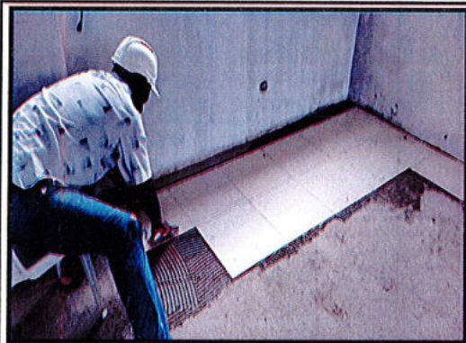
Suministro e instalación de piso en baldosa cerámica TRAFICO 5 30cm x 30cm
