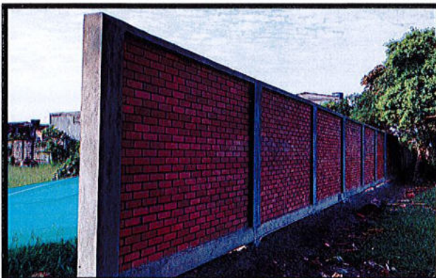
PINTURA ACABADO MATE TIPO KORAZA MURO LADRILLO
