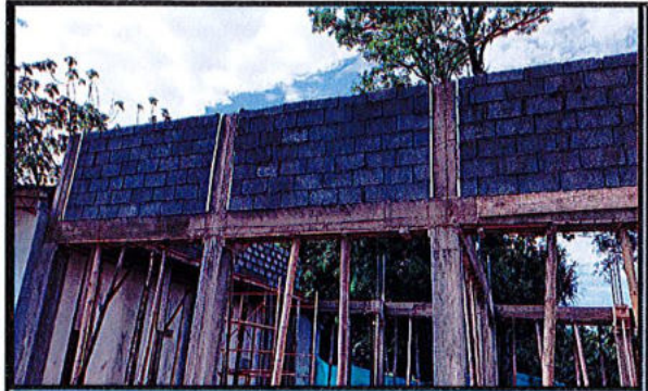
Foto No 6. Instalación de dilatacion de icopor de 3 cm
