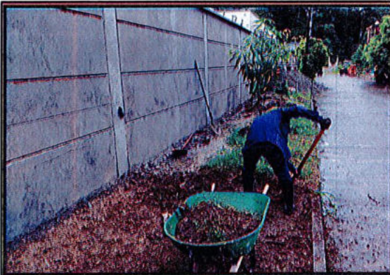
DESCAPOTE PARA ANDEN PERIMETRAL
