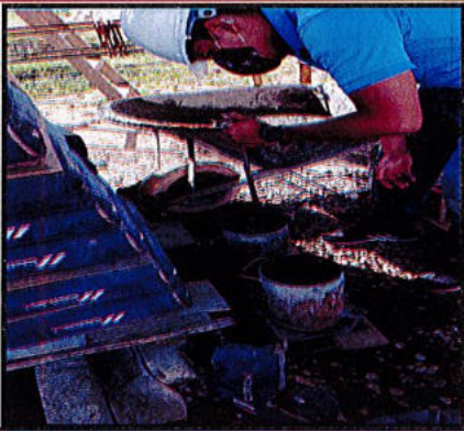
TOMA DE CILINDROS DE CONCRETOS PARA ENSAYOS DE COMPRESION
