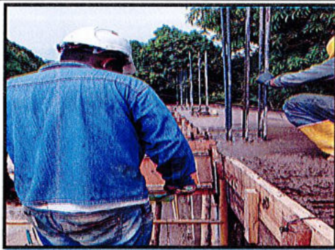
Foto No 3. Concreto f'c = 21 Mpa para vigas aéreas 30X30
