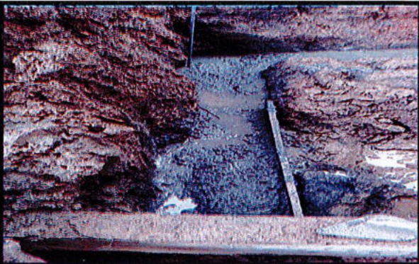
CONCRETO BASE PARA MURO DE CONTENCION
