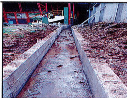
CONCRETO DE 3000 PSI IMPERMEABILIZADO PARA CANAL RECTANGULAR DE AGUAS LLUVIAS (sin refuerzo)
