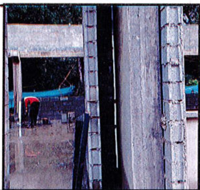
Instalación de dilatacion de icopor de 3 cm
