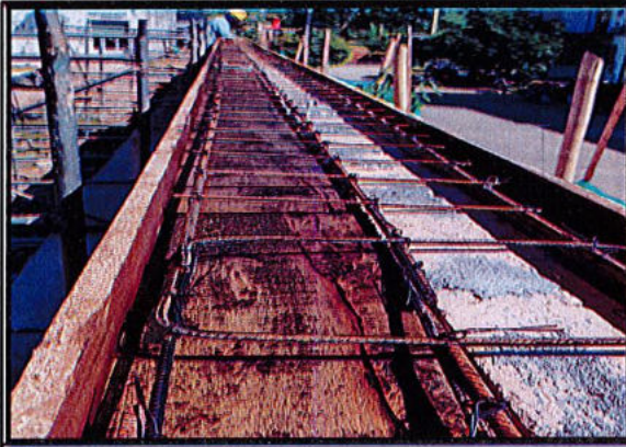
FIGURADO DE ACERO DE REFUERZO 60000 PSI
