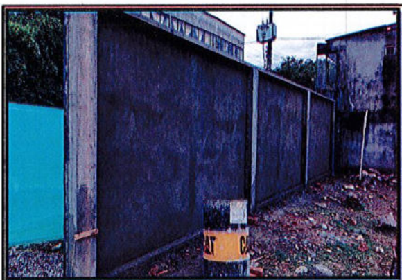
PAÑETE 1:3 SOBRE MURO E : 2CM
