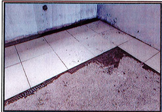
Suministro e instalación de piso en baldosa cerámica TRAFICO 5 30cm x 30cm
