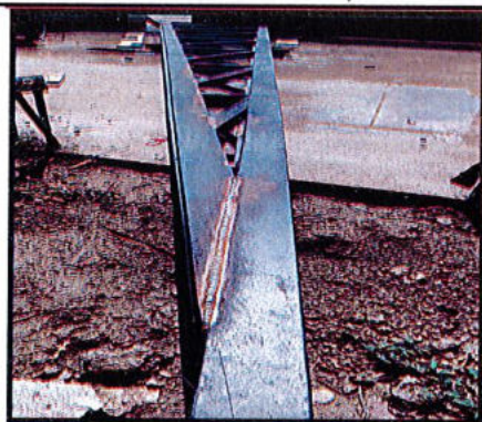
Cercha estructura de cubierta
