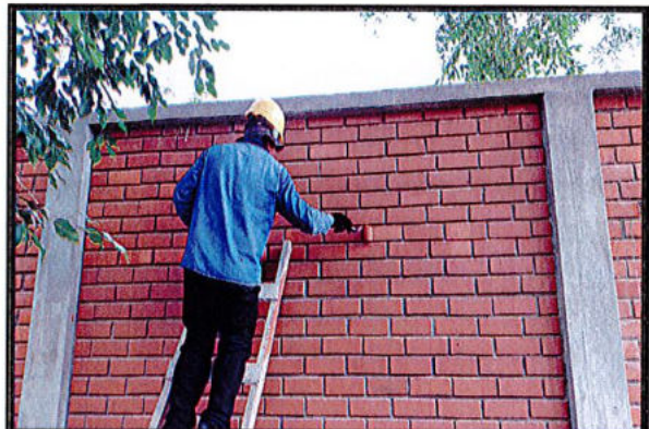
PINTURA ACABADO MATE TIPO KORAZA MURO LADRILLO
