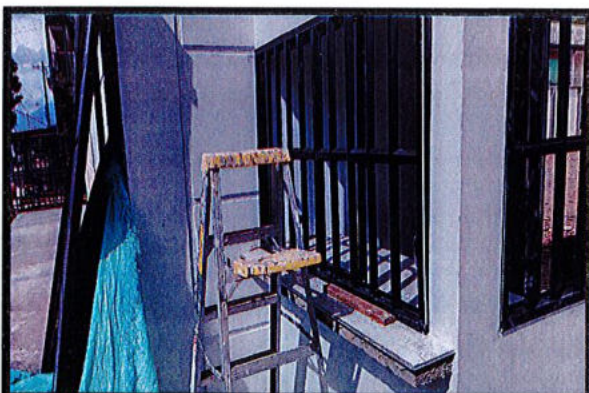
VENTANA EN LAMINA .Incluye vidrio, el suministro de todos los accesorios requeridos para el correcto montaje y vidrio transparente de 4mm (Suministro e instalación)
