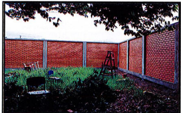
MURO LADRILLO VISTO TIPO REJILLA
