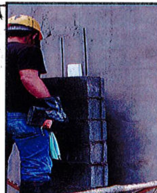
Instalación de dilatacion de icopor de 3 cm
