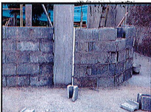
Instalación de dilatacion de icopor de 3 cm
