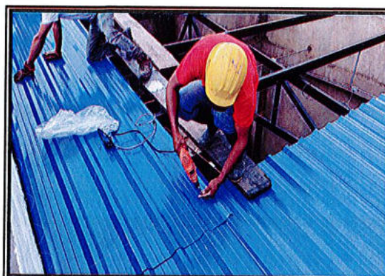
Instalacion de cubierta con tornillos recomendados
