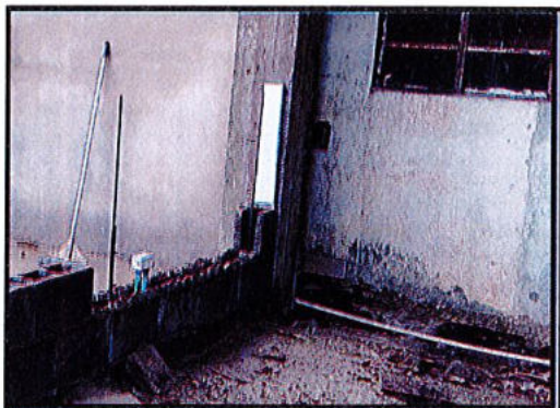
Instalación de dilatacion de icopor de 3 cm
