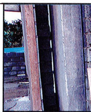
Instalación de dilatacion de icopor de 3 cm
