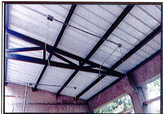
Cubierta termo acústica tipo sándwich
