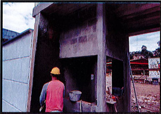
PAÑETE 1:3 SOBRE MURO E : 2CM
