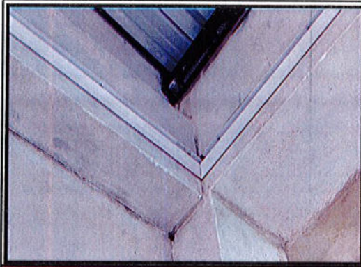
Ángulos en PVC para instalación de cielo raso
