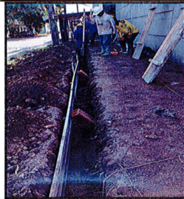
BORDILLO EN CONCRETO DE 3000 PSI a=12cm b=40cm (no incluye refuerzo)
