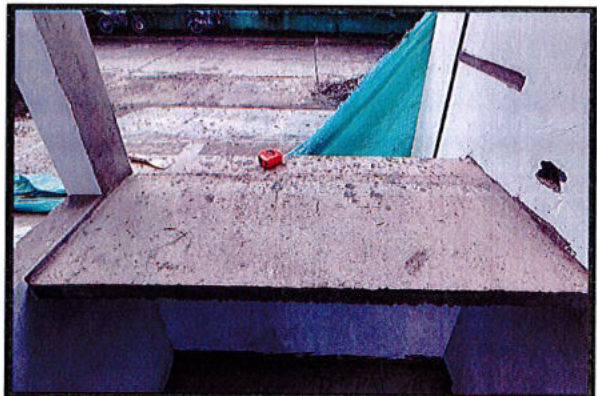
MESON EN CONCRETO INCLUYE GRANITO PULIDO (ANCHO : 0,40M)
