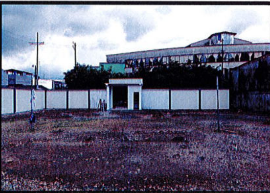
VISTA INTERNA SECTOR ACCESO PRINCIPAL
