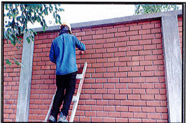
PINTURA ACABADO MATE TIPO KORAZA MURO LADRILLO
