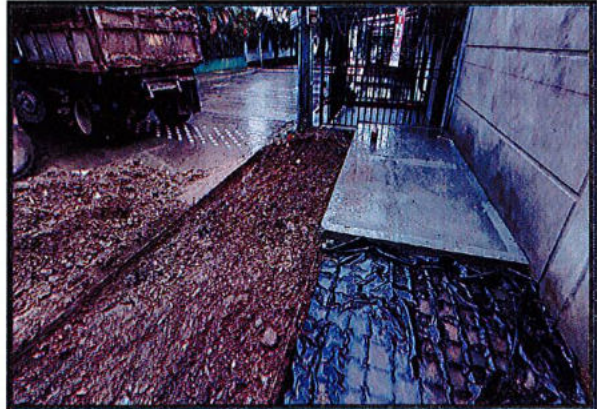
ANDEN EN CONCRETO DE 3000 PSI (incluye refuerzo en malla electrosoldada Q5)
