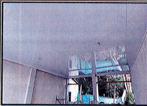
Suministro e instalación de cielo raso en lámina de PVC Blanco
