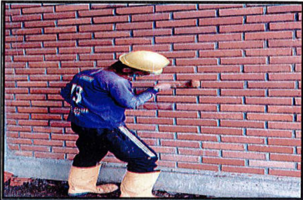
PINTURA ACABADO MATE TIPO KORAZA MURO LADRILLO
