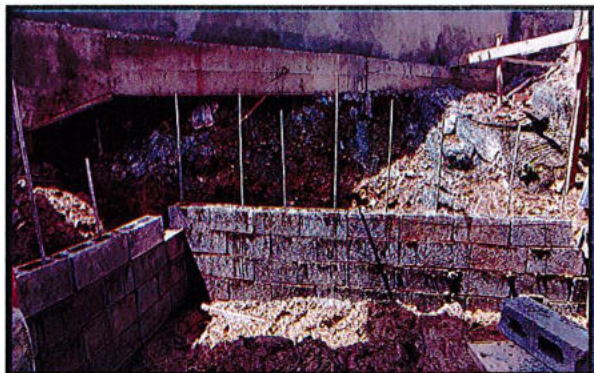
MURO DE CONTENCION FACHADA OSTERIOR DEL COLISEO
