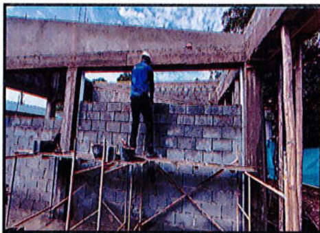
Muros estructural según diseño. Incluye refuerzo y grouting
