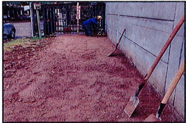
COMPACTACION MANUAL DE RELLENO PARA ANDEN
