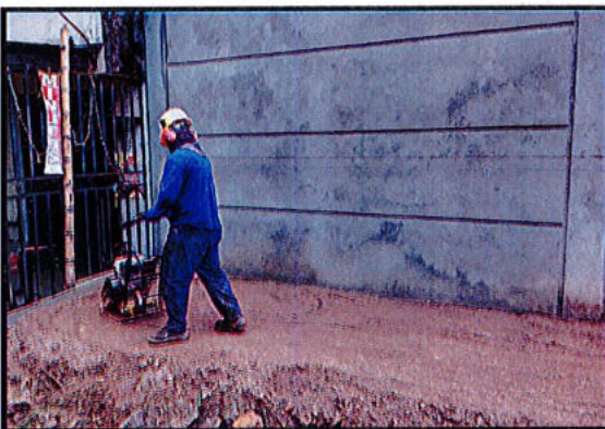
COMPACTACION MANUAL DE RELLENO PARA ANDEN
