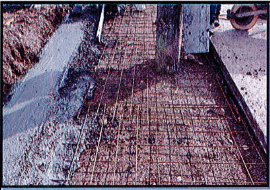
ANDEN EN CONCRETO DE 3000 PSI (incluye refuerzo en malla electrosoldada Q5)
