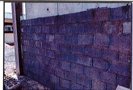
Foto No 9. Muros estructural según diseño. Incluye refuerzo y grouting
