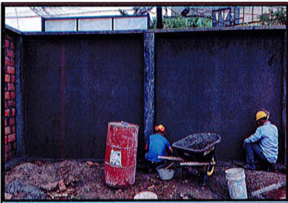
PAÑETE 1:3 SOBRE MURO E : 2CM
