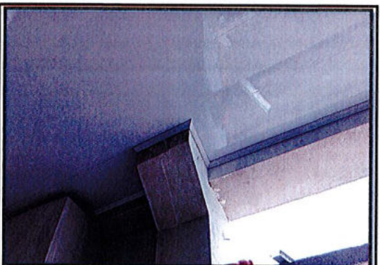
Suministro e instalación de cielo raso en lámina de PVC Blanco
