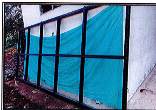
Estructura metalica cubierta policarbonato
