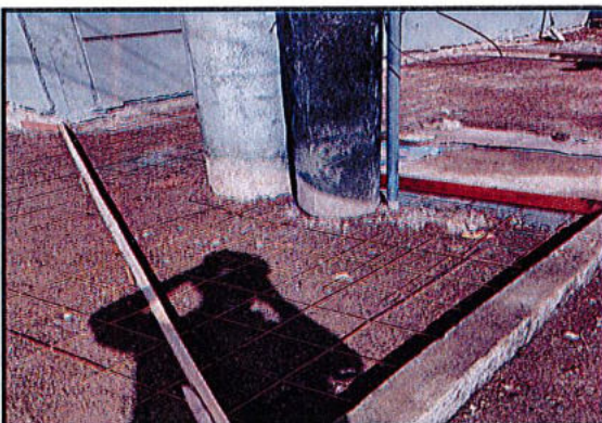
SUMINISTRO E INSTALACION DE MALLA ELECTROSALDADA Q5
