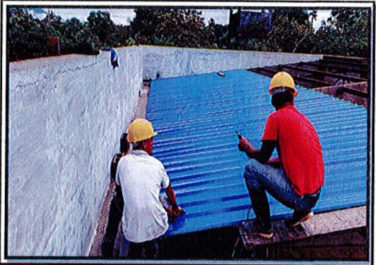
Instalacion de cubierta
