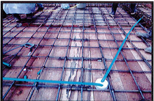
SUMINISTRO E INSTALACION DE TUBERIA CONDUIT PVC 1/2". EMBEBIDA EN PLACA O MURO
