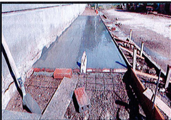
PLACAS DE ANDEN PERIMETRAL FUNDIDAS
