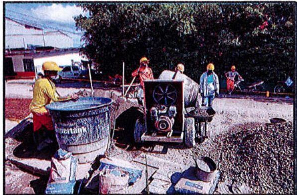
PREPARACION DE CONCRETO SIGUIENDO EL DISEÑO DE MEZCLA PRESENTADO
