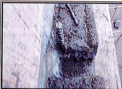
Espacio para correa de la estructura metalica de cubierta
