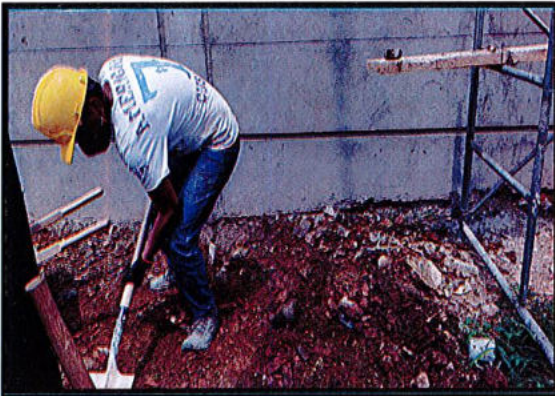
MEJORAMIENTO PARA ANDEN PERIMETRAL
