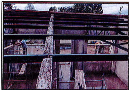
Correas de estructura metalica de cubierta
