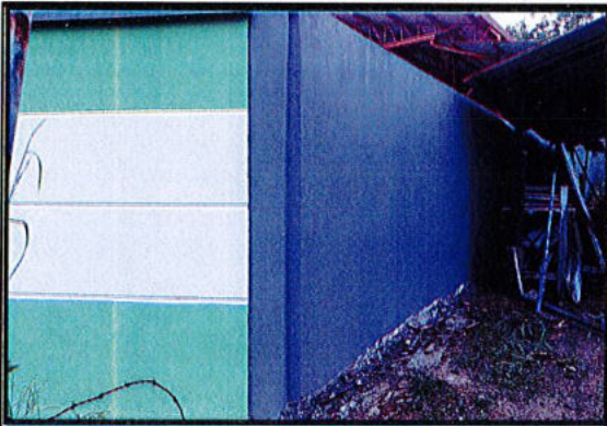
PINTURA PARTE EXTERNA DE MURO
