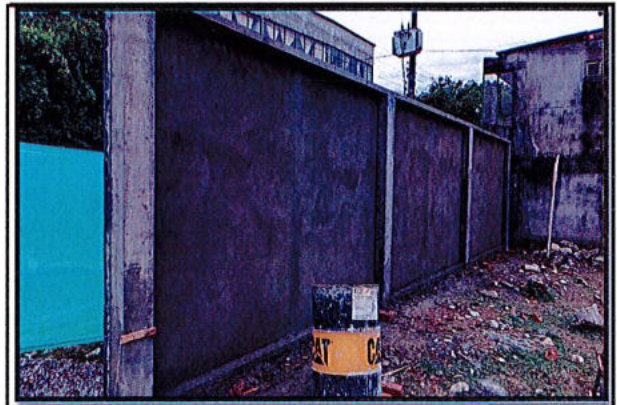
PAÑETE 1:3 SOBRE MURO E : 2CM
