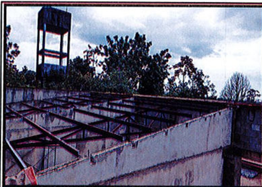
Correas de estructura metalica de cubierta
