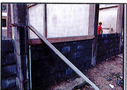
Muros estructural según diseño. Incluye refuerzo y grouting
