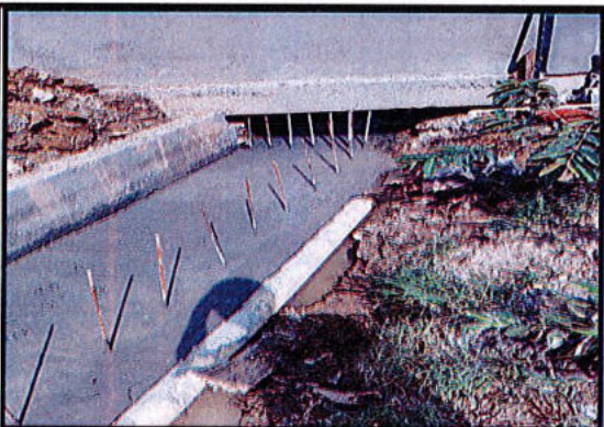
CONCRETO DE 3000 PSI IMPERMEABILIZADO PARA CANAL RECTANGULAR DE AGUAS LLUVIAS (sin refuerzo)
