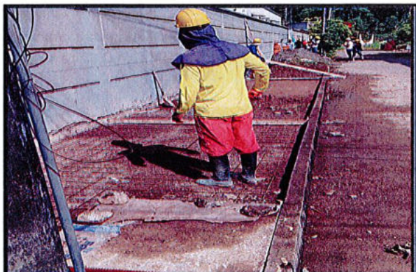
SUMINISTRO E INSTALACION DE MALLA ELECTROSALDADA Q5
