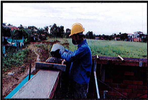
Concreto para zapata
