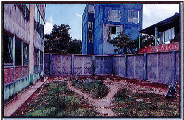
PAÑETE 1:3 SOBRE MURO E : 2CM
