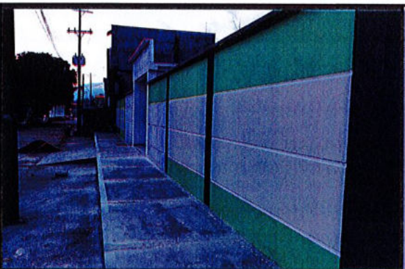
PINTURA FACHADAS EXTERNA
