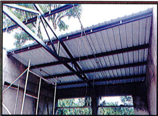
Cubierta termo acústica tipo sándwich
