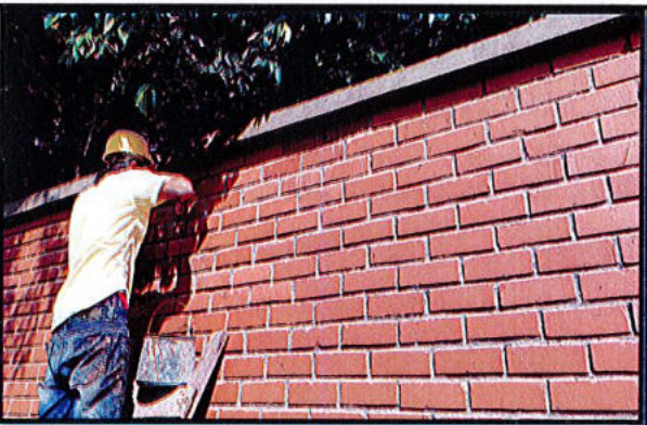
PINTURA ACABADO MATE TIPO KORAZA MURO LADRILLO
