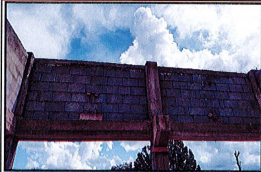
Muros estructural según diseño. Incluye refuerzo y grouting
