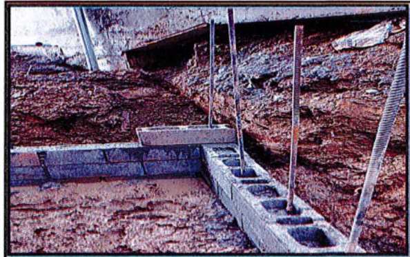
MURO DE CONTENCION EN BLOQUE ESTRUCTURAL
