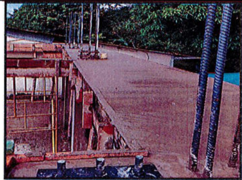
Foto No 4. Concreto f'c = 21 Mpa para vigas aéreas 30X30
