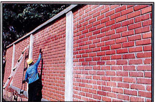
PINTURA ACABADO MATE TIPO KORAZA MURO LADRILLO
