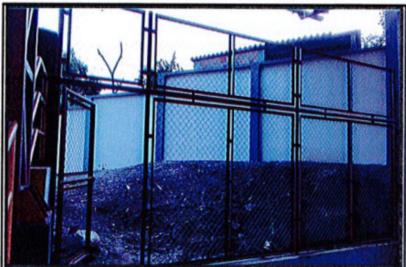
CERRAMIENTO EN MALLA ESLABONADA Y ANGULO ZONA POLIDEPORTIVO
