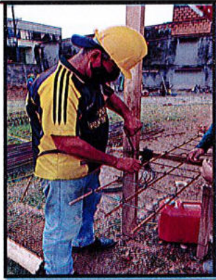
FIGURADO DE ACERO DE REFUERZO 60000 PSI
