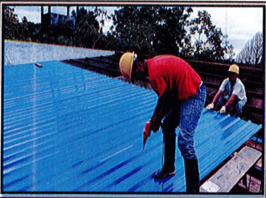
Instalacion de cubierta
