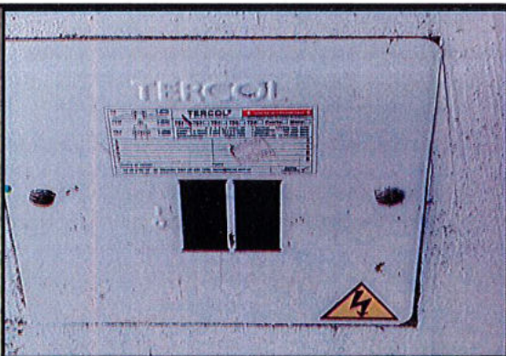
SUMINISTRO E INSTALACION DE TABLERO DE 2 CIRCUITOS 3F5H, CON PUERTA Y ESPACIO PARA TOTALIZADOR, BARRAJE PARA 200A BARRA NEUTRO Y BARRA TIERRA.
