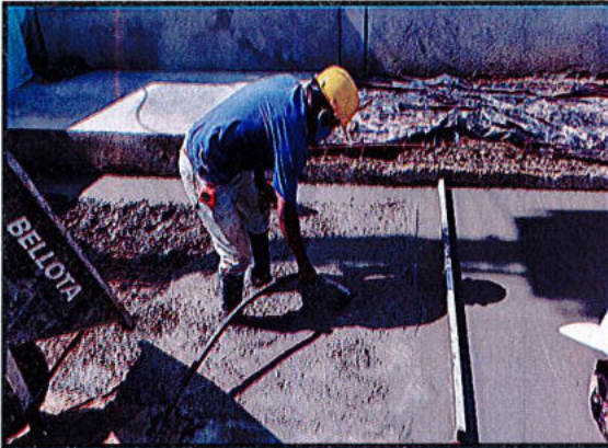
ANDEN EN CONCRETO DE 3000 PSI (incluye refuerzo en malla electrosoldada Q5)
