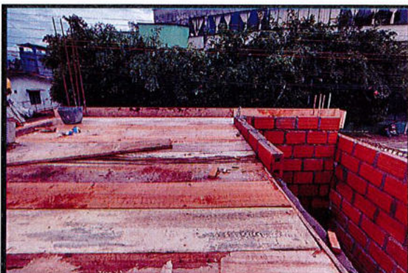
ARMADO DE FORMALETA PARA PLACA DE CONCRETO
