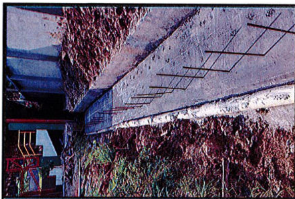
CONCRETO DE 3000 PSI IMPERMEABILIZADO PARA CANAL RECTANGULAR DE AGUAS LLUVIAS (sin refuerzo)
