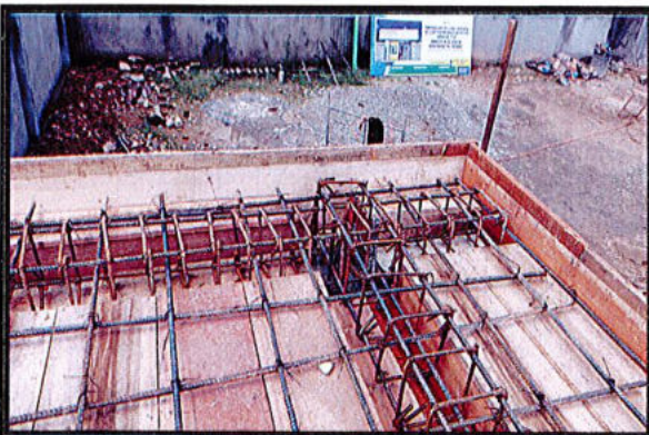
FIGURADO DE ACERO DE REFUERZO PARA PLACA Y VIGAS AEREAS
