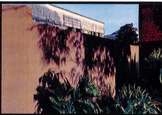
PINTURA PARTE EXTERNA DE MURO
