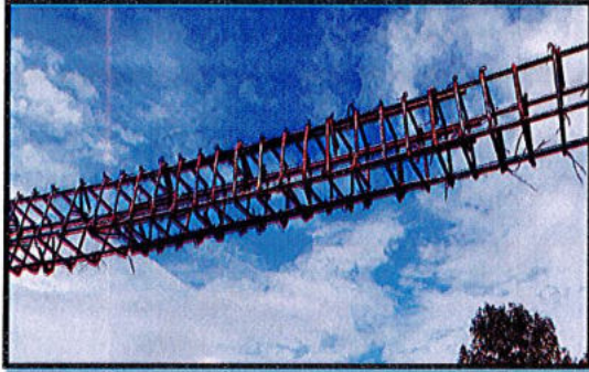
Foto No 1. Acero de refuerzo figurado, para vigas aéreas
