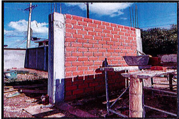
MURO EN LADRILLO GARITA
