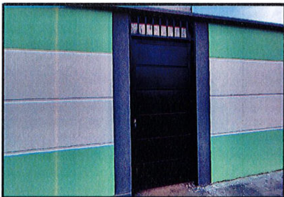
SUMINISTRO E INSTALACION DE PORTON EN LAMINA COLD ROLLED CAL 20 (Incluye Anclaje)
