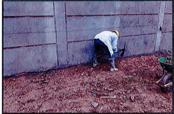
DESCAPOTE PARA ANDEN PERIMETRAL
