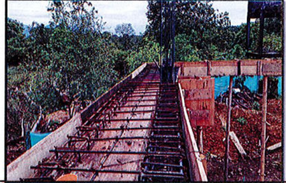
Foto No 2. Instalación de acero de refuerzo figurado e instalación de formaleta para vigas aéreas
