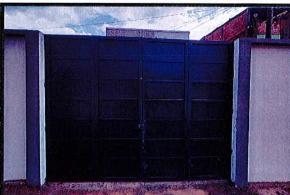
SUMINISTRO E INSTALACION DE PORTON EN LAMINA COLD ROLLED CAL 20 (Incluye Anclaje)
