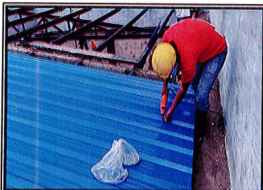
Instalacion de cubierta con tornillos recomendados
