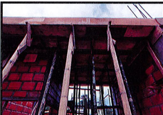
ARMADO DE FORMALETA PARA PLACA DE CONCRETO
