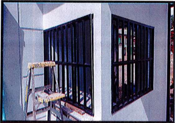
VENTANA EN LAMINA .Incluye vidrio, el suministro de todos los accesorios requeridos para el correcto montaje y vidrio transparente de 4mm (Suministro e instalación)
