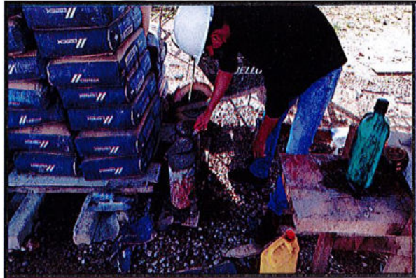
TOMA DE CILINDROS DE CONCRETOS PARA ENSAYOS DE COMPRESION
