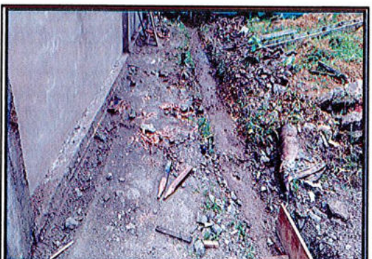
Localización y replanteo
