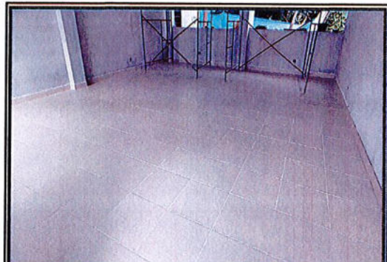
Suministro e instalación de piso en baldosa cerámica TRAFICO 5 30cm x 30cm
