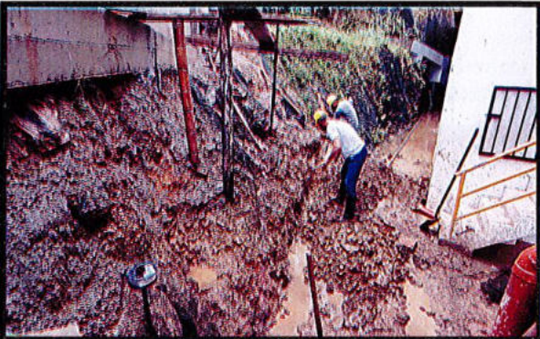
EXCAVACION MANUAL EN CONGLOMERADO
