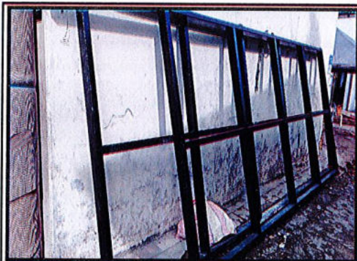
Estructura metalica cubierta policarbonato
