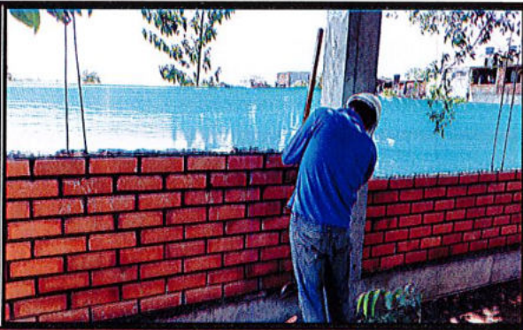
MURO LADRILLO VISTO TIPO REJILLA
