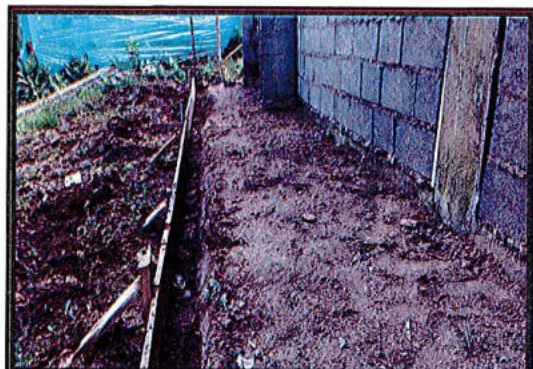
Localización y replanteo
