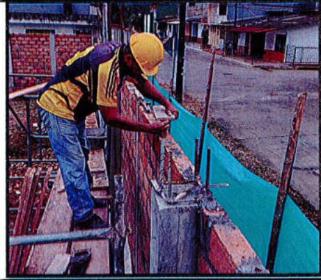
ARMADO DE FORMALETA PARA ALFAJIA
