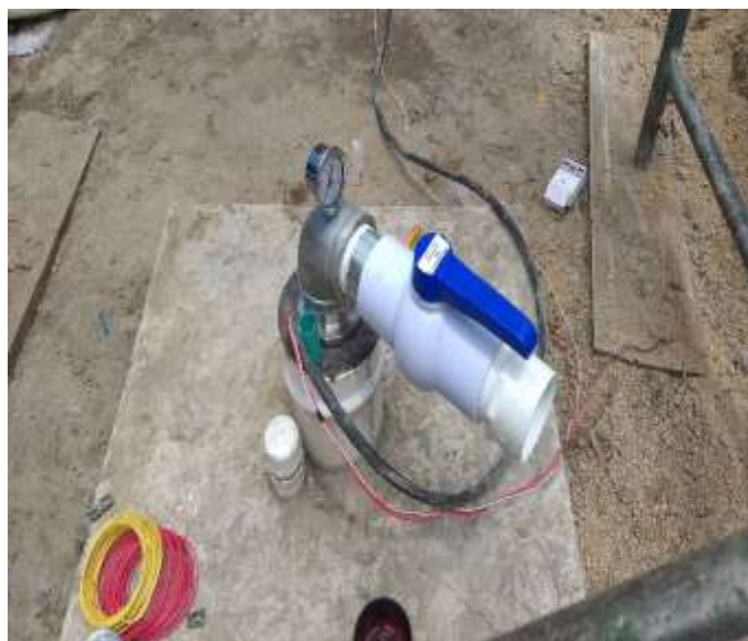
Foto N°.07, Instalación de tubería piezométrica de 1" conduit PVC.
