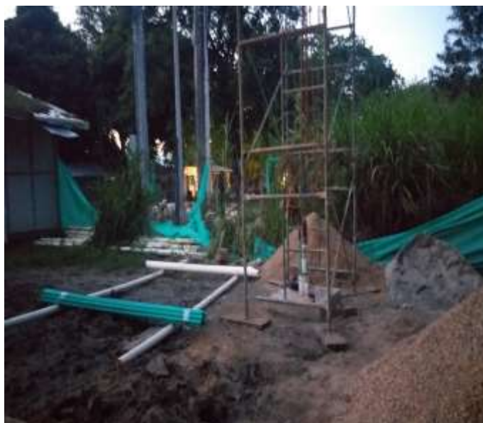
Foto N°04, Instalación tubería 3" tubo Altamira para columna uPVC y demás accesorios.
