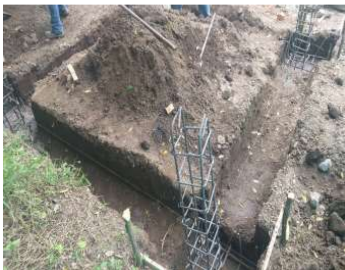
Foto N°02, Construcción de la caseta de protección y operación del pozo profundo.
