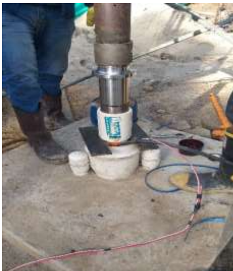
Foto N°.05, Instalación tubería 3" tubo Altamira para columna uPVC y demás accesorios.
