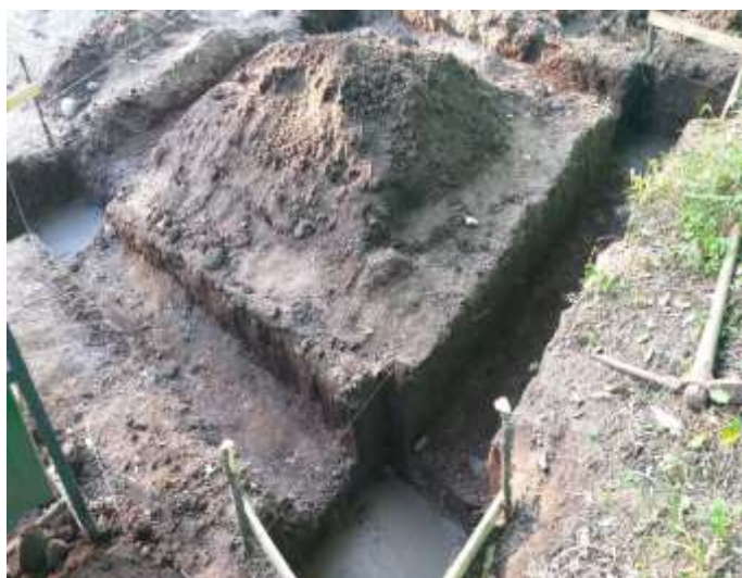
Foto N°01, Construcción de la caseta de protección y operación del pozo profundo.
