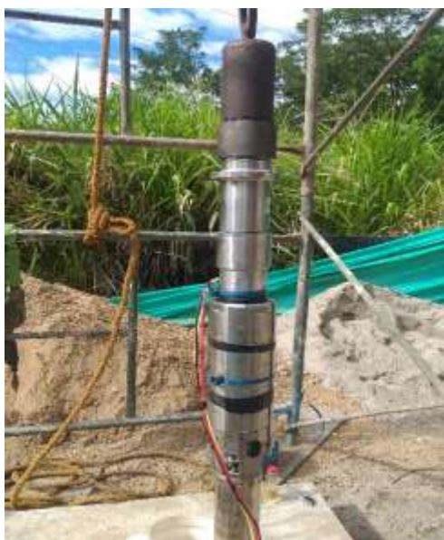
✓ Foto N°03, Instalación del equipo de bombeo sumergible, electrobomba, motor 5hp, 220v-3F, cabeza 80 metros.
