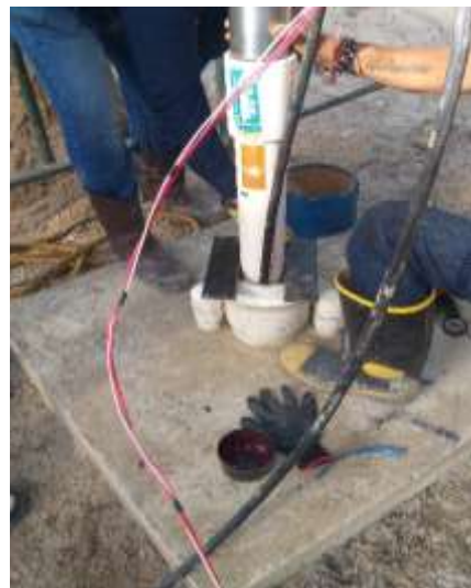
Foto N°.06, Instalación de cable encauchetado para el pozo 3X6 y sonda eléctrica incluye accesorios.
