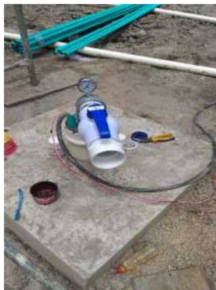
Foto N°.08, Instalación de manómetro y registro de 3".
