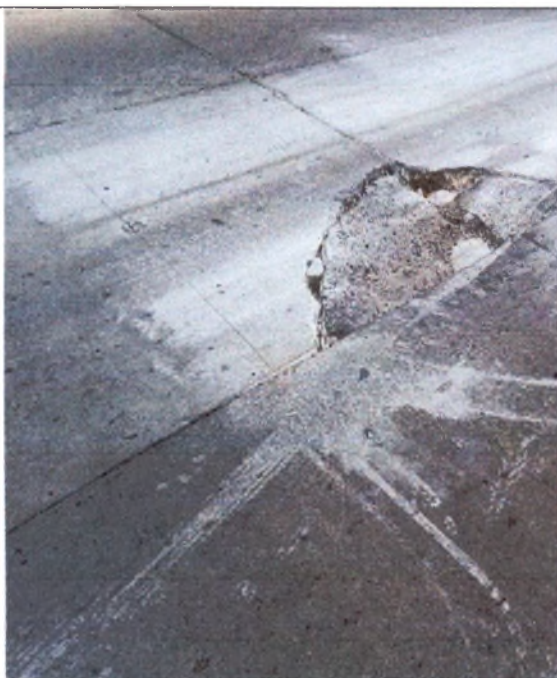
FOTO 7. CORTE DE CALZADA
