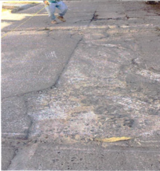
FOTO 1. LOCALIZACION Y REPLANTEO
