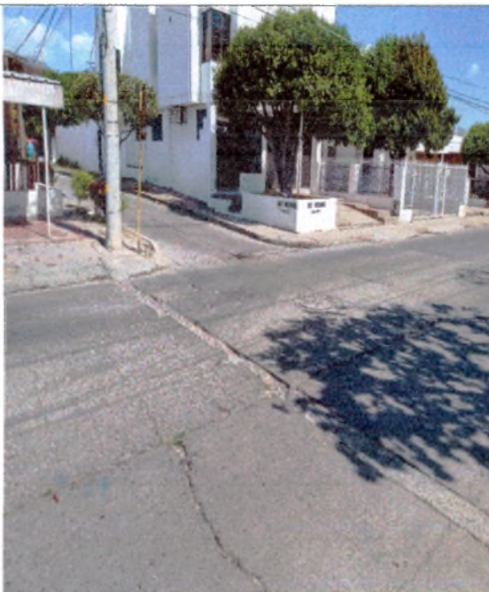
FOTO 3. DEMARCACION CON PINTURA
