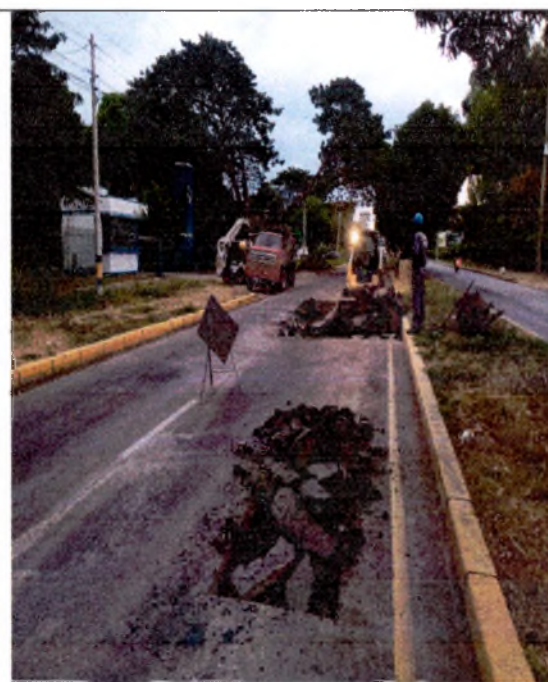
FOTO 12. DEMOLICION DE CONCRETO ASFALTO
