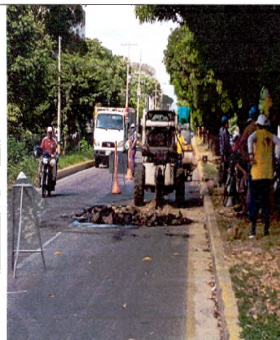
FOTO 11. DEMOLICION DE CONCRETO ASFALTO
