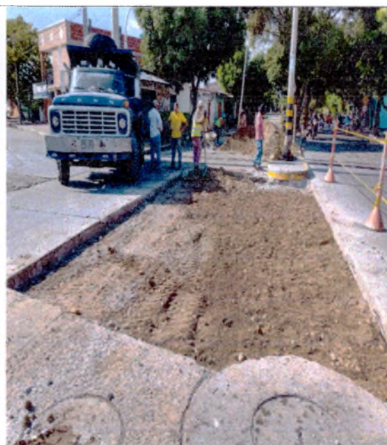
FOTO 18. CONFORMACION Y NIVELACION TERRENO
