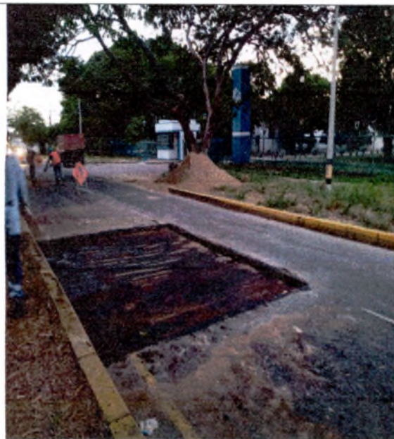
FOTO 25. IMPRIMACION CON EMULSION ASFALTICA
