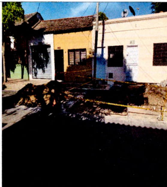
FOTO 30. DOMICILIARIAS PARA ACUEDUCTO
