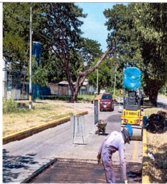
FOTO 26. IMPRIMACION CON EMULSION ASFALTICA
