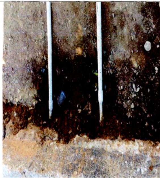
FOTO 29. DOMICILIARIAS PARA ACUEDUCTO
