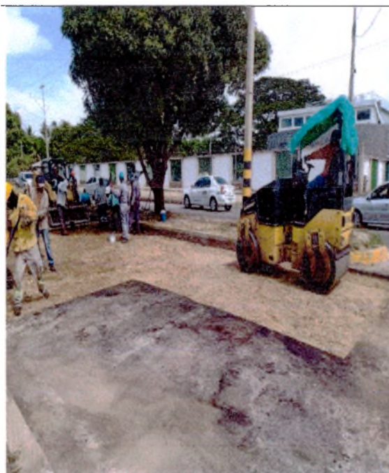
FOTO 20. RELLENO GRANULAR
