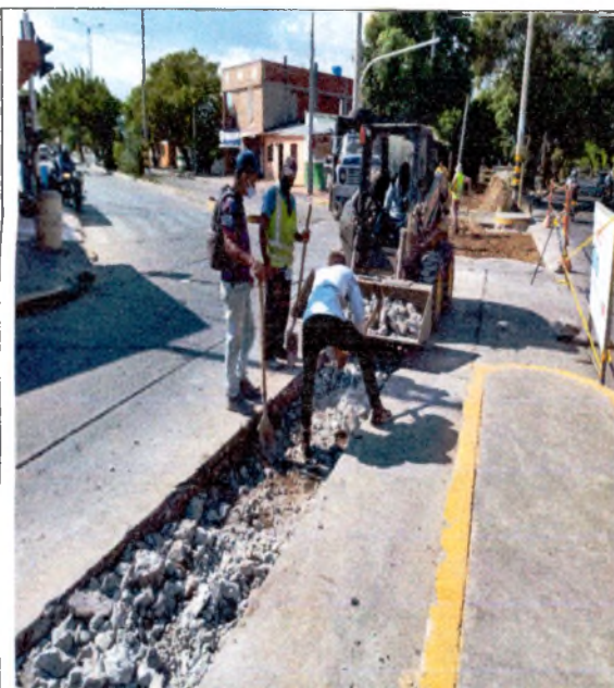
FOTO 9. DEMOLICION DE CONCRETO RIGIDO
