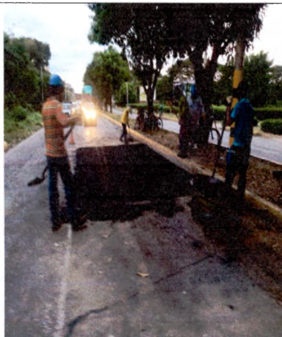
FOTO 27. MEZCLA DENSA EN CALIENTE ASFALTO
