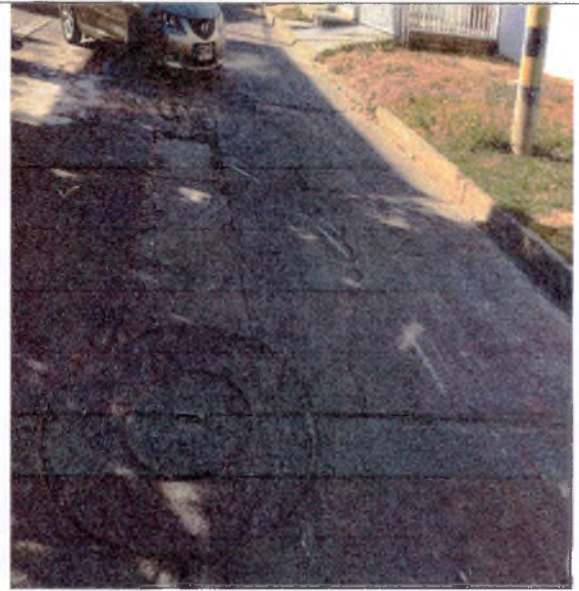
FOTO 2. LOCALIZACION Y REPLANTEO
