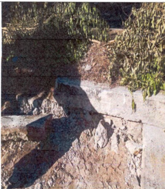
FOTO 5. DEMOLICION DE BORDILLOS
