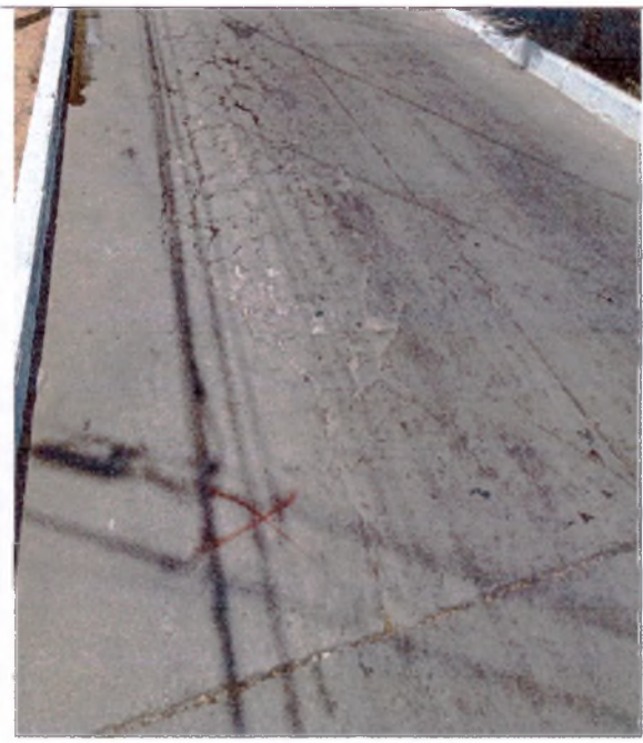
FOTO 4. DEMARCACION CON PINTURA
