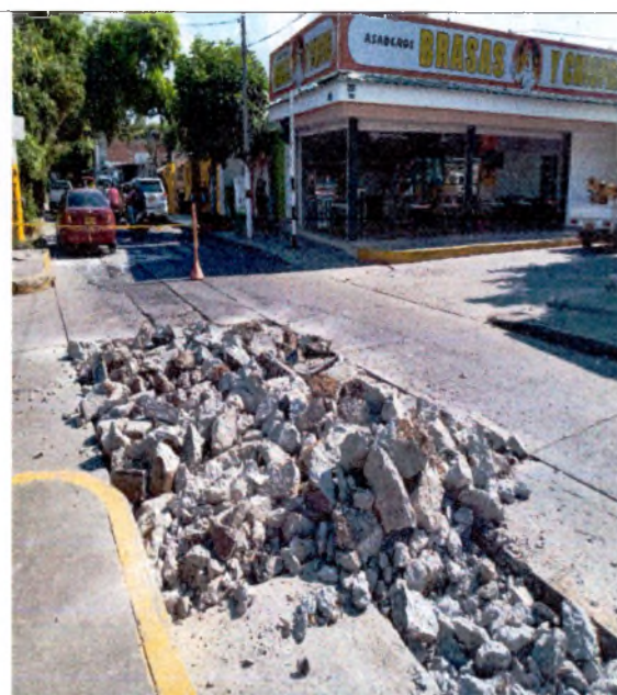
FOTO 10. DEMOLICION DE CONCRETO RIGIDO
