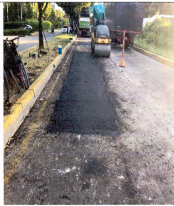
FOTO 28. MEZCLA DENSA EN CALIENTE ASFALTO
