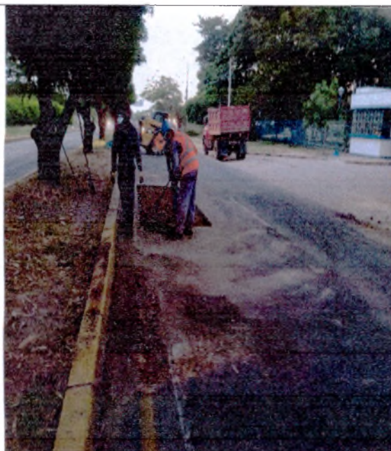
FOTO 17. CONFORMACION Y NIVELACION TERRENO
