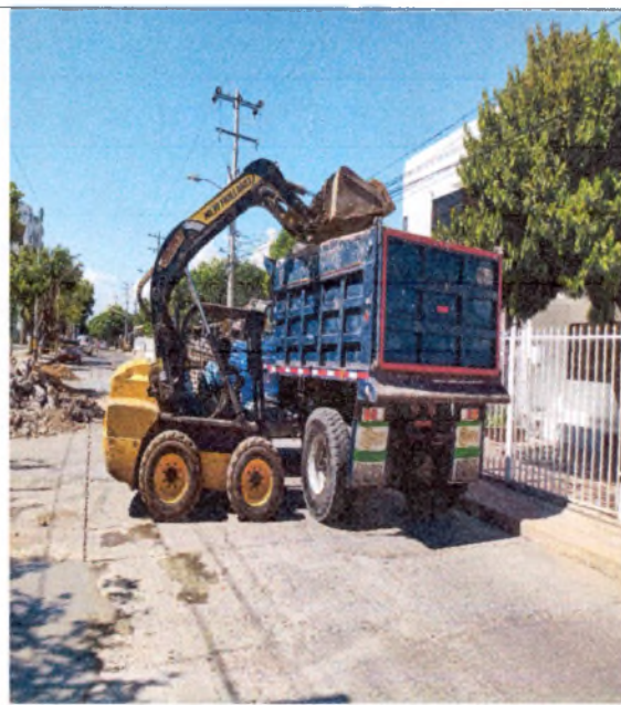
FOTO 14. RETIRO DE MATERIAL
