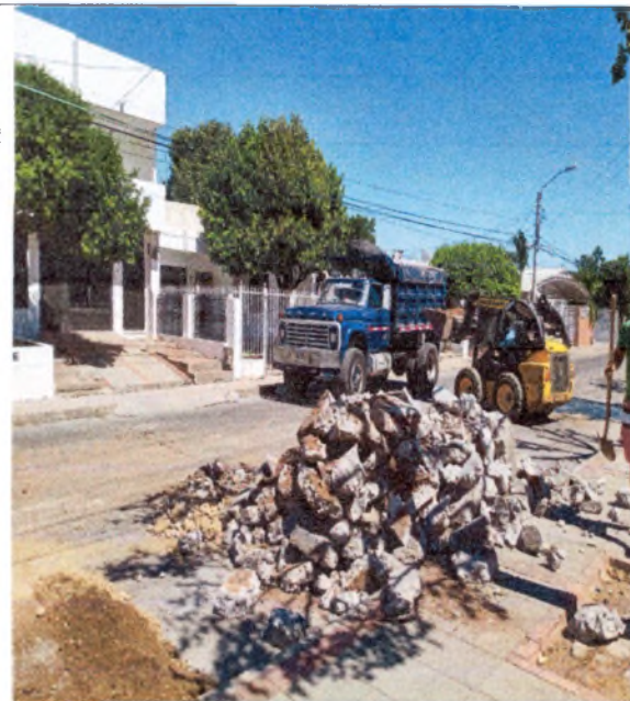
FOTO 13. RETIRO DE MATERIAL
