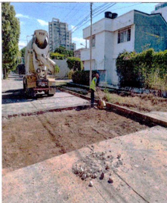
FOTO 19. RELLENO GRANULAR
