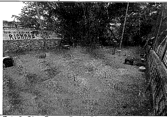
Foto 9: Obra Parque Barrio Diamante 1
