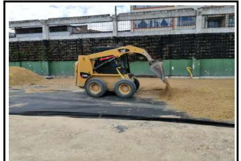
Maquinaria en obra
