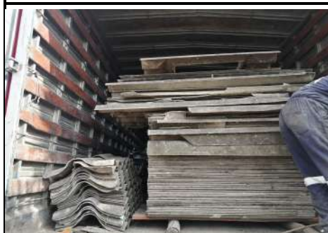
Retiro de tejas de asbesto
