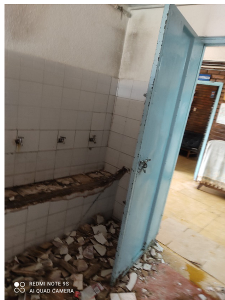
DEMOLICIÓN DE ORINAL Ó LAVAMANOS CORRIDO (INC. RETIRO DE SOBR.)
