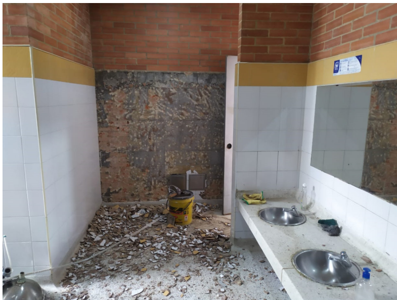
DEMOLICIÓN DE ENCHAPES CERÁMICOS (INC. RETIRO DE SOBR.)
