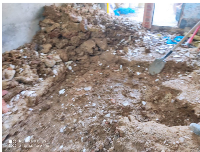
DEMOLICION AFINADOS DE PISO E=5 cm (INCLUYE CARGUE, RETIRO, DISPOSICION DE ESCOMBROS)
