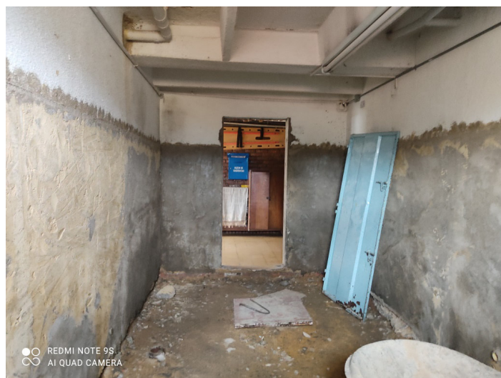
DESMONTE DE PUERTAS EN LAMINA
