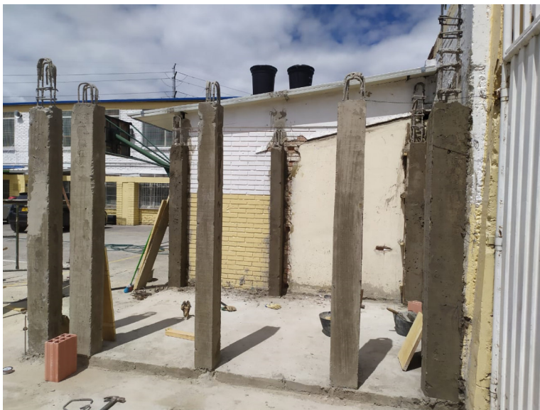
COLUMNETAS EN CONCRETO 3000 PSI DE 20X15CM
