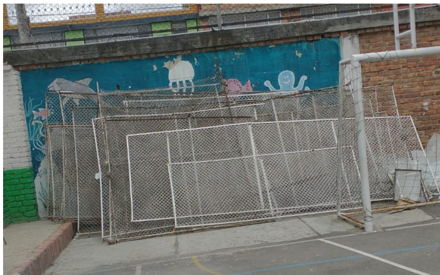
DESMONTE DE REJAS
