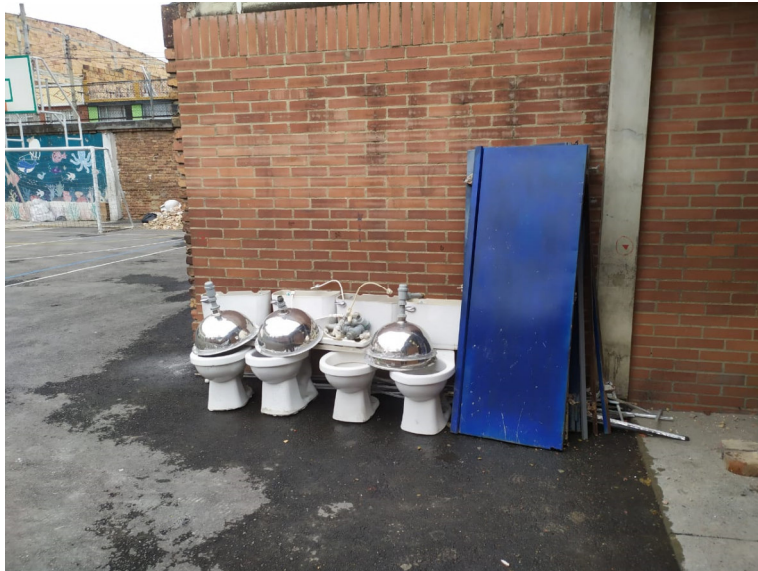
DESMONTE DE APARATOS SANITARIOS
