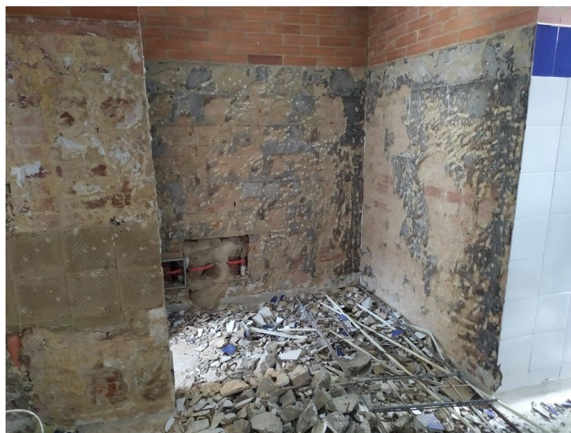
DEMOLICIÓN DE PISOS EN BALDOSÍN (INC. RETIRO DE SOBR.)
