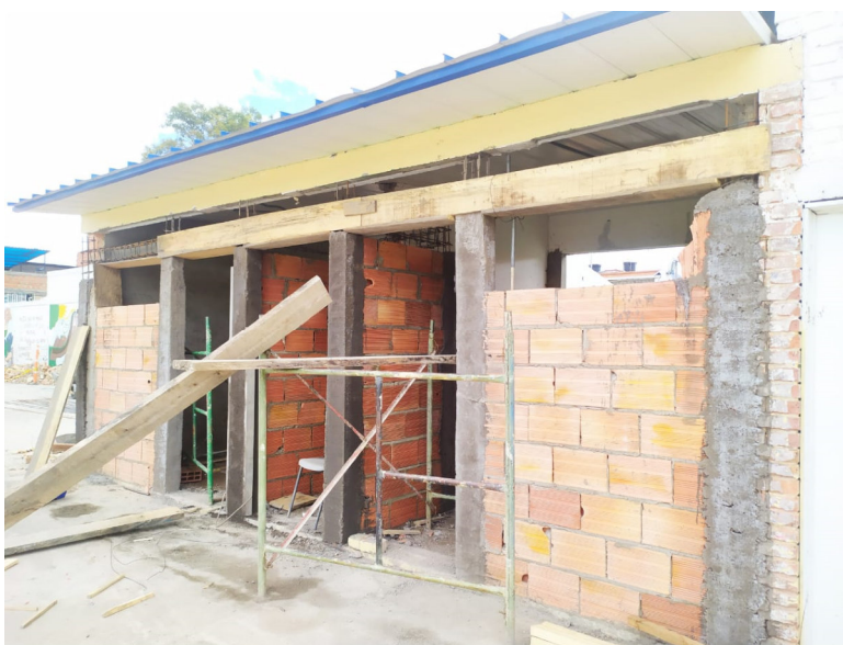
COLUMNETA EN CONCRETO DE 2500 PSI DE 20X15CM
