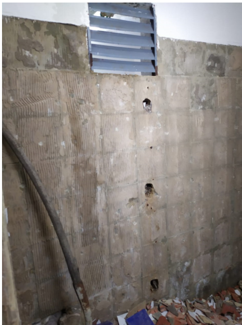
DEMOLICION DE ENCHAPE
