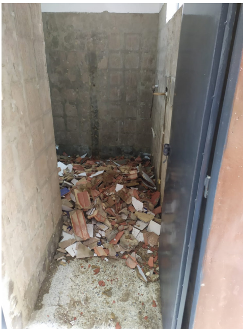
DEMOLICION PISOS EN TABLON
