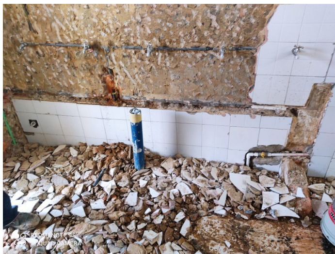
DEMOLICIÓN DE ORINAL Ó LAVAMANOS CORRIDO (INC. RETIRO DE SOBR.)
