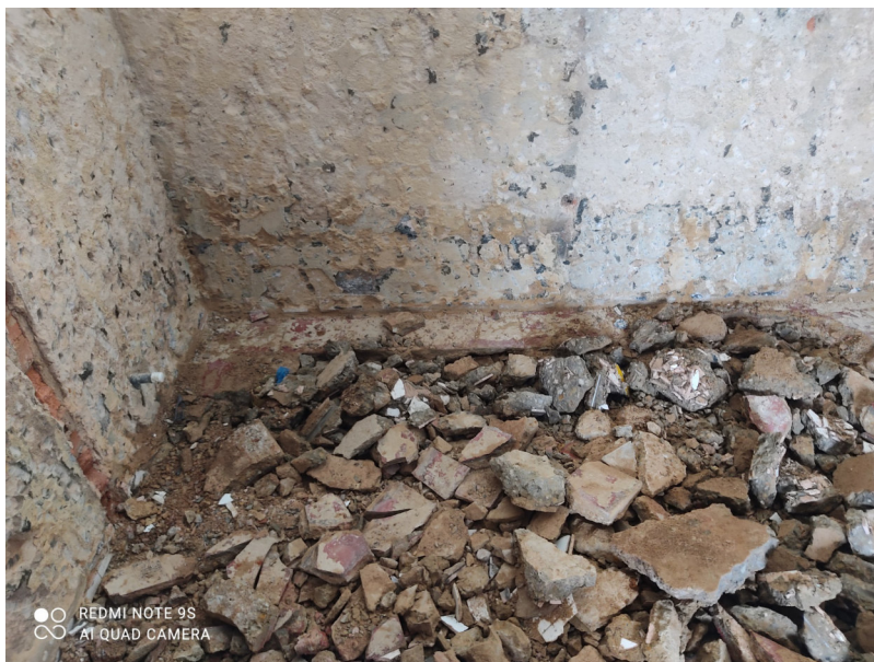
DEMOLICION AFINADOS DE PISO E=5 cm (INCLUYE CARGUE, RETIRO, DISPOSICION DE ESCOMBROS)
