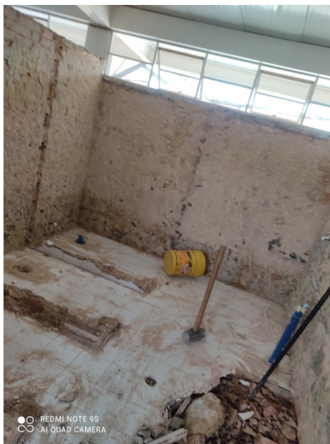
DEMOLICIÓN DE ENCHAPES CERÁMICOS (INC. RETIRO DE SOBR.)
