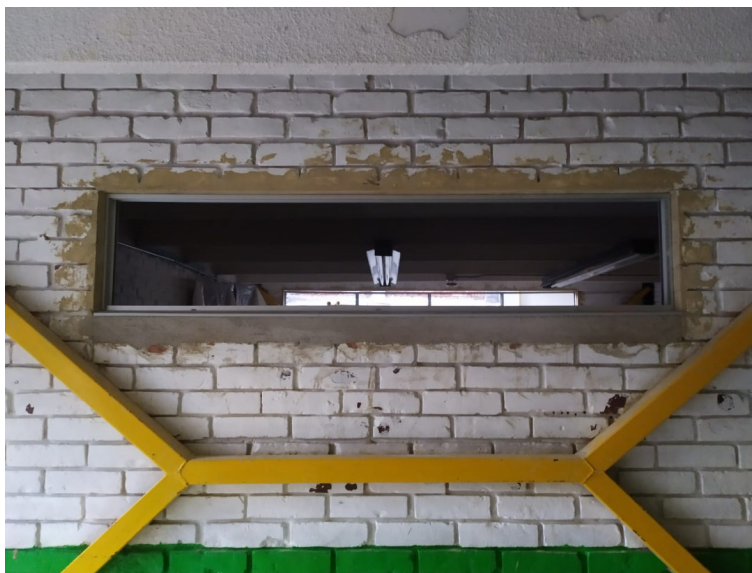
ALFAJÍAS EN CONCRETO
