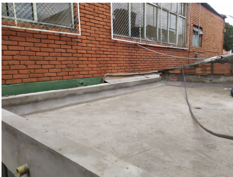
MORTERO IMPERMEABILIZADO
