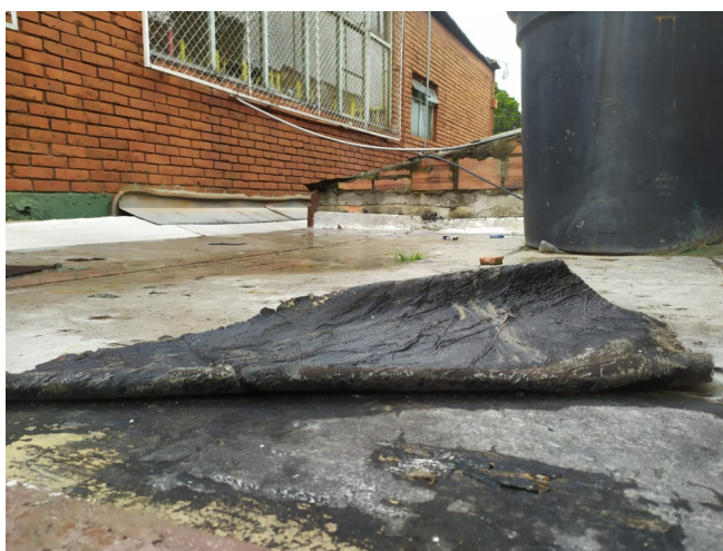
RETIRO DE MANTOS ASFALTICOS (INC. RETIRO DE SOBR.)
