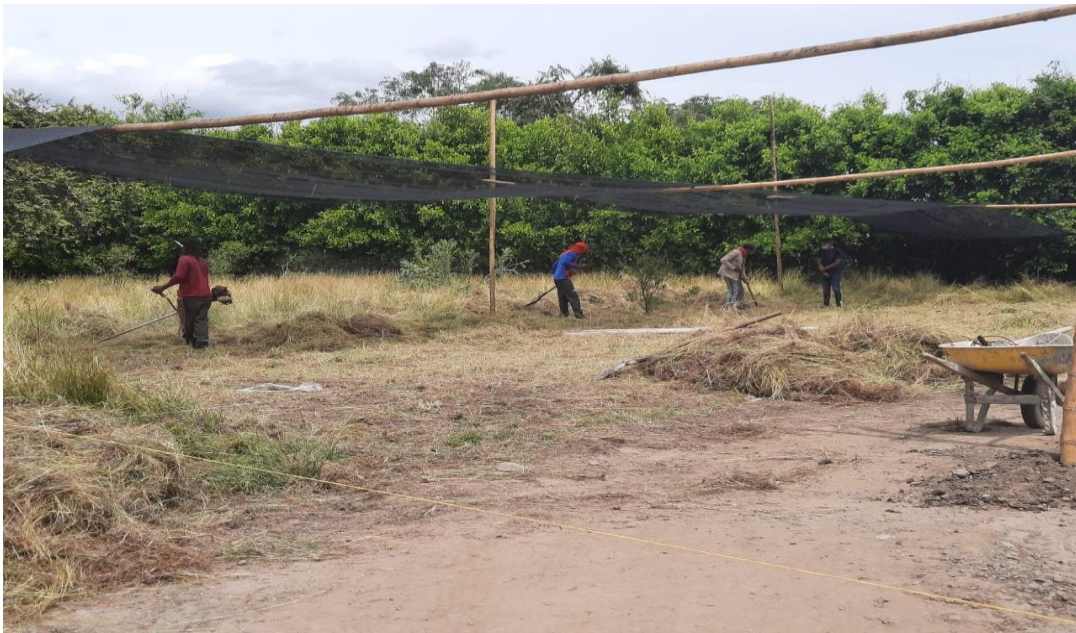
LIMPIEZA DEL CENTRO DE ACOPIO
