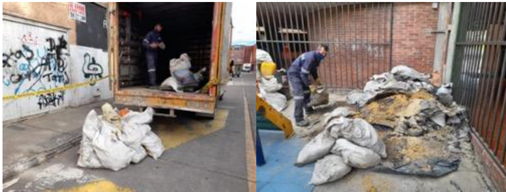
Ilustración 1 Acopio de Material Colegio Lleras
