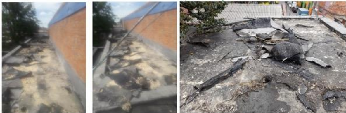
Ilustración 7 Levantamiento de manto asfáltico
