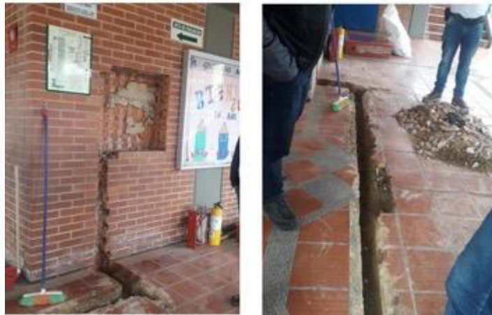
Ilustración 6. Arreglo de la red contra incendio
