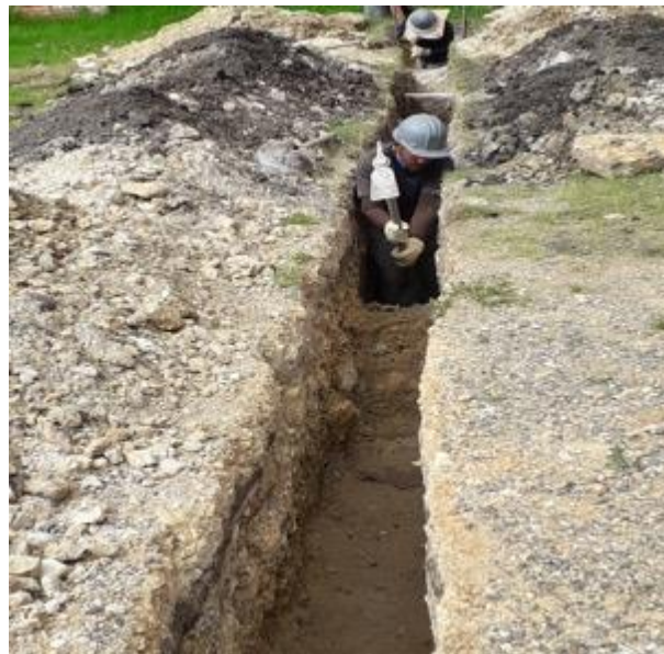
Ilustración 3. Excavación manual
