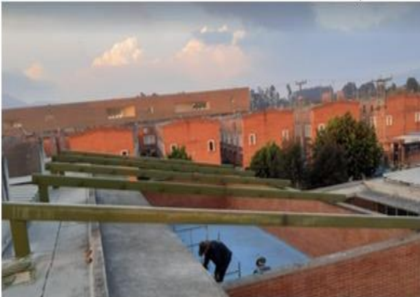
Ilustración 9 Instalación de perfilería metálica en el colegio Delia Zapata.
