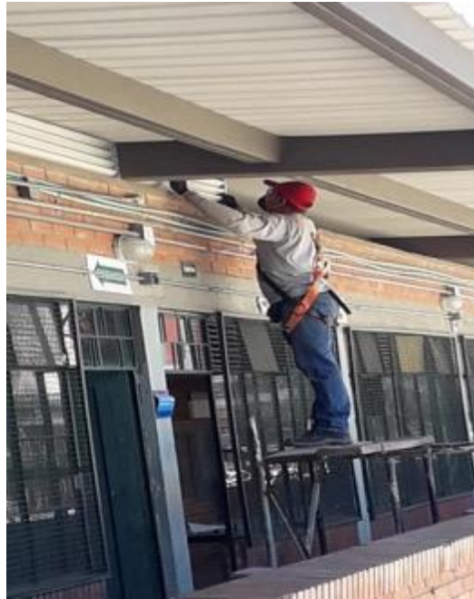
Ilustración 4. Instalación de ventanas en aluminio
