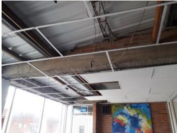
Ilustración 2 instalación de cielo raso
