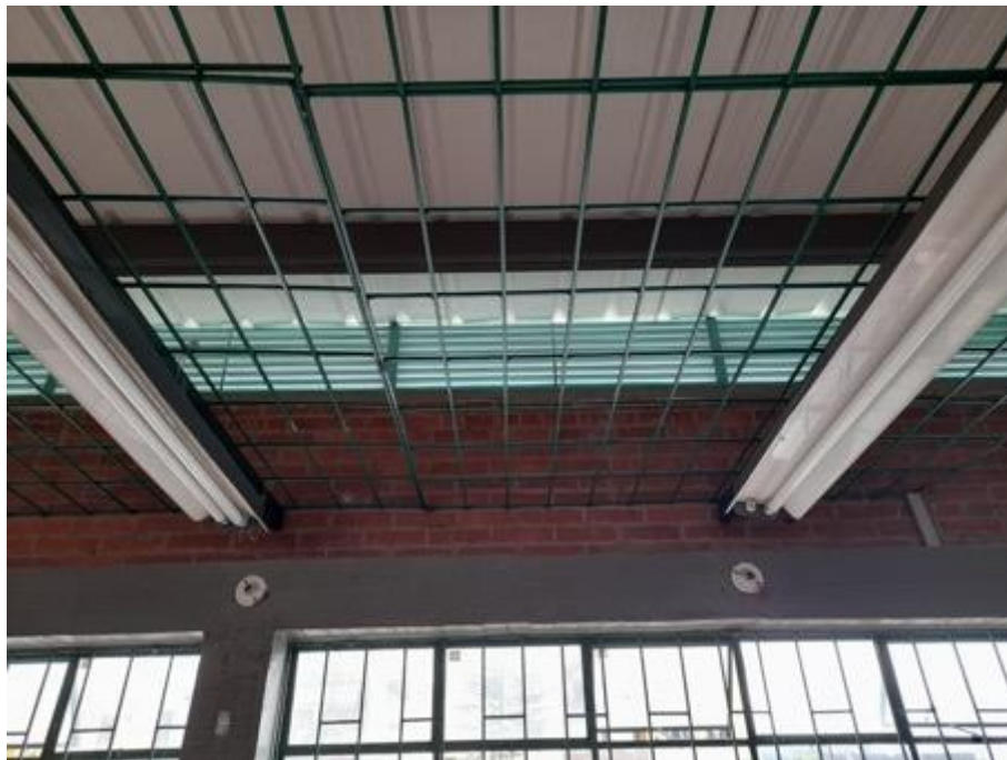
Ilustración 10 Instalación del angeo Colegio Gustavo Morales
