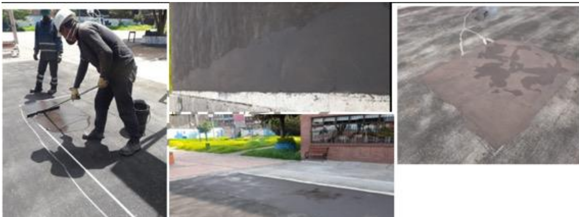
Ilustración 7 Levantamiento de manto asfáltico
