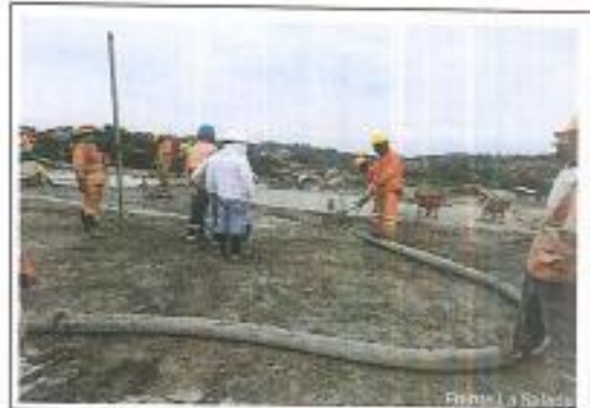
FOTO 2 Colocación de concreto losa superior (Frente La Salada)
