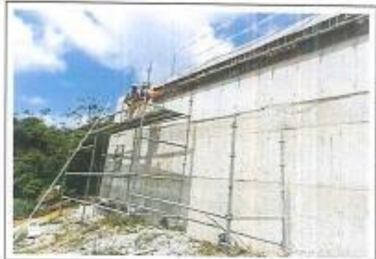
FOTO 4 Dismonte anclaje perímetro tanque (La Salada)
