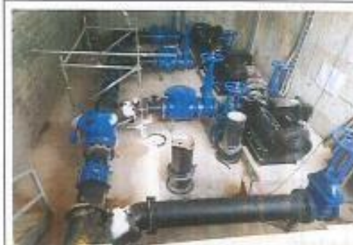
FOTO 6 Montaje e instalación accesorios hidráulicos (Frente Popolao)
