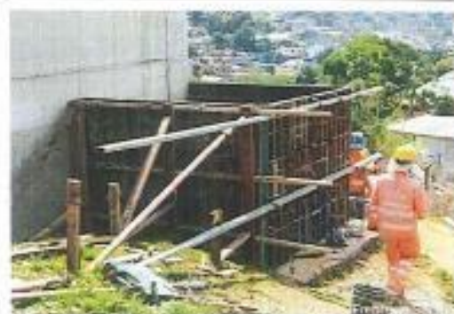
FOTO 5 Encofrado caja de válvulas (Frente La Salud)
