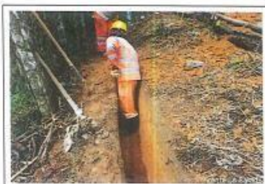
FOTO 1 Excavación viga cerramiento (Frente La Salud)
