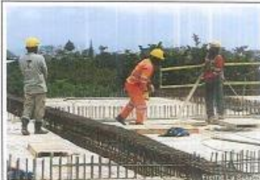
FOTO 4 Instalación de acero de refuerzo leas superior tanque (La Salud)
