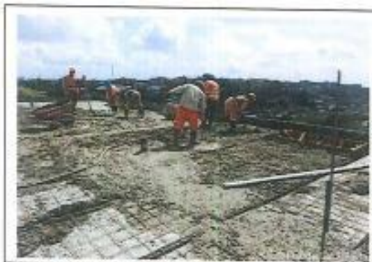
FOTO 1 Colocación de concreto losa superior (Frente La Salada)
