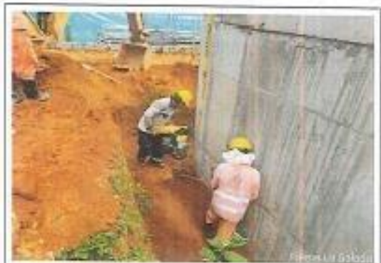
FOTO 6 Compactación lleno material de préstamo (Frente La Salada)
