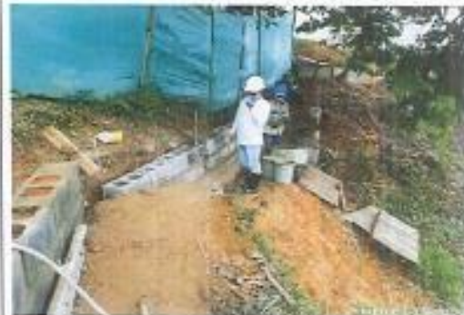
FOTO 2 Construcción muro en bloques cerramiento (Frente La Salud)
