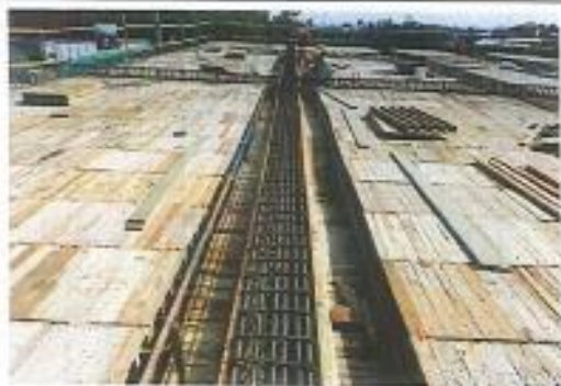
FOTO 3 Instalación de formaldes leas superior tanque (La Salud)
