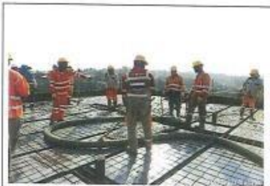
FOTO 3 Colocación de concreto losa superior (Frente La Salada)
