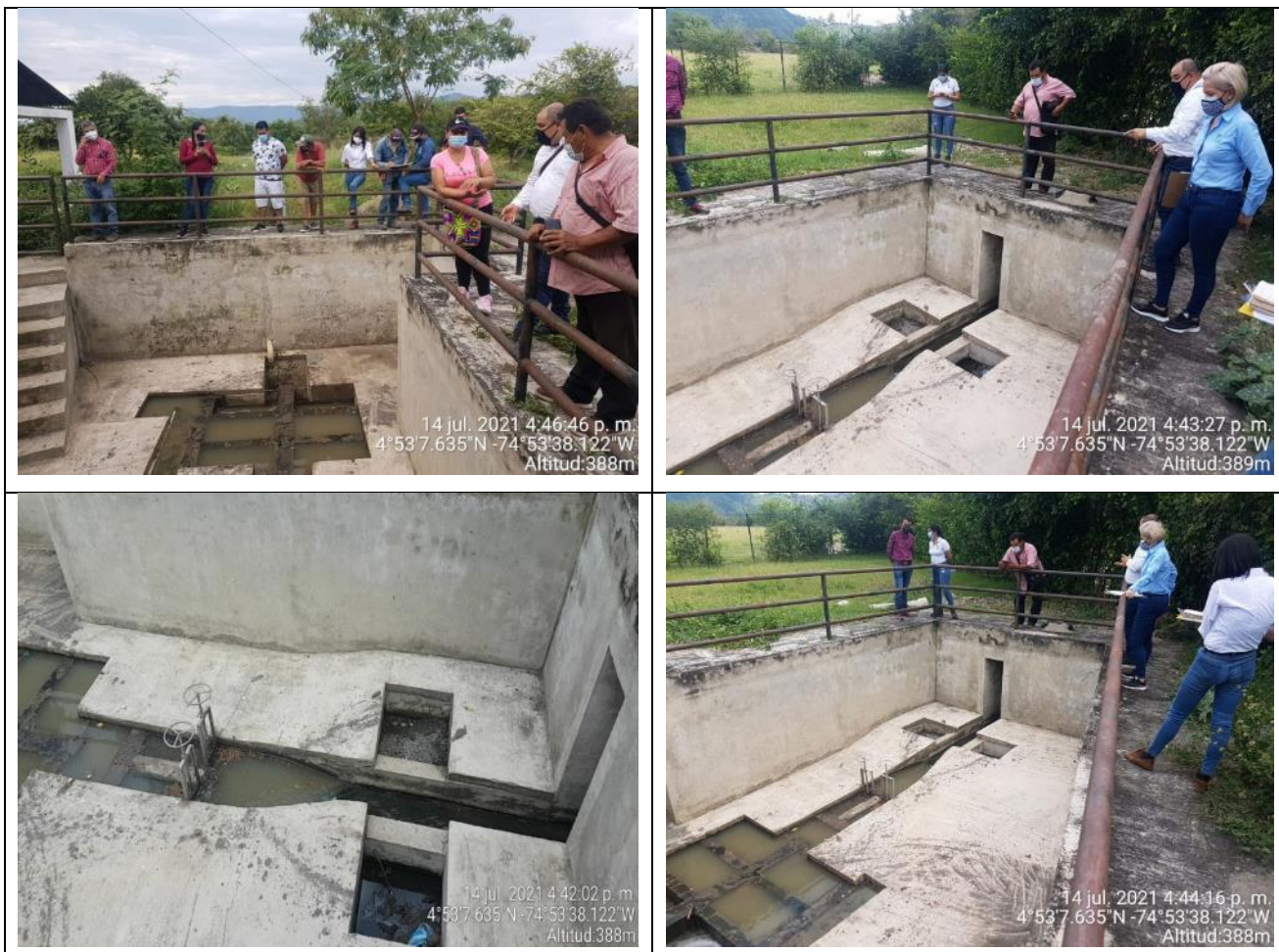
Fotos 18 a 21- Chequeo de conexión de colector con PTAR Chicalá.
