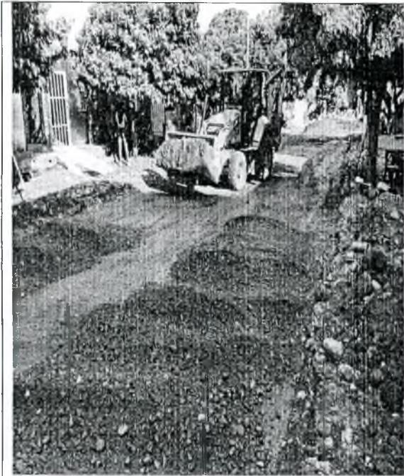
Foto 9. Colocación de subbase granular
