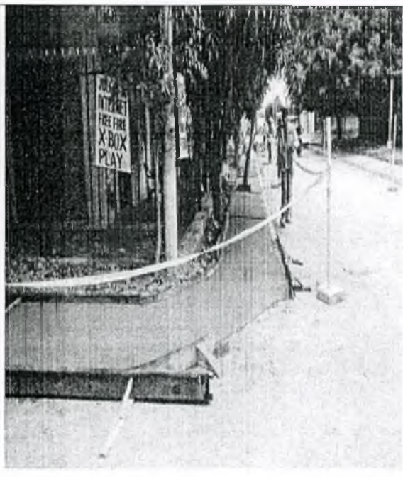
Foto 14. Fundida de andenes en concreto
