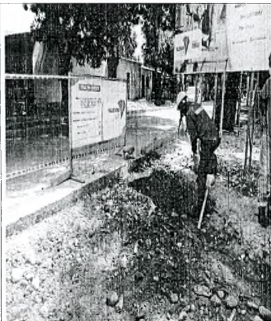
Foto 19. Excavación manual
