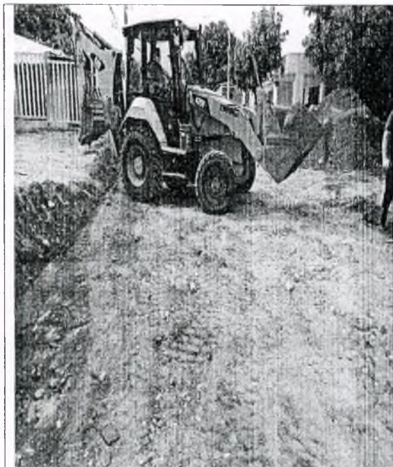
Foto 7. Retiro de sobrantes
