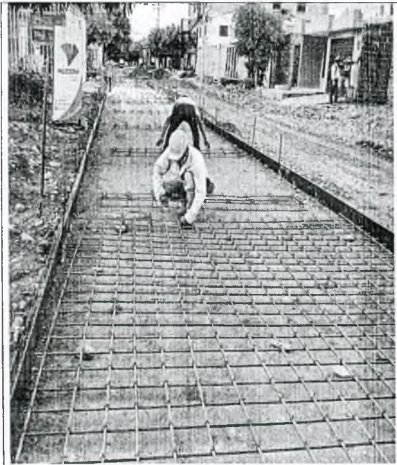
Foto 15. Acero de refuerzo
