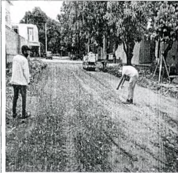
Foto 1. Instalación de valla informativa
