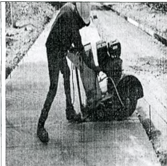
Foto 17. Corte y junta en losas
