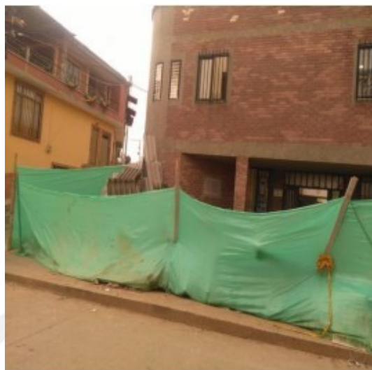
Imagen 7. Cerramiento perimetral de la Obra
