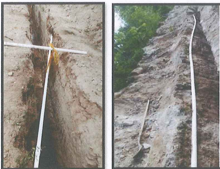
Ilustración 31: Instalación tubería 2"
