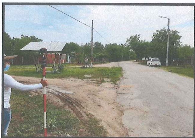
Ilustración 5: Localización y Replanteo pozo 31 al 27 Fuente: Propia
