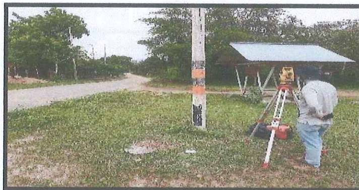
Ilustración 4: Localización y Replanteo pozo 31 al 27 Fuente: Propia
