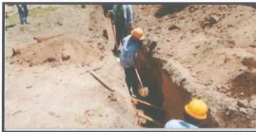
Ilustración 30: Excavación manual Fuente: Propla
