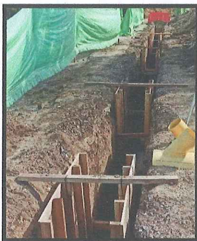
Ilustración 23: Entibados garantizando la seguridad de los trabajadores, Pozo 36 al 29
