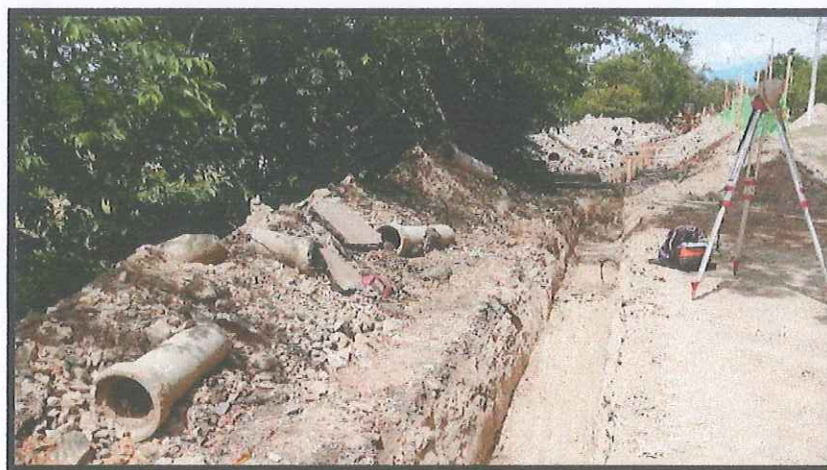
Ilustración 34: Retiro de Tubería existente Fuente: Propia
