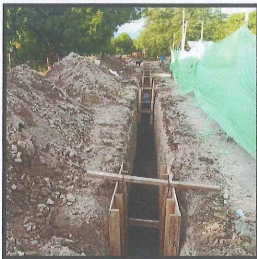
Ilustración 22: Entibados garantizando la seguridad de los trabajadores, Pozo 36 al 29
