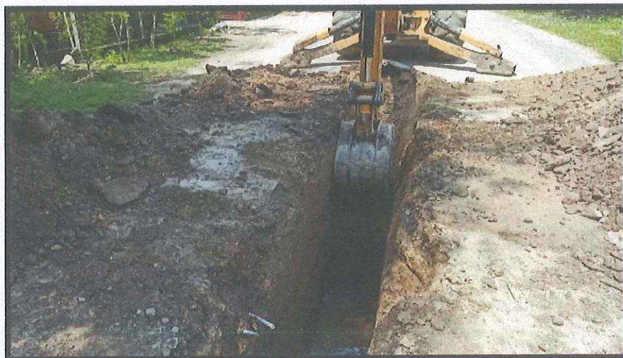
Ilustración 13: Excavación mecánica Pozo 31 al 29 Fuente: Propia
