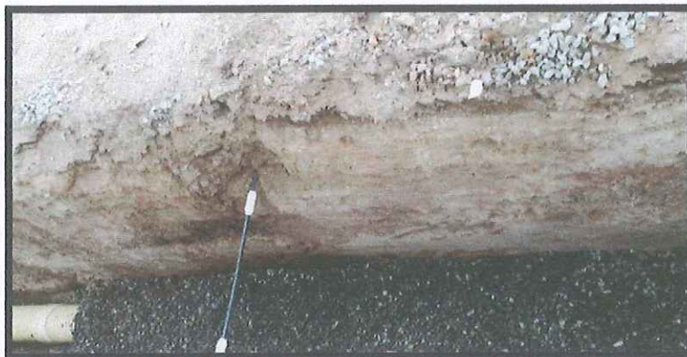
Ilustración 16: Regado de triturado de ½ a ¾ para atraque de tubería Pozo 31 al 30
