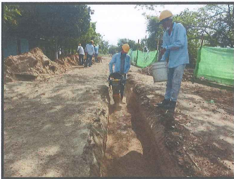
Ilustración 18: Compactación en zanja material seleccionado Pozo 31 al 30 Fuente: Propia
