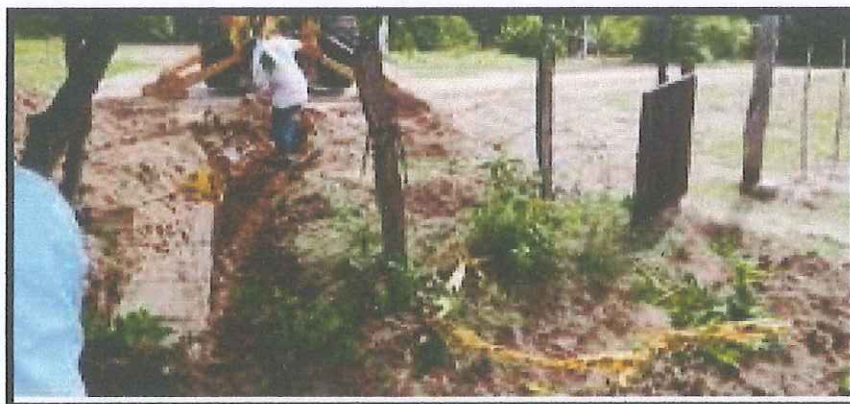
Ilustración 27: Excavación domiciliaria Fuente: Propia
