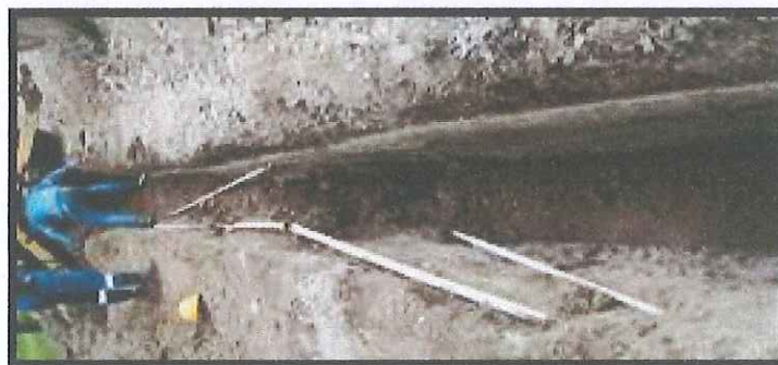
Ilustración 32: Instalación tubería 1 1/2"
