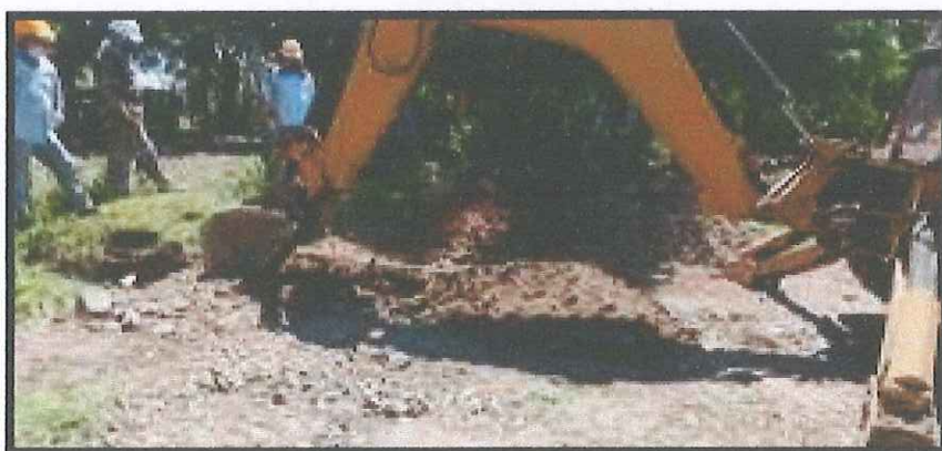
Ilustración 28: Excavación domiciliaria Fuente: Propia
