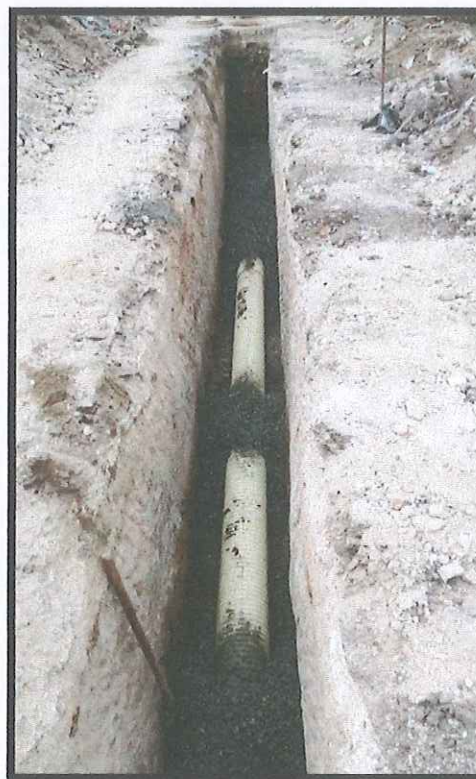
Ilustración 26: Instalación de Tubería PVC TDP 315 mm, Pozo 31 al 29 Fuente: Propia
