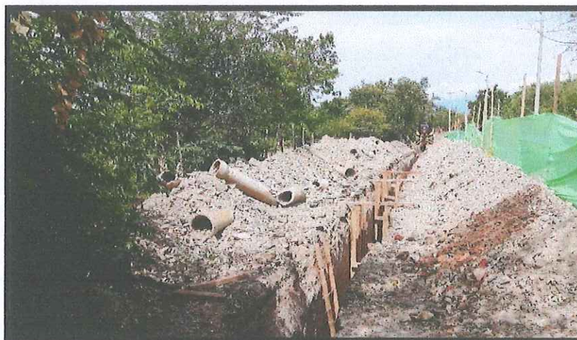
Ilustración 35: Retiro de Tubería existente Fuente: Propia
