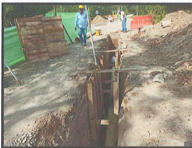
Ilustración 23: Entibados garantizando la seguridad de los trabajadores, Pozo 36 al 29
