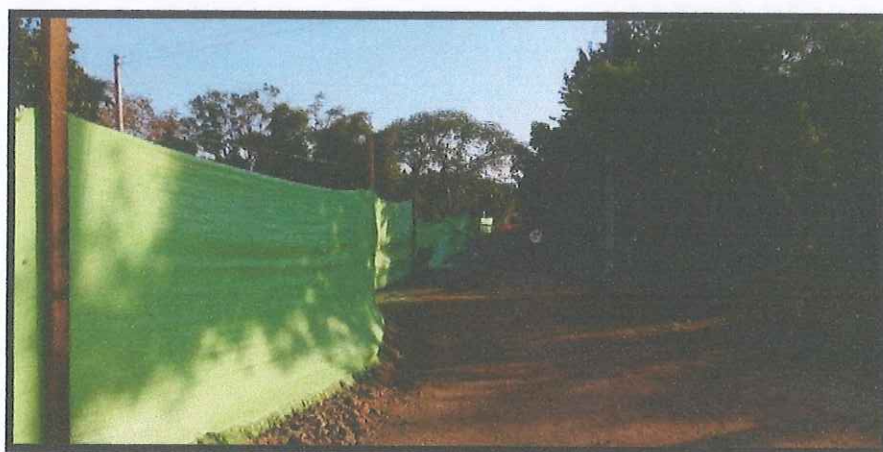
Ilustración 7: Señalización en guadua c/3m y polisombra de H=1.8m Pozo 30A al 30 Fuente: Propia
