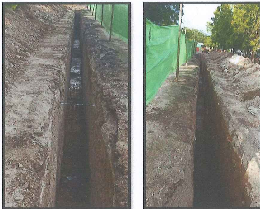
Ilustración 12: Excavación mecánica Pozo 31 al 29 Fuente: Propia
