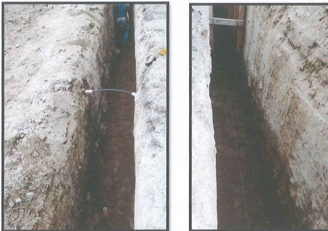
Ilustración 15: Instalación de Cama en arena fina para atraque de tubería Fuente: Propia
