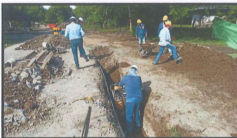
Ilustración 19: Compactación en zanja material seleccionado Pozo 31 al 30 Fuente: Propia
