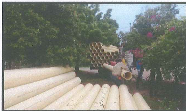
Ilustración 25: Acopio de Tubería PVC TDP 315 mm y 160 mm Fuente: Propia
