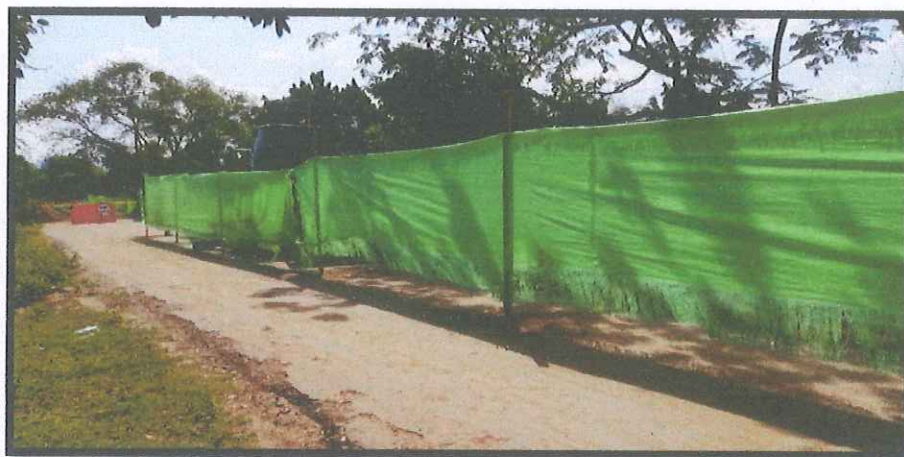
Ilustración 6: Señalización en guadua c/3m y polisombra de H=1.8m Pozo 31 al 30A Fuente: Propia
