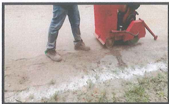
Ilustración 10: Corte de pavimento flexible Pozo 31 al 29 Fuente: Propia
