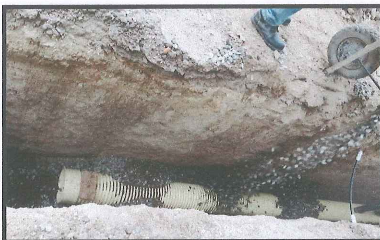
Ilustración 17: Regado de triturado de ½ a ¾ para atraque de tubería Pozo 30 al 29
