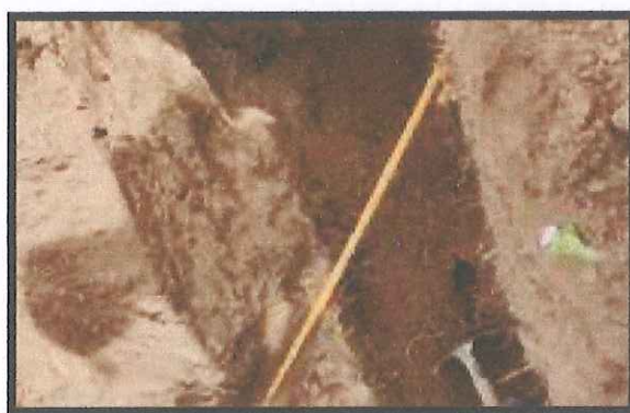
Ilustración 33: Instalación tubería de gas Fuente: Propia
