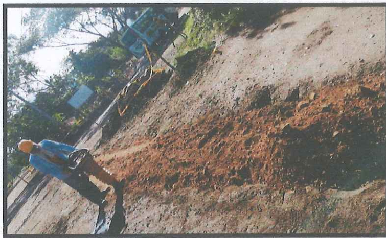
Ilustración 20: Última capa en zanja con Recebo compactado Pozo 31 al 30 Fuente: Propia
