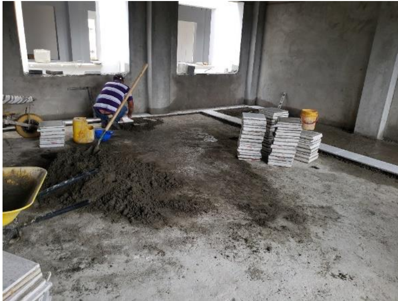
ENCHAPE DE PISO
