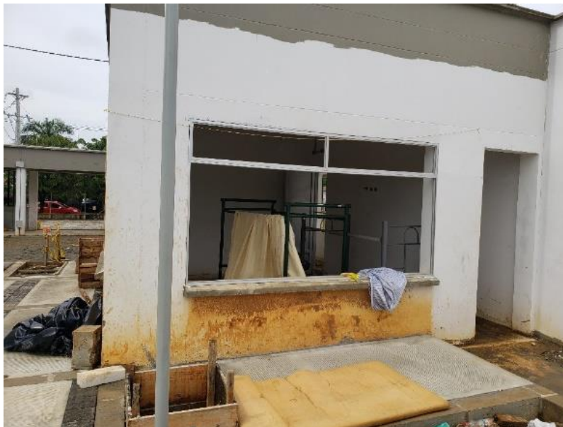
INSTALACIÓN DE VENTANAS
