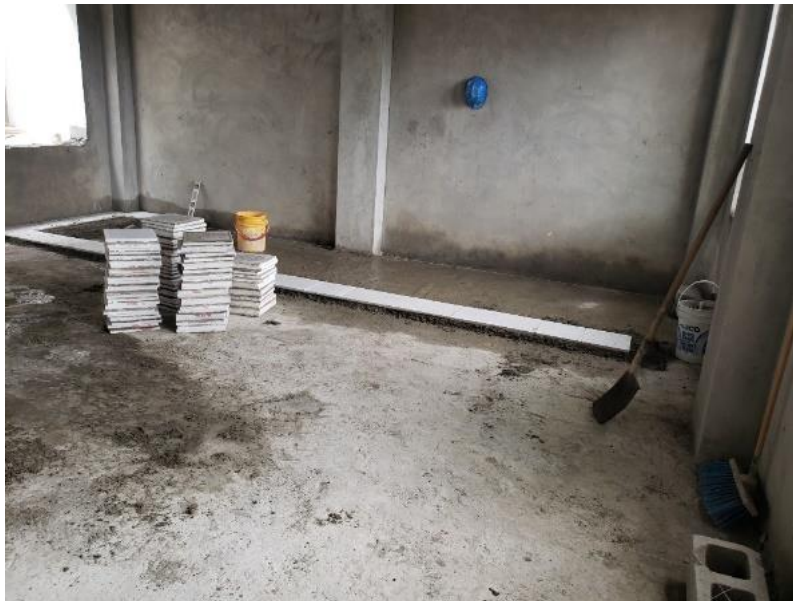
ENCHAPE DE PISO
