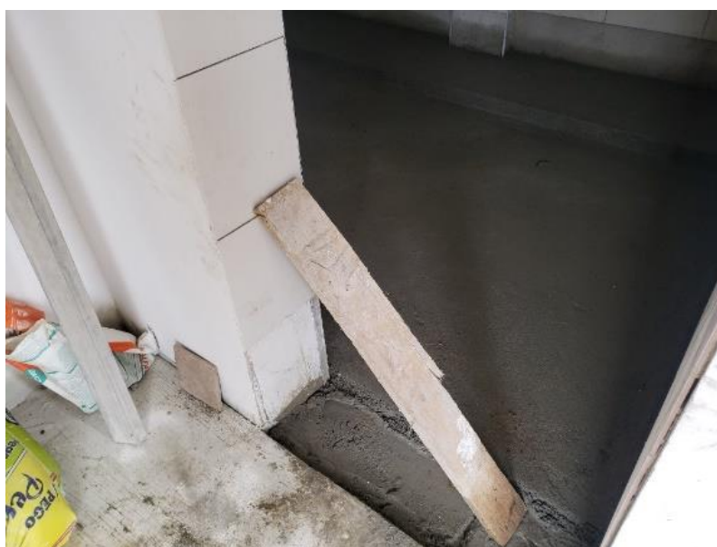
ENCHAPE DE PISO BAÑOS
