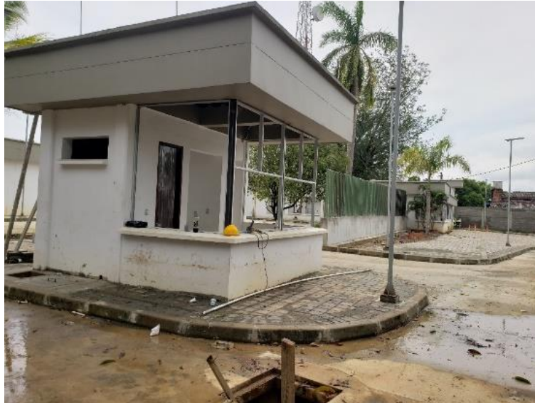
INSTALACIÓN DE VENTANAS
