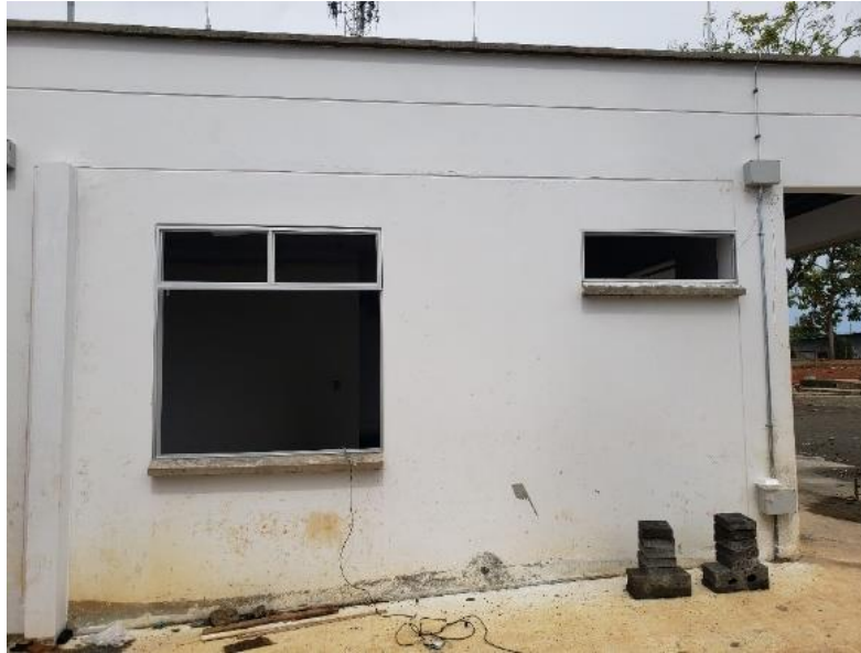
INSTALACIÓN DE VENTANAS
