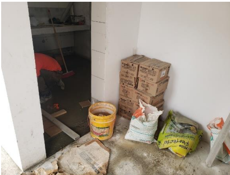
ENCHAPE DE PISO BAÑOS
