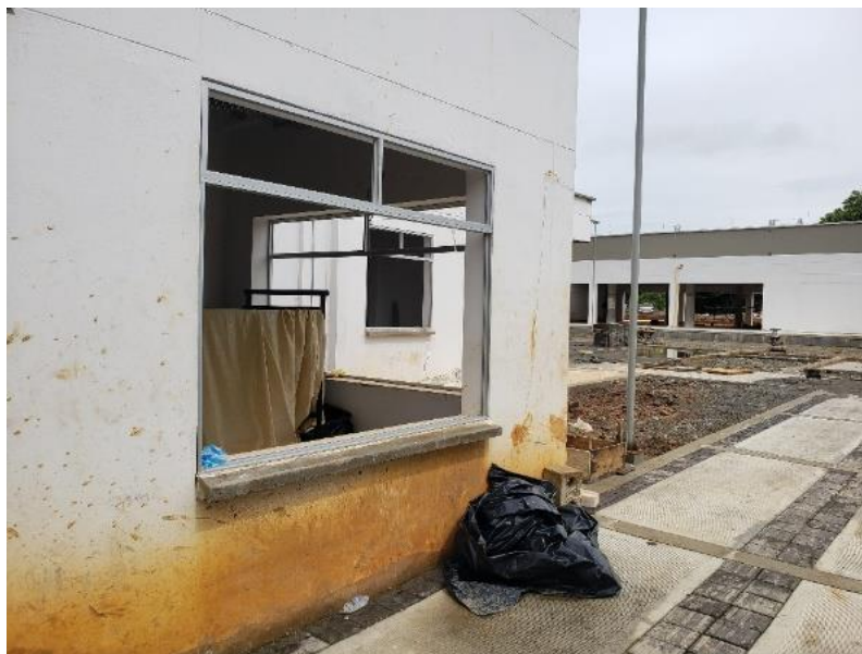
INSTALACIÓN DE VENTANAS
