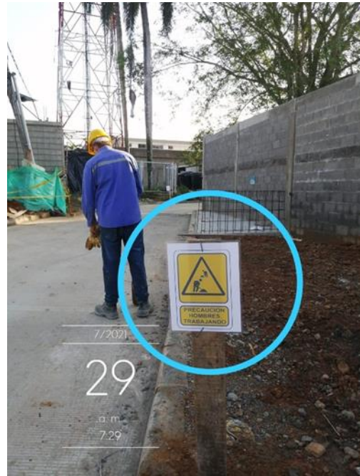
Foto No 6. Señalización en conjunto con lote 1
