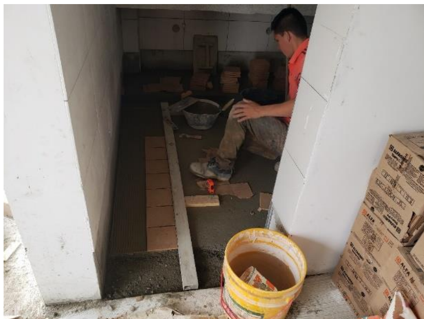
ENCHAPE DE PISO BAÑOS
