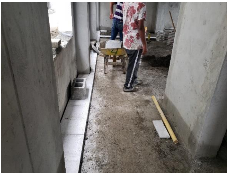
ENCHAPE DE PISO
