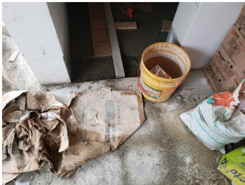
ENCHAPE DE PISO BAÑOS
