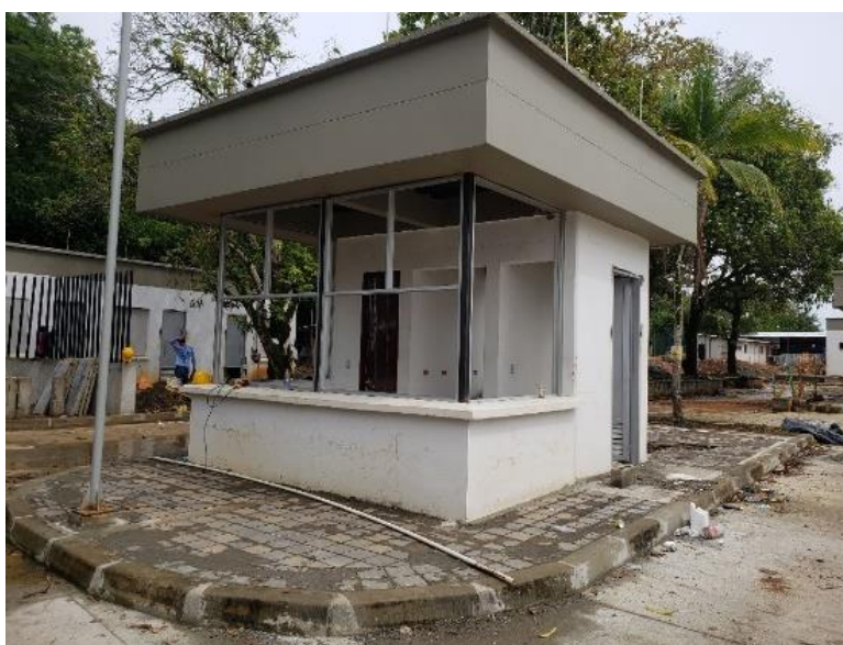
INSTALACIÓN DE VENTANAS
