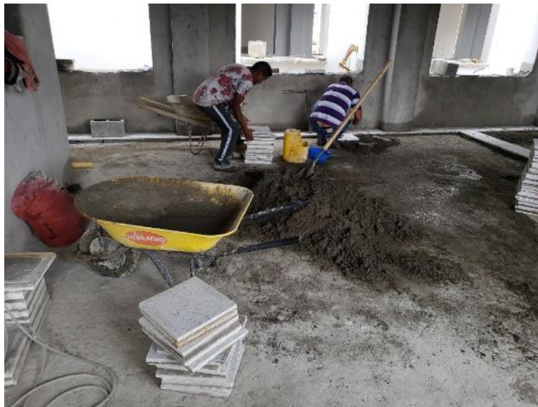
ENCHAPE DE PISO
