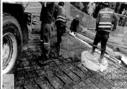
Foto 12 – figurado de acero para fundida de concreto MR-45
