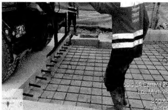
Foto 11 –Fundida de ultima losa de concreto
