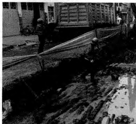
Foto 18 –sobre excavación para reparación de fallos
