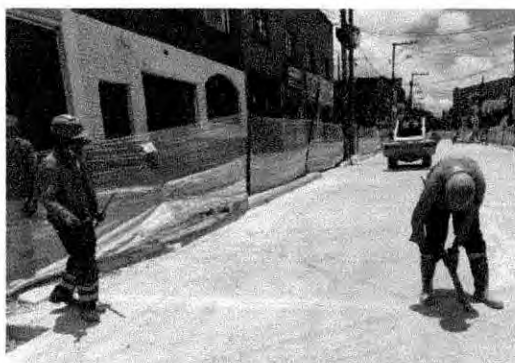
Foto 7 –juntas de dilatación
