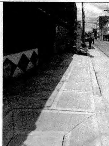
Foto 16 – Concreto para cinta de ajuste
