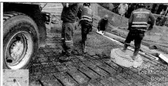
Foto 13 – Figurado de acero para fundir MR-45
