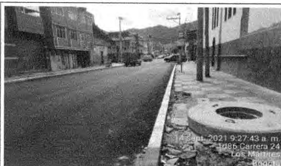
Foto 1 – CIV 14001469 – Instalación de hombros y bajo rampas
