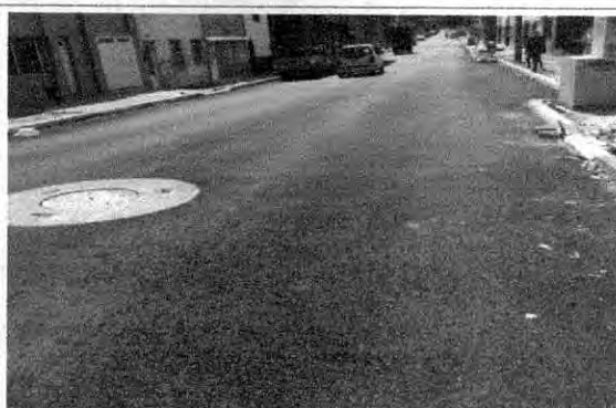
Foto 4 – CIV 14001481 – habilitación de la vía e instalación de hombros y bajo rampas
