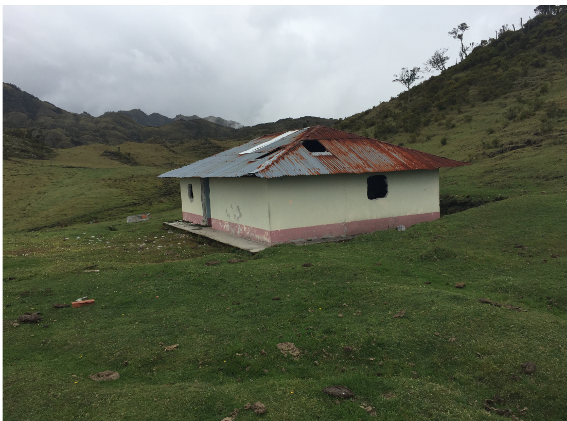
Casa dentro del predio y zona para enriquecimiento forestal sin ningún tipo de cobertura.
