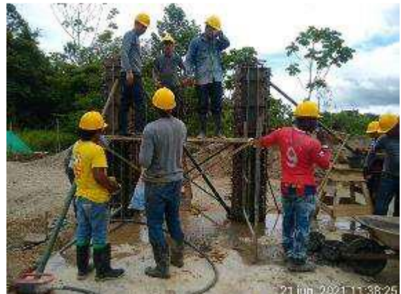
Foto 10: Figuración de acero para vigas de cimentación de la estructura 5.
