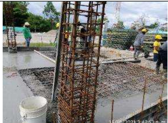
Foto 06: Armado de acero para losa de cimentación.
