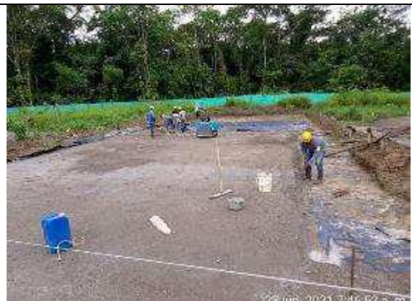
Foto 12: Excavación para vigas de cimentación estructura 5.
