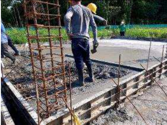
Foto 07: Vaciado de vigas de cimentación estructura 6.
