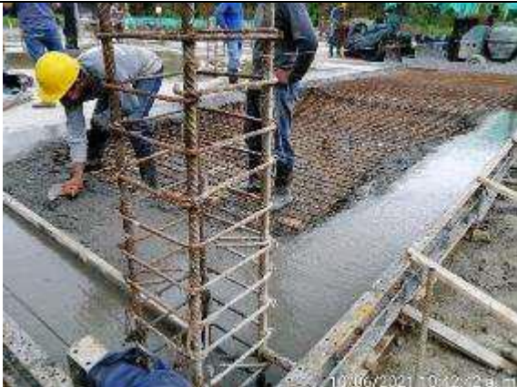
Foto 03: Armado de acero para vigas de cimentación de la estructura 6.
