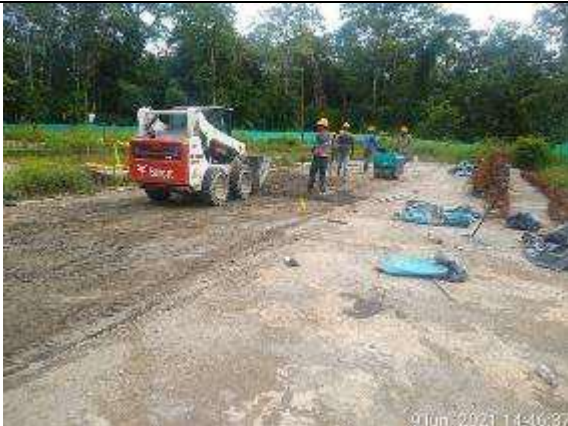
Foto 01: Excavación vigas de cimentación estructura 6.
