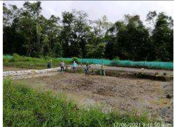
Foto 08: Vaciado de losa de cimentación estructura 6.
