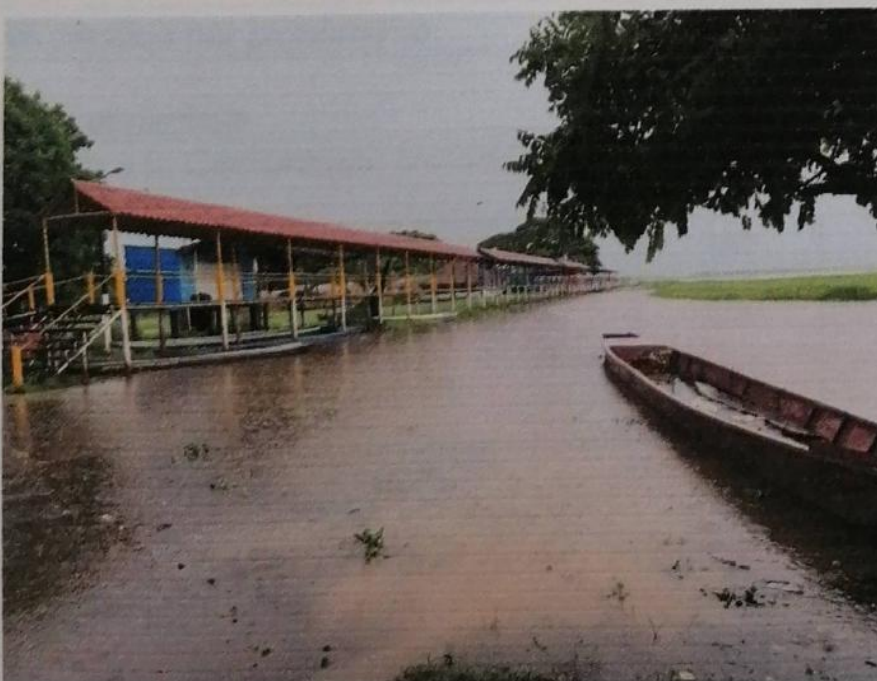
Imagen 7. Vista actual del puente peatonal del corregimiento llanito.
