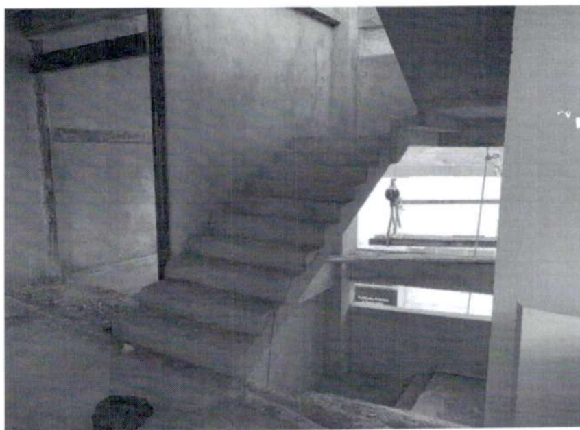
ZONA ESCALERAS Y FOSO ASCENSOR
