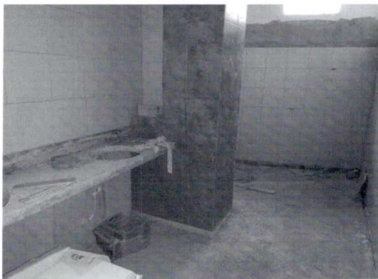
INTERIOR – ZONA BAÑOS
