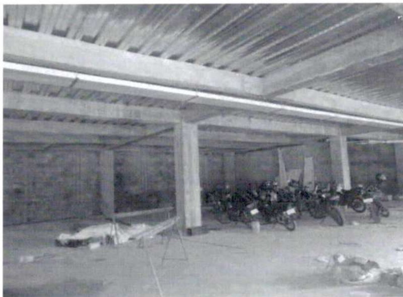
VISTA INFERIOR PLACA DE ENTREPISO
