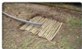
Figura 16. Excavación llena con tallos de café, para manejar sobrecargas hidráulicas o taponamientos en el sistema.
