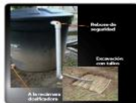
Figura 19. Entrada del agua miel al reactor hidrolítico y válvula de purga de gases.
