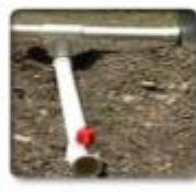
Figura 19. Entrada del agua miel al reactor hidrolítico y válvula de purga de gases.
