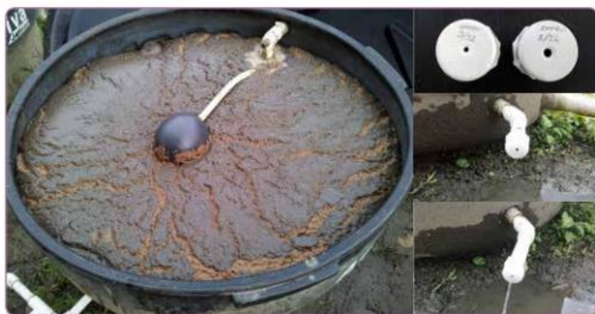
Figura 2. Aspecto de la recámara dosificadora y del orificio de salida del agua residual.
