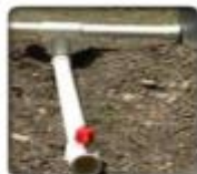
Figura 19. Entrada del agua miel al reactor hidrolítico y válvula de purga de gases.
