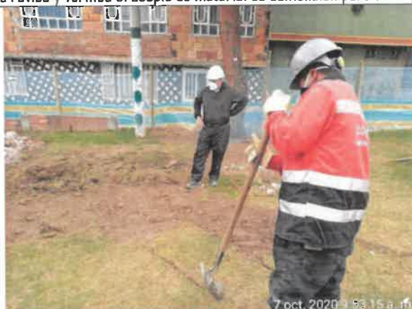
Foto No. 55. Se revisó y verifico el cumplimiento de la instalación del cerramiento perimetral, parque. PARQUE URBANIZACIÓN LA ESTANCIA. 19-038
