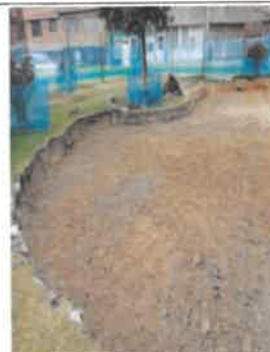
FOTO No 8. La interventoría ARQUITECTURA URBANA LTDA revisa y verifica que el contratista CONSORCIO OPORTO realice la actividad de excavación correspondiente al espesor de la estructura avalada por el especialista de geotecnia de la interventoría. La excavación realizada en el área de senderos es de 35 cm y en el área de juegos es de 45 cm, lo determinado por el Especialista
