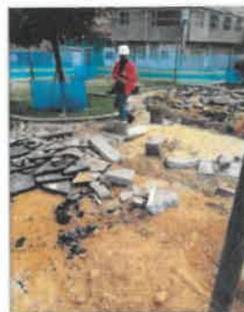
FOTO No 6. La interventoría ARQUITECTURA URBANA LTDA revisa y verifica que el contratista CONSORCIO OPORTO realice la actividad de demolición de la carpeta asfáltica, con un espesor de promedio de 8 cm de grosor.
