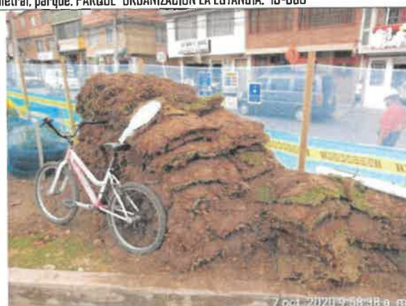
Foto No. 57. Se revisó y verifico el acopio del sepedón, parque. PARQUE URBANIZACIÓN LA ESTANCIA. 19-038
