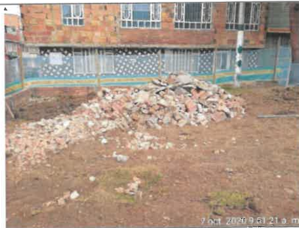
Foto No. 30. Se revisó y verificó la ubicación de los residuos generados en la actividad de desinstalación de juegos existentes, parque URBANIZACIÓN LA ESTANCIA (19-038)
