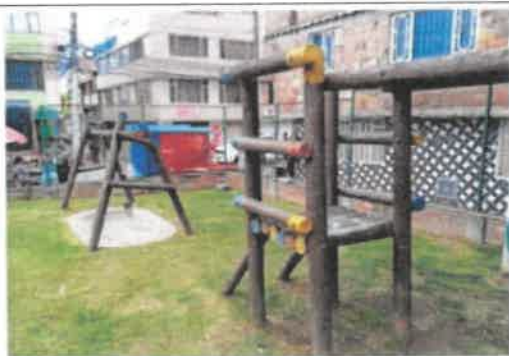
FOTO No 9. La interventoría ARQUITECTURA URBANA LTDA revisa y verifica que el contratista CONSORCIO OPORTO realice la actividad de desmonte del juego infantil en madera, el cual por su deterioro se da de baja mediante un acta de desmonte de mobiliario.
