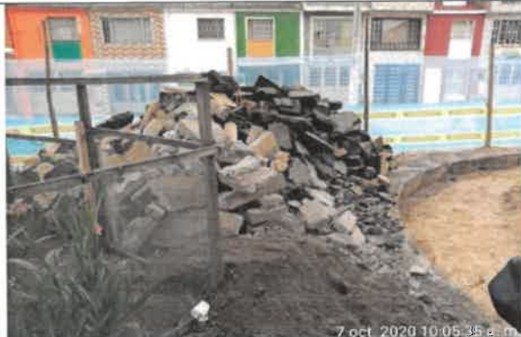
Foto No. 59. Se revisó y verifico el cumplimiento del protocolo de bioseguridad covid-19 y la demolición de la placa de juegos, parque. URBANIZACIÓN LA ESTANCIA. 19-150
