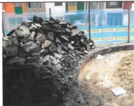
FOTO No 18. La interventoría ARQUITECTURA URBANA LTDA revisa y verifica que el contratista CONSORCIO OPORTO realice la actividad de demolición de la carpeta asfáltica, y el destino final del retiro se hará en los sitios de cantera certificadas.
