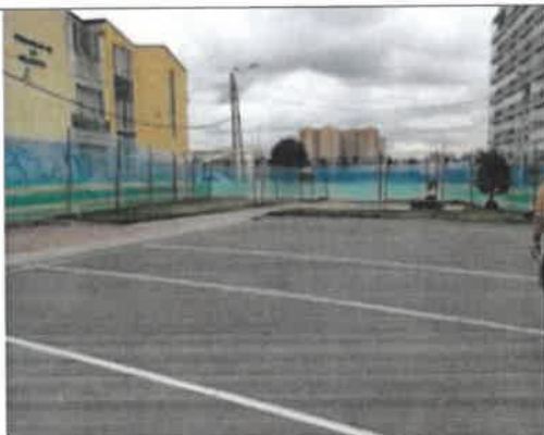
FOTO No 19. La interventoría ARQUITECTURA URBANA LTDA revisa y verifica que el contratista CONSORCIO OPORTO realice la actividad de cerramiento perimetral.
