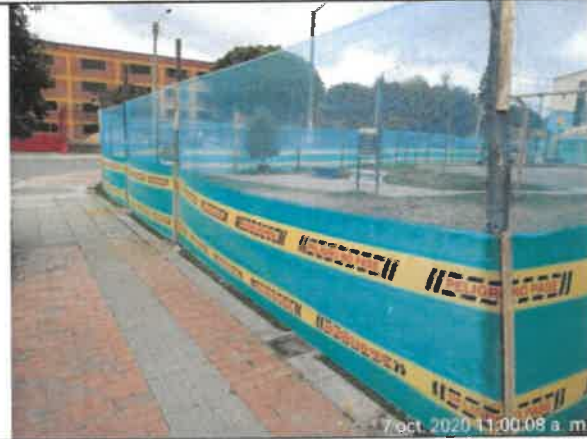
Foto No. 68. Se revisó y verificó el cumplimiento de la instalación del cerramiento parque en el parque CANDELARIA LA NUEVA II SECTOR 1ª ETAPA (19-479).
