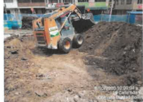
FOTO No 12. La interventoría ARQUITECTURA URBANA LTDA revisa y verifica que el contratista CONSORCIO OPORTO realice la actividad de excavación correspondiente al espesor de la estructura avalada por el especialista de geotecnia de la interventoría. La excavación es de 117,90 M2 x 0,35 de profundidad, de acuerdo a las cartenas topográficas.
