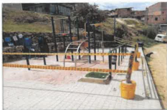
FOTO No 1. Se determina prolongar la tubería de la baranda existente M-80 con el propósito de controlar el acceso al parque. Se deja registro en bitácora de obra. El contratista CONSORCIO OPORTO inicia fabricación de complemento de baranda en taller.
