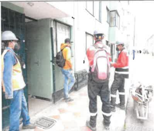
Foto No. 47. Se revisó y verificó el cumplimiento del protocolo en la desinfección de zapatos con hipoclorito de sodio al 2%. Área de campamento CONSORCIO OPORTO
