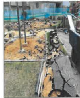
FOTO No 6. La interventoría ARQUITECTURA URBANA LTDA revisa y verifica que el contratista CONSORCIO OPORTO realice la actividad de demolición de la carpeta asfáltica, con un espesor de promedio de 8 cm de grosor.
