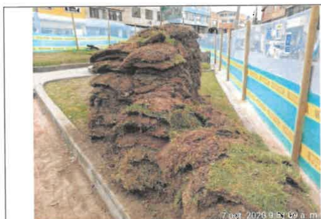
Foto No. 29. Se revisó y verificó la ubicación de los residuos generados en la actividad de desinstalación de juegos existentes, parque URBANIZACIÓN LA ESTANCIA (19-038)
