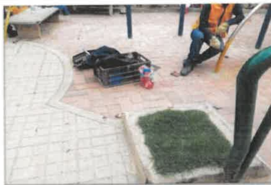
FOTO No 2. La interventoría ARQUITECTURA URBANA LTDA revisa y verifica el cumplimiento de las actividades en ejecución correspondientes al cambio de plataformas triangulares y cuadradas, Mantenimiento del MÓDULO M3 mediante pintura y cambio de rodadero, demolición de jardinera interior.
