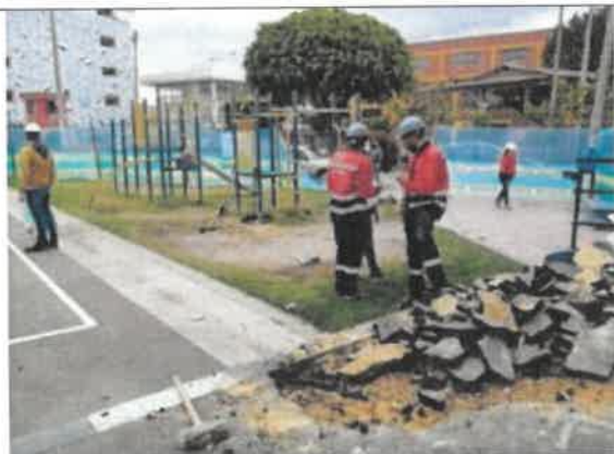
FOTO No 21. La interventoría ARQUITECTURA URBANA LTDA revisa y verifica que el contratista CONSORCIO OPORTO realice la actividad de DEMOLICIÓN DE LA CARPETA ASFÁLTICA. El grosor de la carpeta asfáltica fue del área donde se ubicarán los biosaludables fue de 10 cm.
