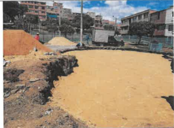
Foto No. 76. Se revisó y verifico el acopio temporal de material particulado, sin hacer uso
