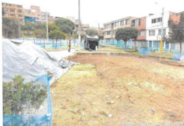
Foto No. 51. Se revisó y verifico el cumplimiento del protocolo de bioseguridad covid-19 y la instalación de un campamento provisional, parque. URBANIZACIÓN LA ESTANCIA. 19-039
