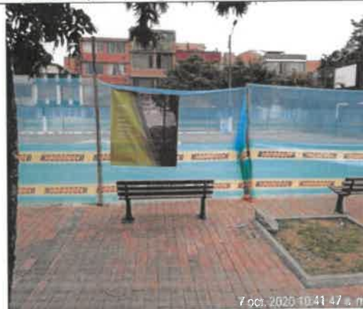
Foto No. 36. Se revisó y verificó la ubicación de la señalización, parque URBANIZACIÓN LA ESTANCIA (I9-149).
