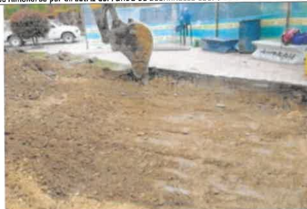
FOTO No 22. La interventoría ARQUITECTURA URBANA LTDA revisa y verifica que el contratista CONSORCIO OPORTO realice la actividad de excavación correspondiente y corresponde a la avalada por el especialista de geotecnia de la interventoría. 10cm de placa, 15 cm de base y 20 cm de sub-base. Las cantidades se soportarán en las memorias de cálculo, en cuanto a la excavación.
