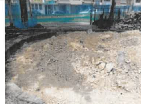
FOTO No 16. La interventoría ARQUITECTURA URBANA LTDA revisa y verifica que el contratista CONSORCIO OPORTO realice la actividad de excavación correspondiente al espesor de la estructura avalada por el especialista de geotecnia de la interventoría. 10cm. de placa, 15cm de base y 20 cm de sub-base. La excavación final fue de 40 cm. Se dejaron 5 cmm sobre el nivel para manejo de aguas de escorrentía.
