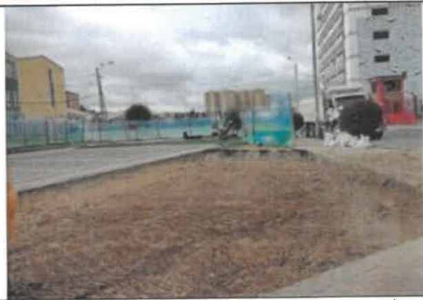
FOTO No 24. La interventoría ARQUITECTURA URBANA LTDA revisa y verifica que el contratista CONSORCIO OPORTO realice la actividad de excavación correspondiente al área de juegos infantiles de 45 cm que corresponde al espesor de la estructura, avalada por el especialista de geotecnia de la interventoría.
