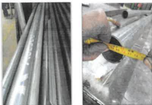
FOTO No 3. Se determina prolongar la tubería de la baranda existente M-80 con el propósito de controlar el acceso al parque. Se deja registro en bitácora de obra. El contratista CONSORCIO OPORTO inicia fabricación de complemento de baranda en taller.
