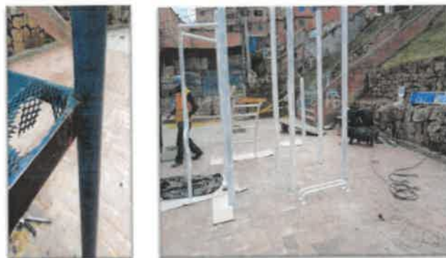
FOTO No 4. La interventoría ARQUITECTURA URBANA LTDA revisa y verifica que el contratista CONSORCIO OPORTO realice las actividades de pintura módulo existente y cambio de plataformas triangulares y cuadradas.
