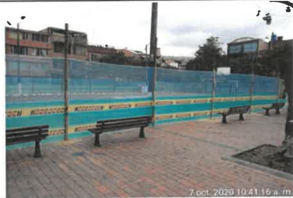
Foto No. 64. Se revisó y verificó el cumplimiento de la instalación del cerramiento, parque. URBANIZACIÓN LA ESTANCIA. 19-149
