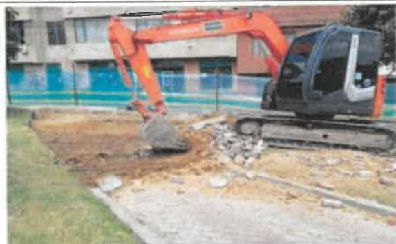
FOTO No 7. La interventoría ARQUITECTURA URBANA LTDA revisa y verifica que el contratista CONSORCIO OPORTO realice la actividad de demolición de la carpeta asfáltica.
