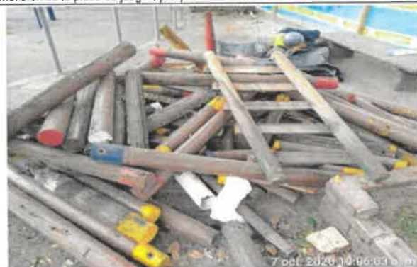
Foto No. 61. Se revisó y verifico el cumplimiento del PMT, parque. URBANIZACIÓN LA ESTANCIA. 19-150
