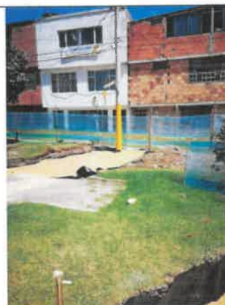
Foto No. 32. Se revisó y verificó la ubicación de los residuos generados en la actividad de desinstalación de juegos existentes, parque URBANIZACIÓN LA ESTANCIA (19-039)
