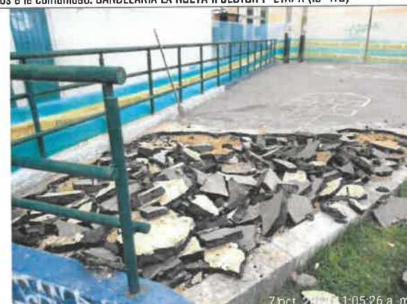
Foto No. 71. Se revisó y verificó el cumplimiento del acopio de carpeta asfáltica para la entrega al gestor autorizado en el parque CANDELARIA LA NUEVA II SECTOR 1ª ETAPA (19-479)
