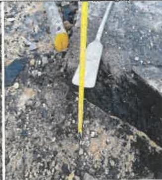
FOTO No 15. La interventoría ARQUITECTURA URBANA LTDA revisa y verifica que el contratista CONSORCIO OPORTO realice la actividad de demolición de la carpeta asfáltica. Se evidencian dos espesores: una área de 20 cm y otra de 14 cm.
