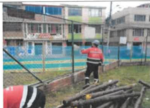
FOTO No 10. La interventoría ARQUITECTURA URBANA LTDA revisa y verifica que el contratista CONSORCIO OPORTO realice la actividad de desmonte del juego infantil en madera, el cual por su deterioro se da de baja mediante un acta de desmonte de mobiliario.
