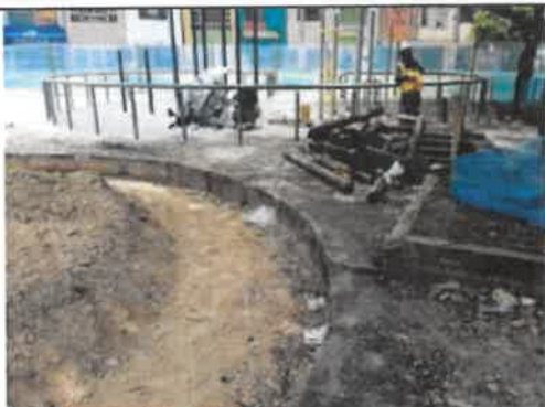
FOTO No 17. La interventoría ARQUITECTURA URBANA LTDA revisa y verifica que el contratista CONSORCIO OPORTO realice la actividad de demolición de la carpeta asfáltica. La interventoría evidenció que se manejaron dos espesores: una área de 20 cm y otra de 14 cm.
