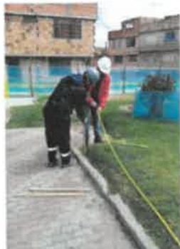
FOTO No 5. La interventoría ARQUITECTURA URBANA LTDA revisa y verifica que el contratista CONSORCIO OPORTO realice las actividades de localización y replanteo, se hace necesario desplazar la localización general en consenso hacia el sur para no afectar el árbol existente.
