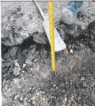
FOTO No 15. La interventoría ARQUITECTURA URBANA LTDA revisa y verifica que el contratista CONSORCIO OPORTO realice la actividad de demolición de la carpeta asfáltica. Se evidencian dos espesores: una área de 20 cm y otra de 14 cm.
