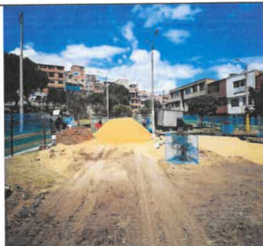
Foto No. 38. Se revisó y verificó la protección del material particulado en el parque URBANIZACIÓN LA ESTANCIA (19-039)
