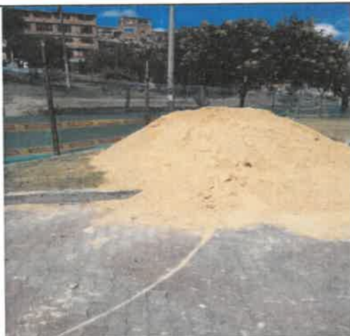
Foto No. 37. Se revisó y verificó la protección del material particulado en el parque URBANIZACIÓN LA ESTANCIA (19-039)
