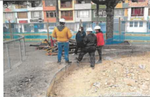
Foto No. 62. Se revisó y verifico el cumplimiento del protocolo de cerramiento, parque. URBANIZACIÓN LA ESTANCIA. 19-150.
