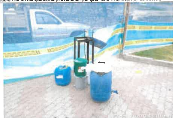
Foto No. 53. Se revisó y verifico el cumplimiento del protocolo de bioseguridad covid-19 la instalación del lavamanos, parque. URBANIZACIÓN LA ESTANCIA. 19-039
