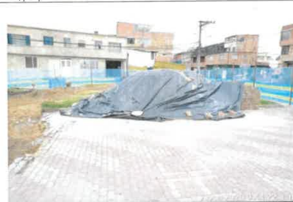
Foto No. 54. Se revisó y verifico el cumplimiento de la protección de los acopios del material, parque. URBANIZACIÓN LA ESTANCIA. 19-039
