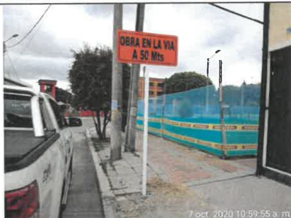
Foto No. 67. Se revisó y verificó el cumplimiento la existencia de la señalización del plan de manejo de tránsito (PMT) en el parque CANDELARIA LA NUEVA II SECTOR 1ª ETAPA (19-479)
