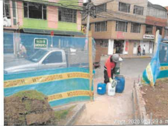
Foto No. 48. Se revisó y verificó el cumplimiento del protocolo de bioseguridad en la señalización covid-19. Área parque URBANIZACIÓN LA ESTANCIA 19-039
