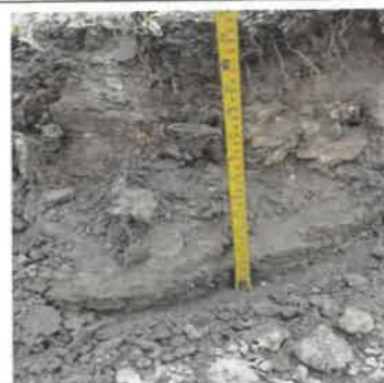
FOTO No 8. La interventoría ARQUITECTURA URBANA LTDA revisa y verifica que el contratista CONSORCIO OPORTO realice la actividad de excavación correspondiente al espesor de la estructura avalada por el especialista de geotecnia de la interventoría. La excavación realizada en el área de senderos es de 35 cm y en el área de juegos es de 45 cm, lo determinado por el Especialista
