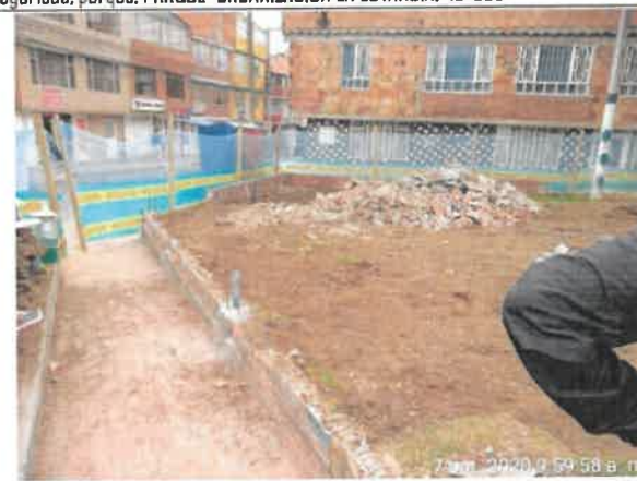
Foto No. 58. Se revisó y verifico el acopio del material de escombros, parque. PARQUE URBANIZACIÓN LA ESTANCIA. 19-038
