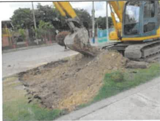
FOTO No 23. La interventoría ARQUITECTURA URBANA LTDA revisa y verifica que el contratista CONSORCIO OPORTO realice la actividad de excavación correspondiente al espesor de la estructura del piso del área de juego infantil de 45 cm avalada por el especialista de geotecnia de la interventoría
