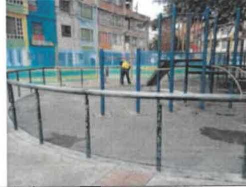
FOTO No 14. La interventoría ARQUITECTURA URBANA LTDA revisa y verifica que el contratista CONSORCIO OPORTO realice el proceso de mantenimiento del juego infantil existente módulo M3. con lija y aplicación de anticorrosivo.
