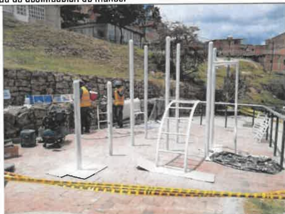
Foto No. 31. Se revisó y verificó la ubicación de la caneca para la recolección de residuos, parque URBANIZACIÓN LAS HUERTAS (19-287)
