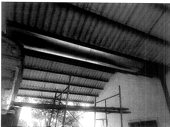
INSTALACION DE LAMINA GALVANIZADA, INCLUYE DOBLEZ DE LA TEJA DE 1,2*2,4 MT, INCLUYE IMPERMEABILIZACIÓN DE DESAGUE POR SECTOR SUPERIOR, PINTURA SECCIÓN BAJA CON ANTICORROSIVO Y ACABADO PINTURA ACEITE
