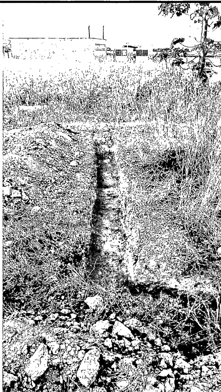
Fotografía 14 – Excavación para acometida tubería transporte de combustible
