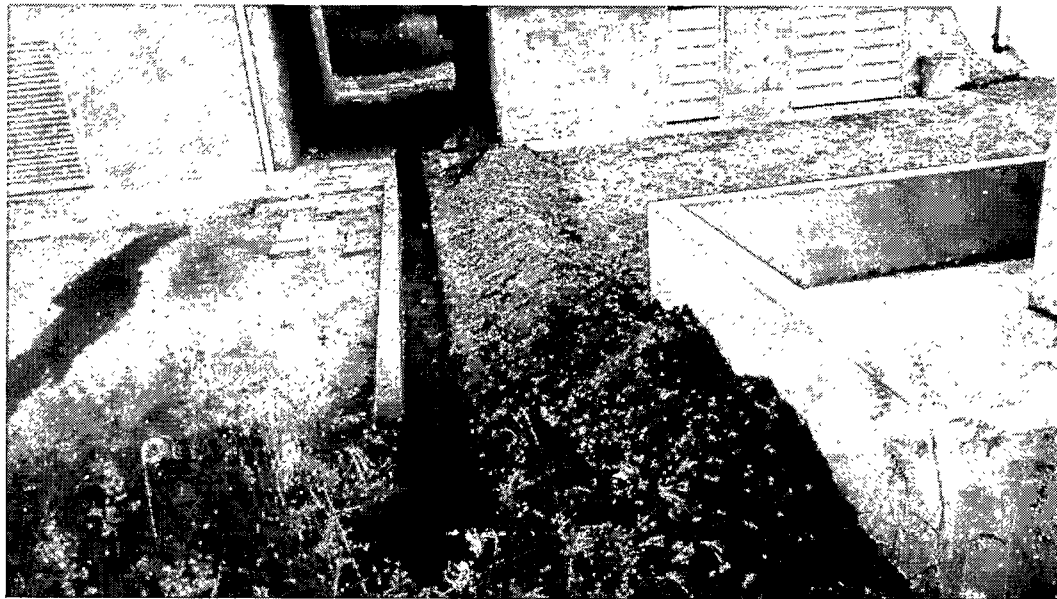
Fotografía 5 – Excavación para acometida eléctrica y acometida tubería combustible
