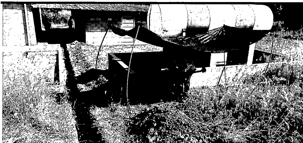
Fotografía 19 – Excavación para caseta.
