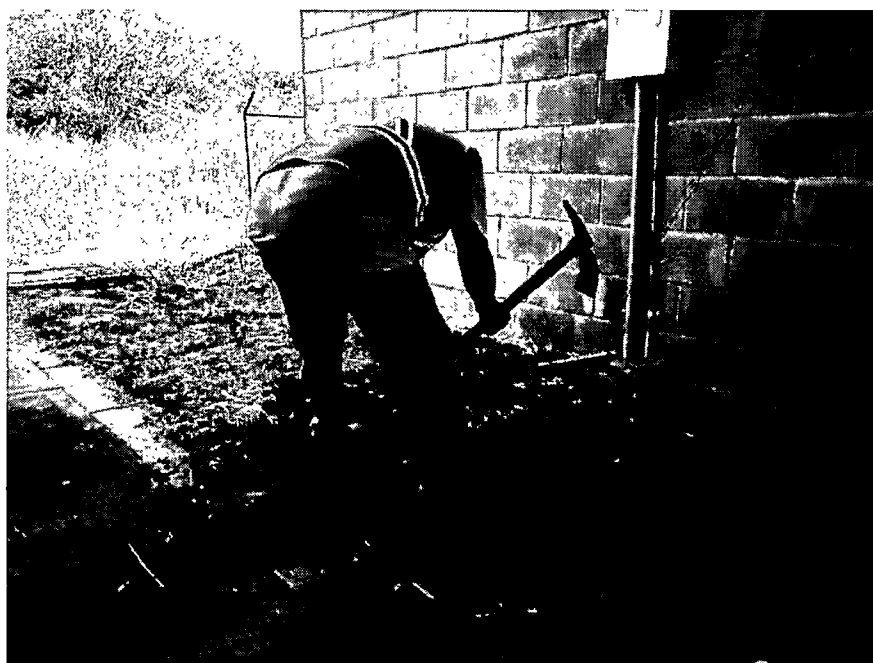
Fotografía 1 – Excavación para acometida eléctrica y inicio de obra
