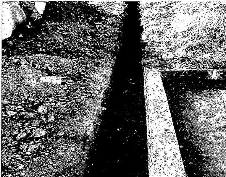
Fotografía 9 – Excavación para acometida tubería transporte de combustible
