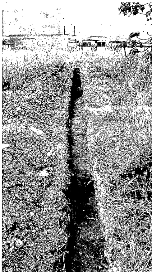
Fotografía 16 – Excavación para acometida tubería transporte de combustible
