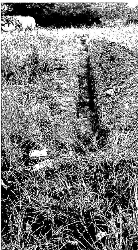
Fotografía 15 – Excavación para acometida tubería transporte de combustible
