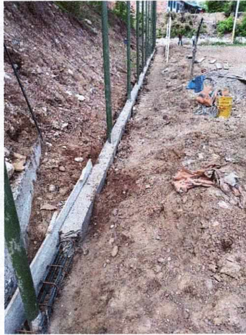
Construcción de Viga, incluye Acero
