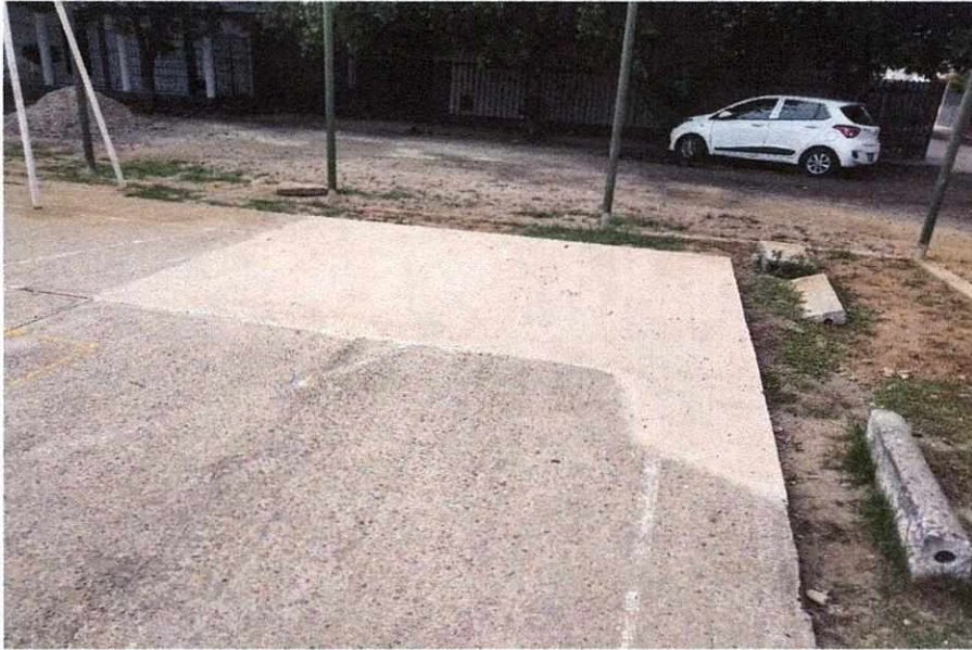
Demolición y Construcción de Placa Barrio Villa Urbe
