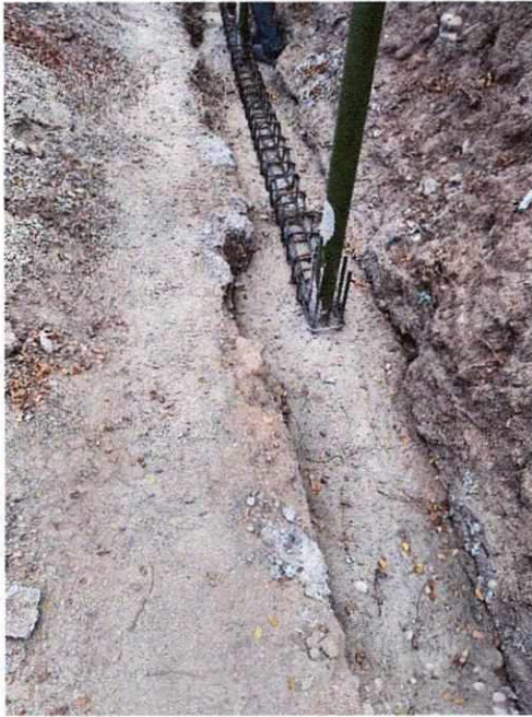
Construcción de Viga, incluye Acero
