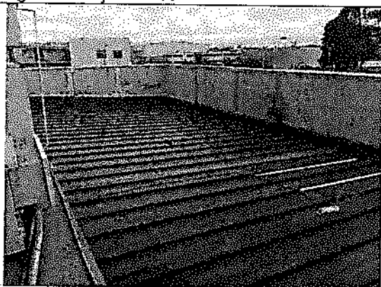
Mantenimiento de cubierta, canales red de agua lluvia y canales
