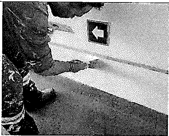
Resane y pintura oficinas D1 2.80m2
