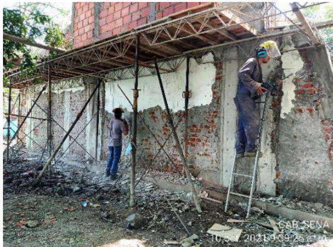
ESCARIFICADO PAÑETE MUROS EXISTENTES
