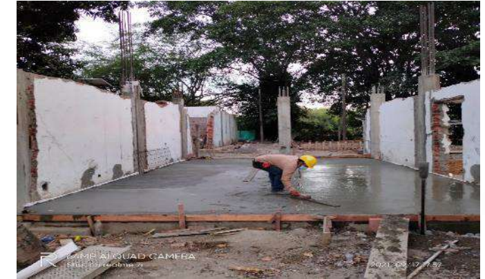
CONSTRUCCION PLACA CONTRAPISO
