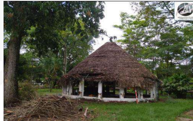
DESMANTELAMIENTO PUERTAS Y VENTANAS EXISTENTES
