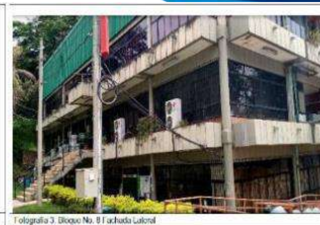
Fotografía 3. Bloque No. 8 Fachada Lateral
