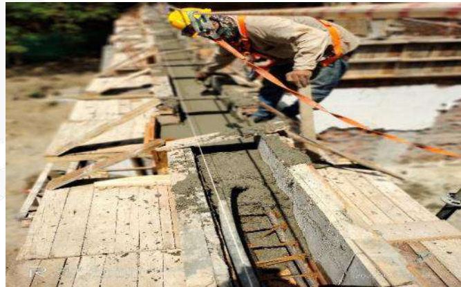
CONSTRUCCION VIGAS AEREAS
