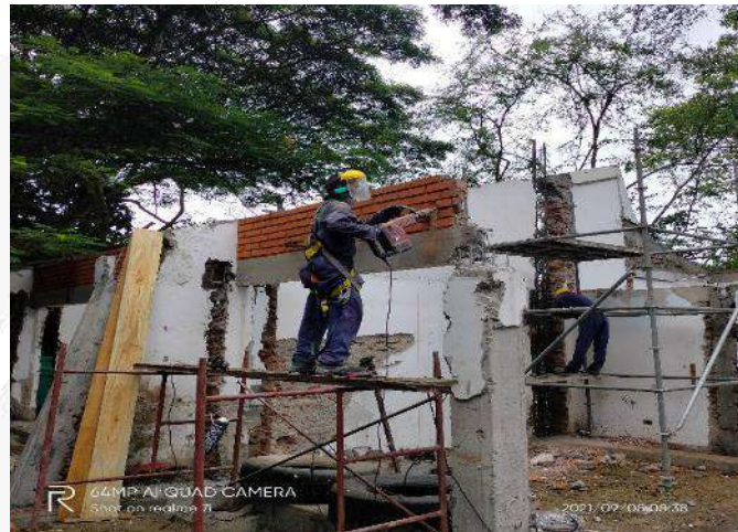
CORTES DE MUROS EXISTENTES PARA CONSTRUCCION DE ESTRUCTURA DE CONFINAMIENTO
