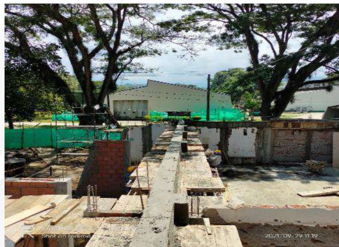
CONSTRUCCION VIGAS AEREAS
