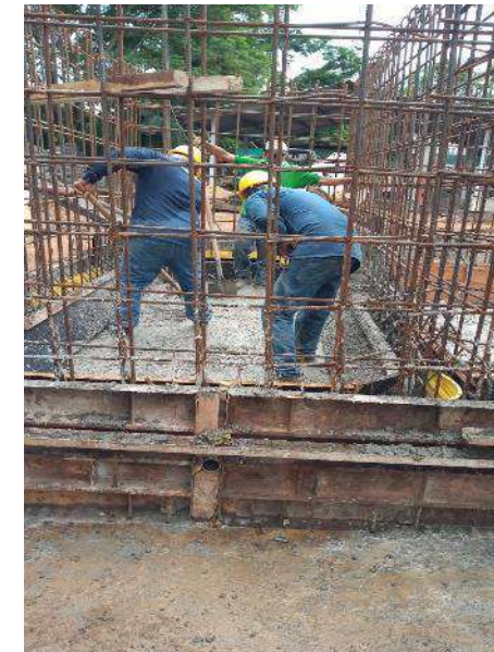
Fundida placa tanque
