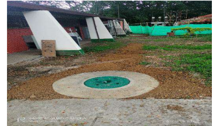
RELLENO E INSTALACION POZO RED SANITARIA
