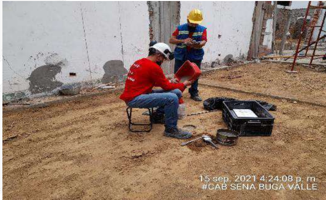
TOMA DE DENSIDADES A RELLENO PLACA CANTRAPISO
