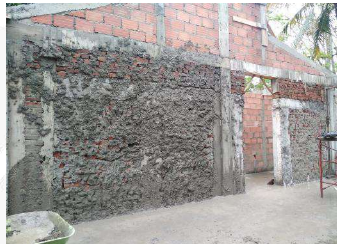
PAÑETES SOBRE MUROS INTERNOS
