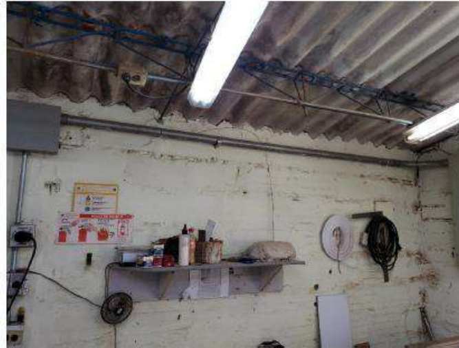
Ilustración 103 Tomacorrientes luminarias bloque 42
