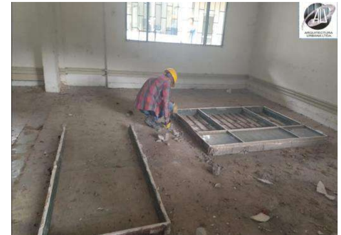
DESMONTE DE PUERTAS Y VENTANAS BLOQUE 33
