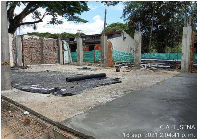
CONSTRUCCION REFORZAMIENTO ESTRUCTURAL COLUMNAS
