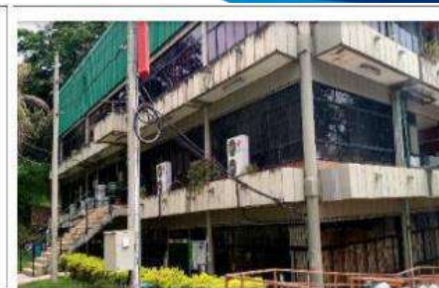
Fotografía 3: Bloque No. 8 Fachada Lateral
