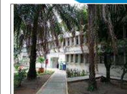
Fotografía 7. Bloque No. 10 Administrativo – Despacho Regional
