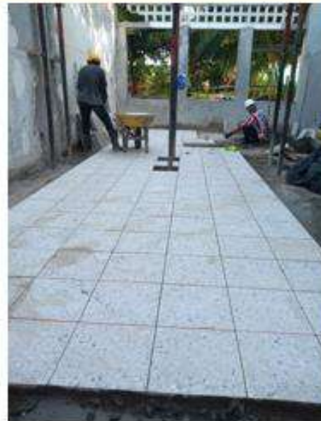
Instalación pisos dormitorio 1
