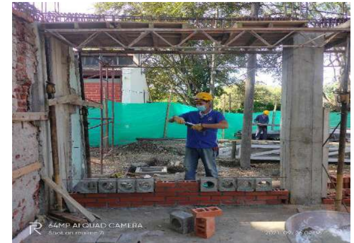
MAMPOSTERIA EN LADRILLO PRENSADO SEGÚN DISEÑOS
