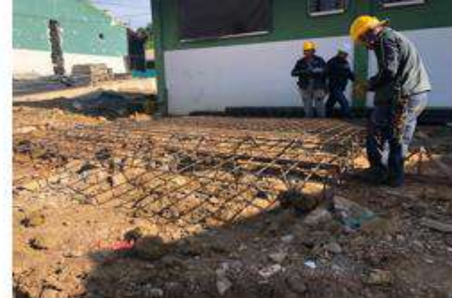
Acero placa tanque
