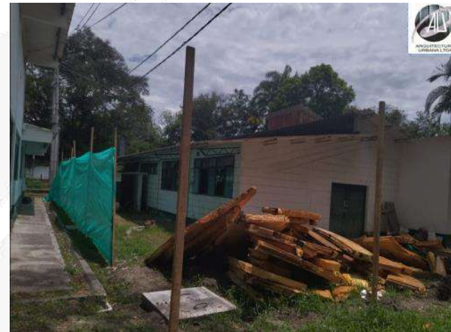
INSTALACIÓN DE CERRAMIENTO BLOQUE 36
