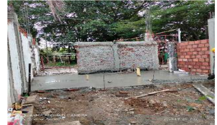
CONSTRUCCION PLACA CONTRAPISO
