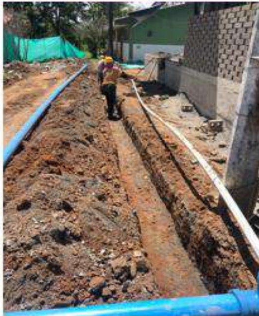
Instalación redes hidráulicas y contra incendios.
