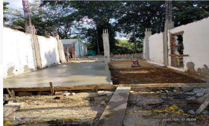
CONSTRUCCION PLACA CONTRAPISO
