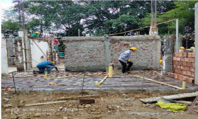
INSTALACION DE TUBERIA SANITARIA
