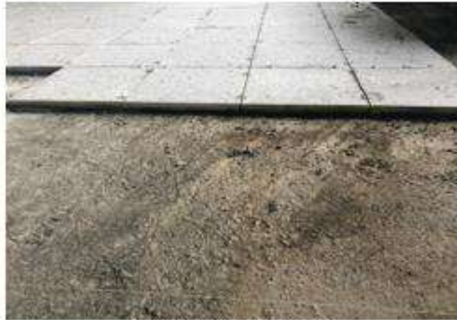
Instalación piso Dormitorio 5
