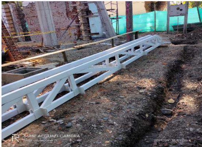
FABRICACION ESTRUCTURA METALICA
