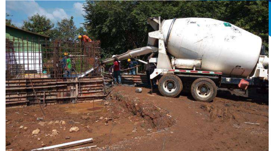
Fundida placa tanque
