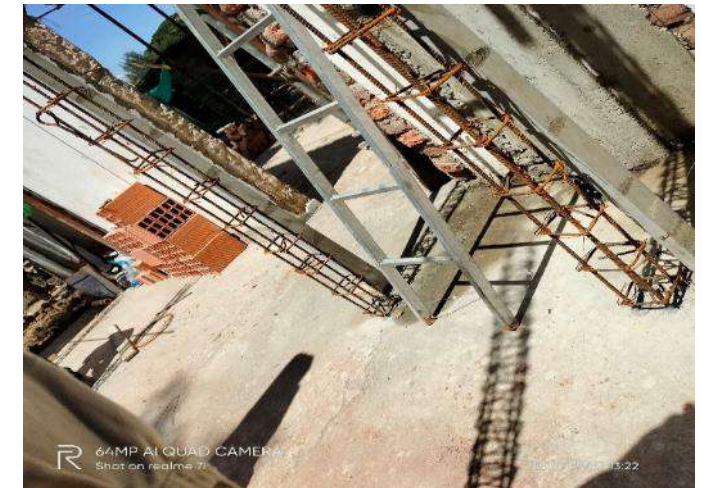
INSTALACION ACERO REFUERZO COLUMNETAS DE CONFINAMIENTO
