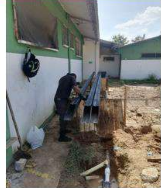
Estructura para cubierta
