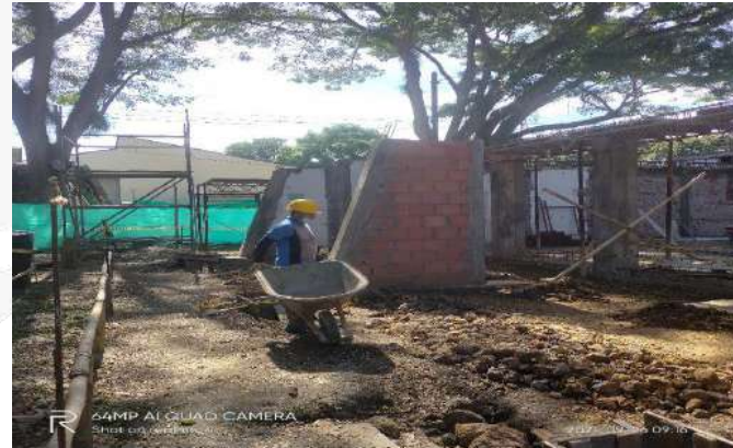
RELLENO AREA ANDEN FACHADA
