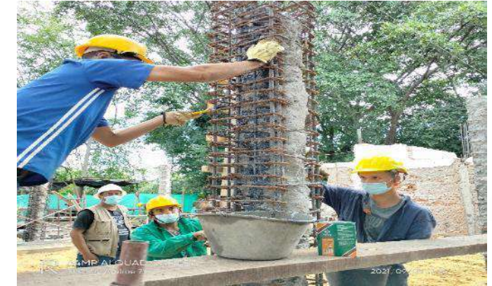
INSTALACION ACERO REFORZAMIENTO COLUMNAS
