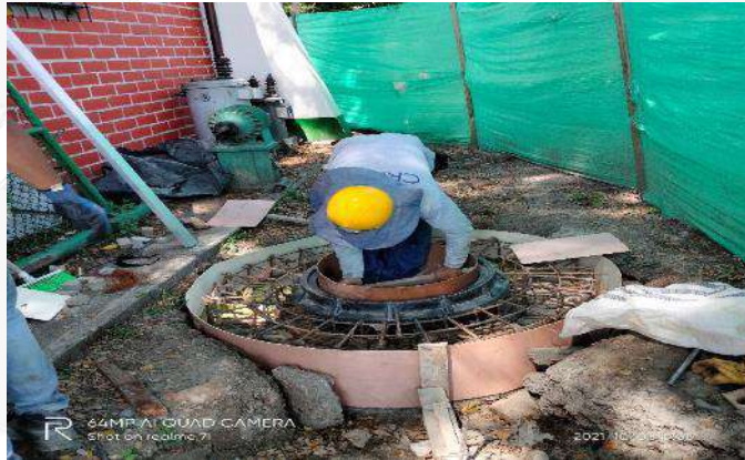
CONSTRUCCION POZO RED SANITARIA
