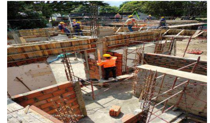
CONSTRUCCION MAMPOSTERIA Y VIGAS AEREAS
