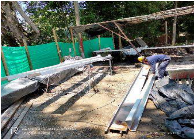
FABRICACION ESTRUCTURA METALICA
