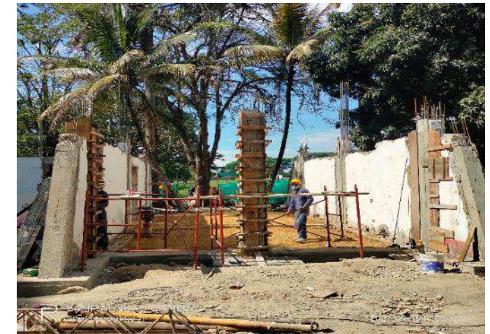
ENCOFRADO DE COLUMNAS
