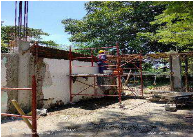
CONSTRUCCION MUROS ANTEPECHO
