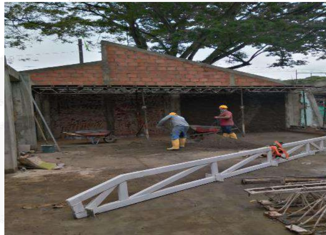
MAMPOSTERIA CONFINADA COLUMNETAS Y VIGUETAS
