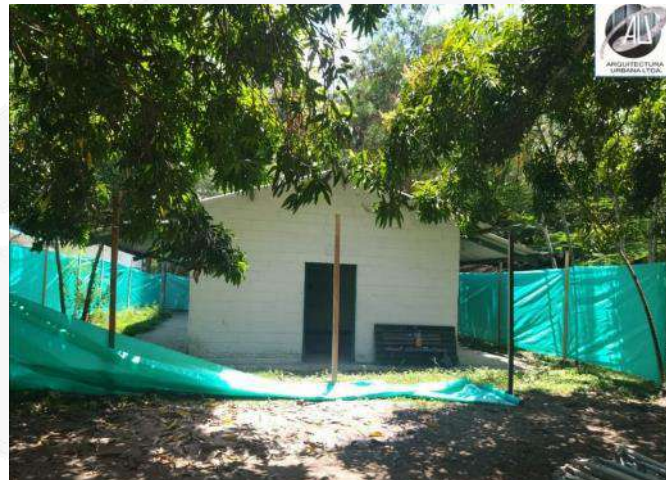
INSTALACIÓN DE CERRAMIENTO BLOQUE 33
