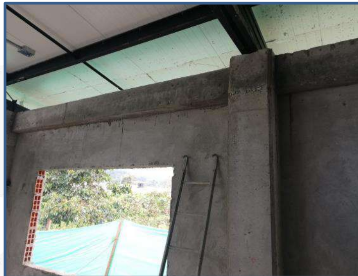
Viga de amarre y cajas de inspección
