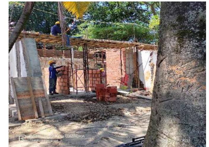
CONSTRUCCION MAMPOSTERIA Y VIGAS AEREAS
