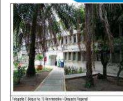
Fotografía 7. Bloque No. 10 Administrativo – Despacho Regional
