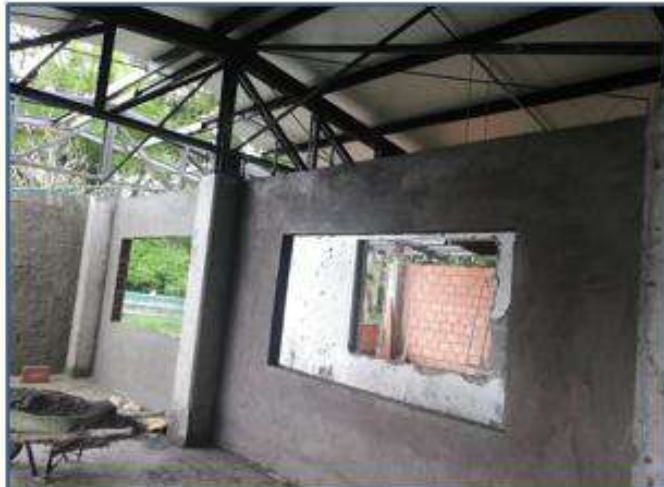
TERMINACION EST METALICA - REGADA TUBERIA PRESION Y ELECTRICA
