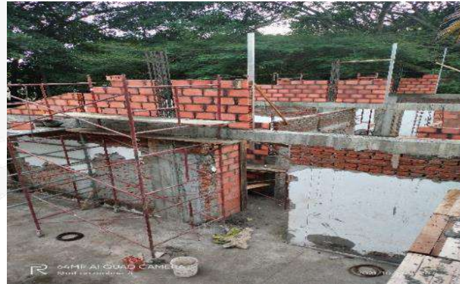
CONSTRUCCION VIGAS AEREAS Y MAMPOSTERIA
