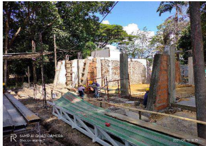
CONSTRUCCION MAMPOSTERIA CONFINADA
