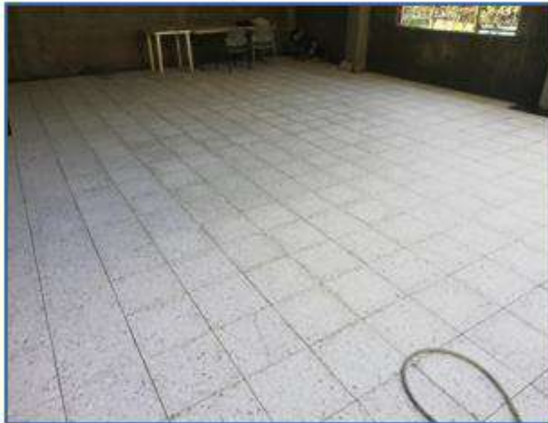
INSTALACION SALIDA LAMPARAS - PEGA PISOS TABLETA MARMOL
