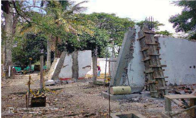
CONSTRUCCION REFORZAMIENTO ESTRUCTURAL COLUMNAS
