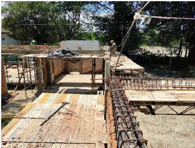
ARMADO ACERO DE REFUERZO VIGAS AEREAS
