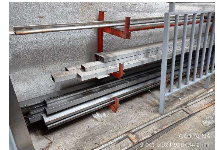
ACOPIO MATERIAL TALLER PARA FABRICACION PUERTAS METALICAS
