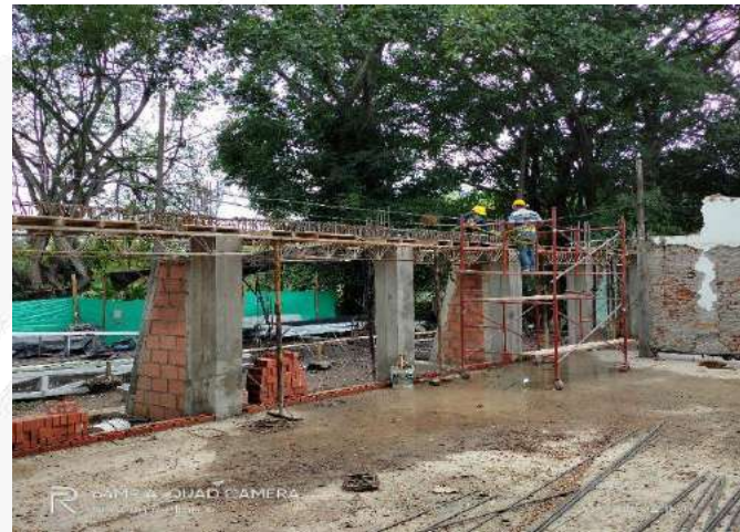
ARMADO DE ACERO REFUERZO VIGAS AEREAS
