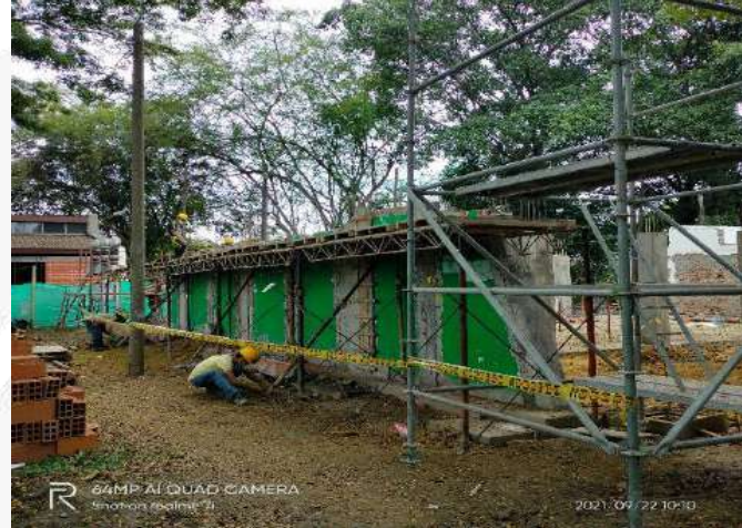
ARMADO ESTRUCTURA SOPORTE PARA CONSTRUCCION VIGAS AEREAS
