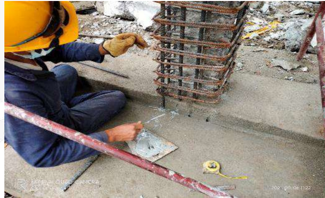
APLICACIÓN EPOXICO ANCLAJE REFORZAMIENTO COLUMNAS
