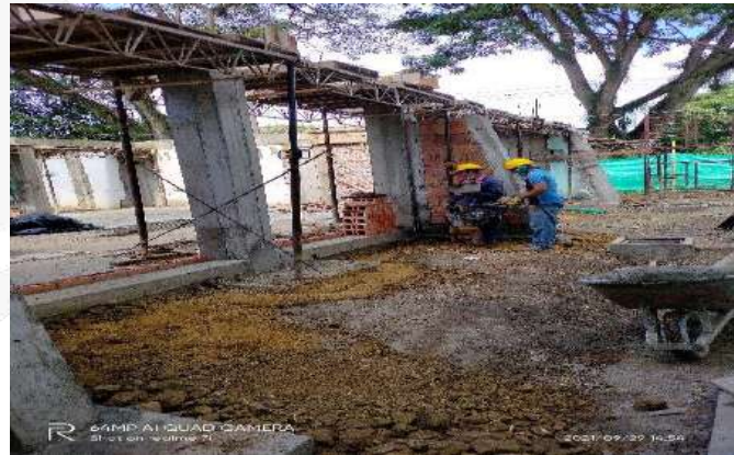
RELLENO AREA ANDEN FACHADA
