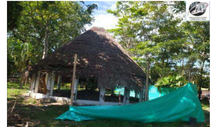
INSTALACIÓN DE CERRAMIENTO BLOQUE 4
