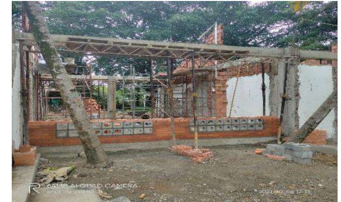
CONSTRUCCION MAMPOSTERIA Y VIGAS AEREAS
