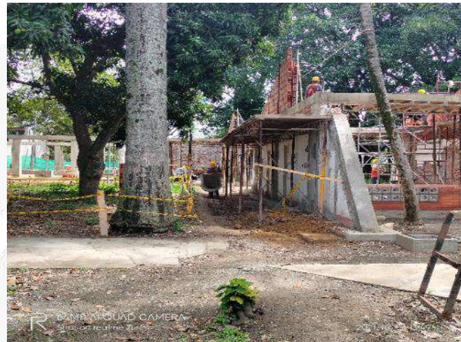
ARMADO ESTRUCTURA SOPORTE PARA CONSTRUCCION VIGAS AEREAS
