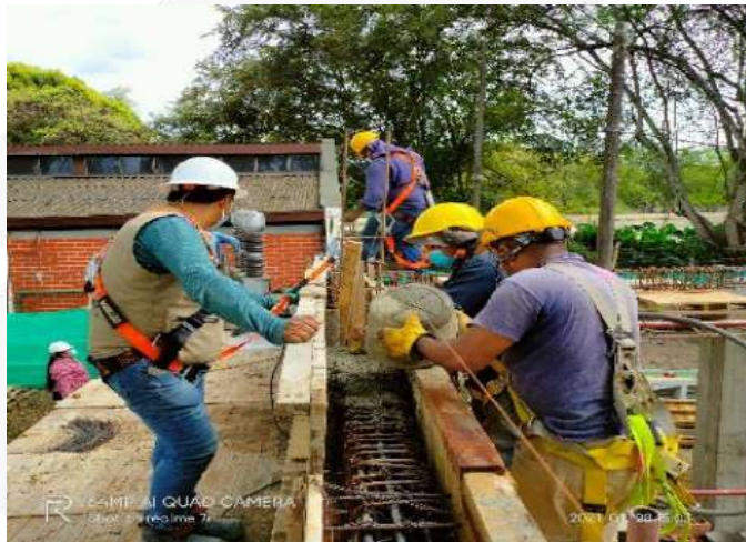
FUNDIDA DE CONCRETO VIGAS AEREAS
