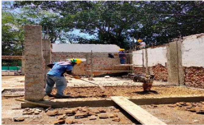
COMPACTACION RELLENO PLACA CANTRAPISO
