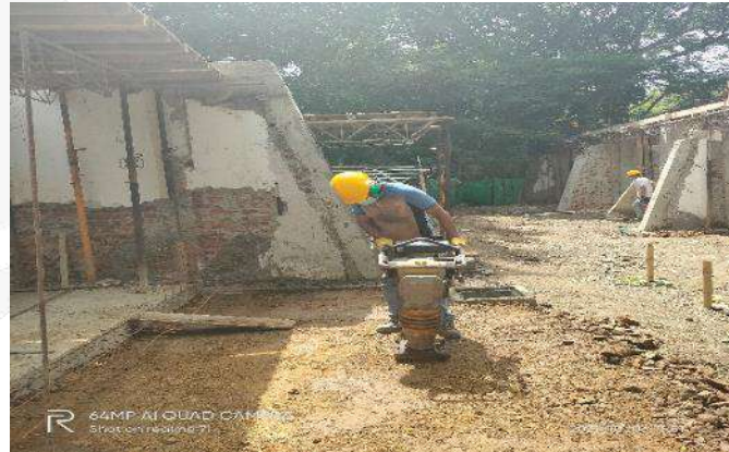
RELLENO AREA ANDEN FACHADA
