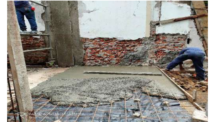
CONSTRUCCION PLACA CONTRAPISO
