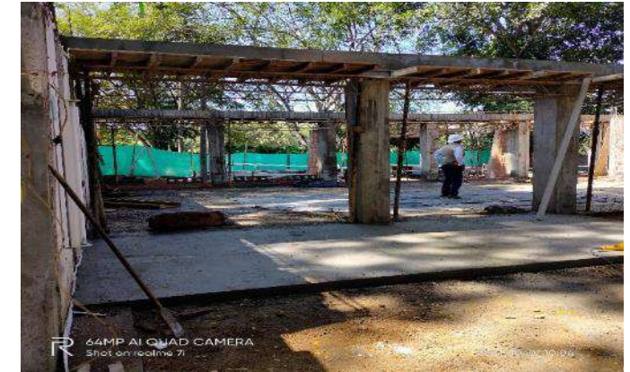
CONSTRUCCION PLACA CONTRAPISO
