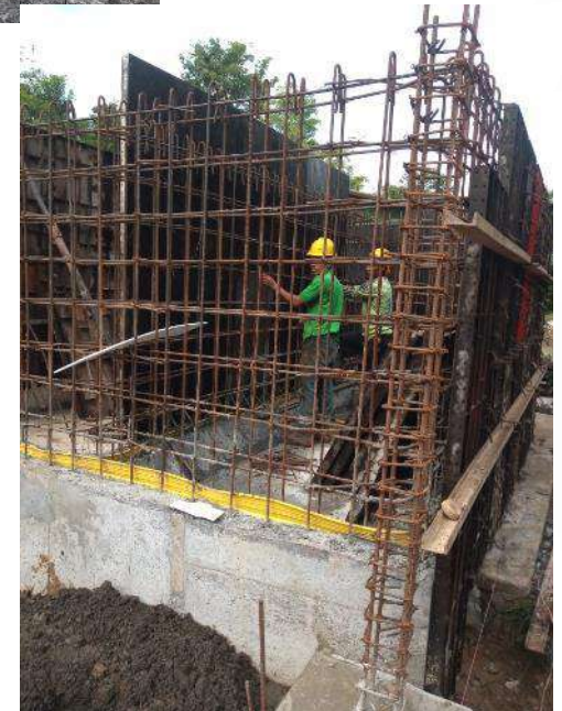
Armado de muros
