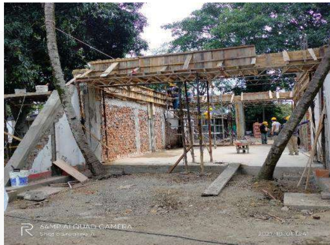
ARMADO ESTRUCTURA SOPORTE PARA CONSTRUCCION VIGAS AEREAS
