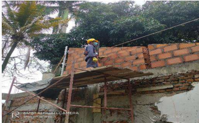
MAMPOSTERIA CONFINADA EN BLOQUE SEGÚN DISEÑOS
