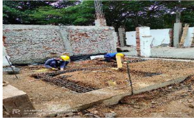
ARMADO ACERO REFUERZO VIGA DE CIMENTACION
