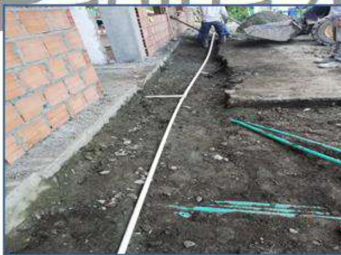
TERMINACION EST METALICA - REGADA TUBERIA PRESION Y ELECTRICA
