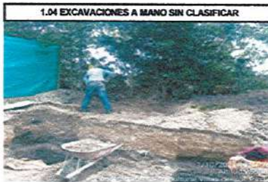
EXCAVACION DE MATERIAL PARA EVACUACIÓN
