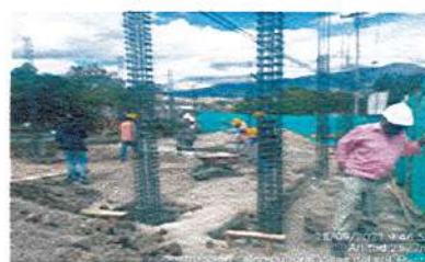
EXCAVACIÓN PARA VIGA Y ZAPATA CIMENTACIÓN
