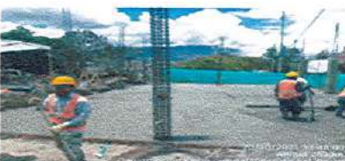
COLOCACION DE CONCRETO 3000 PSI
