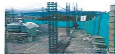
ACOPPIO DE ESCOMBROS Y MATERIAL NO UTILIZABLE EN OBRA
