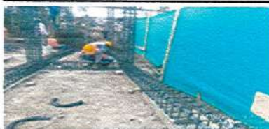
ACERO FIGURADO PARA VIGA DE CIMENTACIÓN
