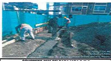
CONCRETO 2000 PSI PARA VIGA EJE 2
