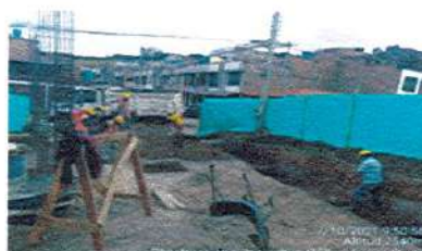
TRANSPORTE Y CARGUE DE MATERIAL EN VOLQUETA
