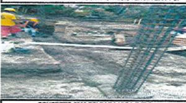
CONCRETO 2000 PSI PARA VIGA EJE 5
