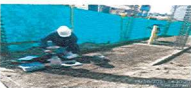
ENSAYO DE DENSIDAD A RECEBO COMPACTADO
