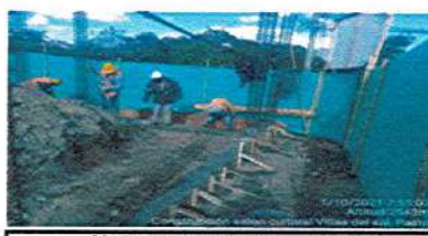
CONCRETO 2000 PSI PARA VIGA EJE E
