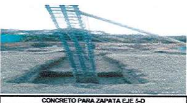
CONCRETO PARA ZAPATA EJE 5-D
