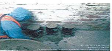
FABRICACION DE CILINDROS PARA PRUEBAS DE RESISTENCIA
