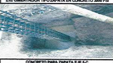
CONCRETO PARA ZAPATA EJE 5-C
