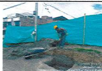
CARGUE Y TRANSPORTE DE MATERIAL SOBRANTE
