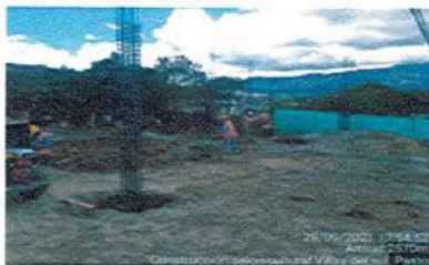
EXCAVACIÓN PARA NIVELACIÓN DE PISO
