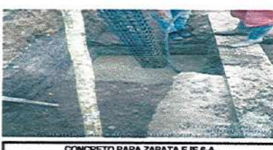
CONCRETO PARA ZAPATA EJE 6-A
