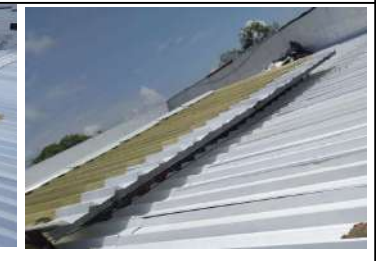
Georeferenciación Sede COMM - Valledupar Descripción Suministro e instalación de cubierta en lámina translúcida.
