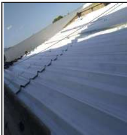
Georeferenciación Sede COMM - Valledupar Descripción Suministro e instalación de cubierta metálica lámina grado 40
