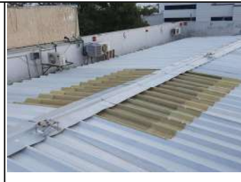
Georeferenciación Sede COMM - Valledupar Descripción Suministro e instalación de cubierta en lámina translúcida.
