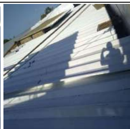
Georeferenciación Sede COMM - Valledupar Descripción Suministro e instalación de cubierta metálica lámina grado 40
