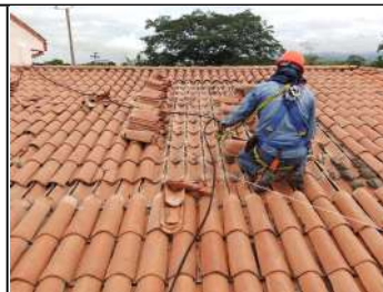
Georeferenciación Sede CAE - Aguachica Descripción Reparación cubierta en teja de barro
