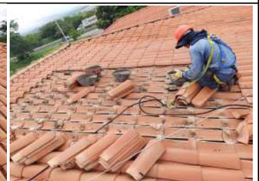
Georeferenciación Sede CAE - Aguachica Descripción Reparación cubierta en teja de barro
