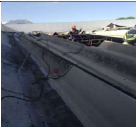
Georeferenciación Sede COMM - Valledupar Descripción Desmonte de cubierta canaleta 90
