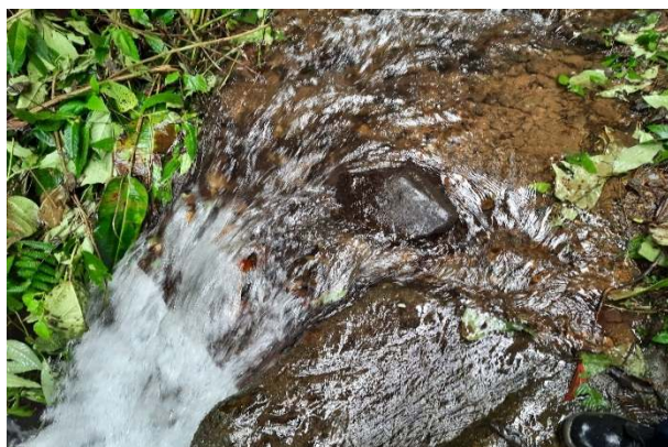
Foto 1. Unidad de Captación del agua (bocatoma).
