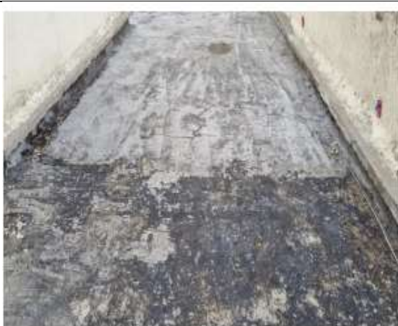
Fotografía 22. Se finaliza con el retiro de la capa impermeable en la superficie de la terraza.
