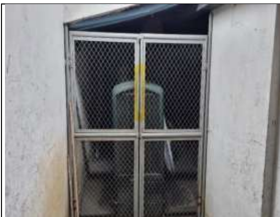
Fotografía 9. Acceso a planta eléctrica posible ubicación de almacenaje de equipos y materiales.
