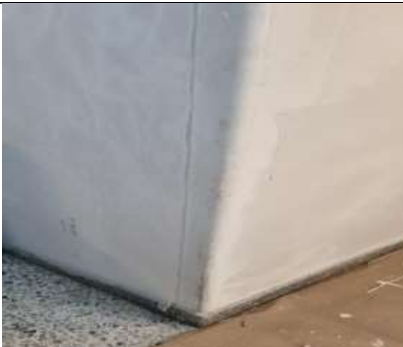
Fotografía 24. Reparación de bordes sobre muros en la terraza.
