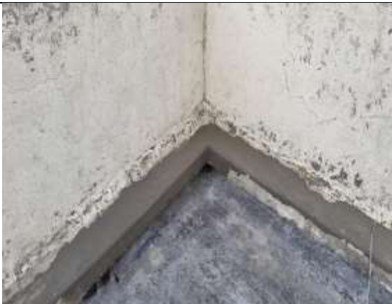
Fotografía 24. Reparación de bordes sobre muros en la terraza.
