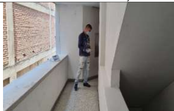
Fotografía 35. Acabado liso sobre muros de zonas comunes.
