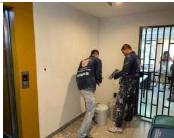
Fotografía 37. Muros y divisiones en pasillos internos pendientes de mantenimiento.
