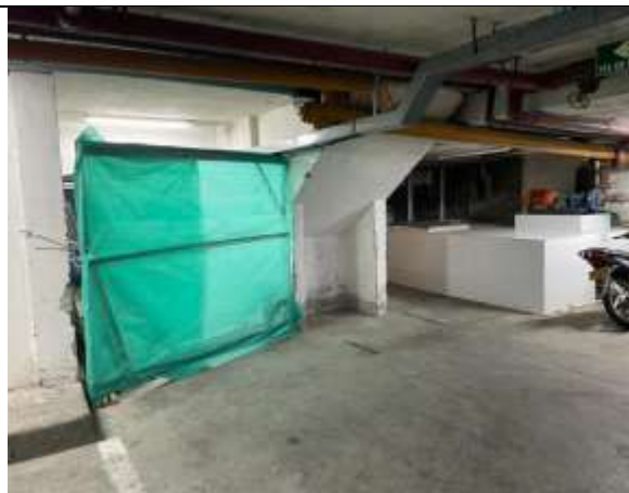
Fotografía 32. Cerramiento de almacén en lona verde en el sótano.
