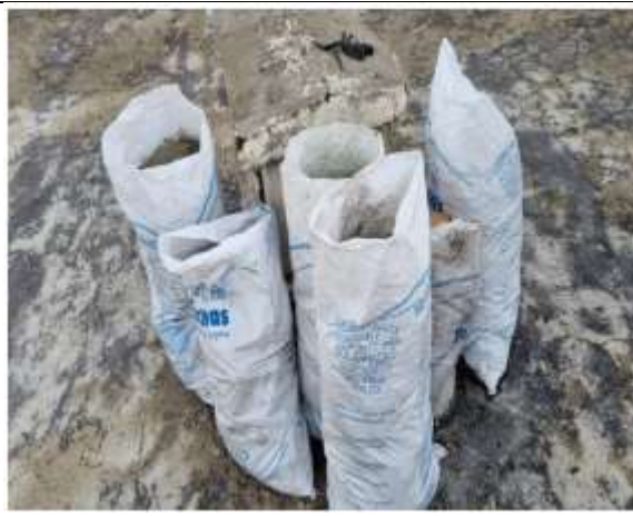
Fotografía 23. Disposición para sobrantes del retiro del impermeable existente en la cubierta del edificio.
