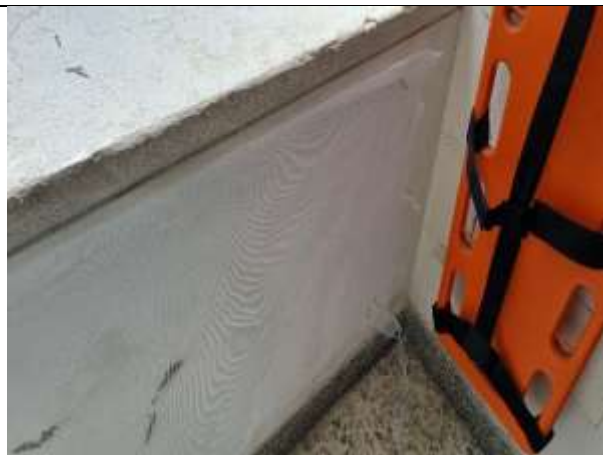
Fotografía 20. Instalación de malla para mantenimiento y acabado liso de muros en zonas comunes.
