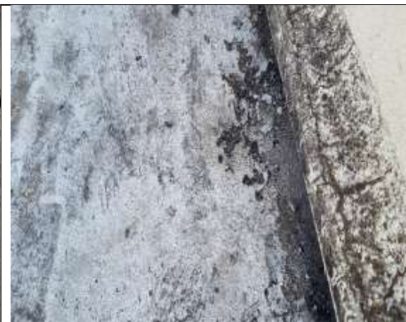
Fotografía 22. Sobrantes del retiro de la impermeabilización existente en la cubierta del edificio.
