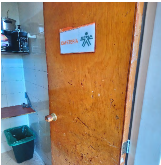
Pintura en puertas de cafetería.
