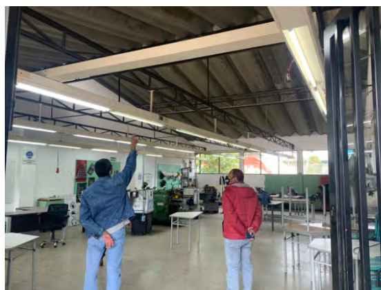
Fotografía 6. Instalación de cielos rasos en PVC
