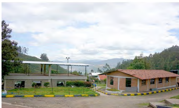
Fotografía 5. Instalaciones del centro
