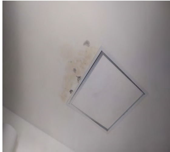
Fotografía 7. Luces y cielorraso
