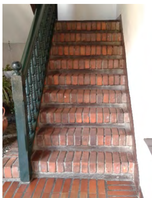
Fotografía 11. Instalación Banda antideslizante Cajas Reales
