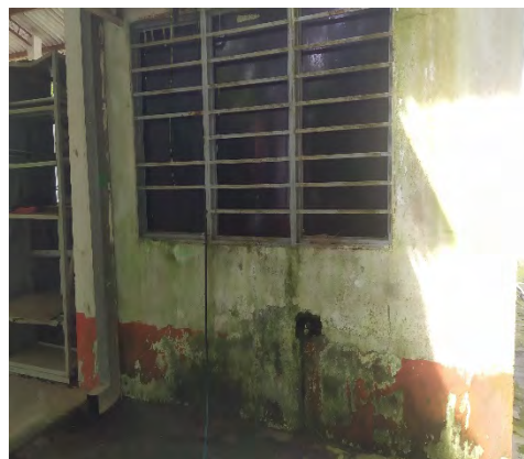
Fotografía 6. Exterior cuarto de sistemas
