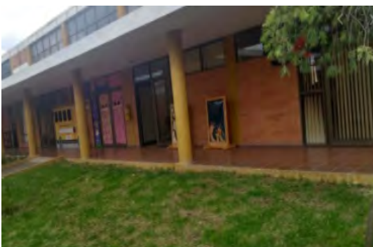
Fotografía 3. Impermeabilización de pasillos
