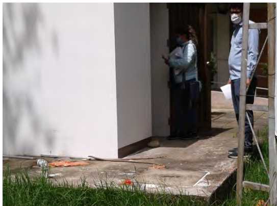
Fotografía 3. Cuarto de máquinas y lavado tanque subterráneo
