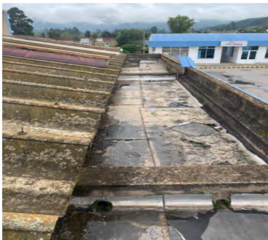
Fotografía 5. Impermeabilización de canales
