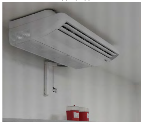
Fotografía 32. Mantenimiento Aires Acondicionados Los Patios
