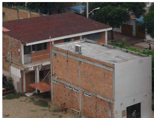
Fotografía 16. Impermeabilización Cubierta bloque C
