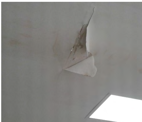
Fotografía 25. Resane y pintura Drywall Aulas de formación Comuneros
