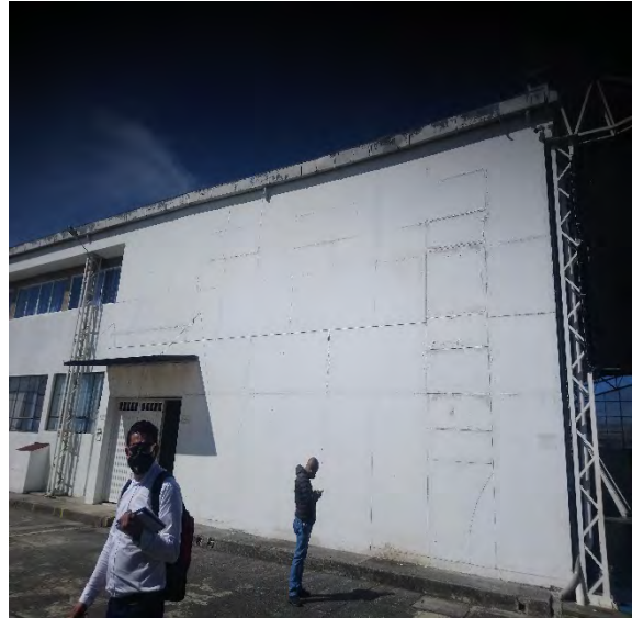
Detalle de fachada y canales para pintura y limpieza.
