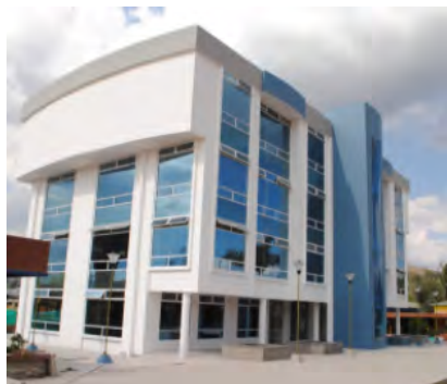
Fotografía 5. Fachada del Centro CIMM SOGAMOSO
