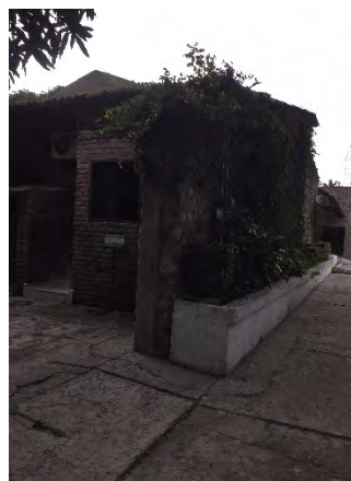
Fotografía 14. Mantenimiento de cubiertas
