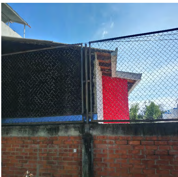
Cerramiento en malla eslabonada.
