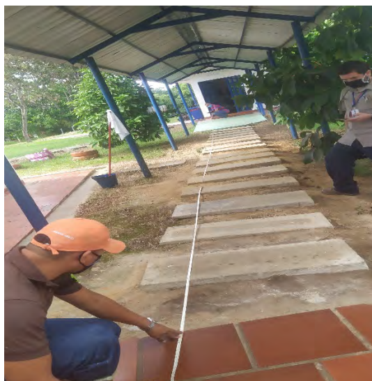
Fotografía 23. Acceso a edificio administrativo.
