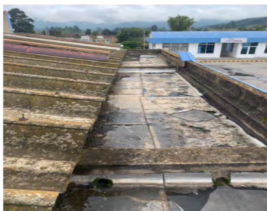
Fotografía 5. Impermeabilización de canales
