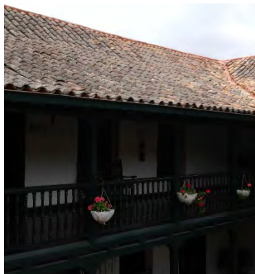
Fotografía 9. Reparación de cubierta en Teja
