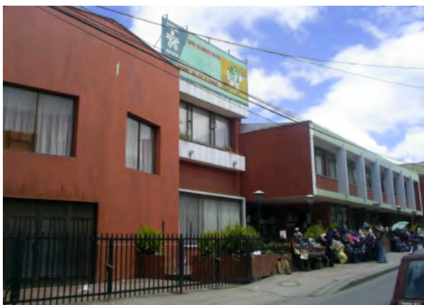
Fotografía 17. Fachada del CEGAFE Tunja centro
