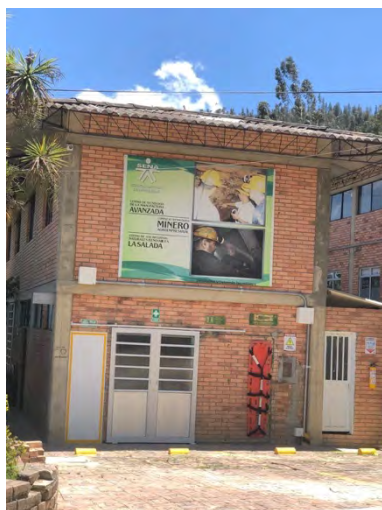
Fotografía 1. Instalaciones Centro Minero - Sogamoso
