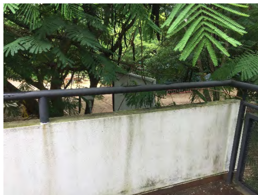
Fotografía 4. Mantenimientos Áreas del edificio de Hidrocarburos.
