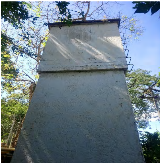
Detalle de tanque elevado.
