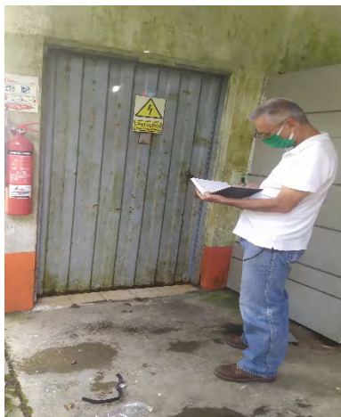
Fotografía 13. Puerta cuarto de sistemas
