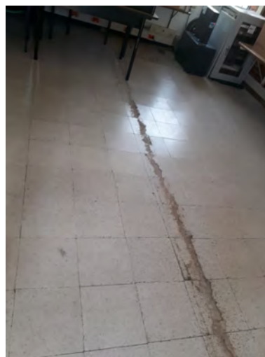
Fotografía 2. Instalaciones Centro Minero - Sogamoso
