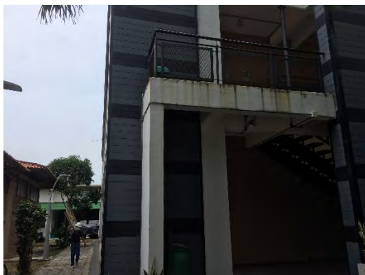
Fotografía 3. Fachada edificio Hidrocarburos
