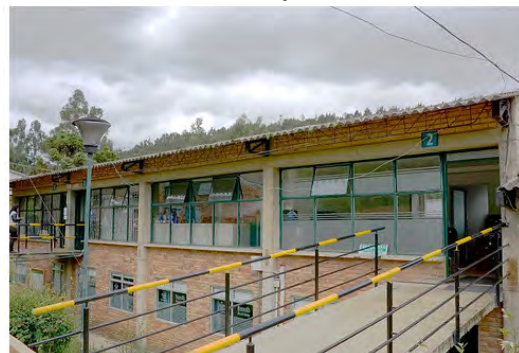
Fotografía 6. Instalaciones del centro
