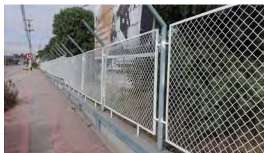
Fotografía 5. Mantenimiento de cerramiento
