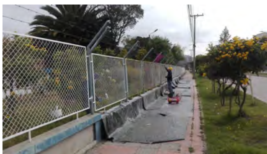
Fotografía 4. Mantenimiento de cerramiento
