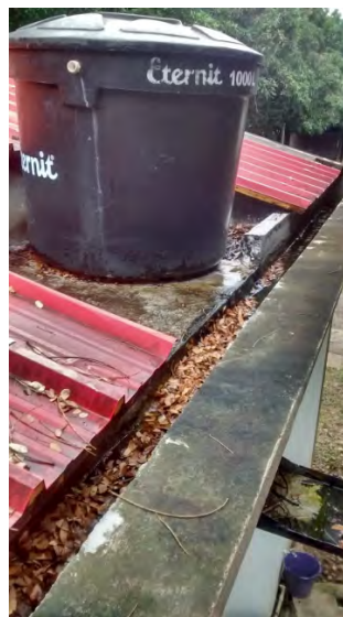
Fotografía 10. Tanque Elevado y Limpieza de Viga Canal
