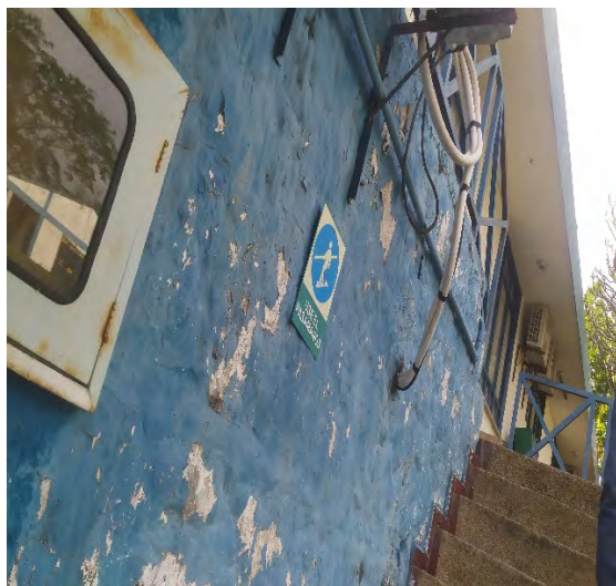
Fotografía 22. Paredes exteriores edificio de ambientes de aprendizaje
