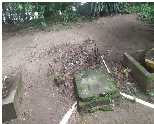
Fotografía 8. Tubería sanitaria y caja de inspección
