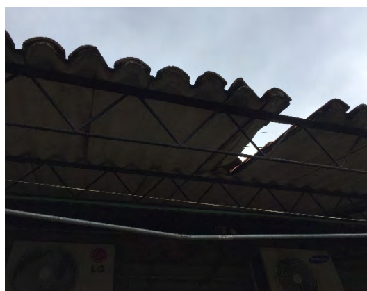
Fotografía 8. Cambio y mantenimiento de tejas
