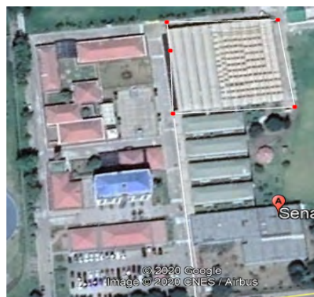
Fotografía 8. Cubierta en mal estado CIMM SOGAMOSO
