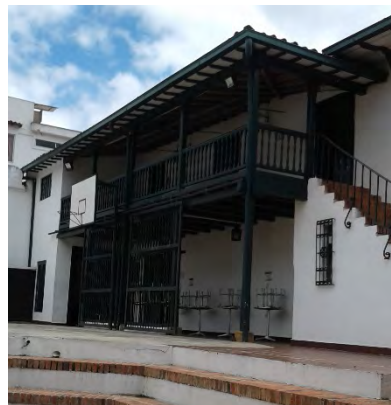
Fotografía 8. Limpieza canales y bajantes Cajas Reales
