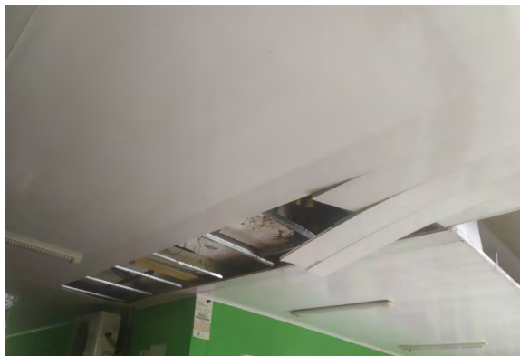
Fotografía 3-4. Cubierta del Centro Educativo – Edificio 1
