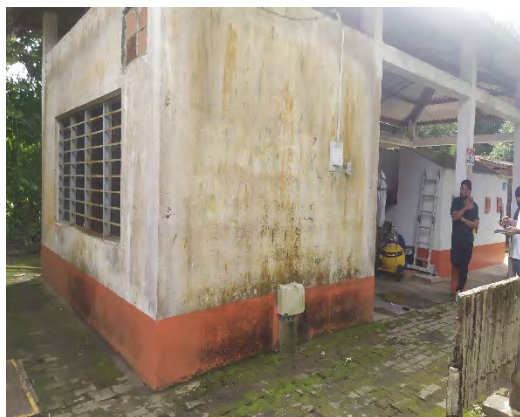
Fotografía 5. Exterior cuarto de sistemas
