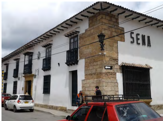
Fotografía 7. CEDRUM Sede Cajas Reales
