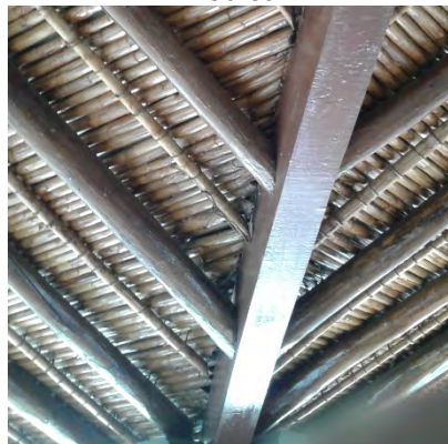
Fotografía 10. Reaparición de cielo raso en Bahareque Cajas Reales
