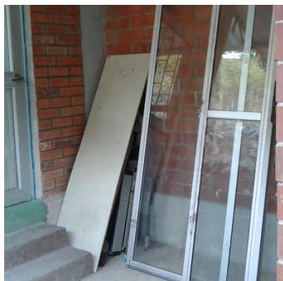
Fotografía 5. Construcción de cuarto aseo con puerta en aluminio
