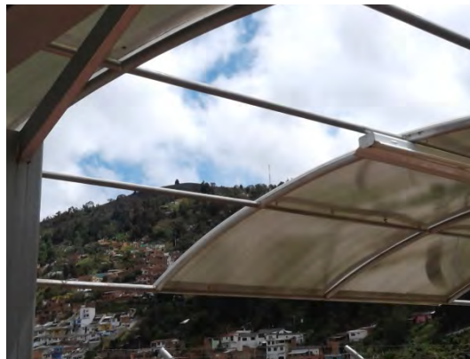
Fotografía 4. Reparación Cubierta en lámina alveolar de policarbonato CEDRUM
