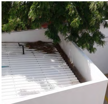
Fotografía 23. Limpieza canales Comuneros
