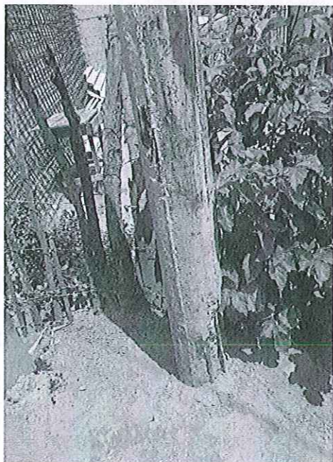
Foto 1. Retiro de postería en mal estado barrio nuevo horizonte
