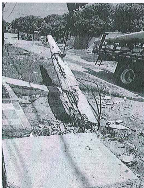
Foto 2 retiro de postería en mal estado barrio nuevo horizonte
