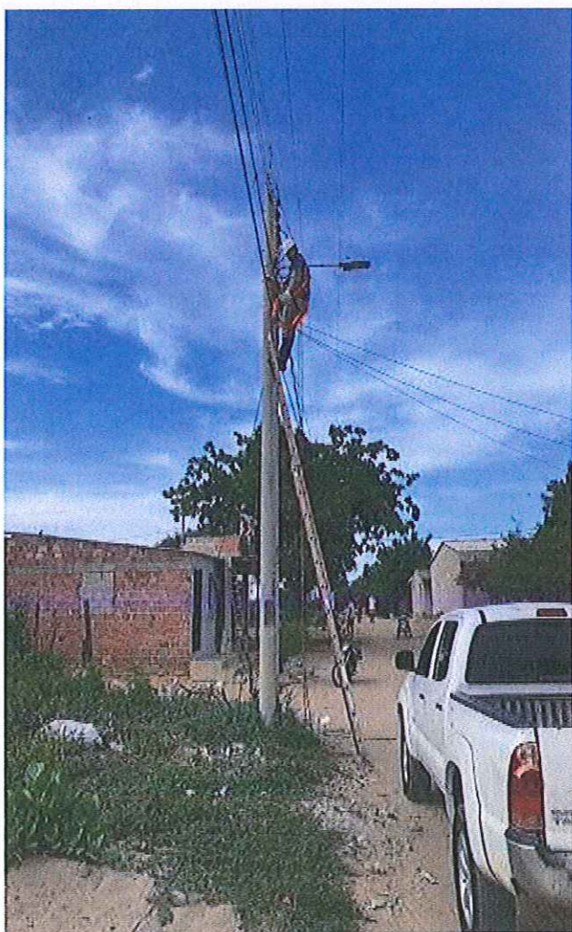
Foto 1. Tendido y amarre de cable en el sector urbano de Riohacha
