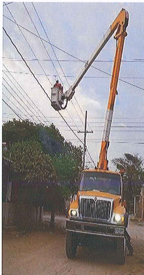
Foto 4. Riego y tendido de cable sector urbano de Riohacha
