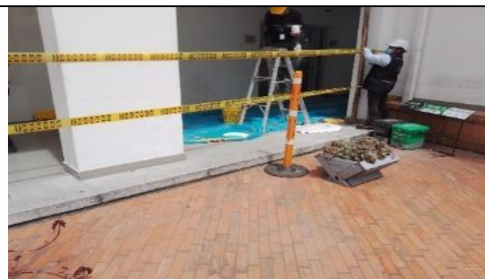
Figura 72: Demarcación zona trabajo en alturas
