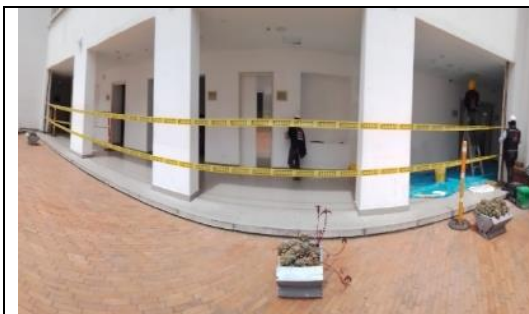
Figura 71: Demarcación zona de demolición
