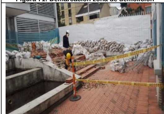
Figura 71: Demarcación zona de demolición
