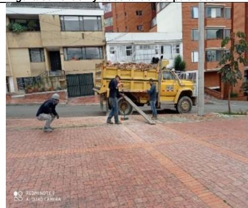
Figura 82: Orden y aseo zonas de Transito
