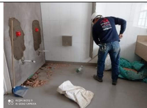
Figura 79: Orden y aseo campamento administrativo
