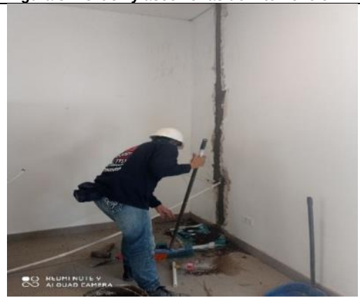
Figura 83: Orden y aseo zonas de Transito
