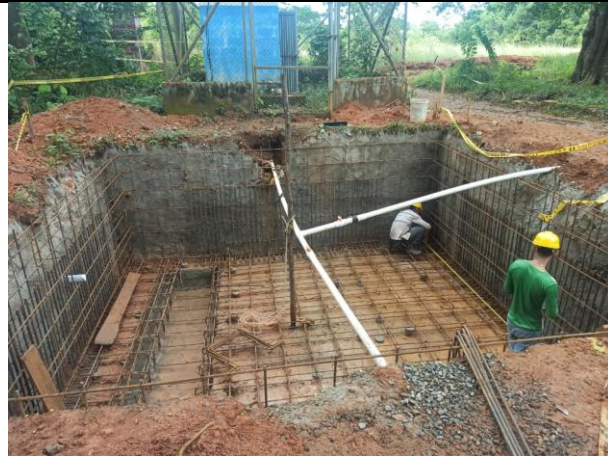
Instalación acero tanque de almacenamiento pozo
