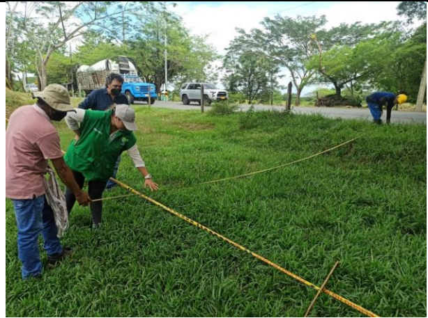
Trazado tubería en predio Hacienda la Marcella
