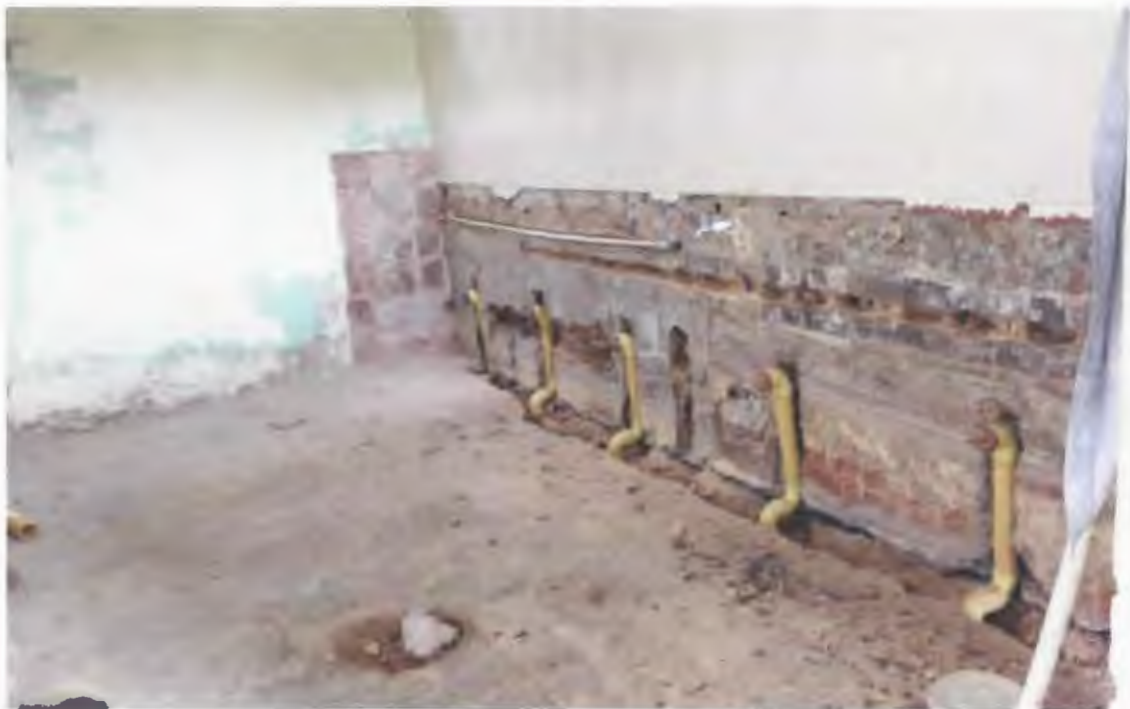
Imagen 16. Instalación de redes sanitarias
