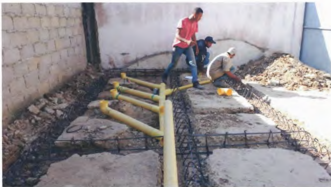
Imagen 46. Instalación de redes sanitarias
