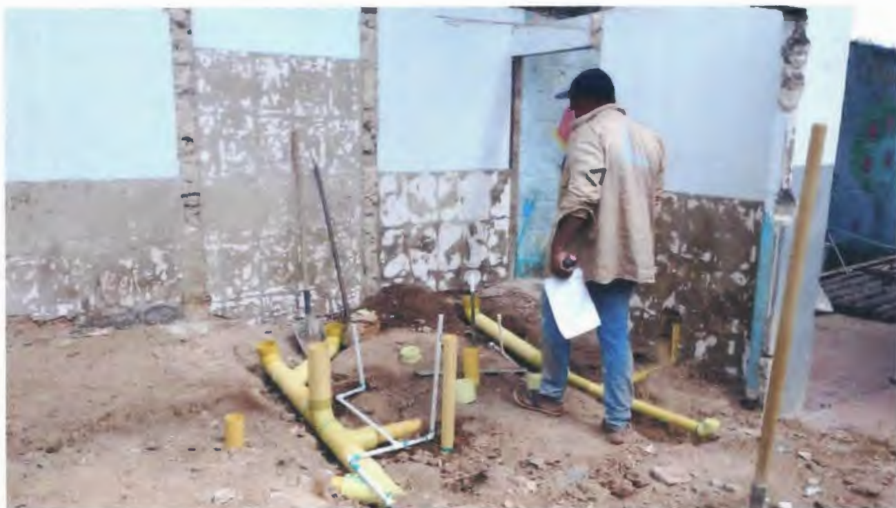
Imagen 38. Instalación de redes sanitarias
