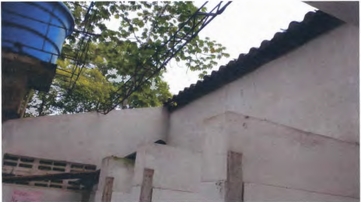
Imagen 20. Desmonte de cubiertas en mal estado
