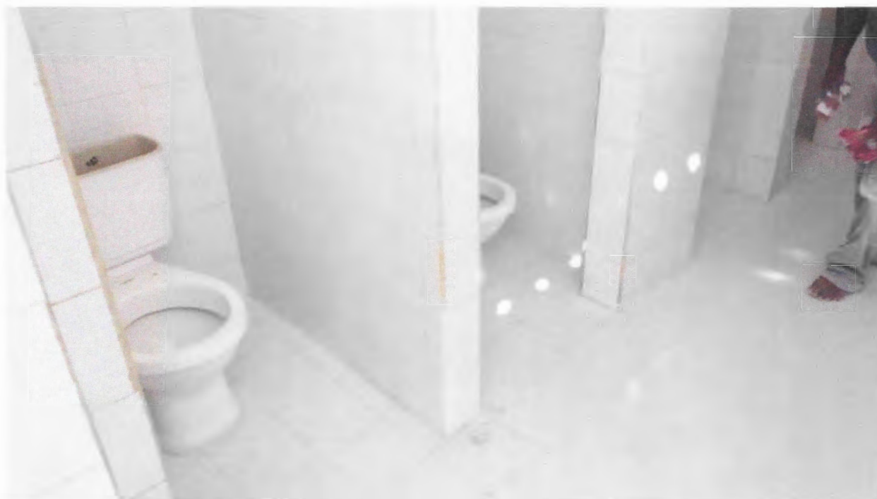
Imagen 18. Instalación de sanitarios
