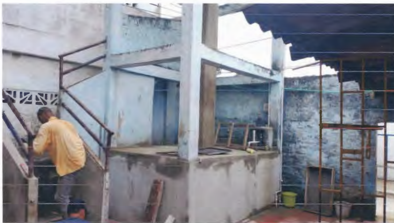
Imagen 30. Reparación de columna de soportes
