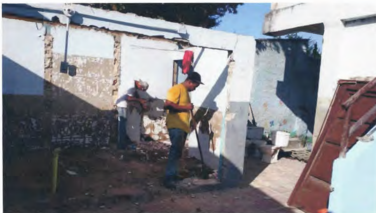
Imagen 00. Demolición de baños
