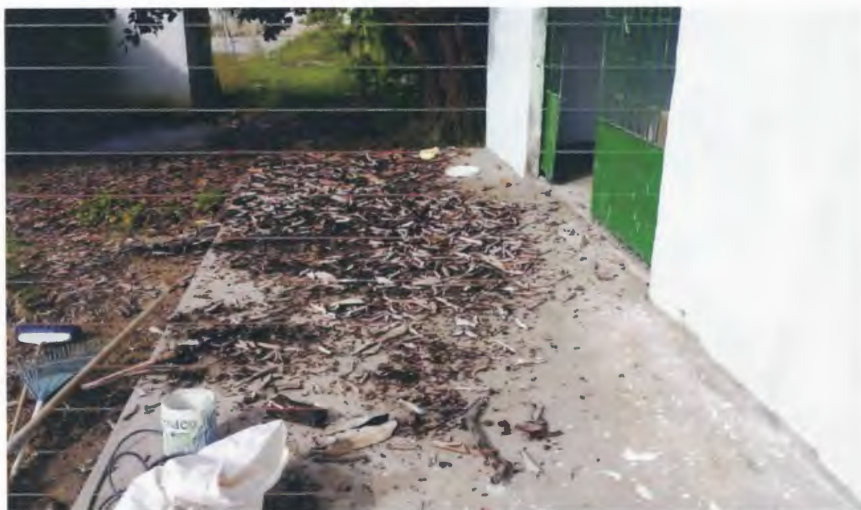
Imagen 10. Limpieza y desmonte de cubierta
