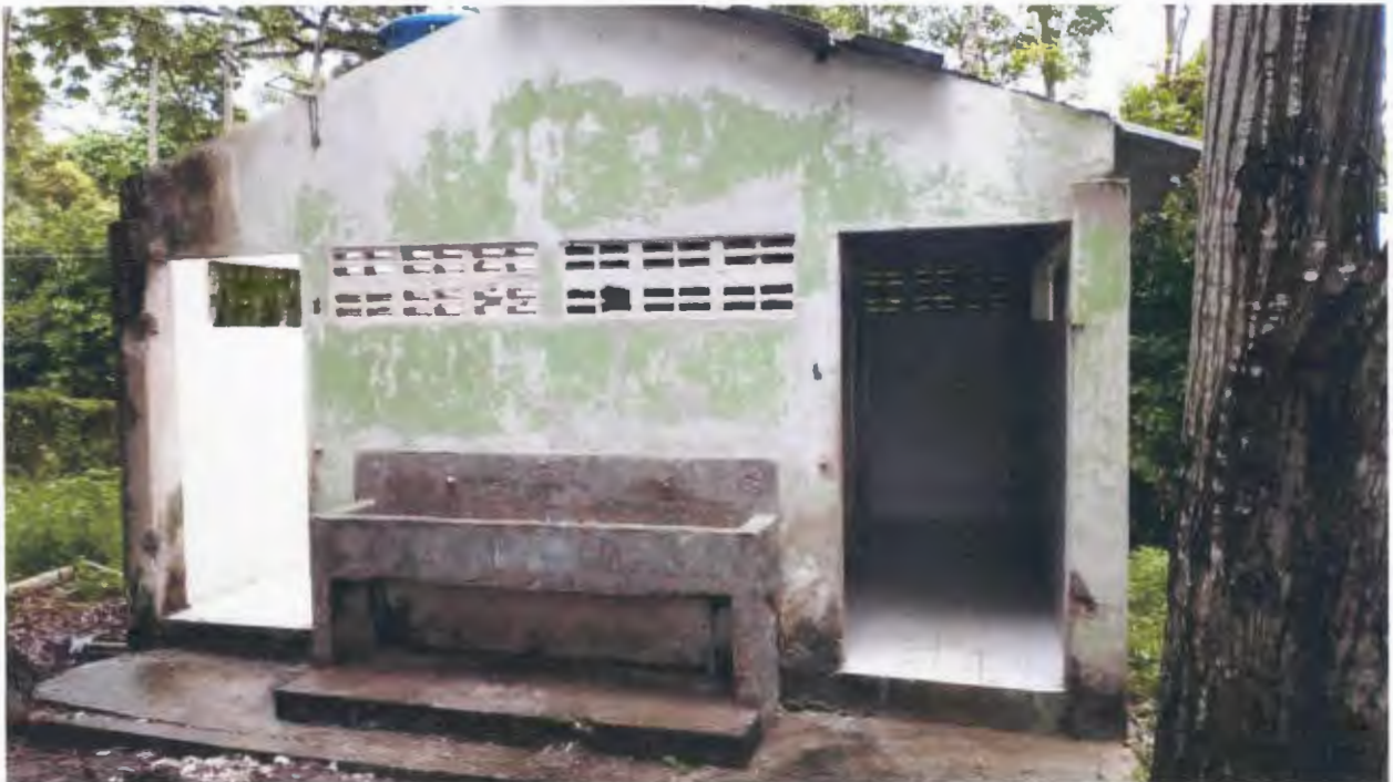
Imagen 16. Desmonte de enchape, cubierta y pintura
