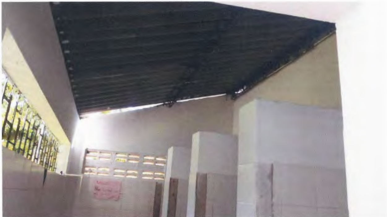
Imagen 22. Cambio de cubierta y pintura interior
