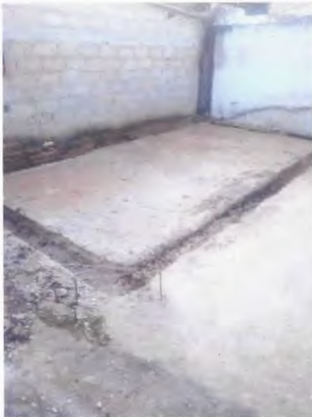
Imagen 44. Cimentación para baños
