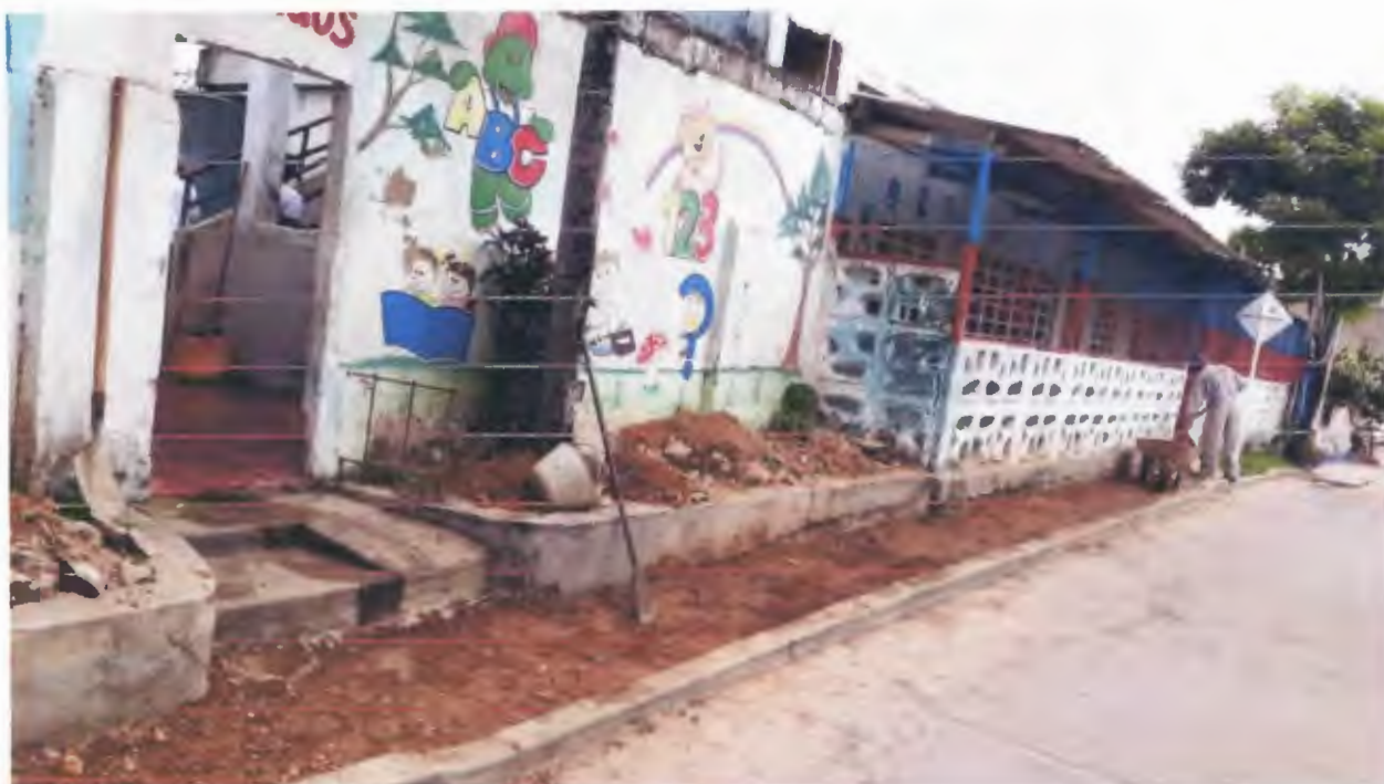
Imagen 27. Adecuación paso peatonal
