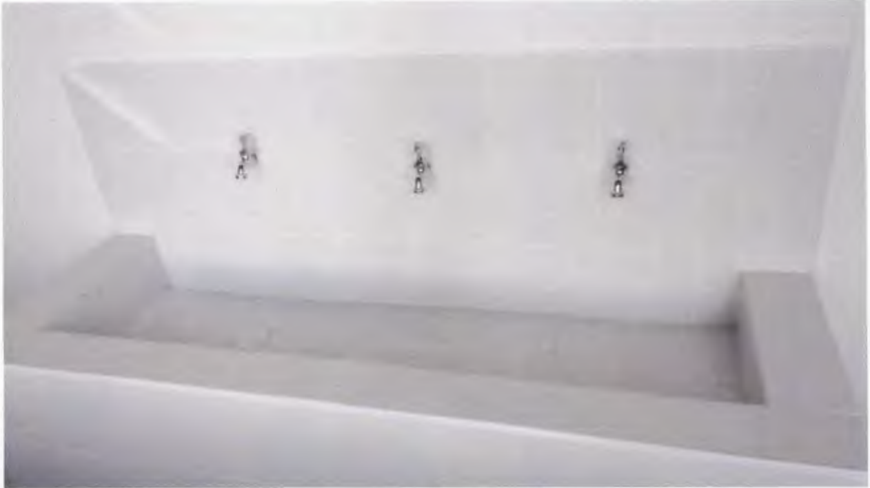
Imagen 18. Acabado de lavamanos múltiples
