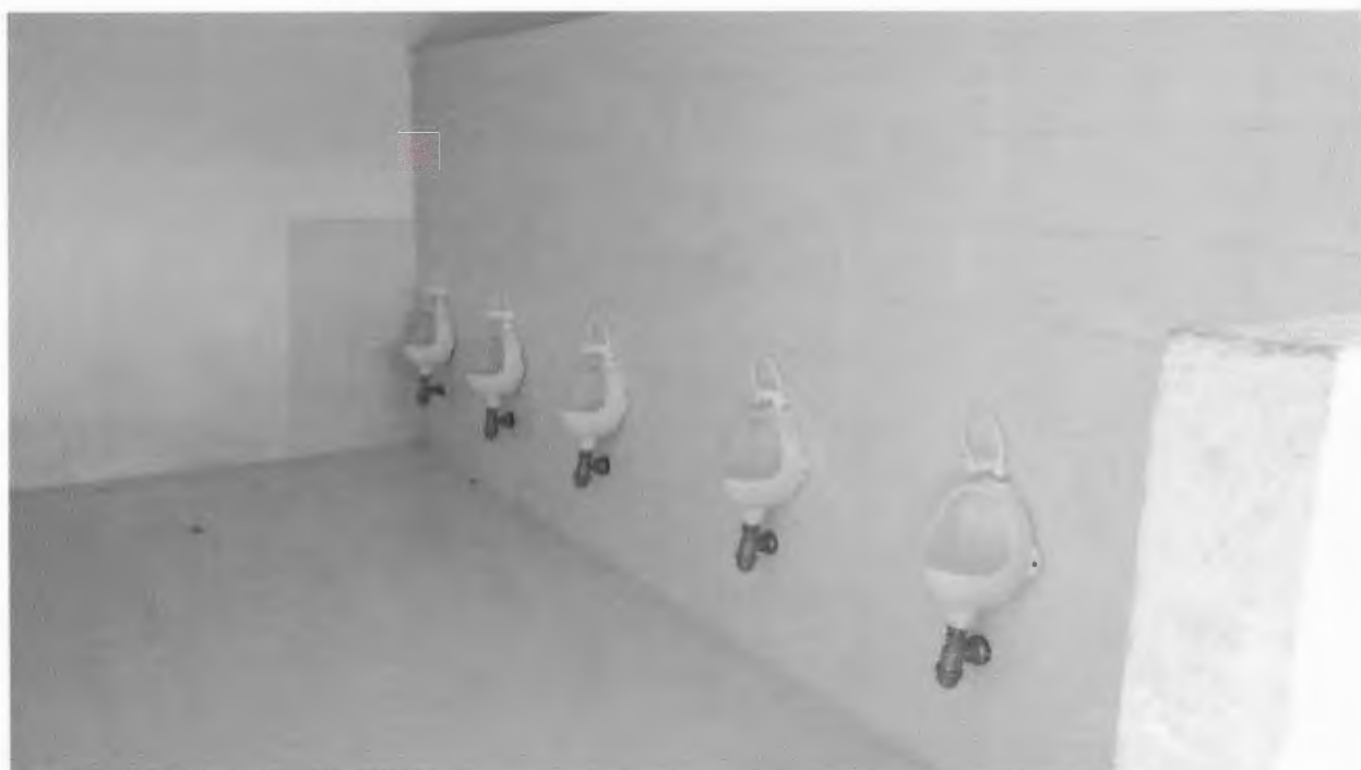
Imagen 17. Instalación de orinales
