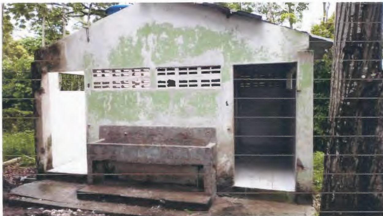
Imagen 16. Desmonte de enchape, cubierta y pintura
