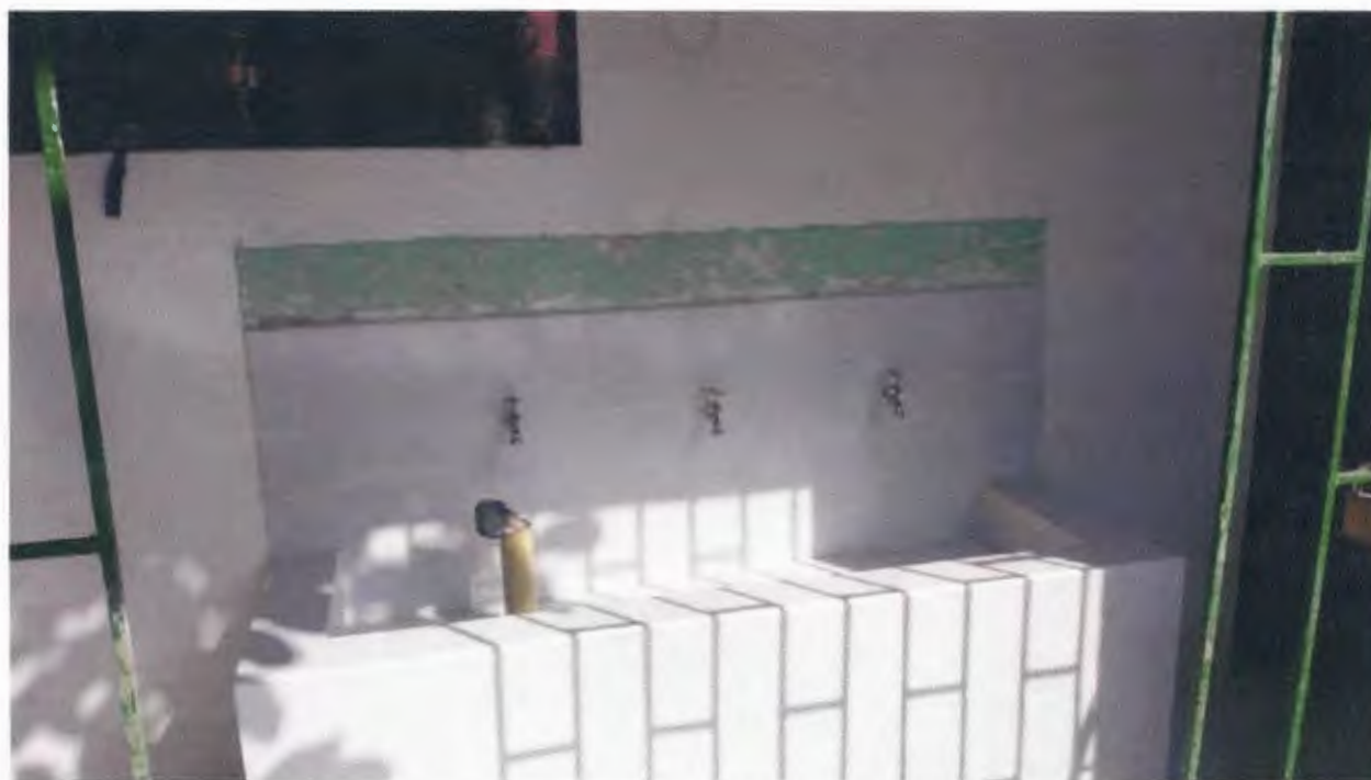
Imagen 17. Enchape lavamanos múltiple
