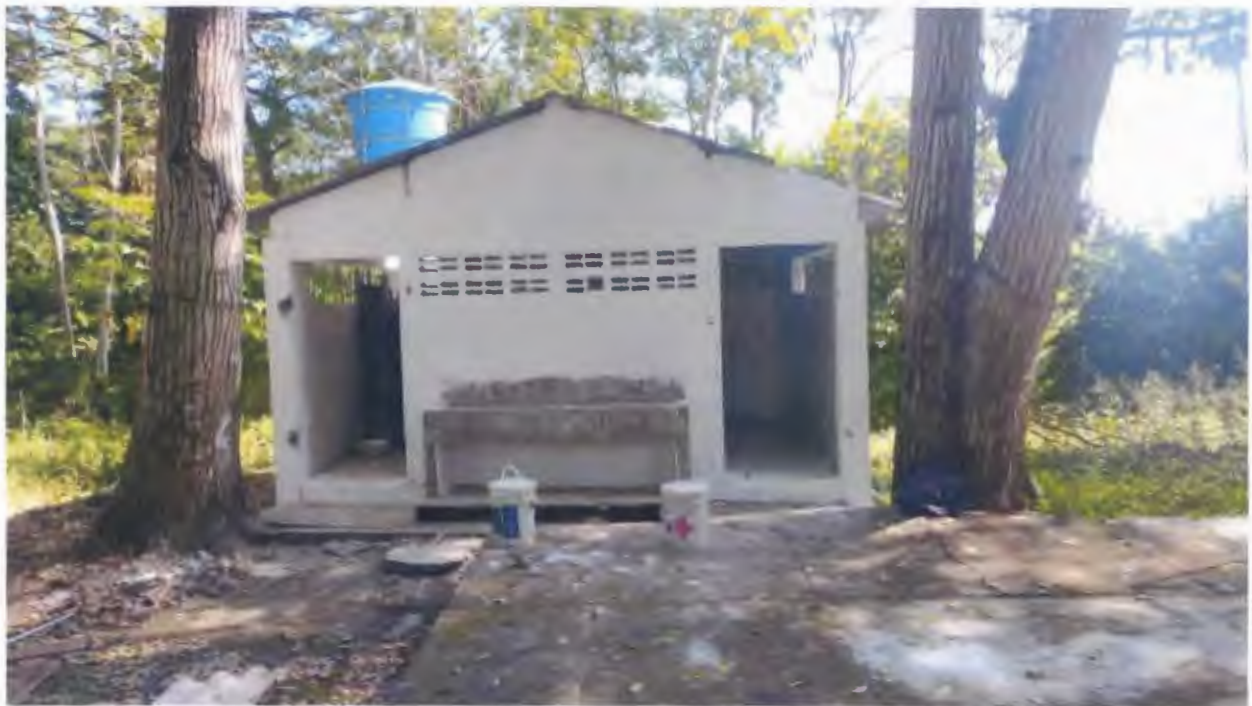
Imagen 20. Pintura muros exteriores
