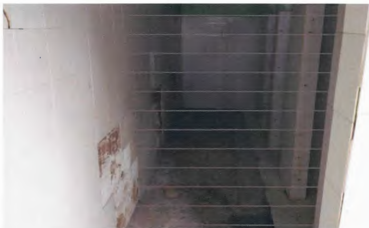
Imagen 6. Desmonte de enchape y pisos
