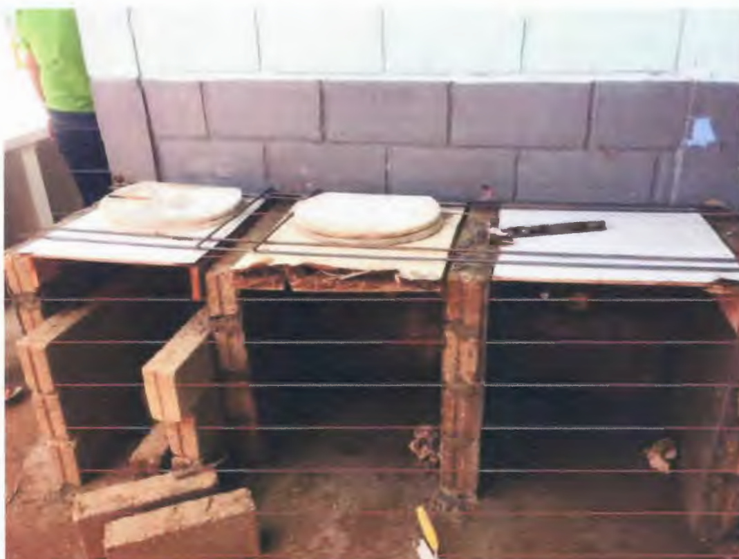
Imagen 41. Mampostería para lavamanos
