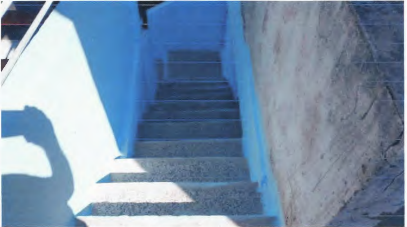
Imagen 32. Adecuación de escaleras en concreto
