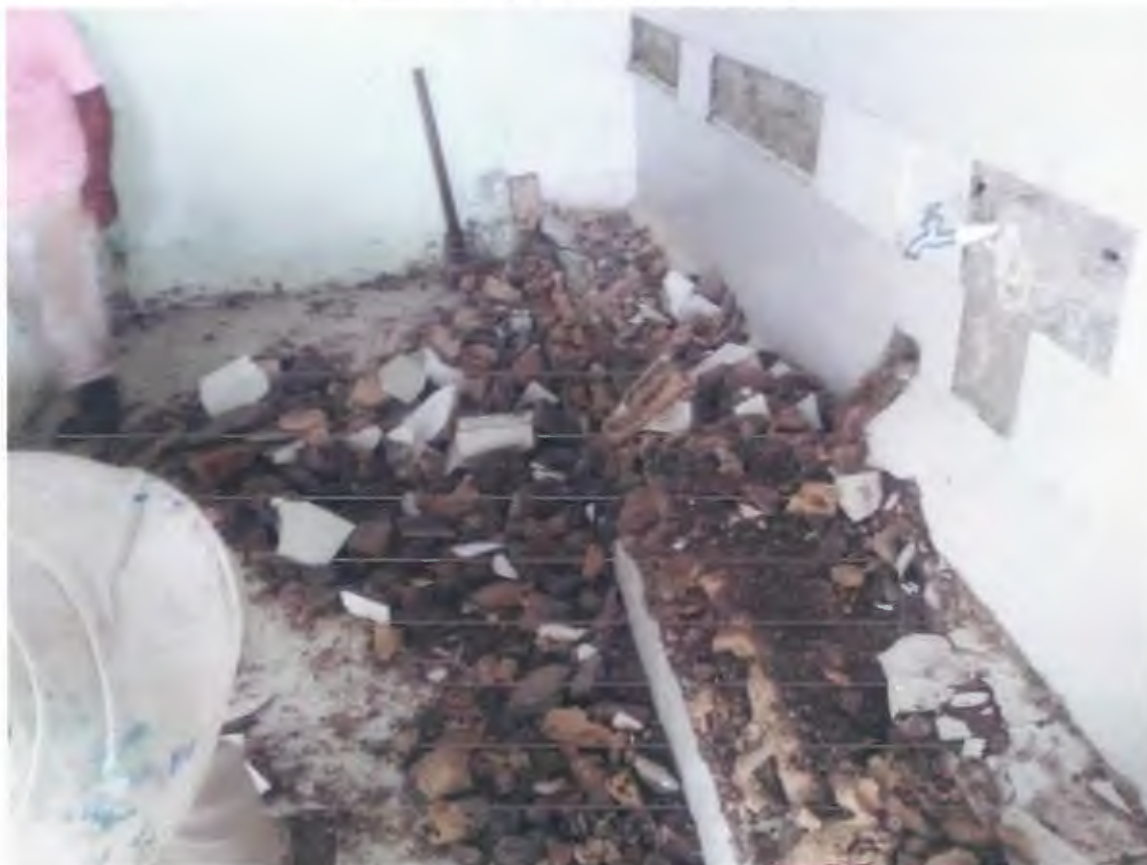
Imagen 1. Demolición de baterías de baños.
