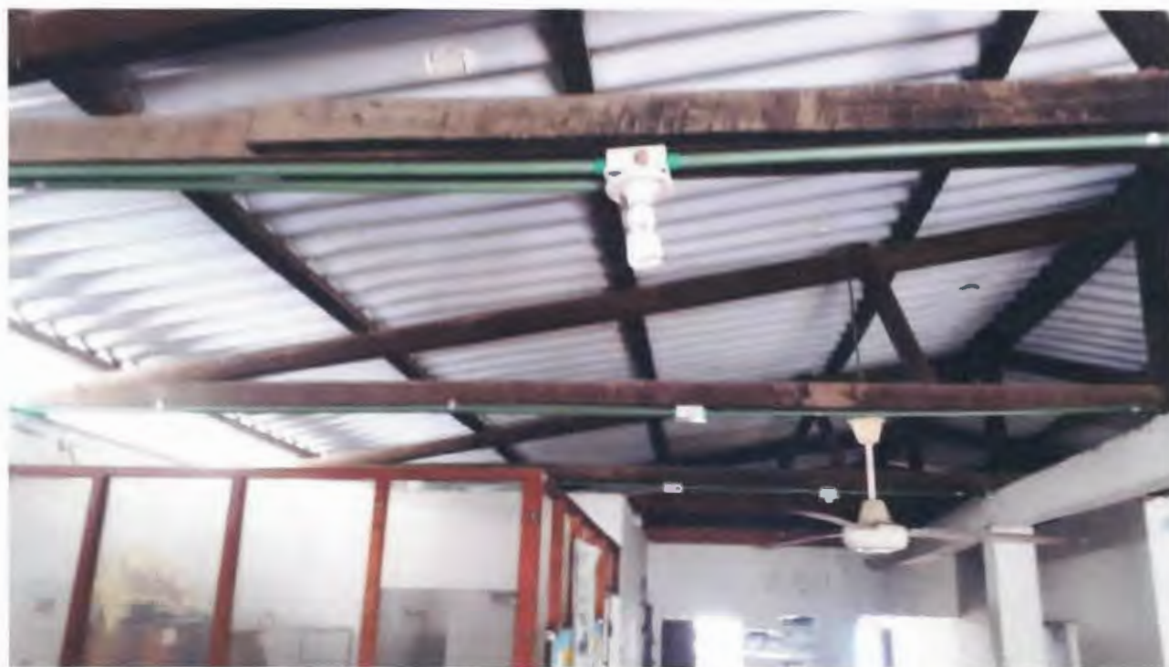
Imagen 36. Reparación de acometidas eléctricas
