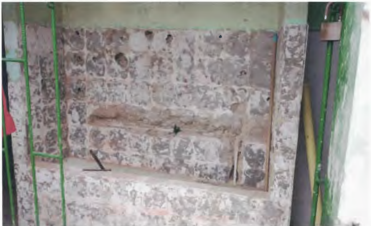
Imagen 5. Desmonte de enchape en lavamanos.
