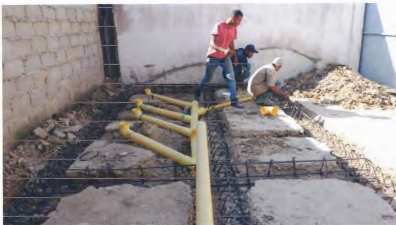
Imagen 46. Instalación de redes sanitarias
