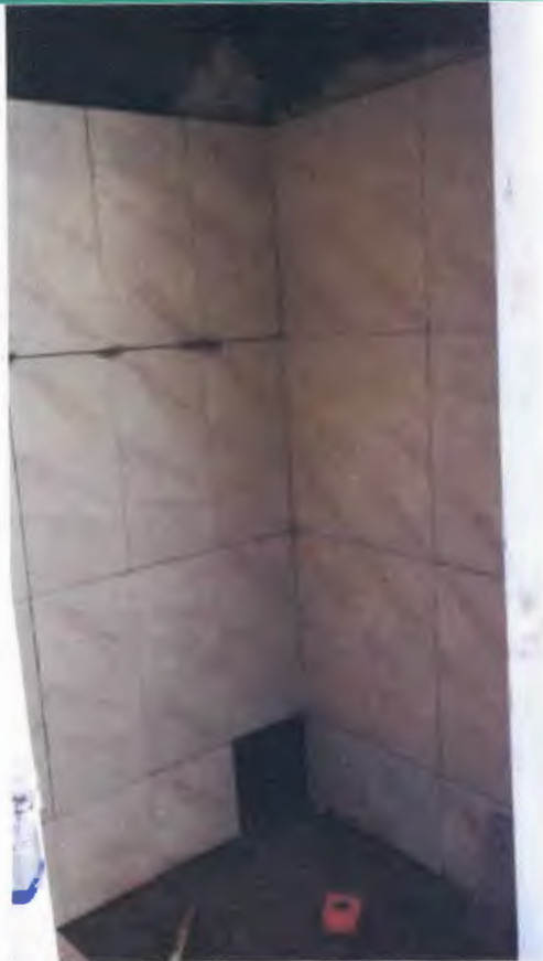
Imagen 43. Enchape muros baños profesores
