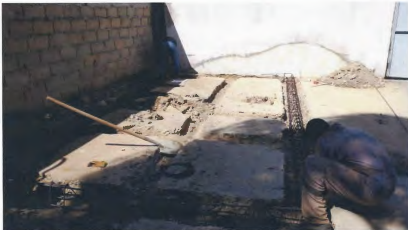
Imagen 45. Vigas de cimentación baños
