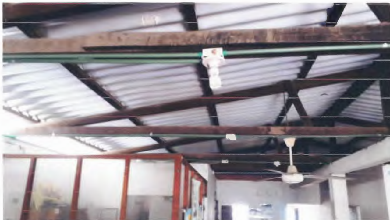
Imagen 36. Reparación de acometidas eléctricas
