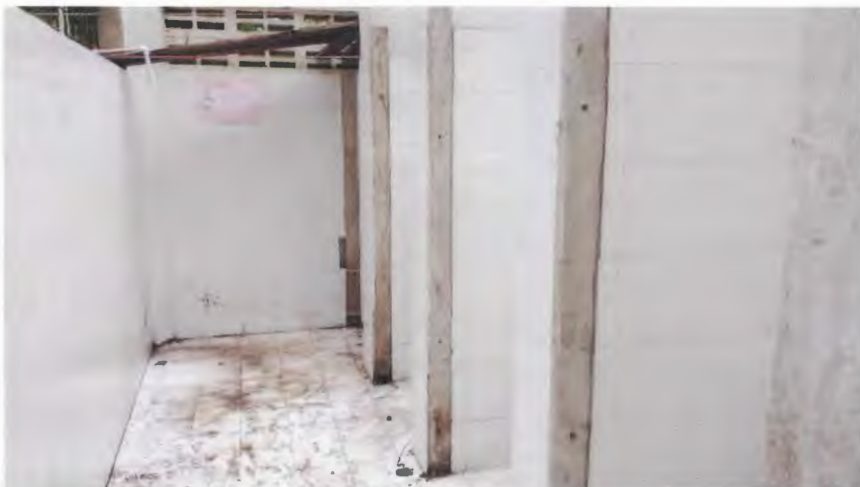
Imagen 17. Desmonte de puertas internas
