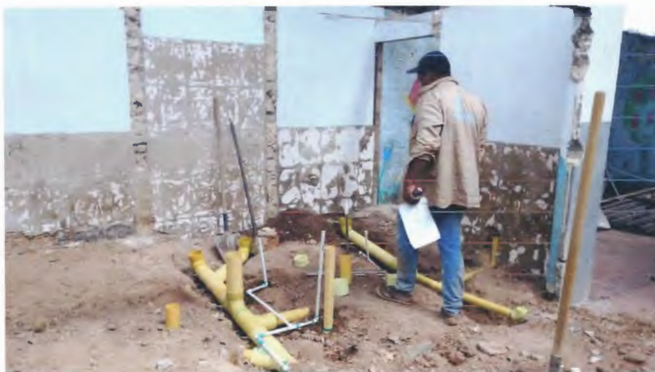
Imagen 38. Instalación de redes sanitarias
