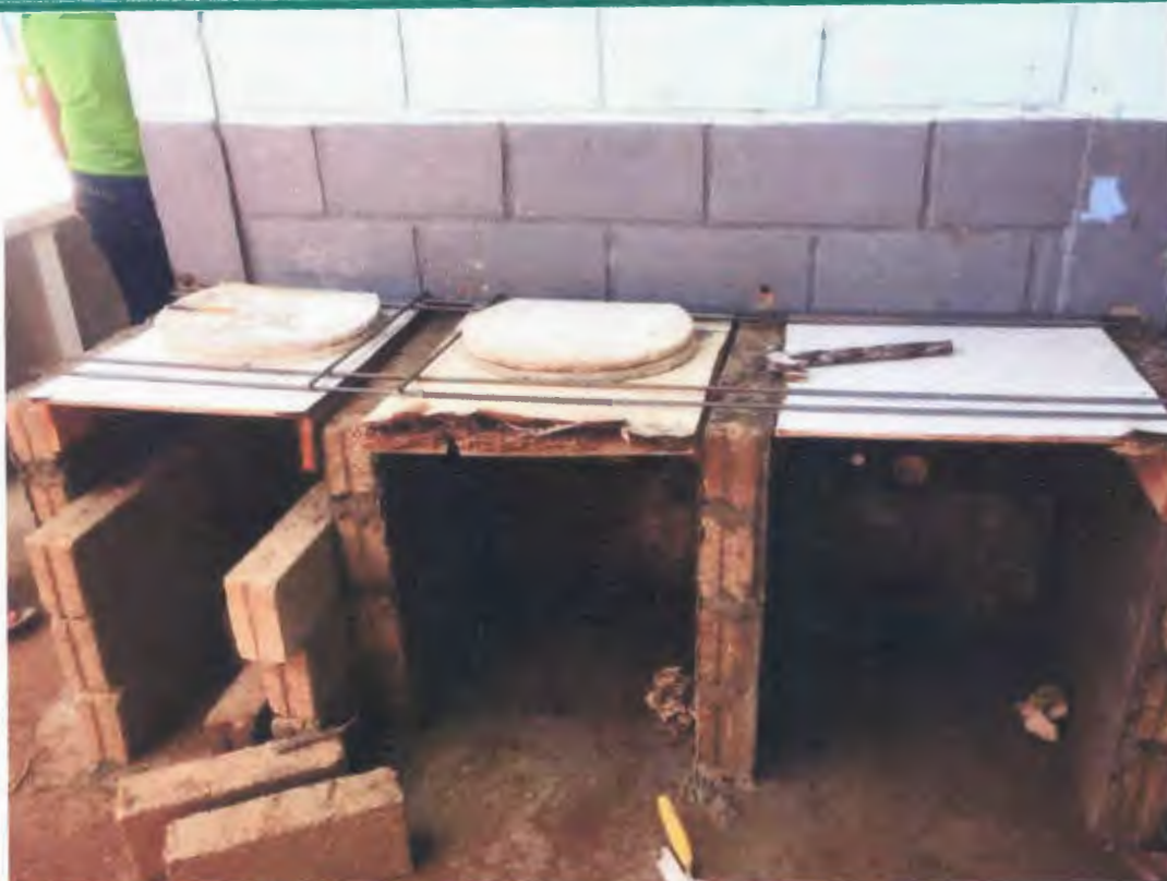
Imagen 41. Mampostería para lavamanos
