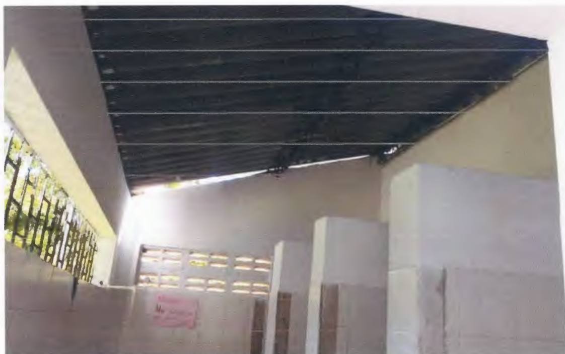
Imagen 22. Cambio de cubierta y pintura interior
