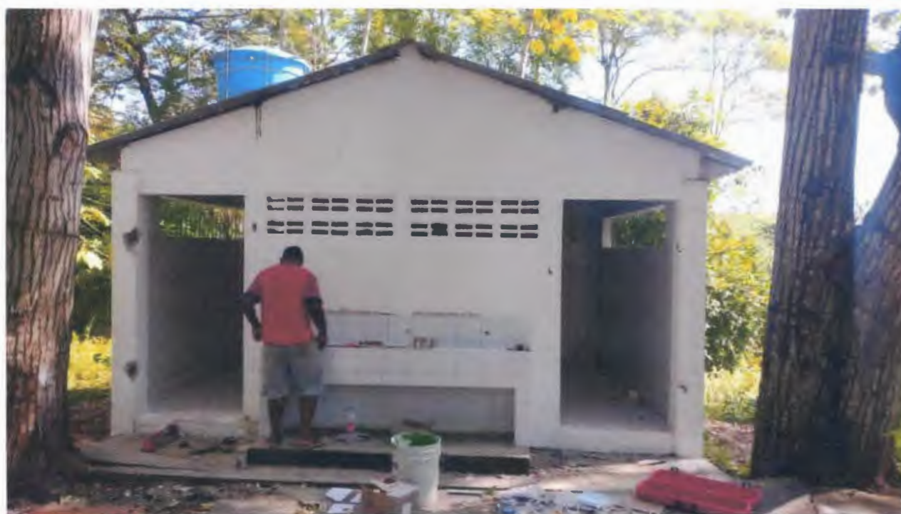
Imagen 24. Enchape lavamanos múltiple
