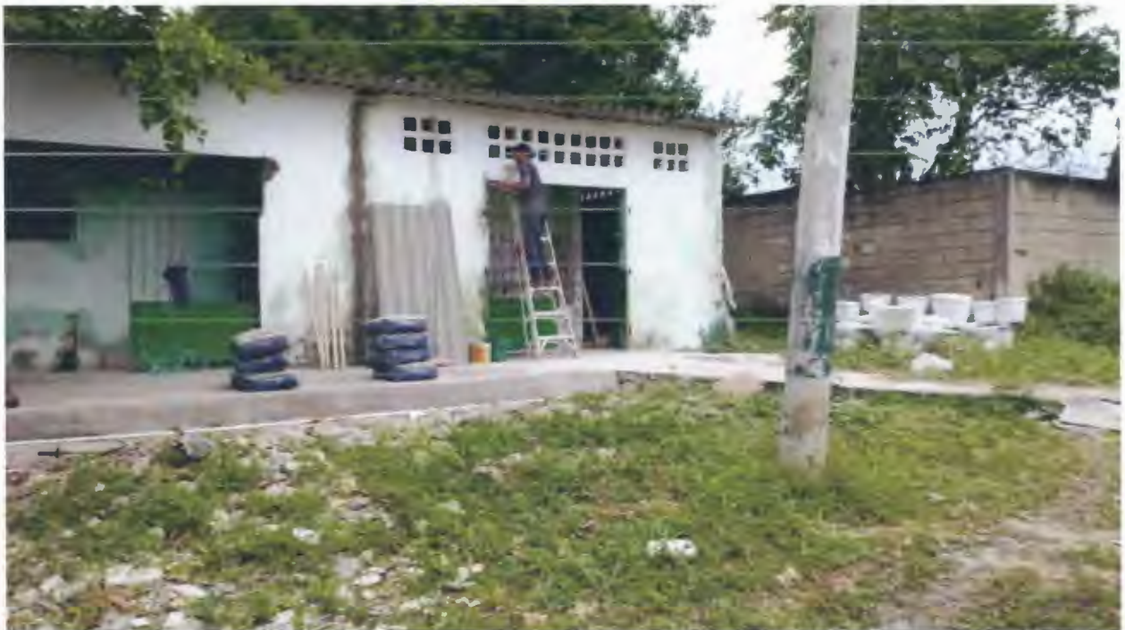
Imagen 4. Pintura exterior en baterías de baños
