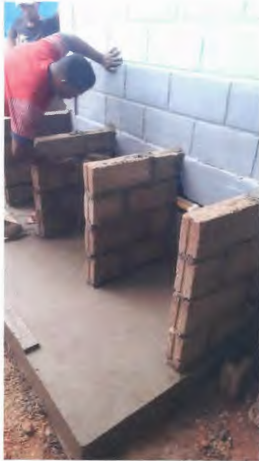
Imagen 40. Mampostería para lavamanos
