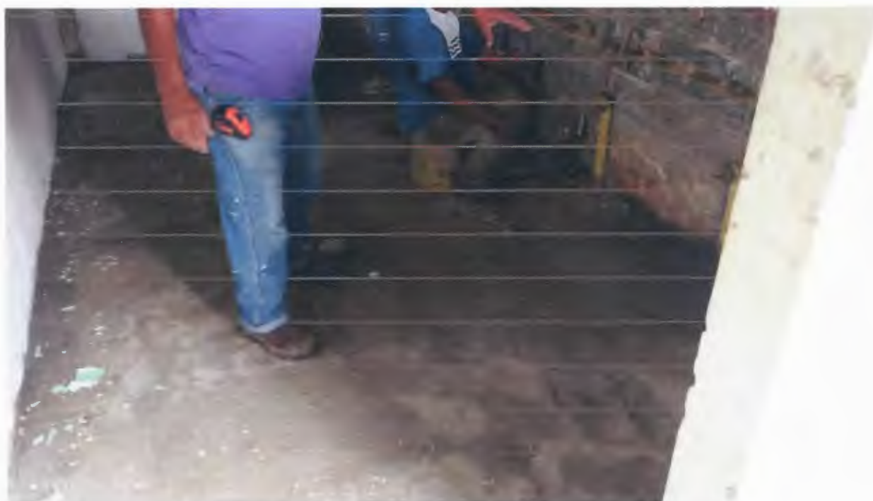
Imagen 9. Instalación de tubería y accesorios sanitarios
