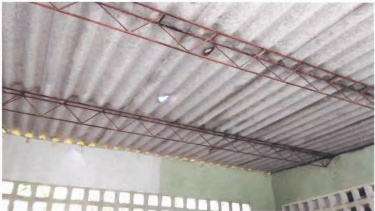
Imagen 14. Reparación y cambio de cubierta en baños
