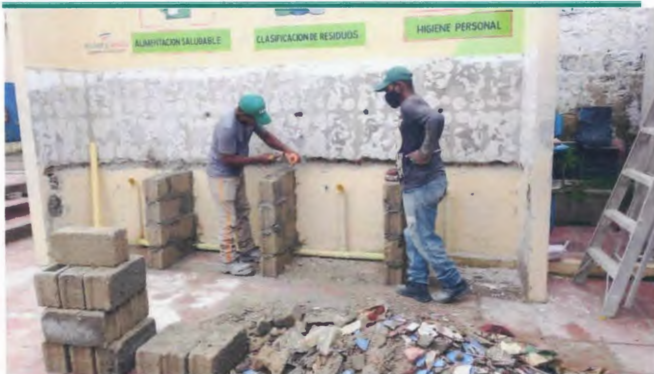
Imagen 47. Mampostería para lavamanos
