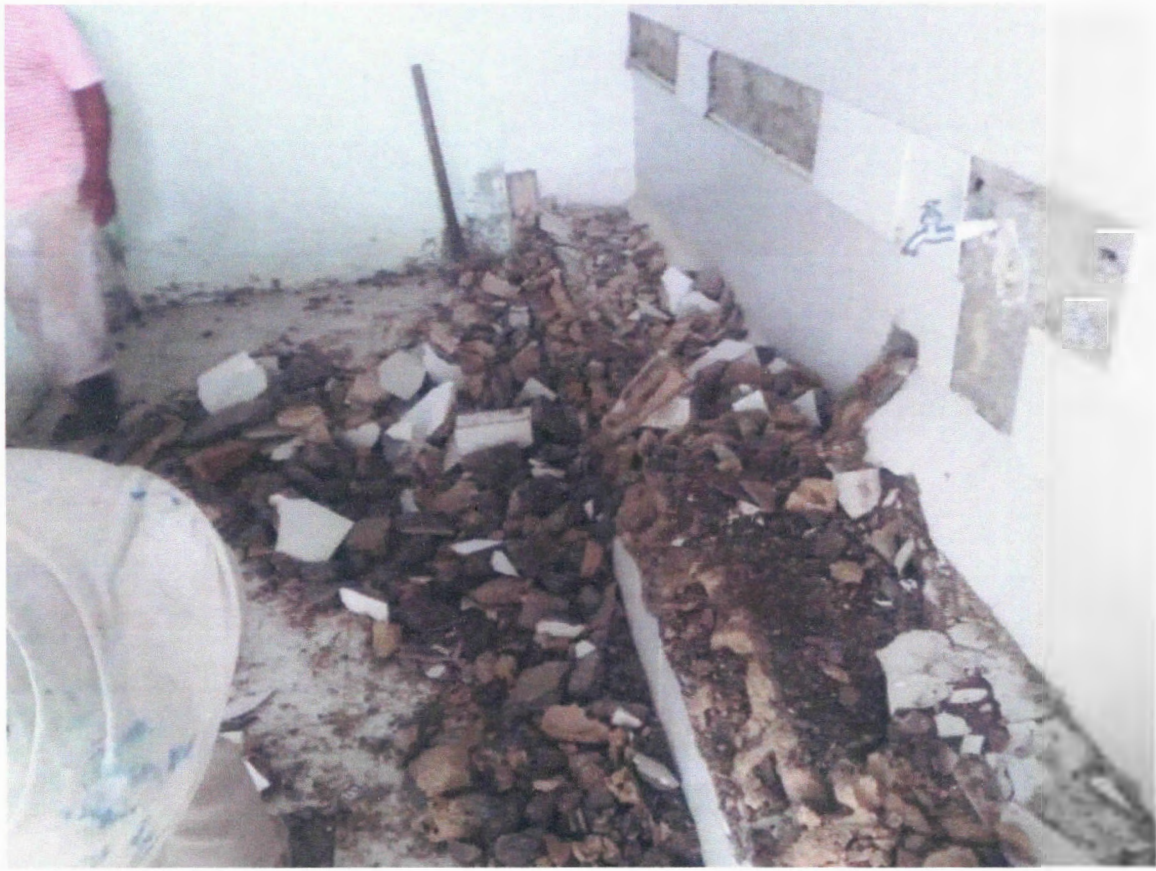
Imagen 1. Demolición de baterías de baños.
