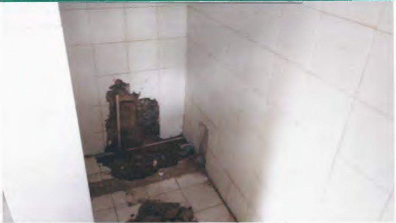
Imagen 19. Reparación de tuberías hidráulicas
