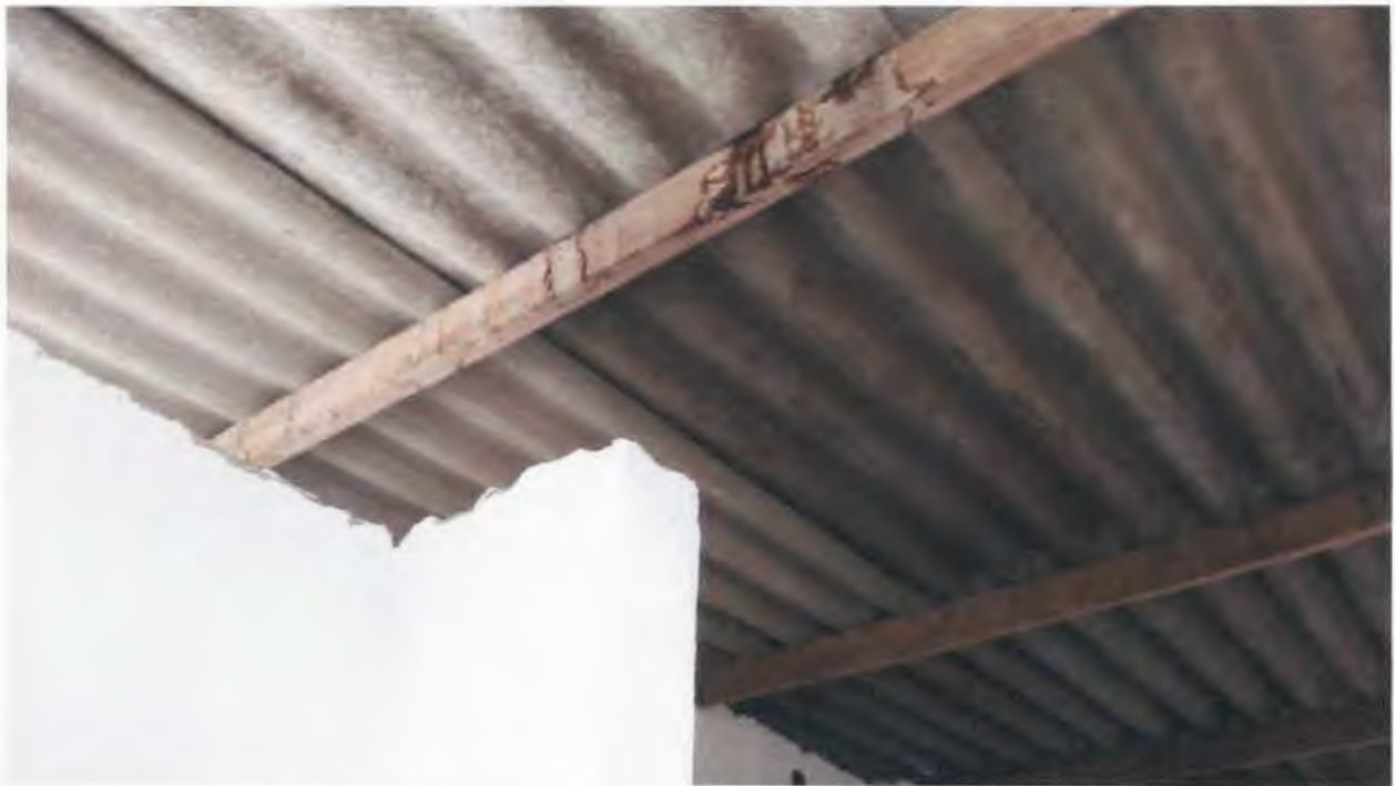
Imagen 13. Reparación y cambio de cubierta en baños
