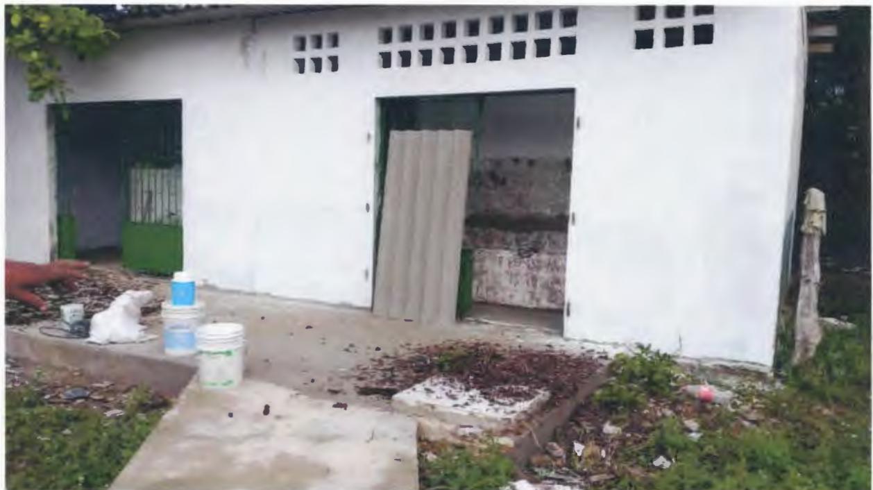
Imagen 12. Pintura exterior baterías de baños
