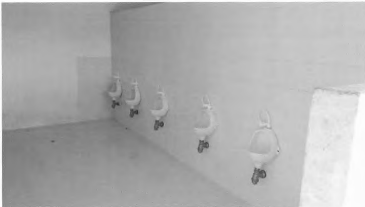
Imagen 17. Instalación de orinales
