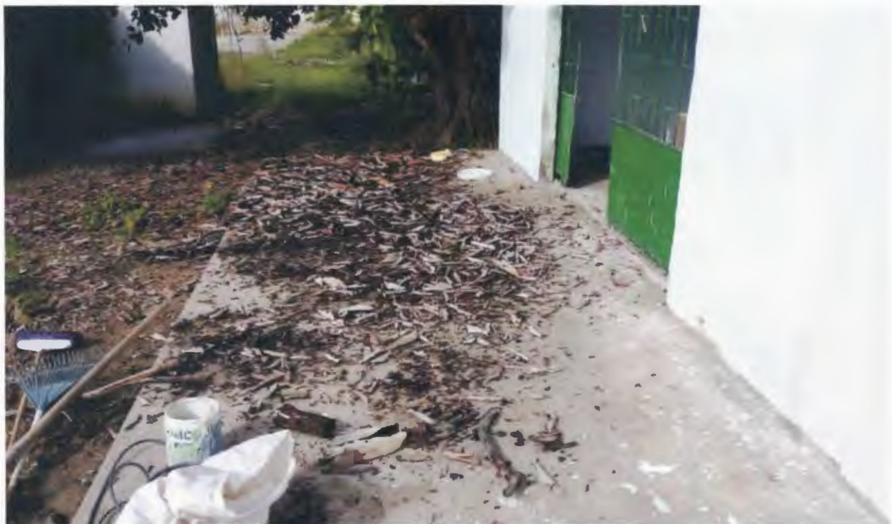
Imagen 10. Limpieza y desmonte de cubierta
