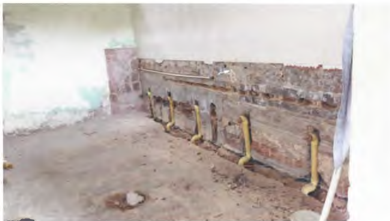
Imagen 16. Instalación de redes sanitarias
