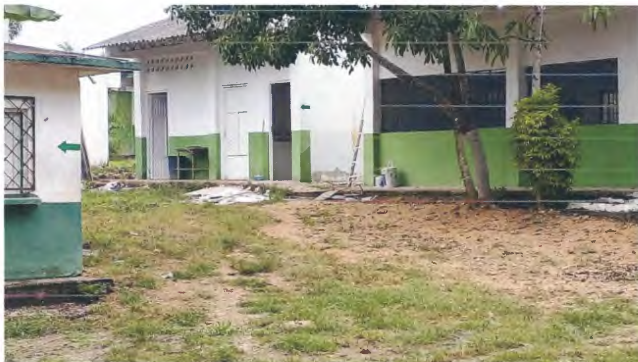
Imagen 15. Baños entrada principal
