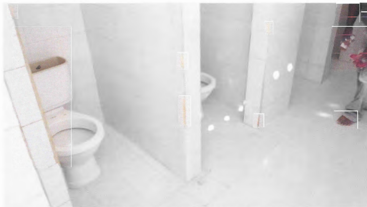
Imagen 18. Instalación de sanitarios
