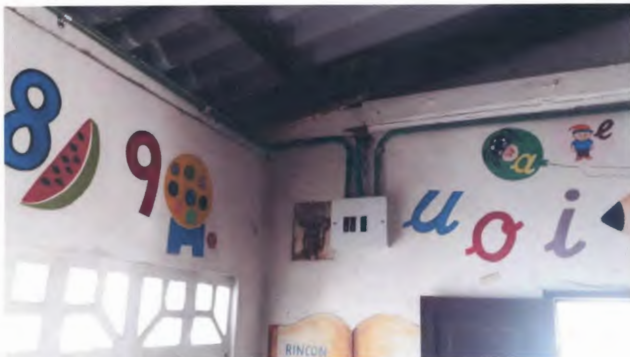
Imagen 37. Reparación de acometidas eléctricas
