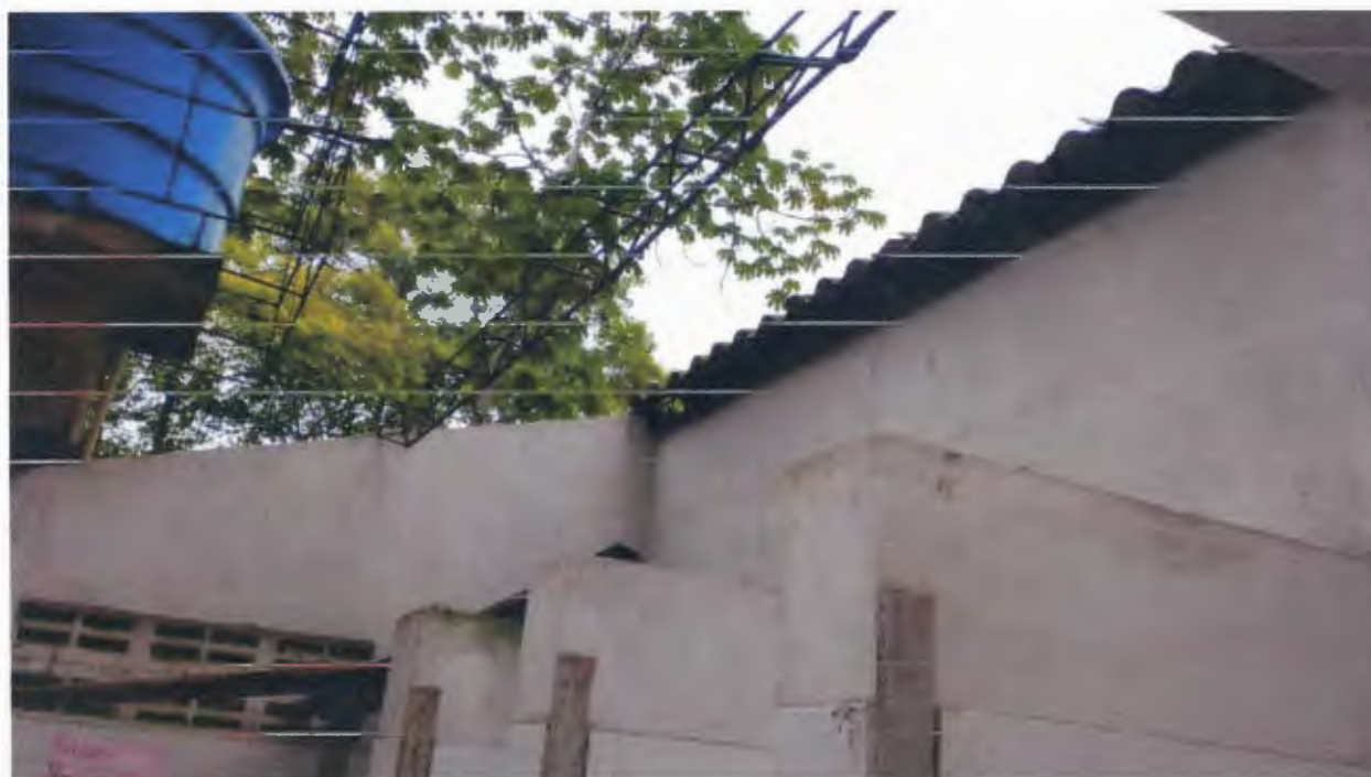
Imagen 20. Desmonte de cubiertas en mal estado
