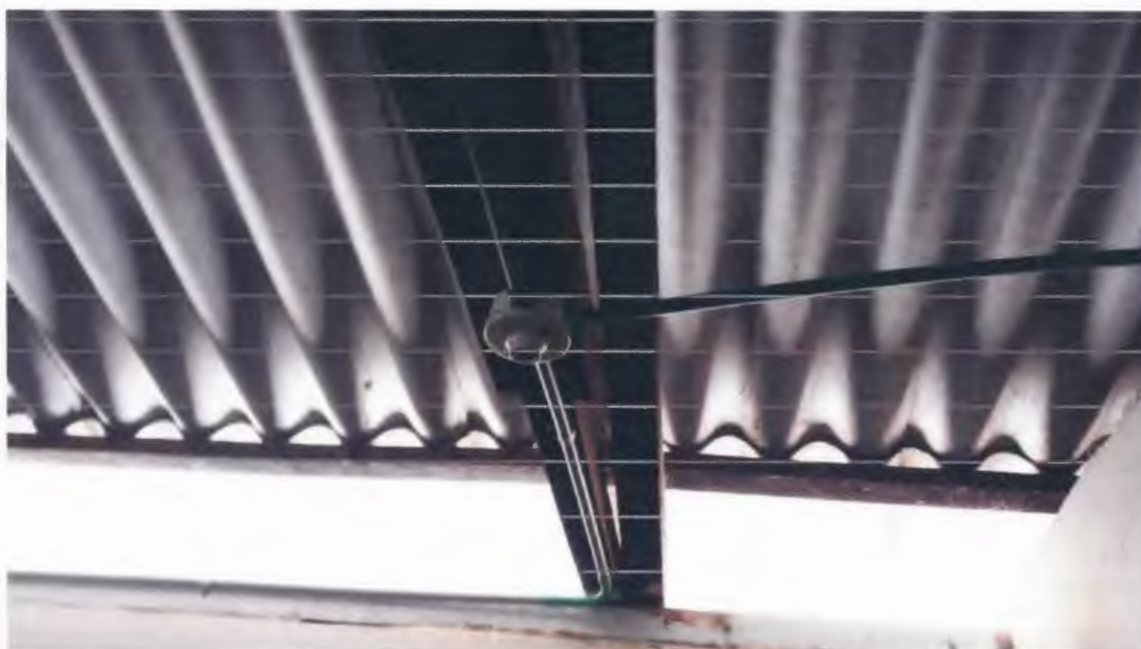
Imagen 35. Reparación de acometidas eléctricas
