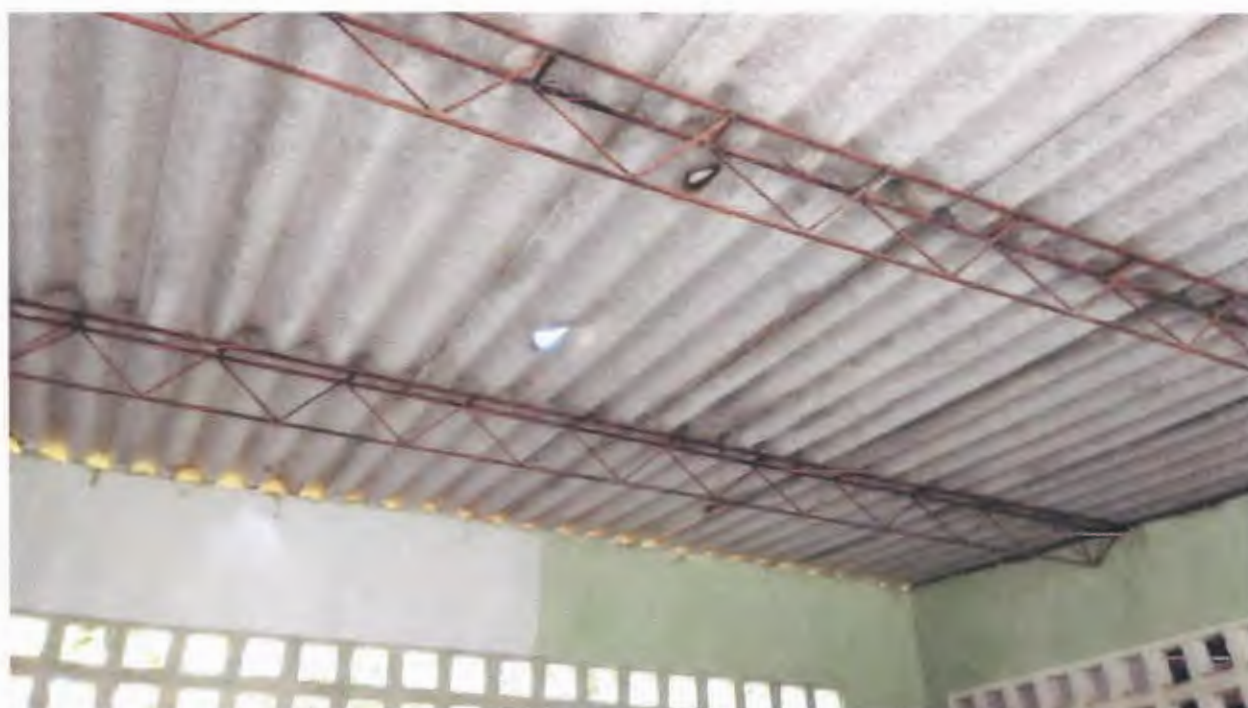
Imagen 14. Reparación y cambio de cubierta en baños
