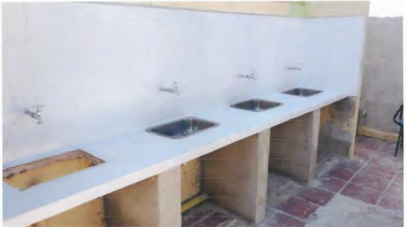
Imagen 48. Acabados de lavamanos
