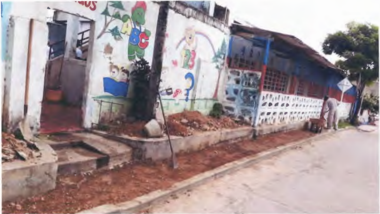
Imagen 27. Adecuación paso peatonal
