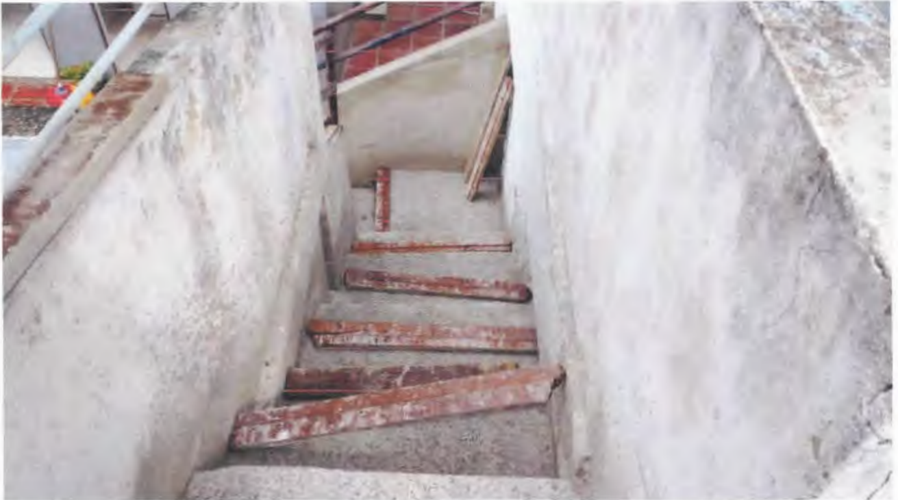
Imagen 31. Adecuación de escaleras en concreto
