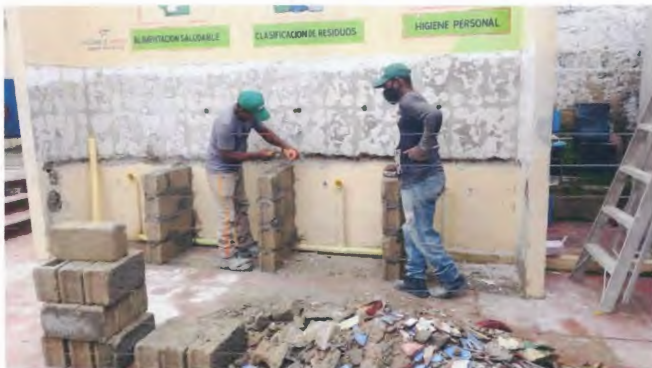
Imagen 47. Mampostería para lavamanos
