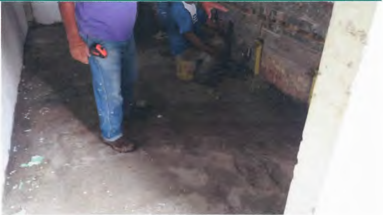
Imagen 9. Instalación de tubería y accesorios sanitarios
