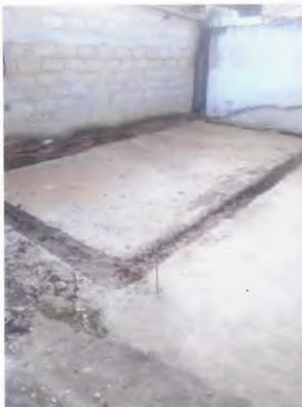
Imagen 44. Cimentación para baños
