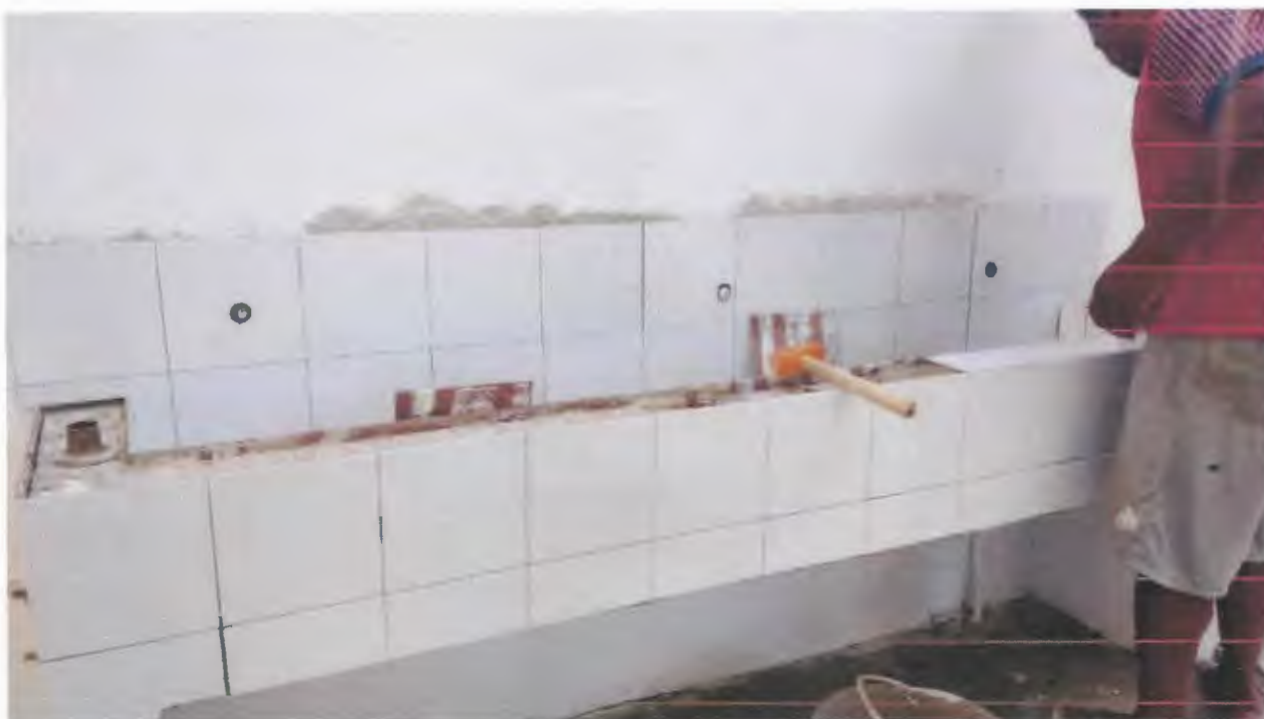
Imagen 23. Enchape lavamanos múltiple
