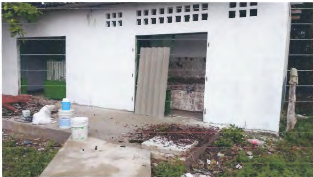
Imagen 12. Pintura exterior baterías de baños
