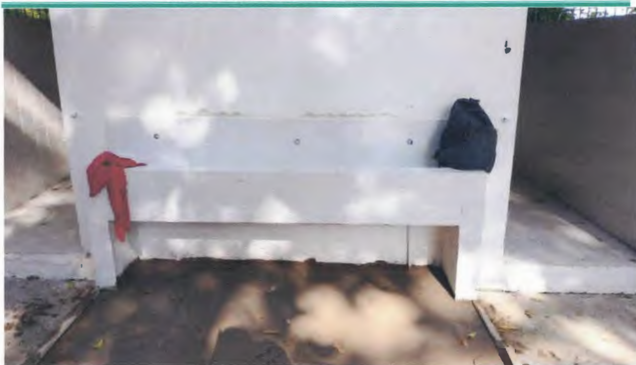
Imagen 25. Acabados enchape lavamanos
