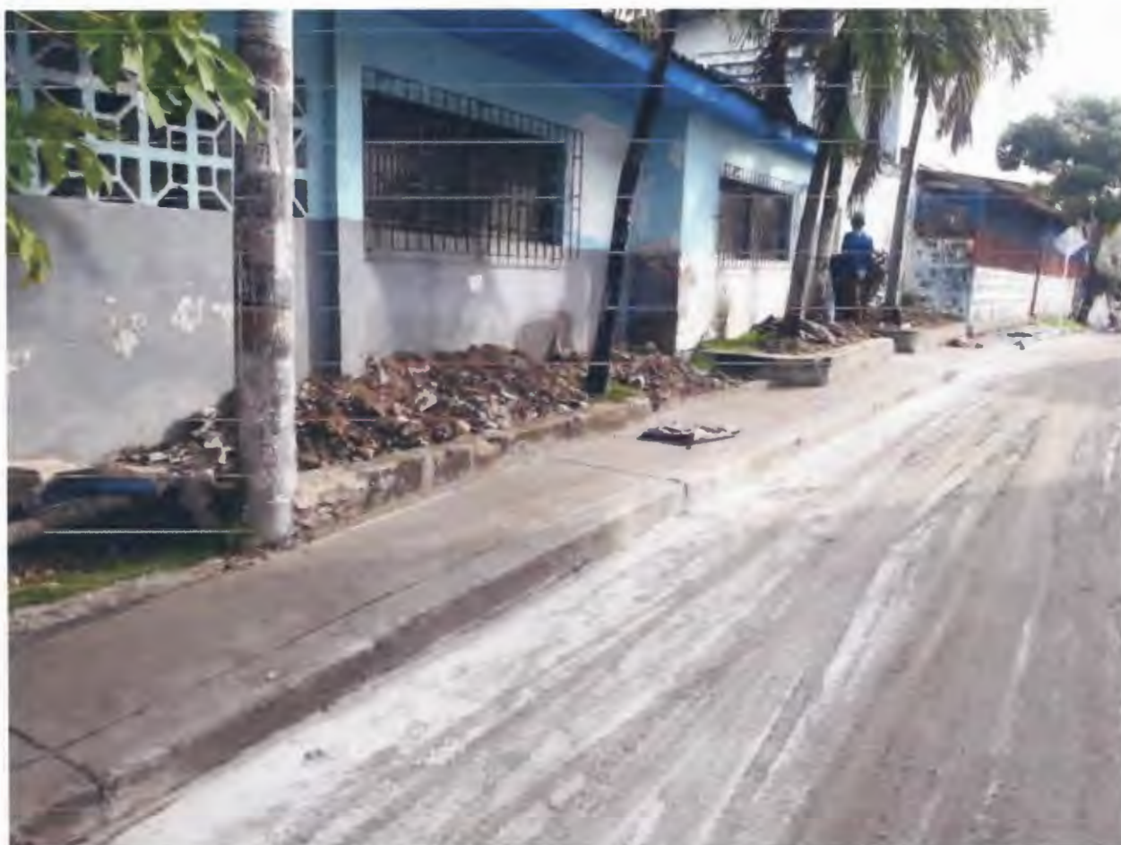
Imagen 28. Adecuación paso peatonal
