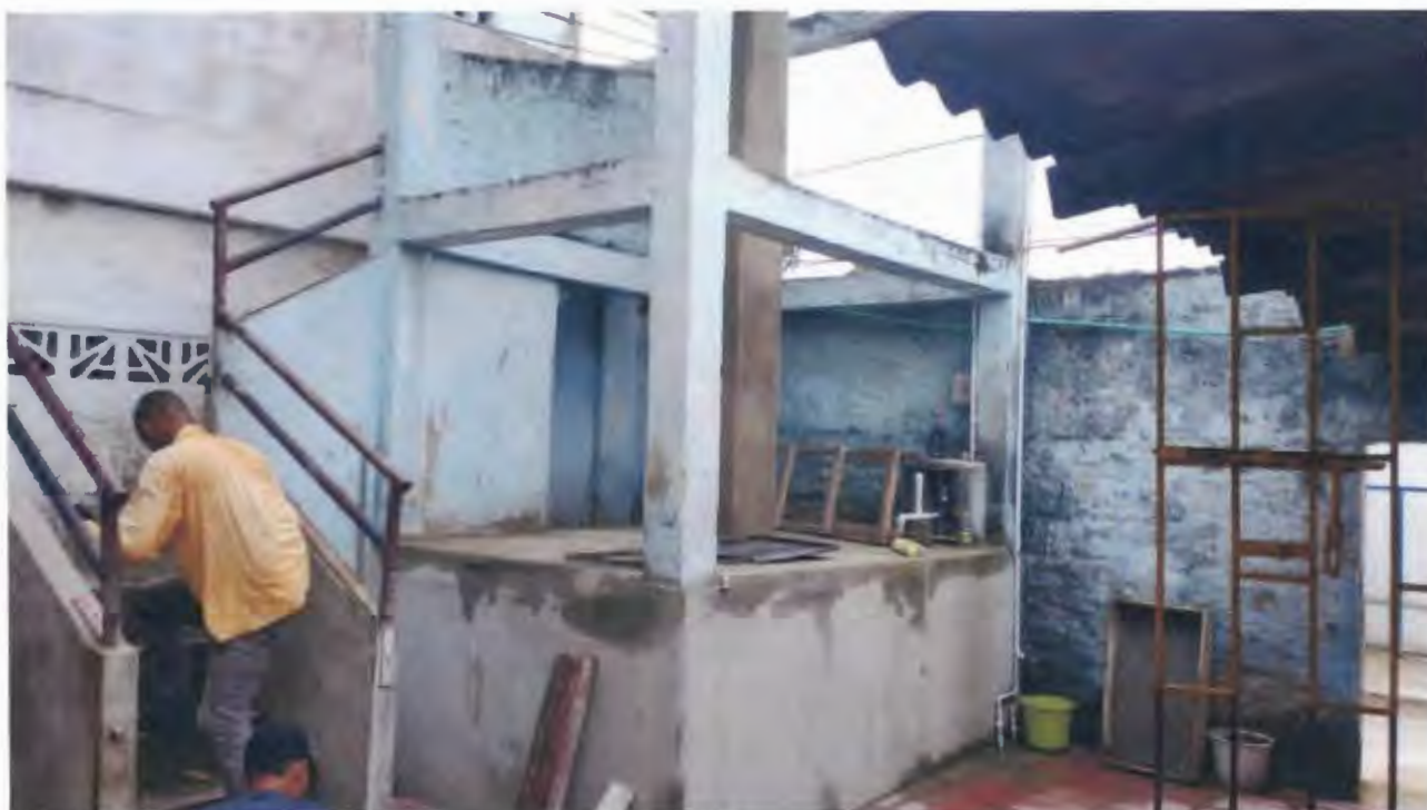
Imagen 30. Reparación de columna de soportes
