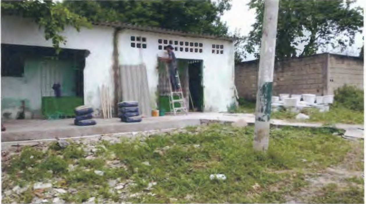
Imagen 4. Pintura exterior en baterías de baños
