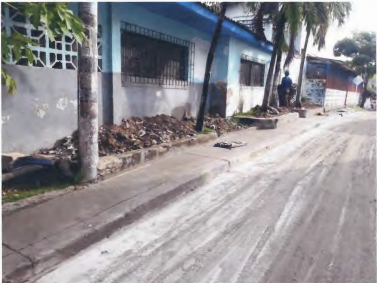
Imagen 28. Adecuación paso peatonal
