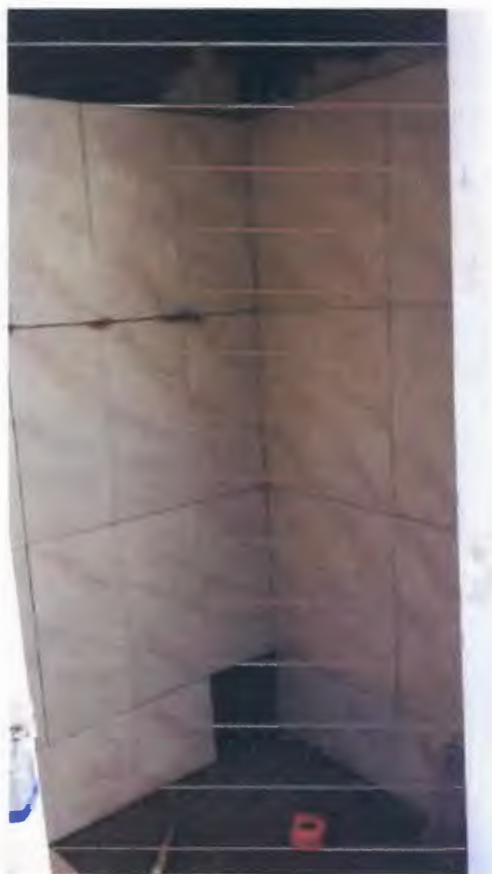
Imagen 43. Enchape muros baños profesores
