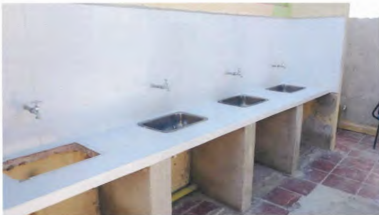
Imagen 48. Acabados de lavamanos
