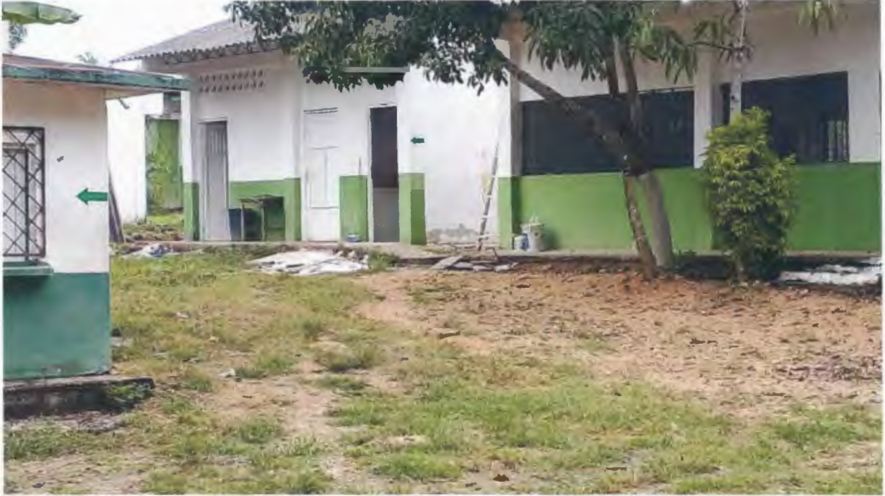
Imagen 15. Baños entrada principal
