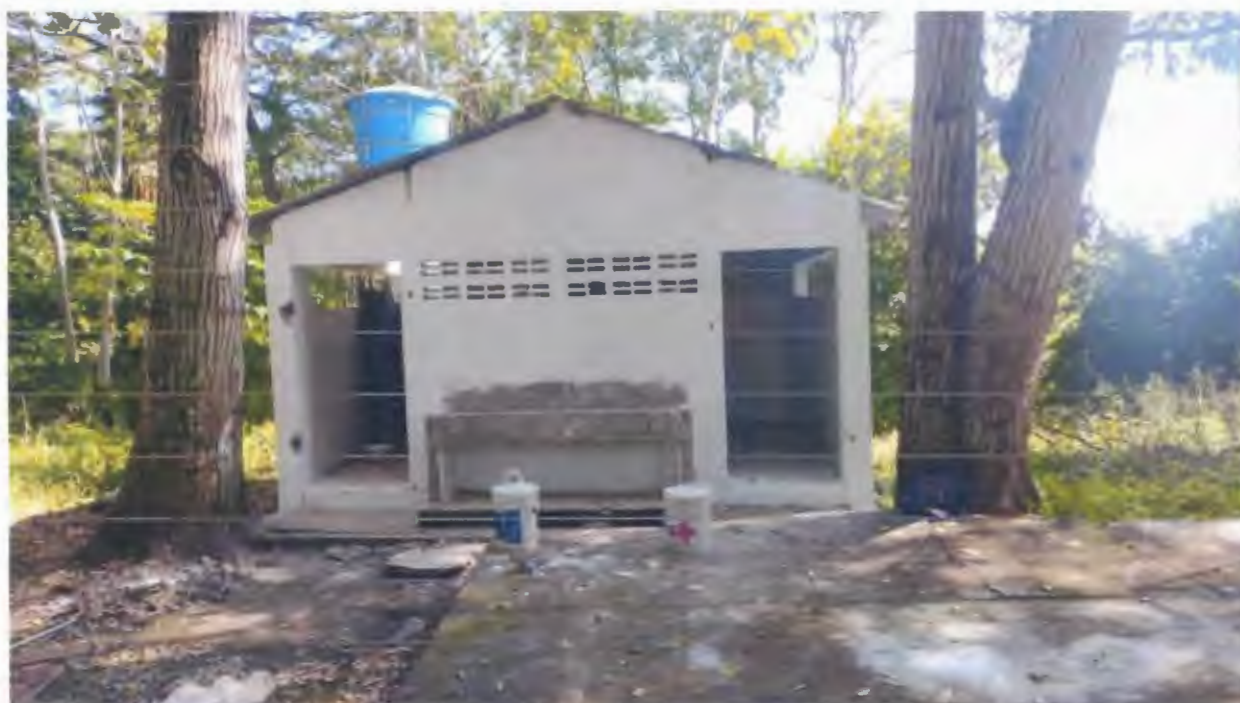
Imagen 20. Pintura muros exteriores
