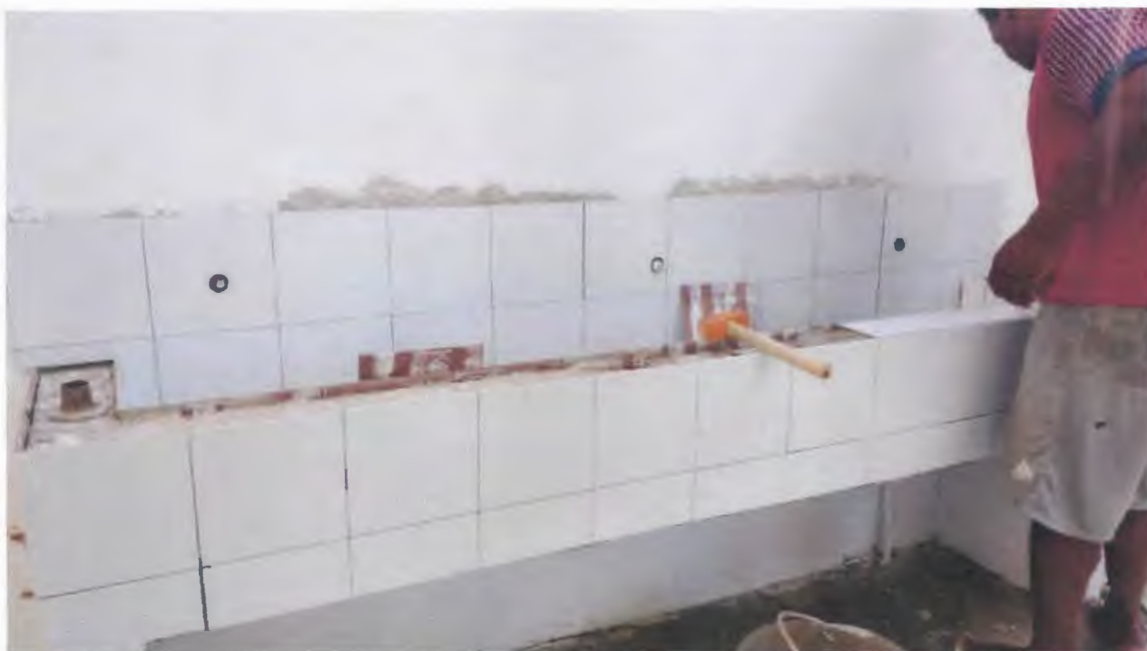
Imagen 23. Enchape lavamanos múltiple
