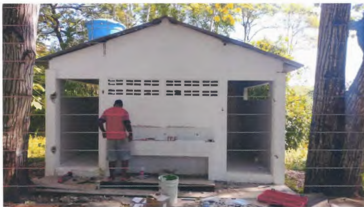
Imagen 24. Enchape lavamanos múltiple
