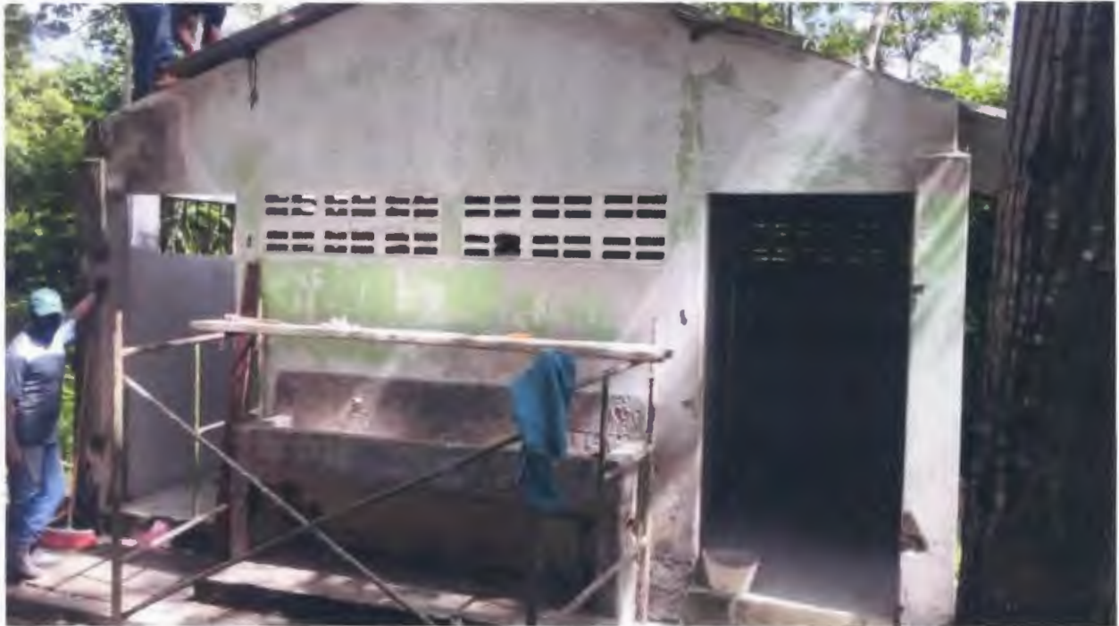
Imagen 20. Desmonte de cubiertas en mal estado
