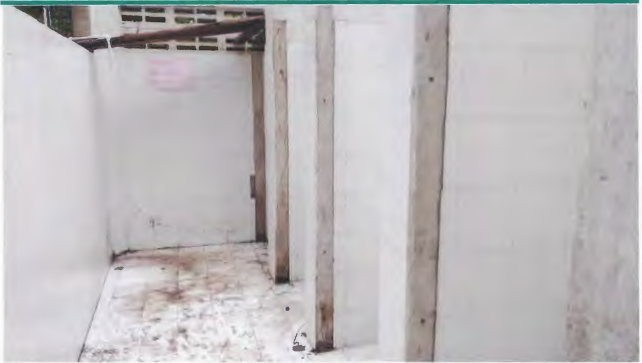
Imagen 17. Desmonte de puertas internas
