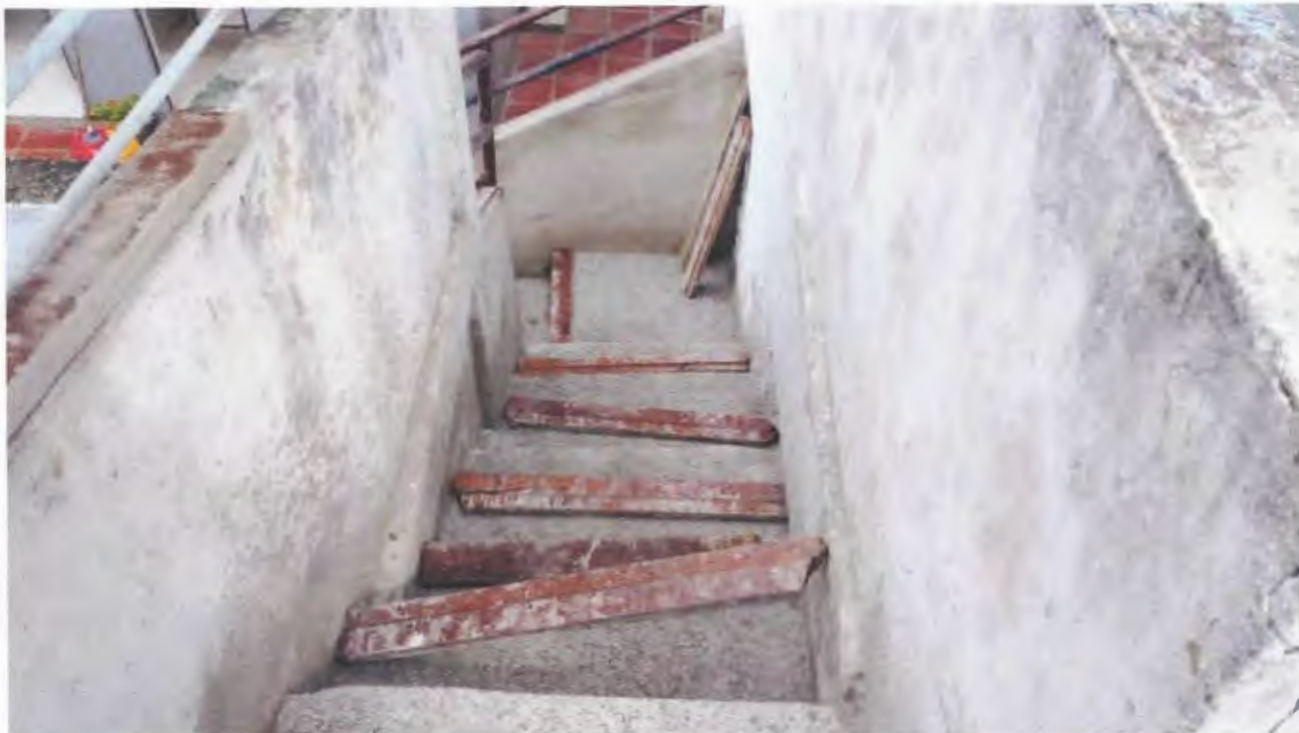
Imagen 31. Adecuación de escaleras en concreto
