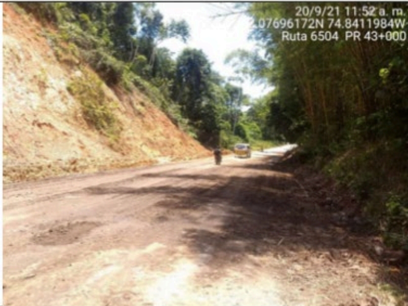
Conformación de la calzada PR43+000 RUTA 6504
