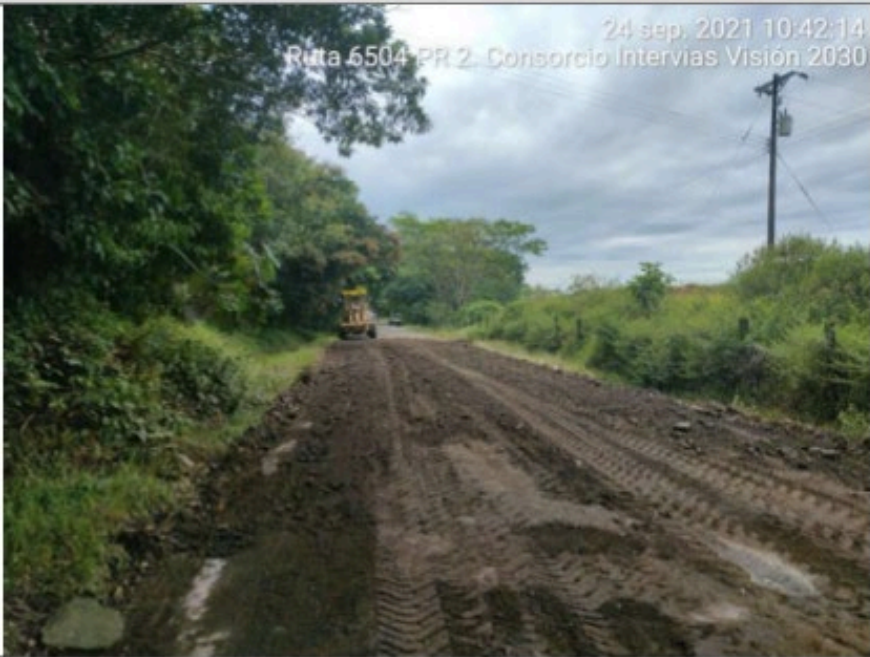
Conformación de la calzada PR13+650 RUTA 6504
