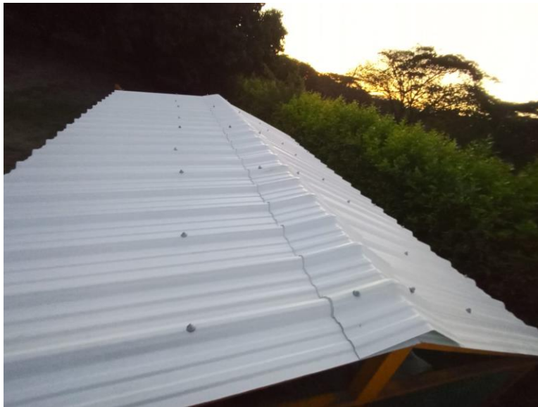
Después cambio de cubiertas y caballetes centro de acopios móviles de residuos
