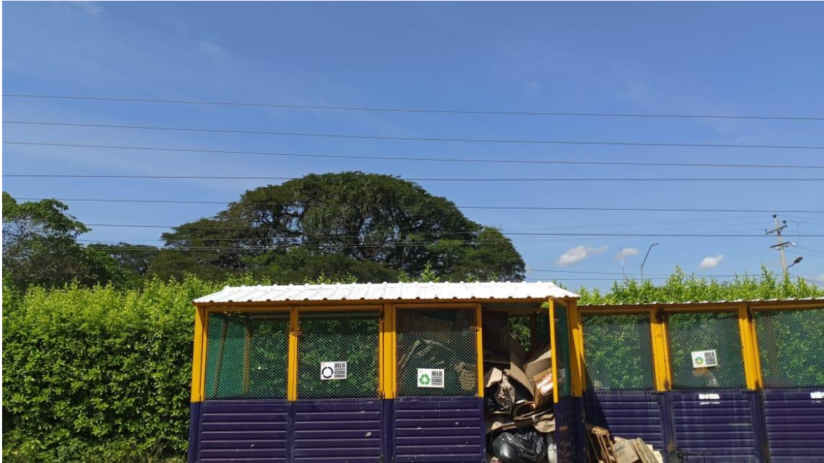
Centro de acopio móvil adecuado
