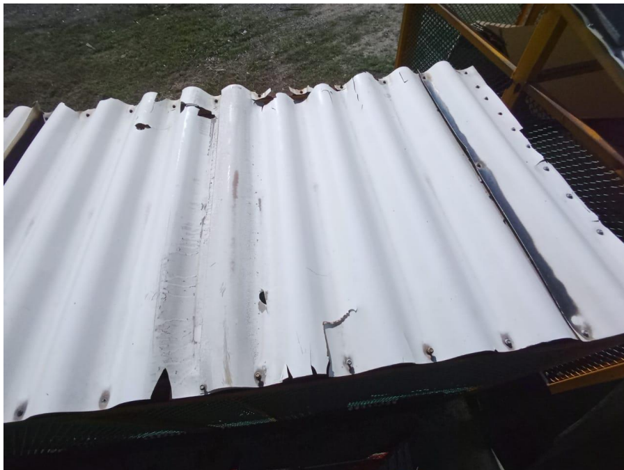
Antes cubiertas centro de acopios móviles de residuos
