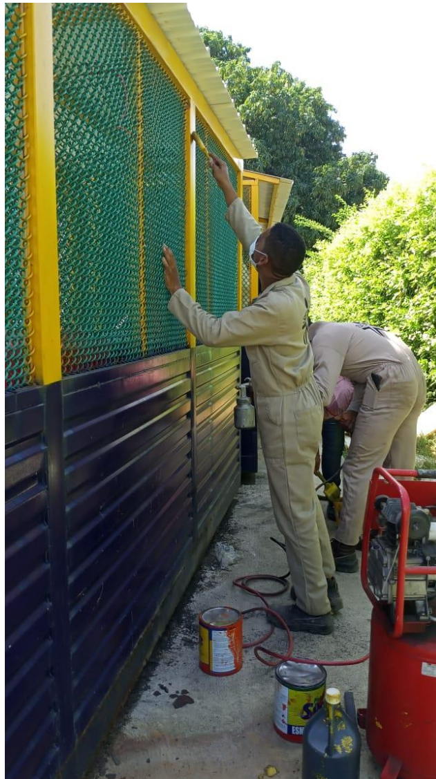
Aplicación de pintura anticorrosiva centro de acopios móviles de residuos
