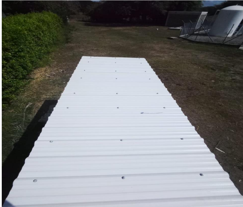
Cambio de cubiertas centro de acopios móviles de residuos
