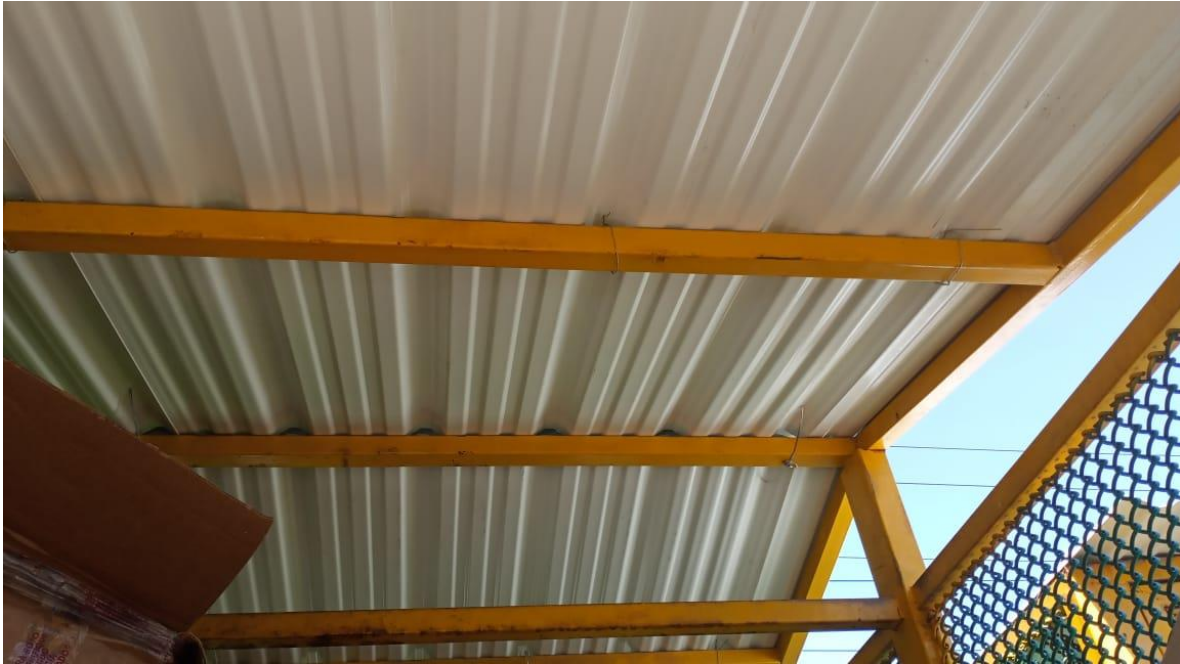
Cambio de cubiertas y caballetes centro de acopios móviles de residuos
