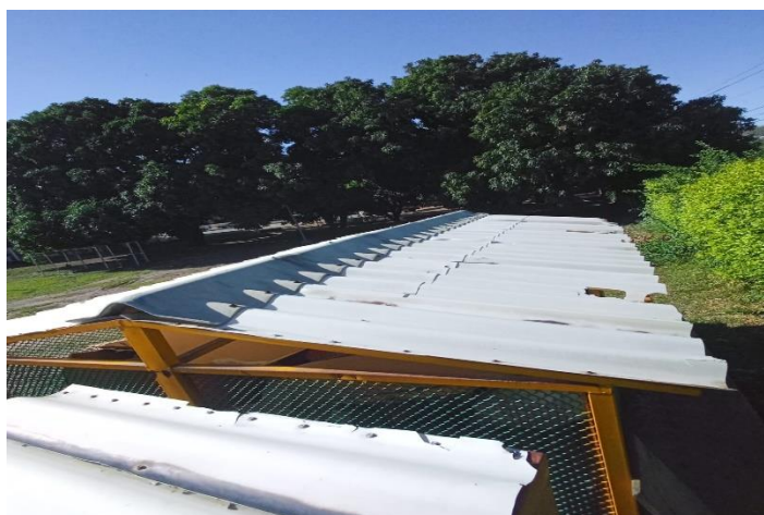
Antes cubiertas y caballetes centro de acopios móviles de residuos
