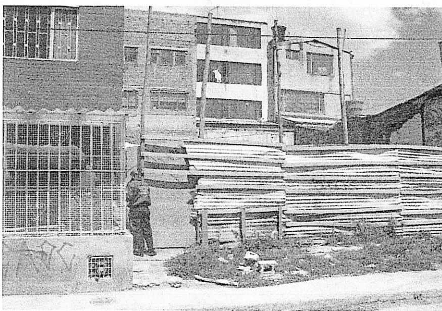
FACHADA (vista sobre la KR 78J)
