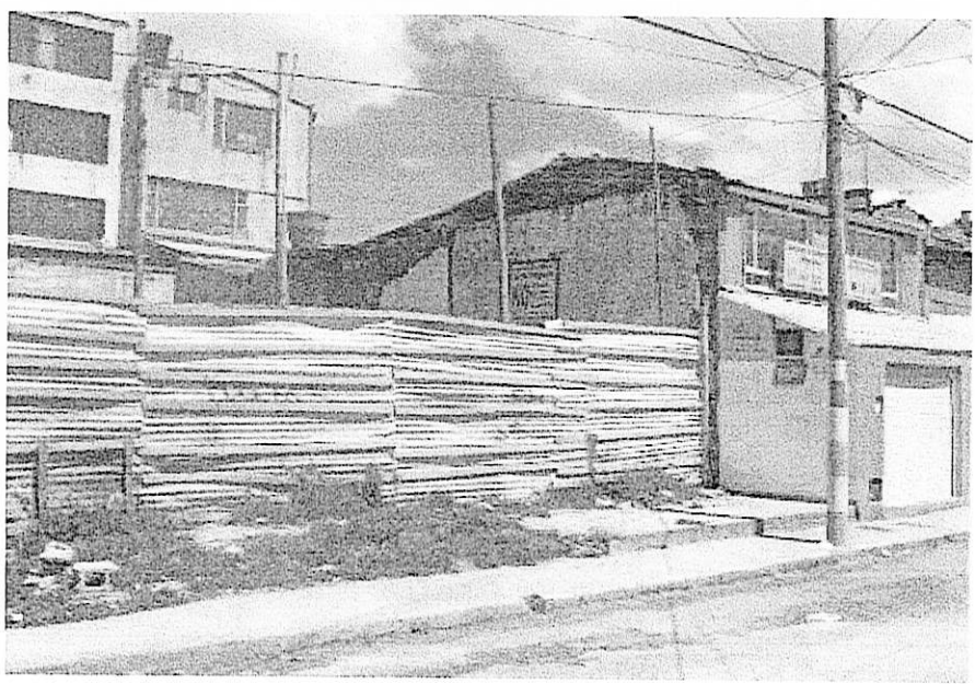
FACHADA (vista sobre la KR 78J)
