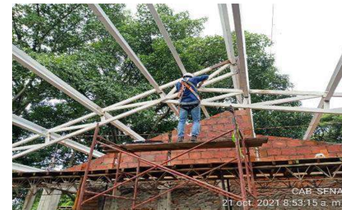
INSTALACION ESTRUCTURA METALICA
