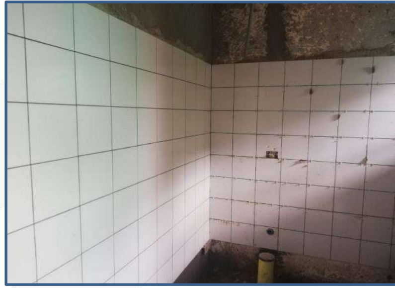
ESTRUCTURA DRY WALL - ENCHAFE BAÑOS - INST ELECTRICAS
