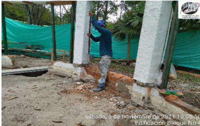
ESCARIFICADO Y DEMOLICION DE MUROS EXISTENTES
