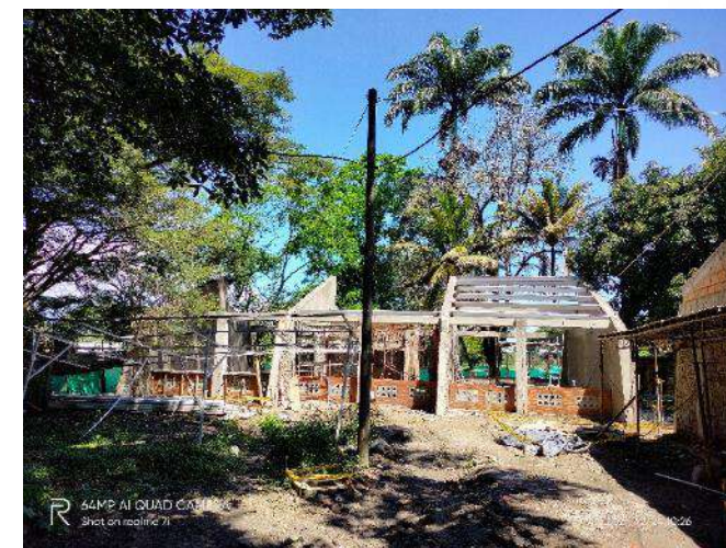
MONTAJE ESTRUCTURA METALICA SEGÚN DISEÑOS – BLOQUE 13
