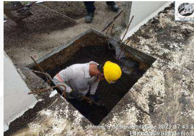
EXCAVACION MANUAL PARA CONCRETO CICLOPEO CIMENTACION
