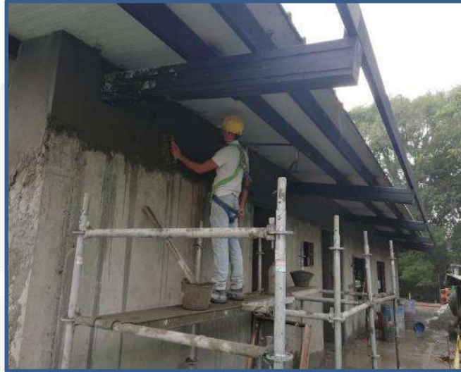
ESTUCO - REMATE DE CUCHILLAS CON CUBIERTA
