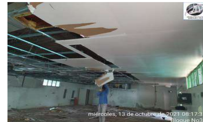
DESMANTELAMIENTO DE CIELO RAZO
