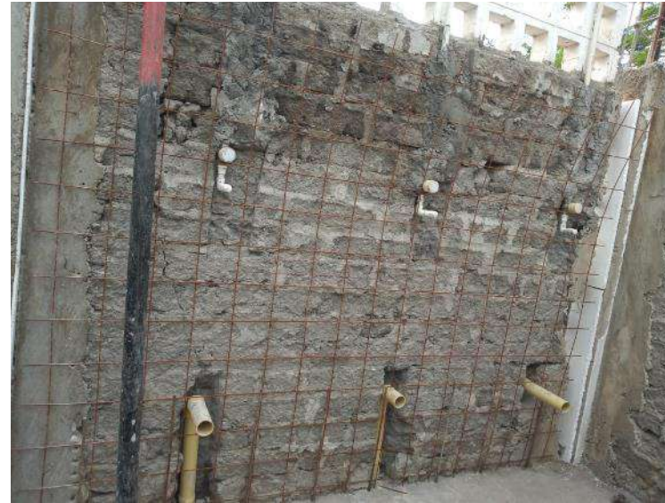
armado para pañete estructural
