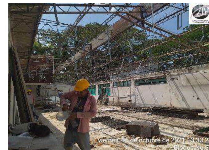
DESMANTELAMIENTO DE CUBIERTA ASBESTO CEMENTO
