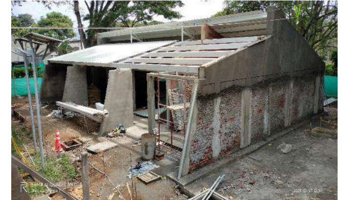
INSTALACION ESTRUCTURA METALICA
