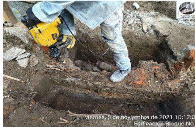
DEMOLICION MECANICA DE CIMENTACION CICLOPEO EXISTENTE
