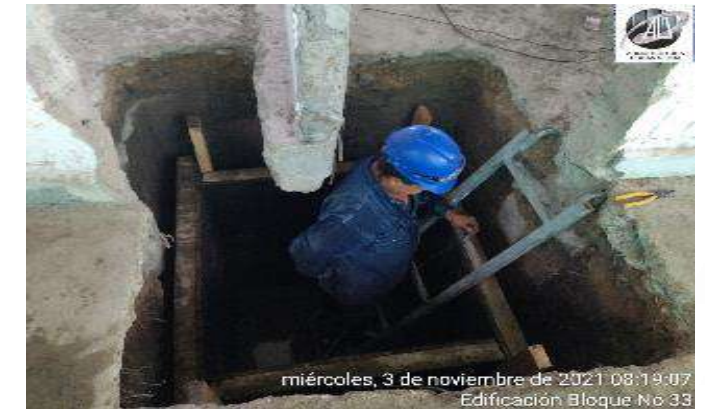
APUNTALAMIENTO DE FORMALETA PARA MEJORAMIENTO EN CONCRETO CICLOPEO PARA CIMENTACION
