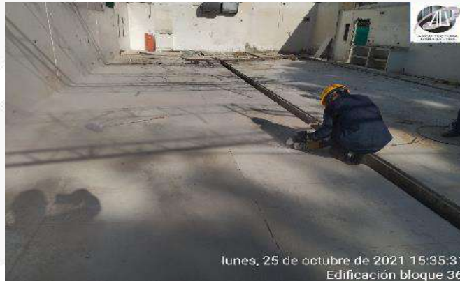
CORTE DE PISOS PARA DEMOLICION
