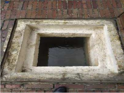
Tanque de almacenamiento bajo de agua potable
