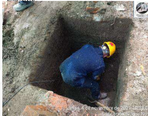
EXCAVACION Y PERFILACION AREA PARA CIMENTACION
