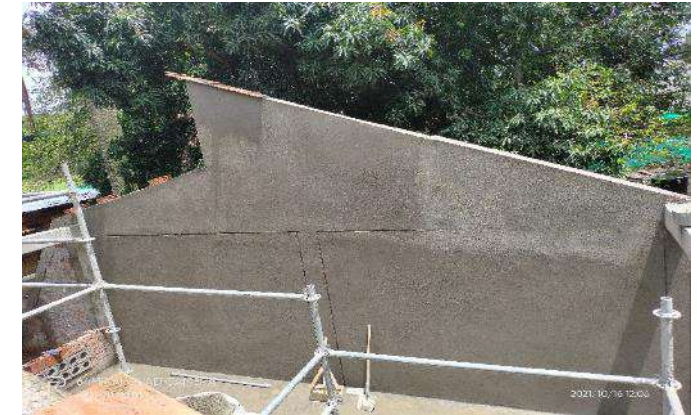
PAÑETE Y DILATACIONES MUROS INTERNOS
