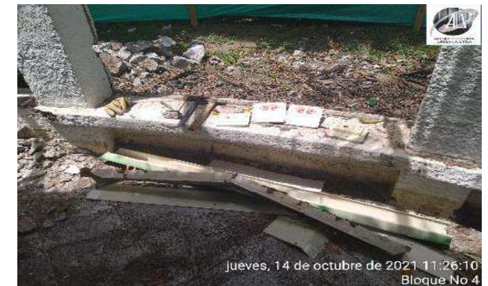
DESISTALACION DE ACCESORIOS Y RED ELECTRICA
