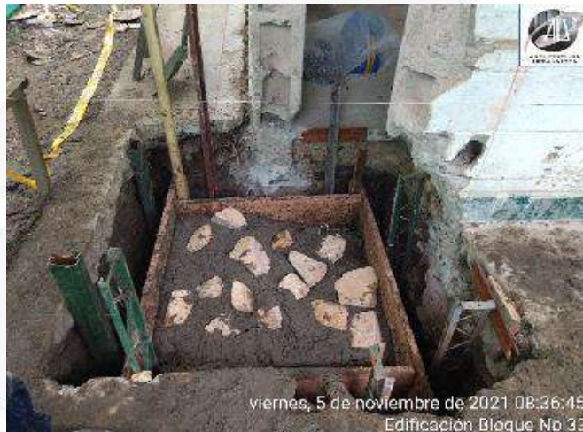
CONSTRUCCION DE CONCRETO CICLOPEO PARA CIMENTACION
