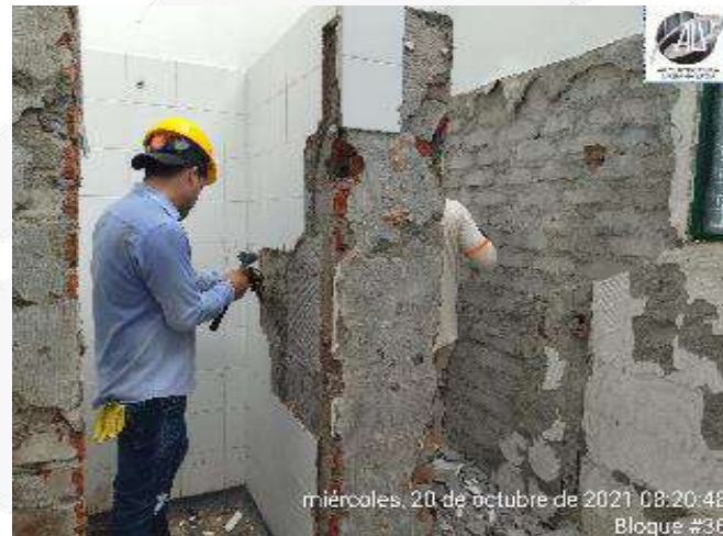
DEMOLICION DE ENCHAPES MUROS
