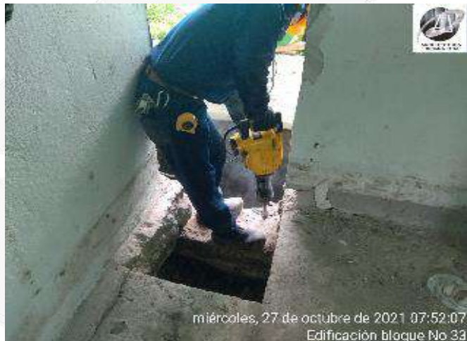
CORTE Y DEMOLICION DE PISOS
