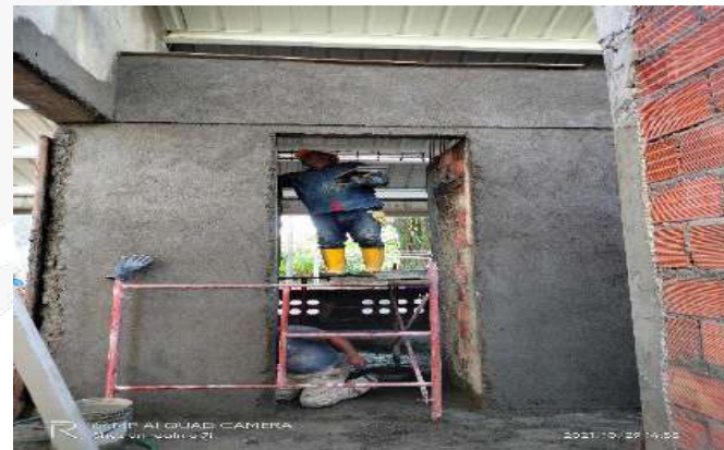
PAÑETES MUROS INTERNOS Y EXTERNOS CON DILATACIONES
