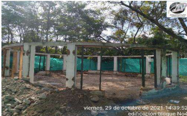
DEMOLICION DE PLACA CONTRAPISO EXISTENTE
