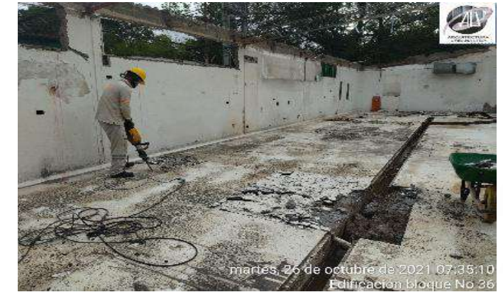
DEMOLICION MECANICA DE PISOS
