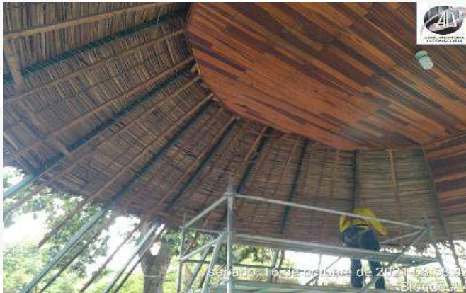
DESMANTELAMIENTO DE CIELO RAZO
