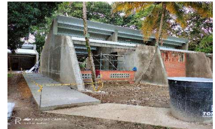
CONSTRUCCION ANDEN PERIMETRAL DE COMUNICACION ENTRE BLOQUES
