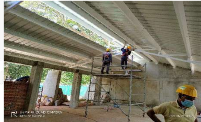
RESANE Y PINTURA ESTRUCTURA CUBIERTA METALICA BLOQUE 12
