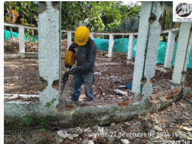
DEMOLICION Y ESCARIFICADO DE COLUMNETAS
