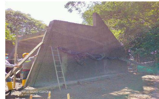
PAÑETES MUROS EXTERNOS IMPERMEABILIZADOS
