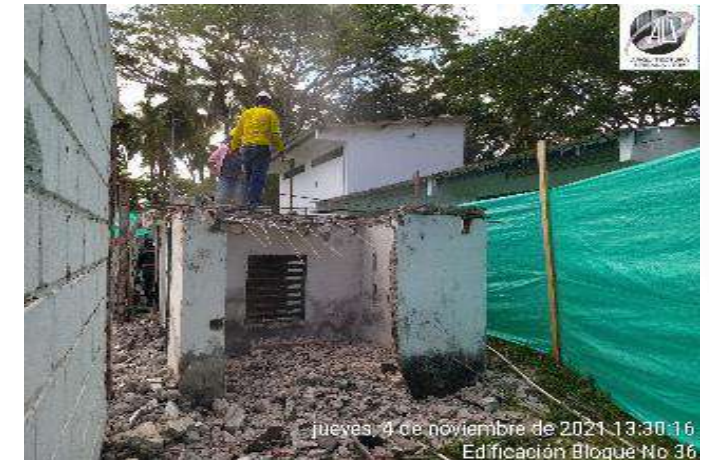
DEMOLICION MUROS Y PLACA EXISTENTE AREA DE EQUIPOS
