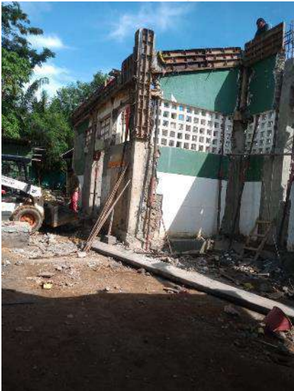
VIGAS ZONA DE BAÑOS
