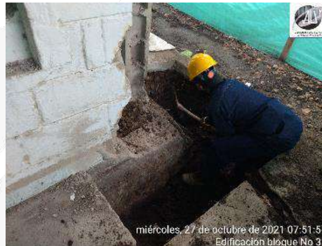
EXCAVACION MANUAL CIMENTACION
