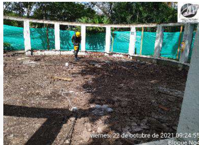
DEMOLICION DE PLACA CONTRAPISO EXISTENTE
