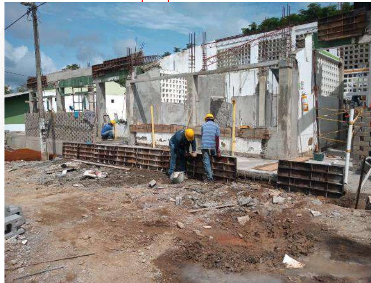
Armado Muro de acceso
