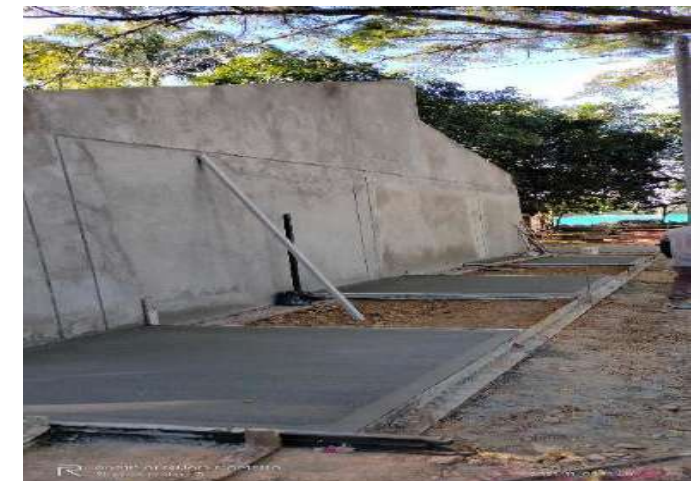
CONSTRUCCION ANDENES DE CIRCULACION Y CONEXIÓN ENTRE BLOQUES DE FORMACION
