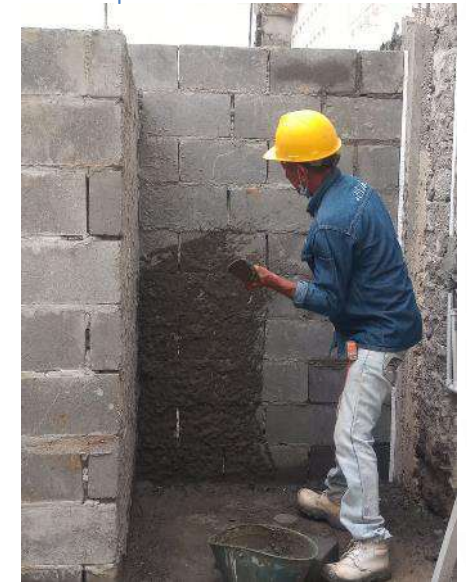
Pañete zona baños
