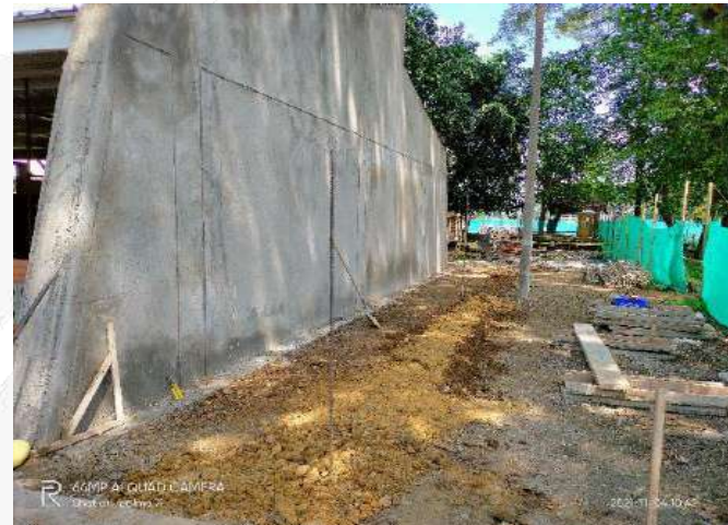
RELLENO Y CONFORMACION AREA CON RECEBO COMPACTADO
