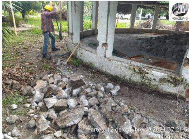
DEMOLICION DE ANDENES EXISTENTES
