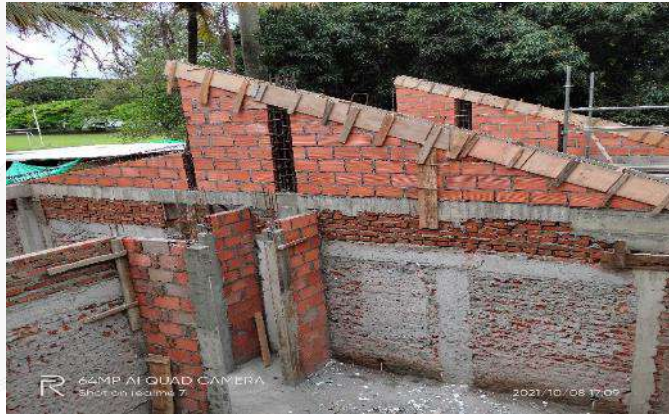
MAMPOSTERIA Y CONFINAMIENTO BLOQUE 13
