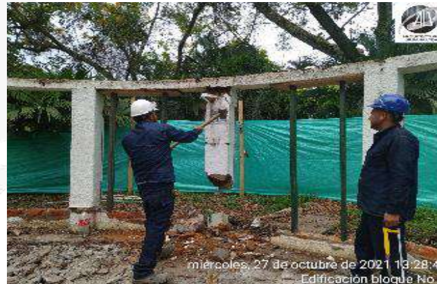
DEMOLICION DE COLUMNAS EXISTENTES
