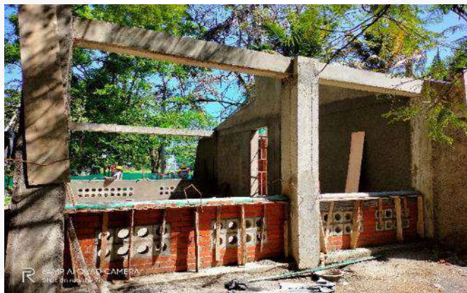
MAMPOSTERIA EN LADRILLO PRENSADO Y CONFINAMIENTO BLOQUE 13
