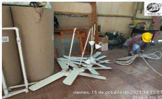
DESMANTELAMIENTO DE EQUIPOS Y RED ELECTRICA
