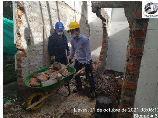
DEMOLICION DE MUROS EXISTENTES BATERIA SANITARIA
