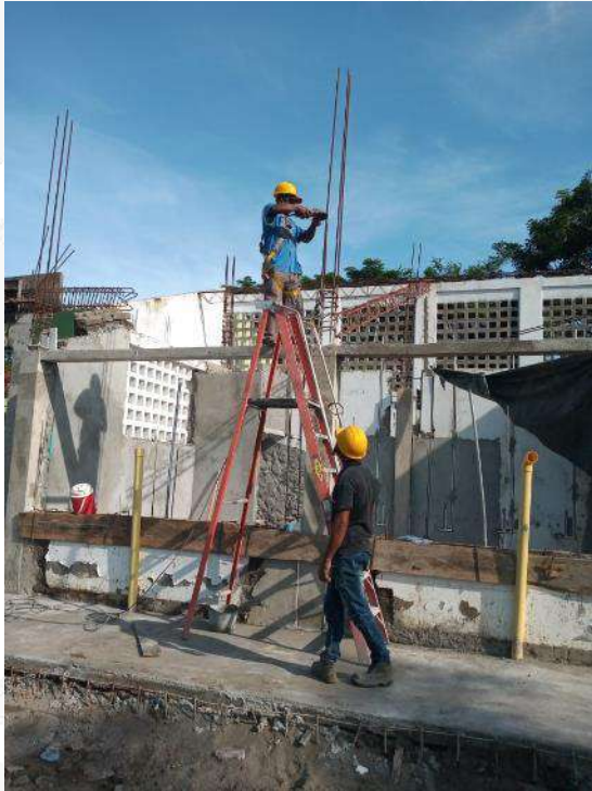
Armado de columnas
