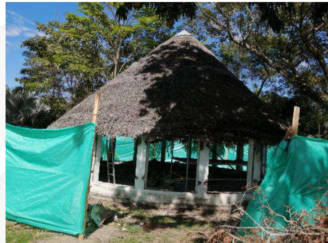
DESMANTELAMIENTO DE PUERTAS Y VENTANAS
