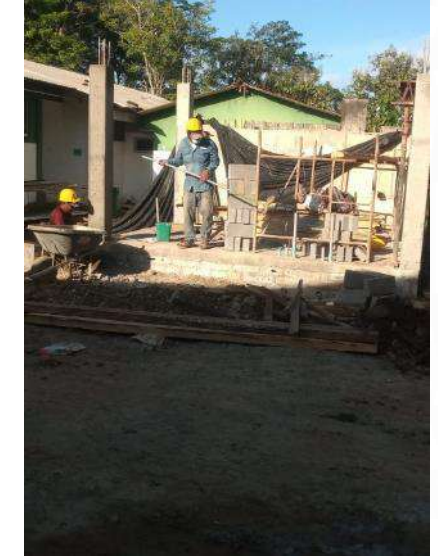
cuarto de bombas
