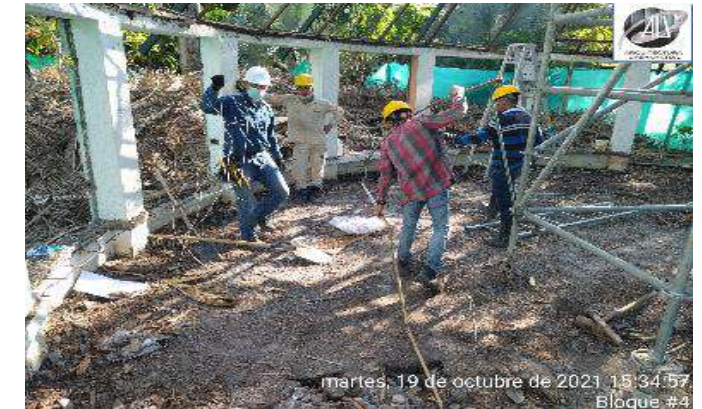
DESISTALACION DE ACCESORIOS Y RED ELECTRICA
