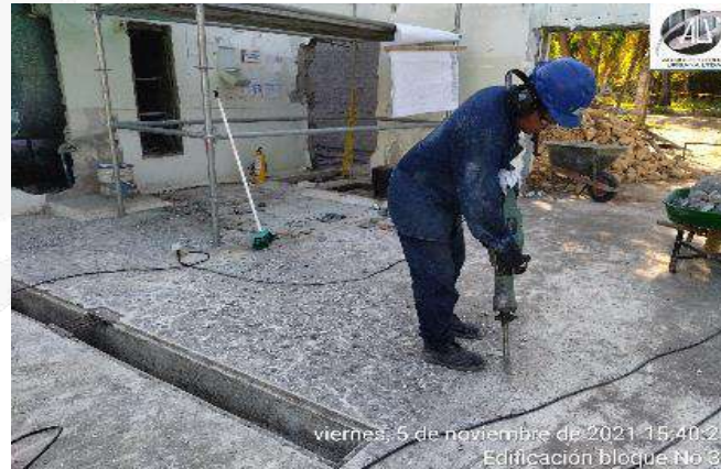
ESCARIFICACION MECANICA DE PISO PARA CONSTRUCCION PLACA CONTRAPISO
