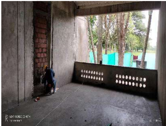
CONSTRUCCION ALISTADO DE PISOS Y PAÑETES MUROS INTERNOS
