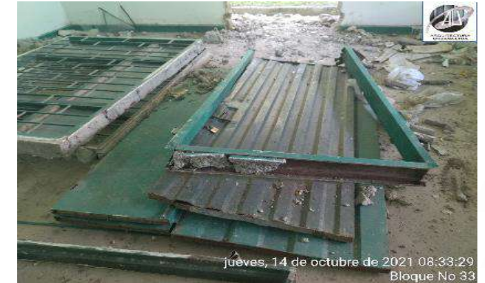
DESMANTELAMIENTO DE PUERTAS Y VENTANAS
