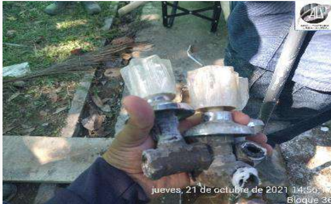
DESMANTELAMIENTO DE ACCESORIOS HIDRAULICOS
