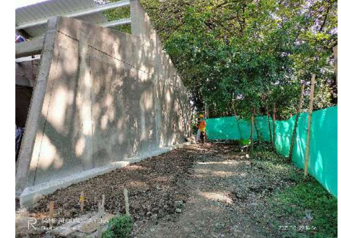
RELLENO Y CONFORMACION ZONA EXTERNA BLOQUES
