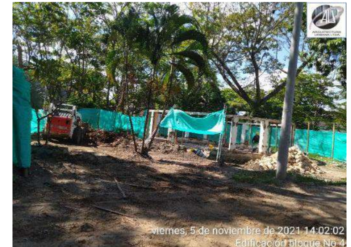
CARGUE Y RETIRO ESCOMBROS
