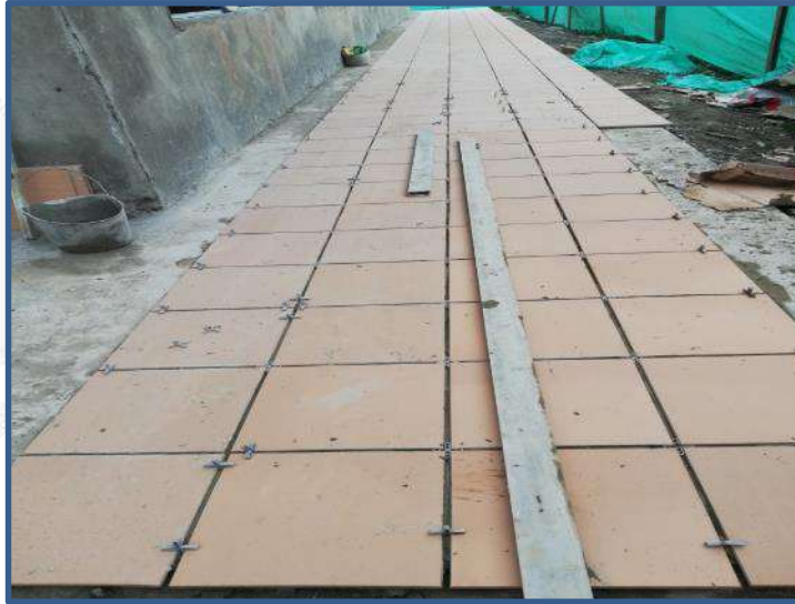
Instalación de tableta pasillos
