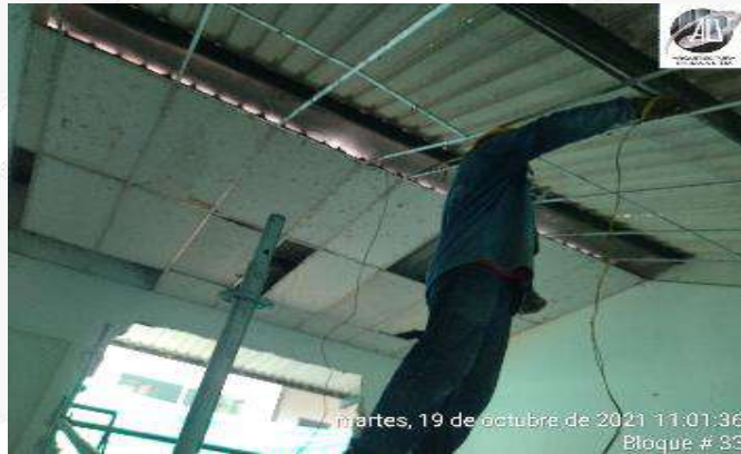
DESISTALACION DE ACCESORIOS Y RED ELECTRICA
