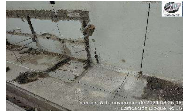
CORTE MECANICO MUROS Y PISOS PARA DEMOLER
