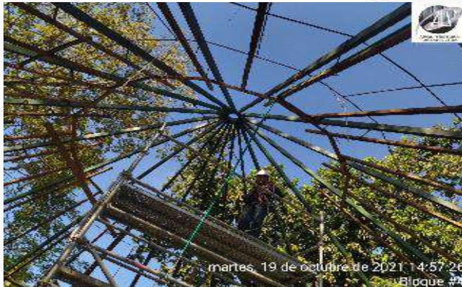
DESMANTELAMIENTO DE CIELO RAZO Y CUBIERTA
