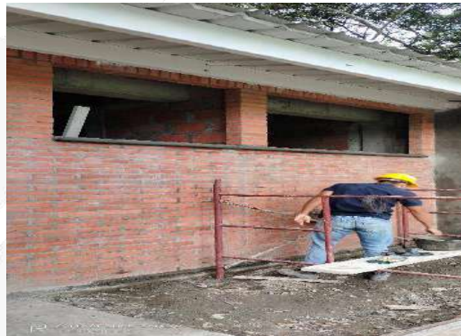
CONSTRUCCION ALFAGIAS EN CONCRETO
