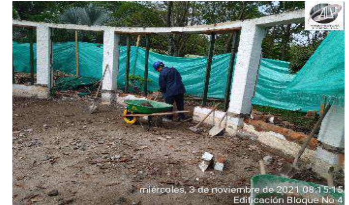
CARGUE Y RETIRO DE MATERIAL DE ESCOMBROS ACOPIO
