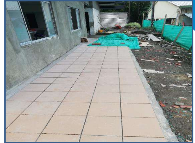
Instalación de tableta pasillos
