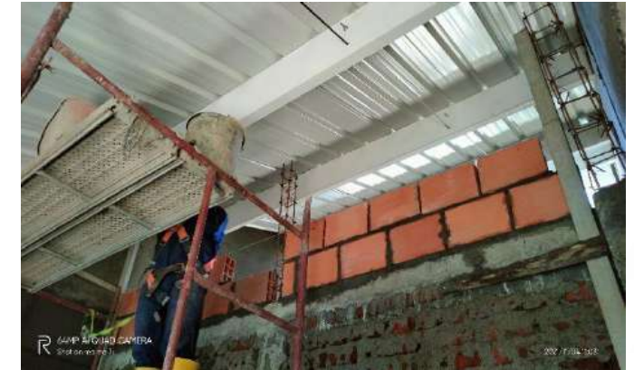
MAMPOSTERIA Y PAÑETE MUROS INTERNOS
