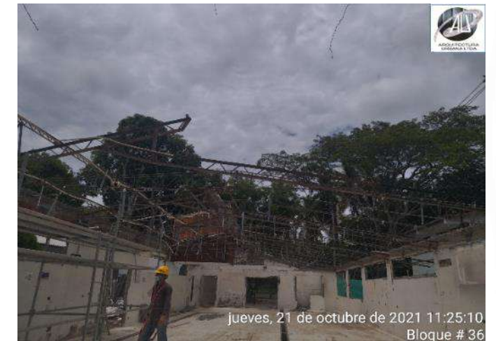
DESMONTE ESTRUCTURA METALICA
