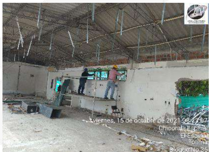
DESMONTE DE PUERTAS Y VENTANAS
