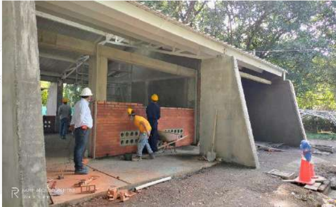
MAMPOSTERIA FACHADAS EN LADRILLO PRENSADO
