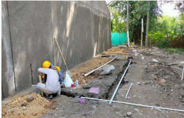
INSTALACION RED HIDRAULICA PARA BATERIAS SANITARIAS
