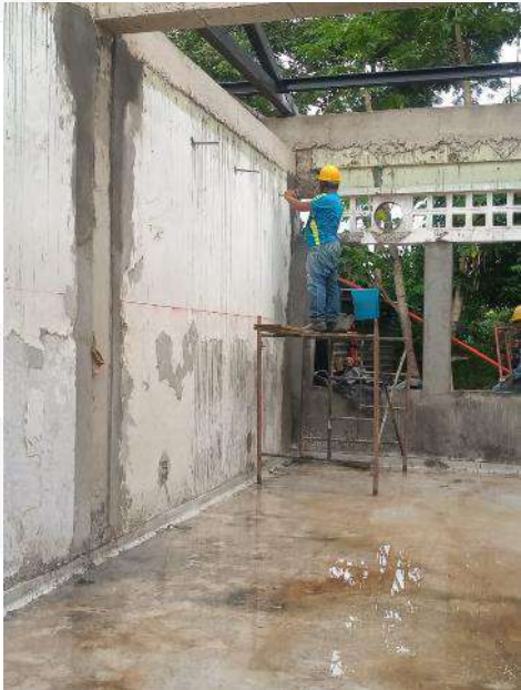
Raspado de pintura
