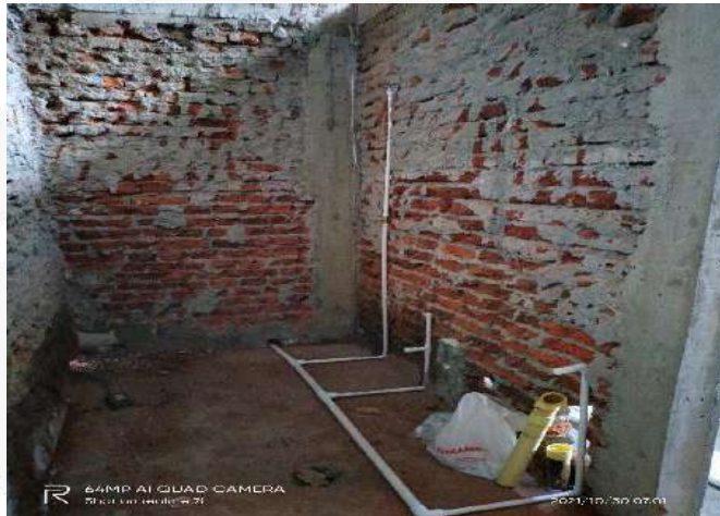
INSTALACION TUBERIA HIDRAULICA
