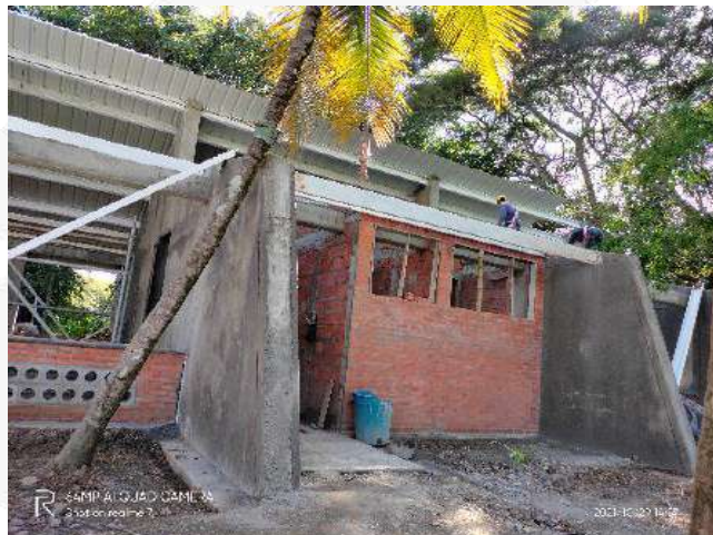
INSTALACION CUBIERTA METÁLICA CON AISLAMIENTO (TIPO SÁNDWICH) – BLOQUE 13
