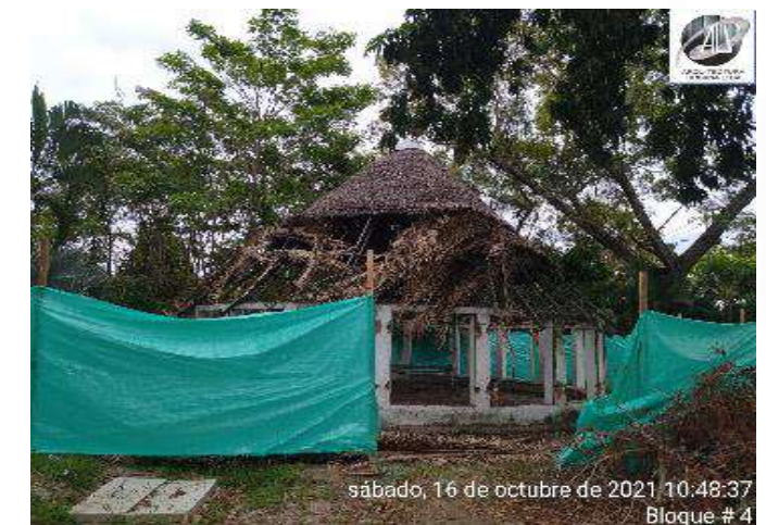
DESMONTE DE CUBIERTA
