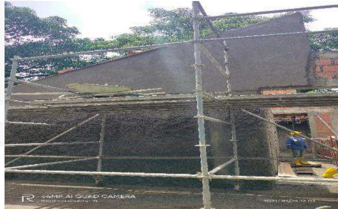
PAÑETES MUROS INTERNOS
