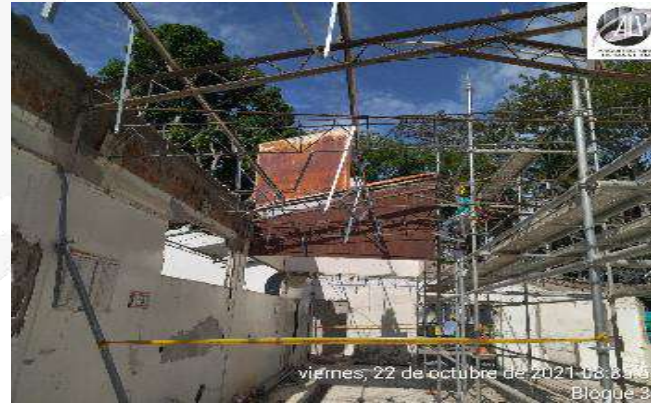
DESMONTE ESTRUCTURA METALICA
