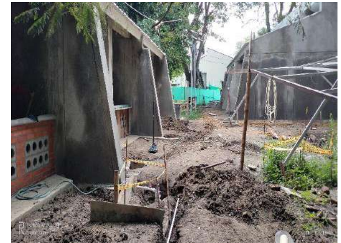
CONSTRUCCION CAJAS Y EXCAVACION RED PLUVIAL
