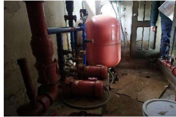
Equipo de presión contante tanque hidro de 300 lts y 3 bombas de 3 hp
