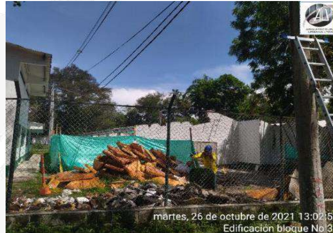
CARGUE Y ACOPIO DE ESCOMBROS
