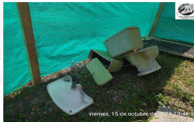
DESISTALACION DE ACCESORIOS SANITARIOS
