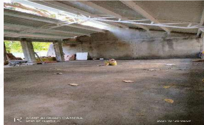
MONTAJE ESTRUCTURA Y CUBIERTA METALICA BLOQUE 12
