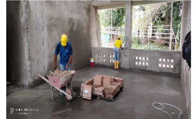
CONSTRUCCION DE ALISTADO DE PISOS Y ACOPIO DE ENCHAPE
