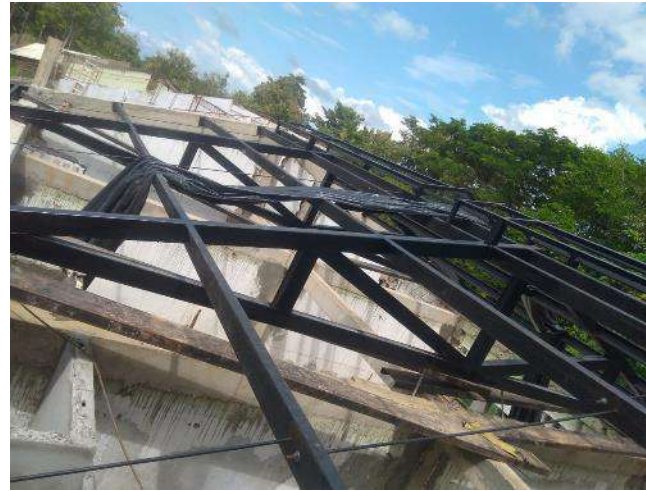
Estructura de cubierta
