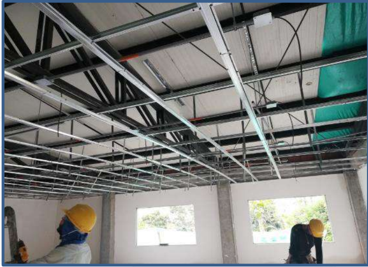
Continuación red eléctrica, instalación de lámparas LED
