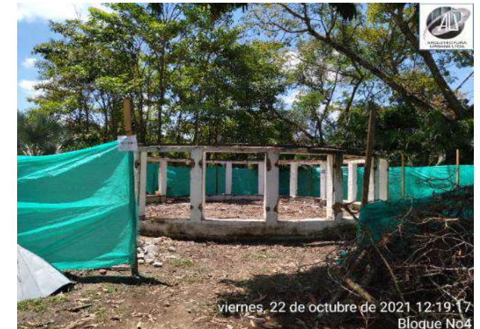
DESMONTE DE CUBIERTA
