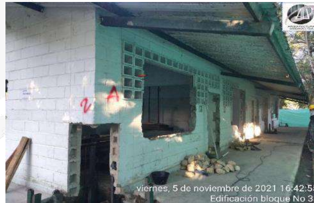
CORTE Y DEMOLICION DE MUROS EXISTENTES
