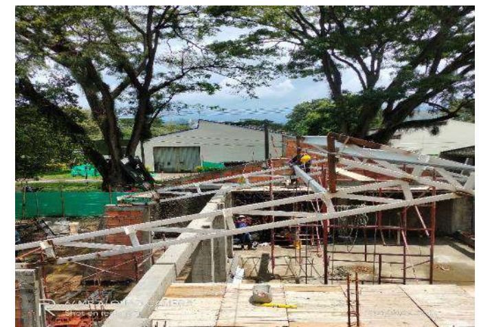
MONTAJE ESTRUCTURA METALICA BLOQUE 12
