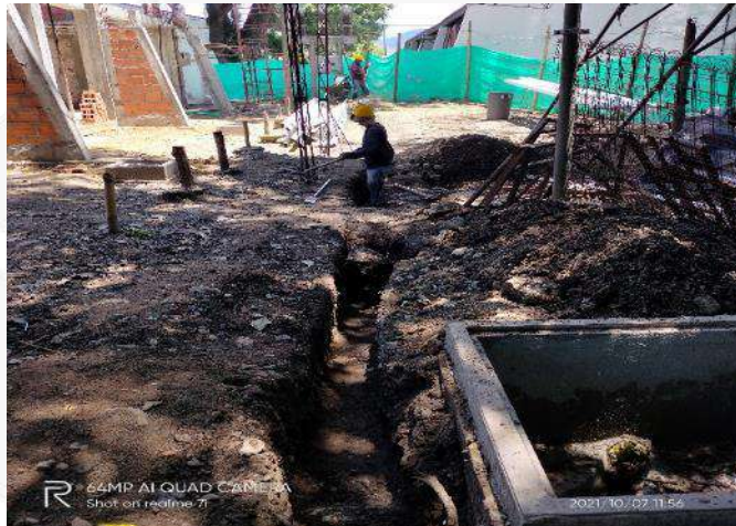
EXCAVACION MANUAL PARA INSTALACION TUBERIA ELECTRICA
