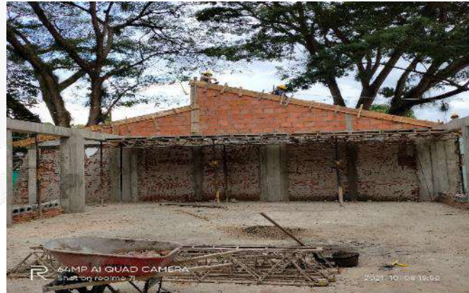
CONSTRUCCION VIGUETA DE CONFINAMIENTO
