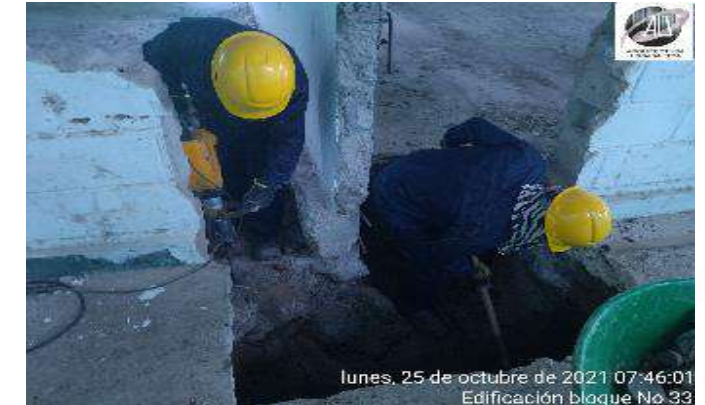
DEMOLICION MECANICA CIMENTACION CICLOPEO
