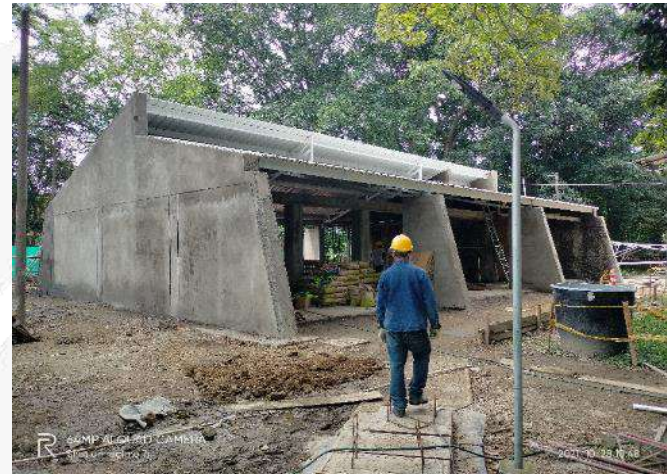
INSTALACION CUBIERTA METÁLICA CON AISLAMIENTO (TIPO SÁNDWICH) – BLOQUE 12
