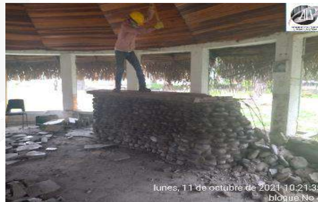
DEMOLICION DE MESON EXISTENTE
