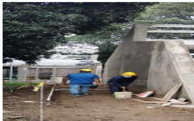
IMPERMEABILIZACION PAÑETE MUROS FACHADAS
