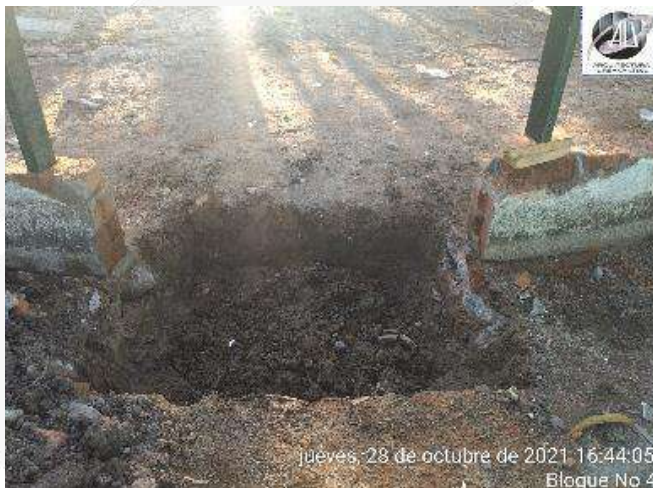
EXCAVACION MANUAL PARA CIMENTACION
