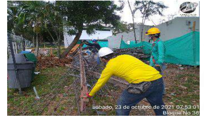
DESMONTE Y ACOPIO DE ESTRUCTURA METALICA
