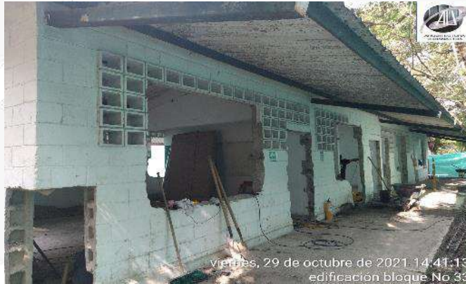
DESMONTE DE PUERTAS Y VENTANAS
