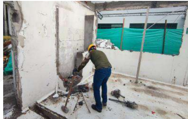
DEMOLICION DE MUROS
