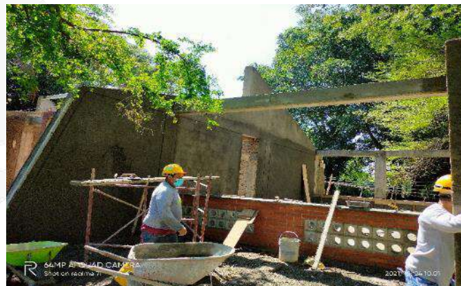
PAÑETES MUROS INTERNOS Y EXTERNOS CON DILATACIONES
