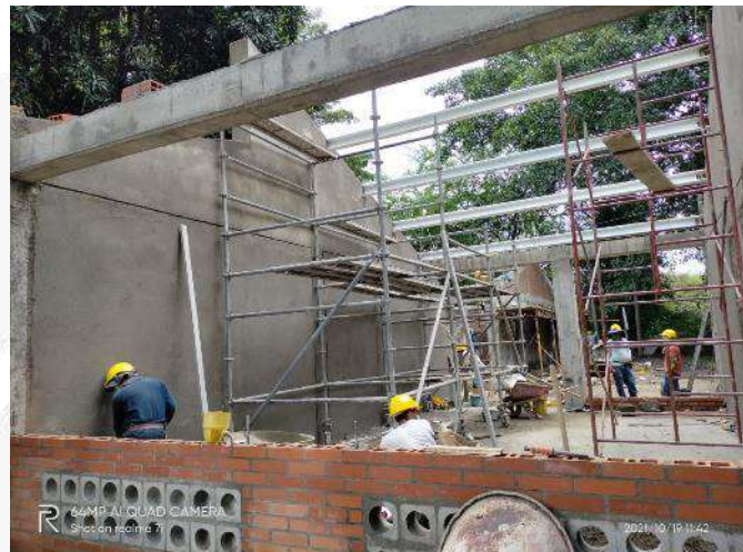
MONTAJE DE ESTRUCTURA METALICA BLOQUE 13
