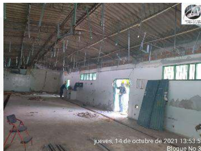
DESMANTELAMIENTO DE PUERTAS, VENTANAS Y CUBIERTA
