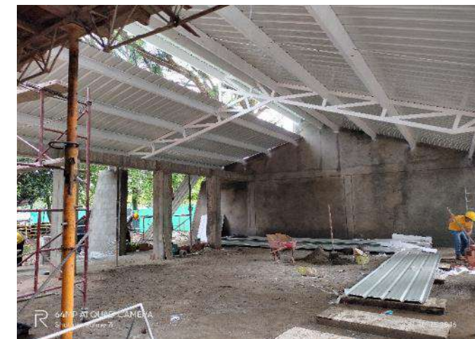
MONTAJE ESTRUCTURA Y CUBIERTA METALICA BLOQUE 12
