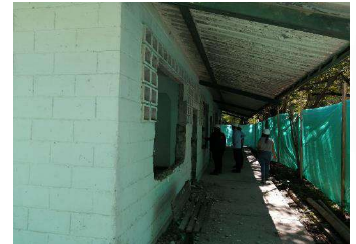
DESMANTELAMIENTO DE PUERTAS Y VENTANAS
