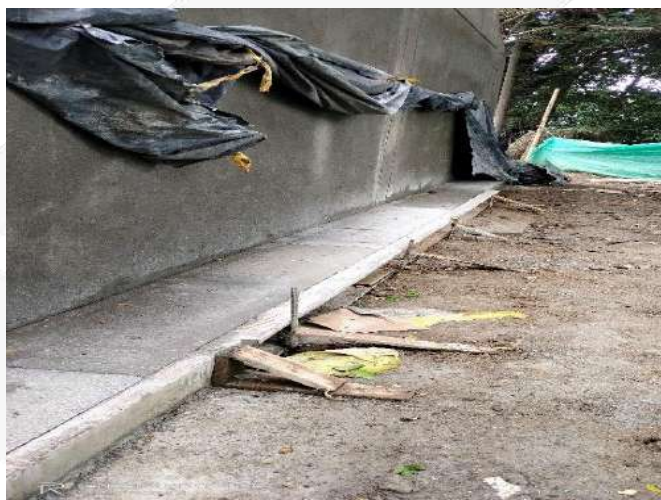
CONSTRUCCION DE ANDEN PERIMETRAL CONFINADO
