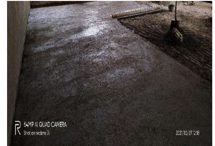
CONSTRUCCION ALISTADO SOBRE PLACA CONTRAPISO
