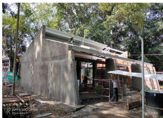
INSTALACION CUBIERTA METÁLICA CON AISLAMIENTO (TIPO SÁNDWICH) – BLOQUE 12
