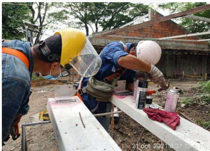
PRUEBAS DE TINTE A LA ESTRUCTURA METALICA
