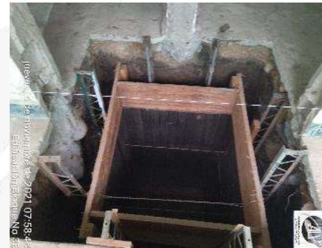
ENCOFRADO PARA CONCRETO CICLOPEO CIMENTACION
