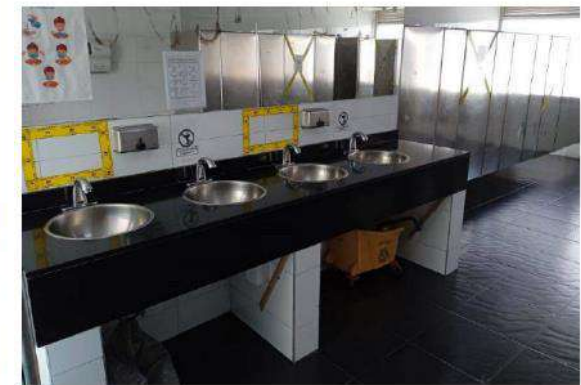
Ilustración 64 | Baños tercer piso
