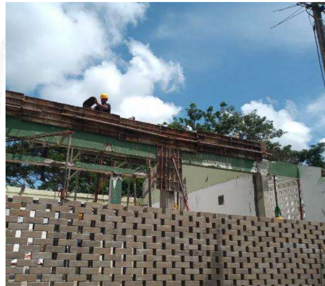
armado de vigas dormitorio 5
