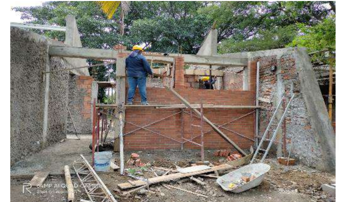
CONSTRUCCION MAMPOSTERIA EN LADRILLO A LA VISTA
