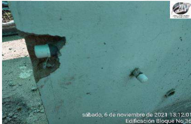
SUSPENSION DE RED HIDRAULICA
