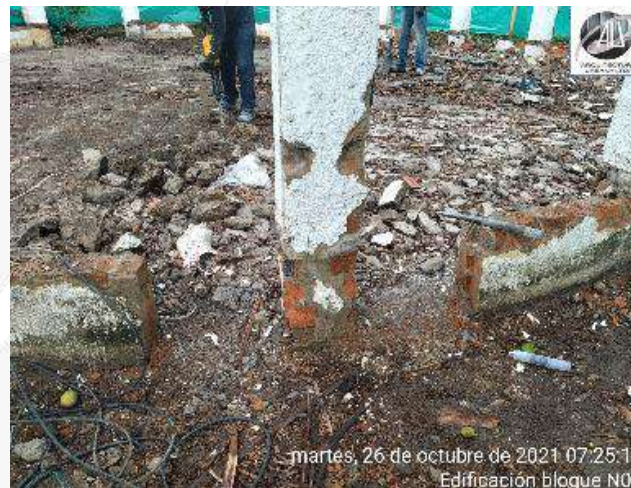
CORTES Y DEMOLICION MUROS EXISTENTES
