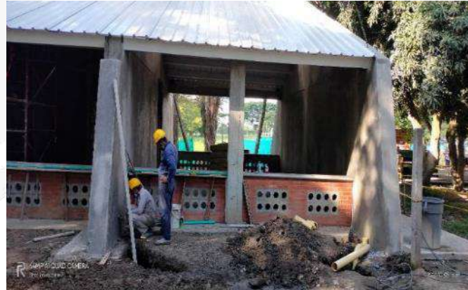
CONSTRUCCION ALFAGIAS EN CONCRETO
