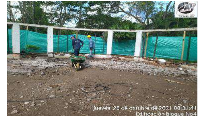
CARGUE Y RETIRO DE ESCOMBROS
