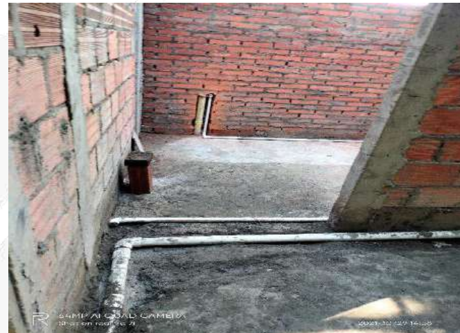
INSTALACION TUBERIA HIDRAULICA
