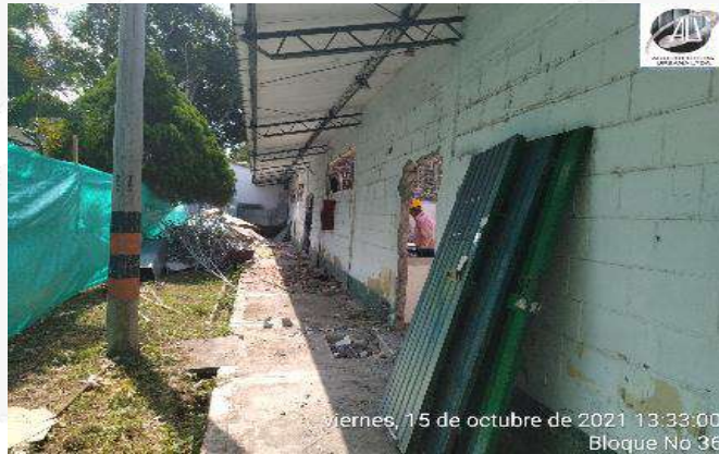
DESMANTELAMIENTO DE PUERTAS Y VENTANAS
