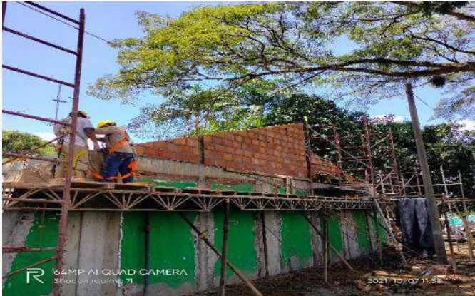
CONSTRUCCION MAMPOSTERIA FACHADA
