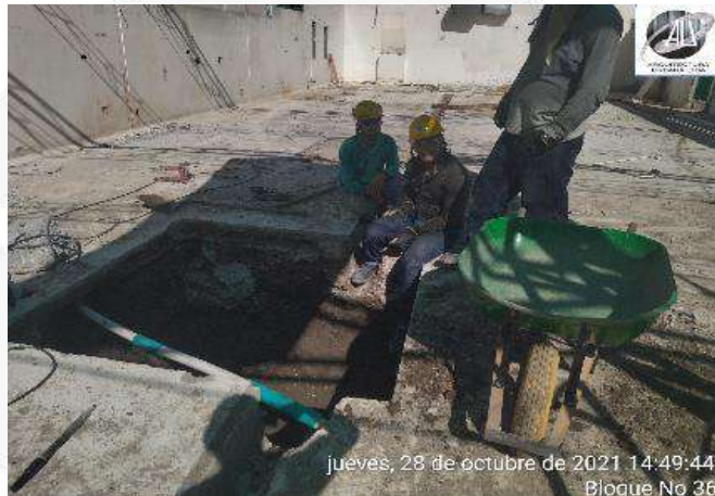
EXCAVACION MANUAL PARA CIMENTACION
