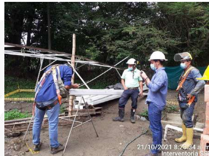
PRUEBAS DE TINTE A LA ESTRUCTURA METALICA
