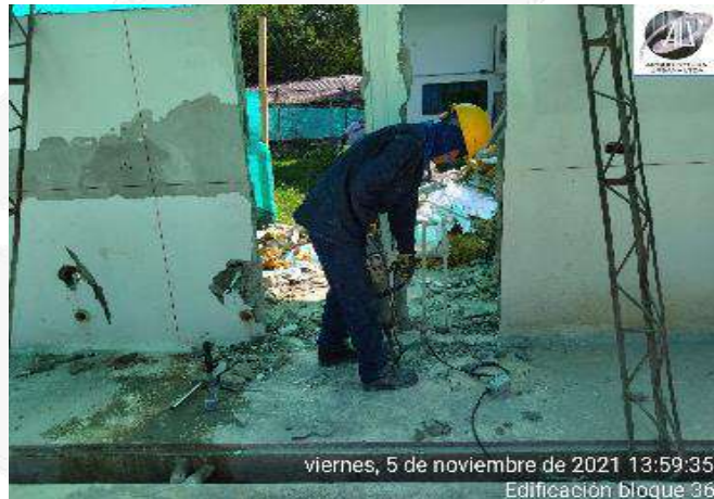
DEMOLICION MUROS Y PISOS
