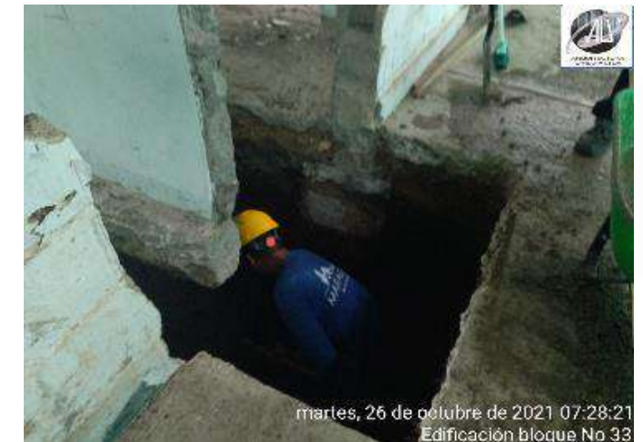
EXCAVACION MANUAL CIMENTACION
