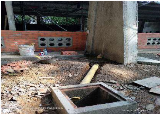
CONSTRUCCION CAJA E INSTALACION TUBERIA BAJANTES
