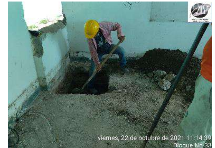
EXCAVACION PARA ZAPATAS
