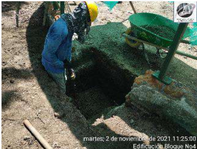
EXCAVACION MANUAL PARA CIMENTACION
