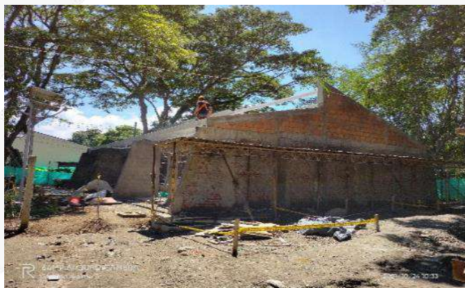
CONSTRUCCION MAMPOSTERIA FACHADA
