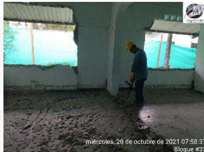
DEMOLICION DE PISOS
