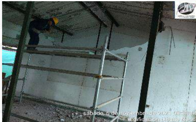
DEMOLICION MURO INTERNO EXISTENTE
