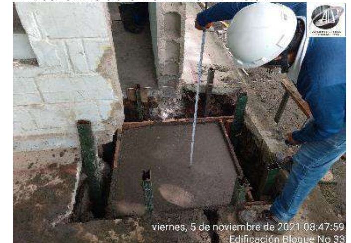
VERIFICACION DE NIVELES PARA CONSTRUCCION DE ZAPATAS
