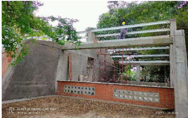
MONTAJE ESTRUCTURA METALICA SEGÚN DISEÑOS – BLOQUE 13
