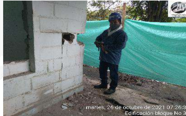
CORTE Y DEMOLICION DE MUROS EXISTENTES
