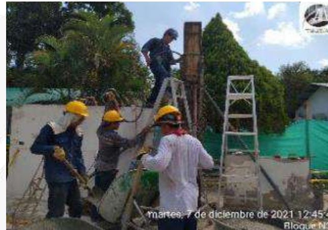
CONSTRUCCION DE COLUMNAS
