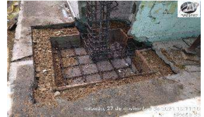
ARMADO PARA CONSTRUCCION ZAPATA DE CIMENTACION SUPERFICIAL
