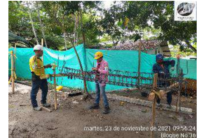
ARMADO ACERO DE REFUERZO VIGA AEREA
