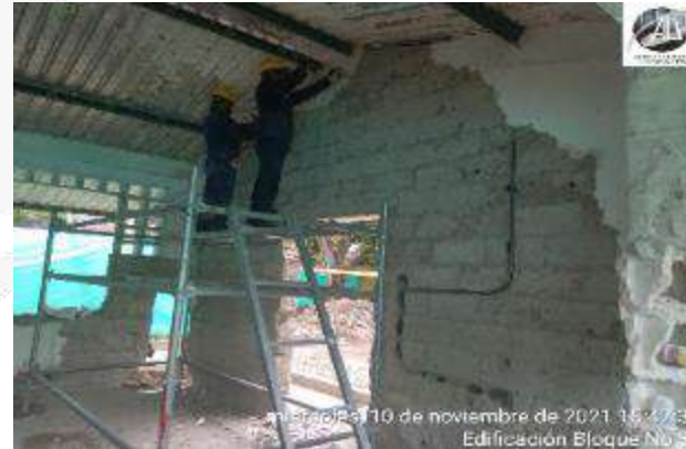
CORTE Y ESCARIFICADO PAÑETE EXISTENTE MUROS INTERNOS
