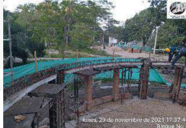
ARMADO DE ACERO DE REFUERZO VIGA AEREA
