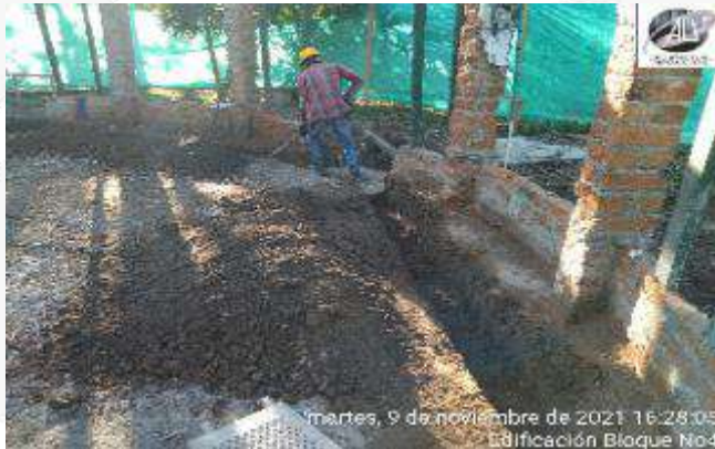
EXCAVACION MANUAL PARA CONSTRUCCION DE VIGA DE AMARRE
