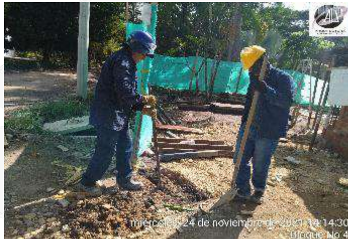
EXCAVACION MECANICA CONSTRUCCION CAJAS
