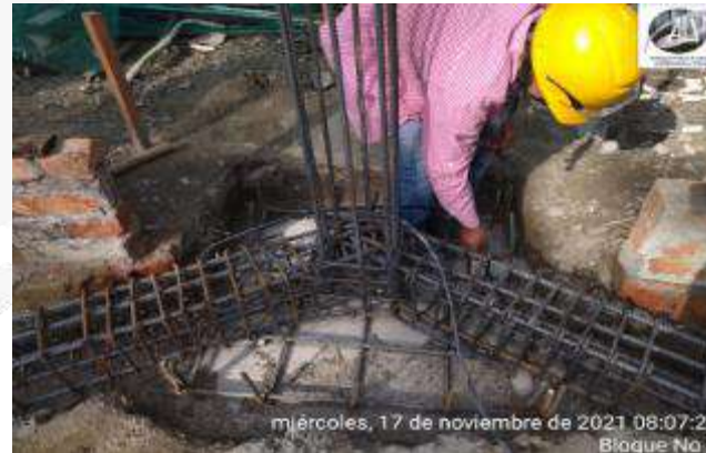
ARMADO DE ACERO DE REFUERZO ZAPATAS, VIGAS Y COLUMNAS
