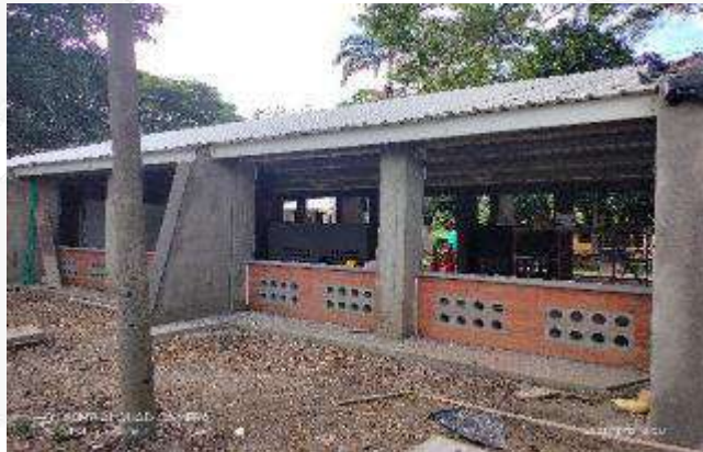
CONSTRUCCION DE ALFAJIAS EN COCNETO
