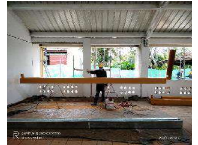
ACABADOS Y PINTURA DE CANAL AGUAS LLUVIAS
