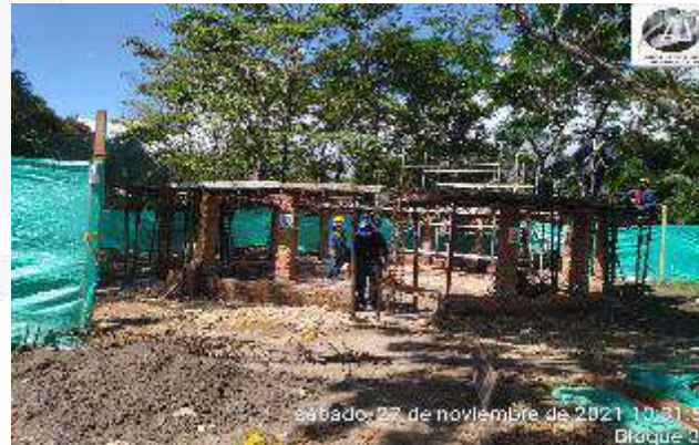
ARMADO DE ACERO DE REFUERZO COLUMNAS Y VIGA AEREA
