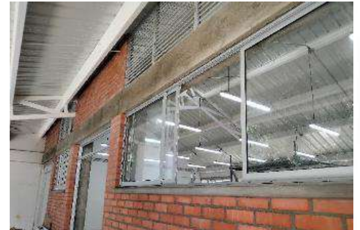
LIMPIEZA, LAVADO E IMPERMEABILIZACION DE FACHADAS
