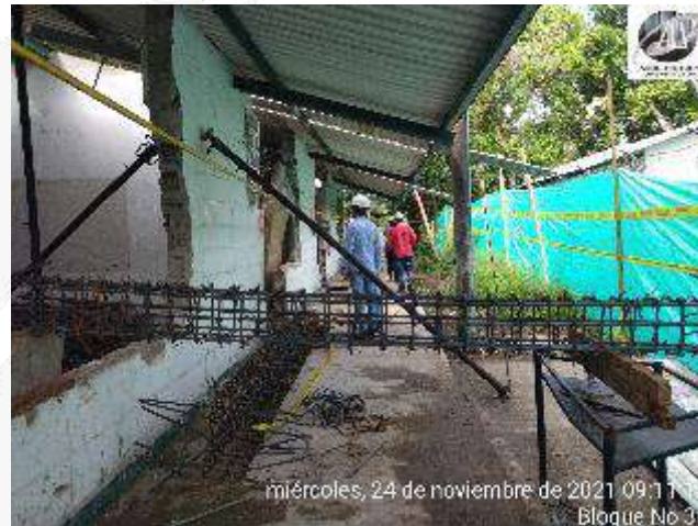
ARMADO DE CANASTA DE ACERO REFURZO VIGA DE AMARRE
