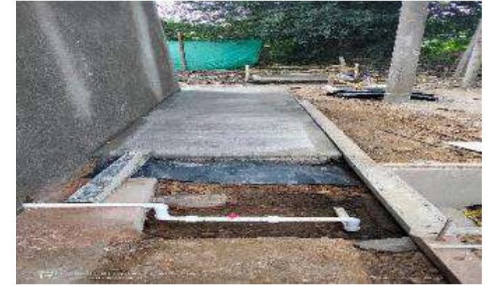
INSTALACION TUBERIA HIDRAULICA
