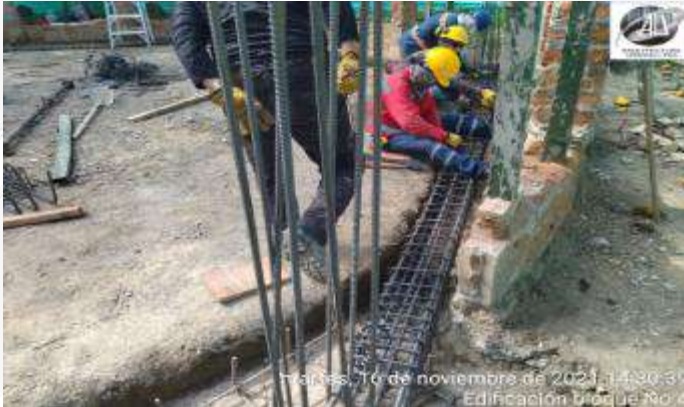
ARMADO DE ACERO DE REFUERZO ZAPATAS, VIGAS Y COLUMNAS
