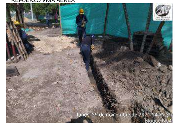
EXCAVACION MANUAL PARA RED SANITARIA
