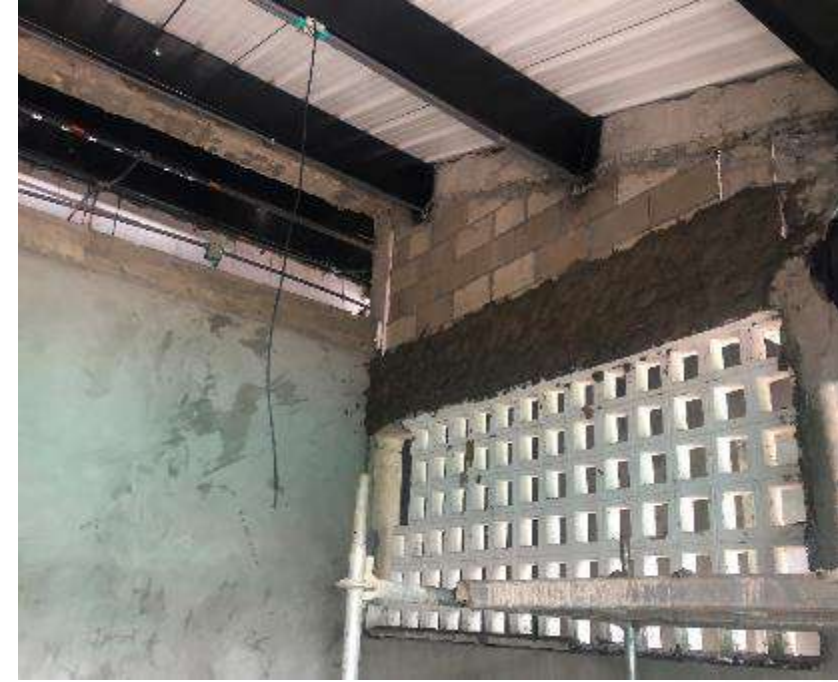
estructura metálica e instalaciones eléctricas
