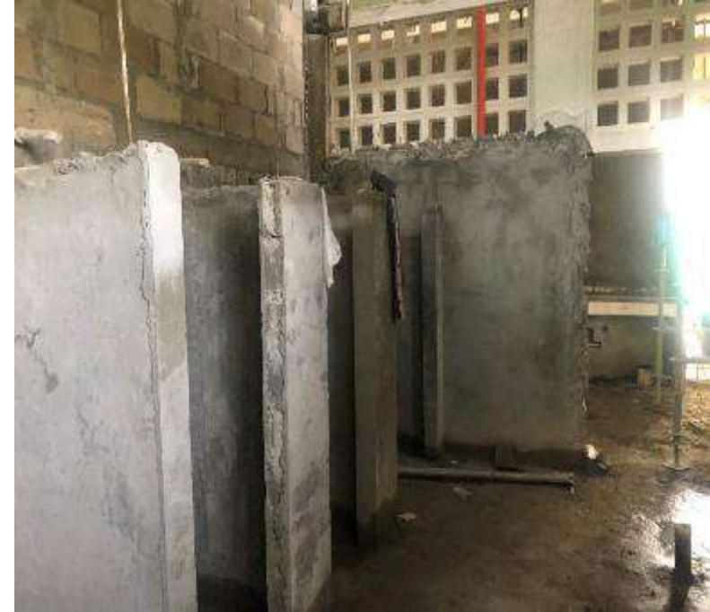
modulo duchas sin enchape
