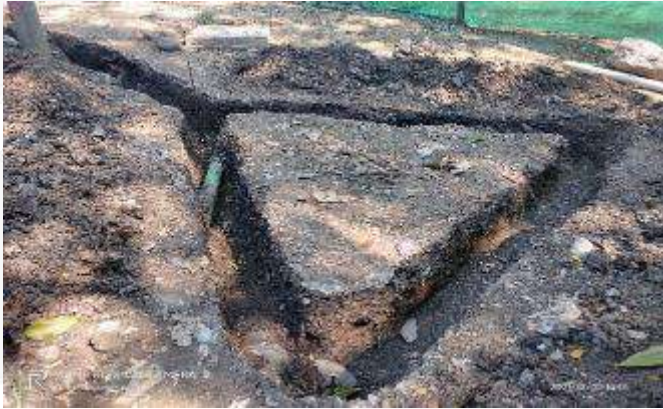
EXCAVACION MANUAL PARA INSTALACION DE RED DE APANTALLAMIENTO
