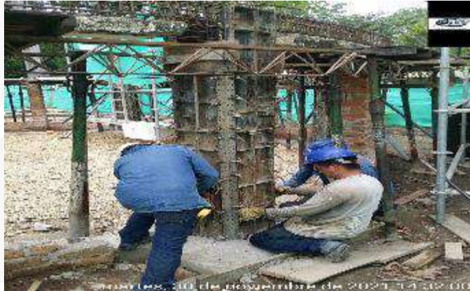
ENCOFRADO Y CONSTRUCCION DE COLUMNAS
