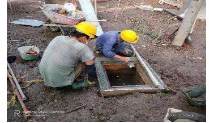
CONSTRUCCION CAJAS ELECTRICAS
