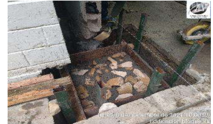
CONSTRUCCION CONCRETO CICLOPEO CIMENTACION SUPERFICIAL
