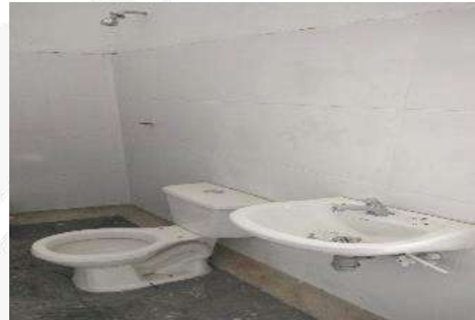
INSTALACION DE APARATOS SANITARIOS, ACCESORIOS Y PUESTA EN FUNCIONAMIENTO
