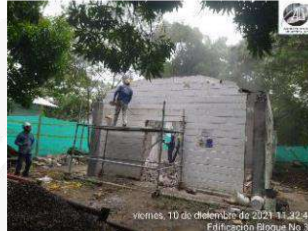
ACABADO DE COLUMNAS Y DEMOLICION DE ESTRUCTURA CUBIERTA
