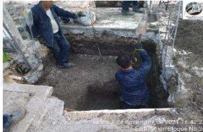
CORTE Y EXCAVACION MANUAL PARA CIMENTACION
