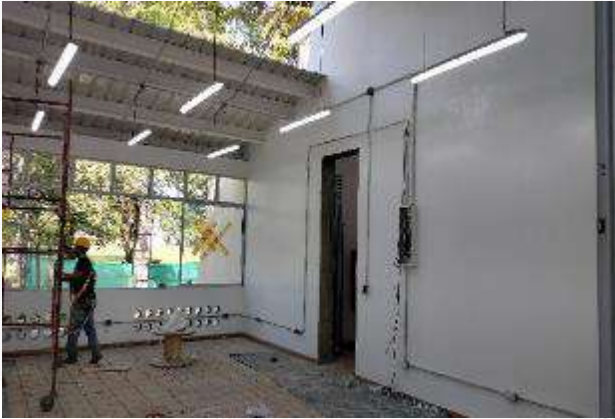
INSTALACION Y VERIFICACION DE FUNCIONAMIENTO DE LUMINARIAS
