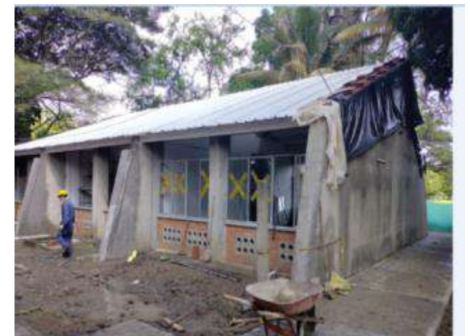
INSTALACION DE VENTANERIA EN ALUMINIO
