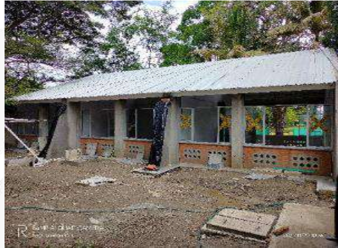
INSTALACION DE VENTANERIA EN ALUMINIO
