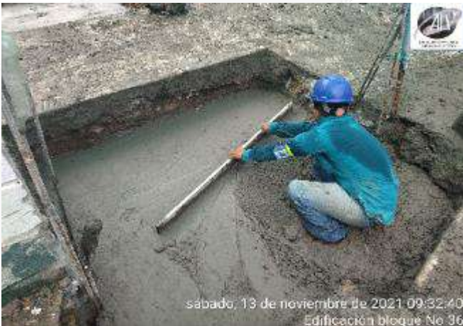
CONSTRUCCION DE CONCRETO CICLOPEO CIMENTACION
