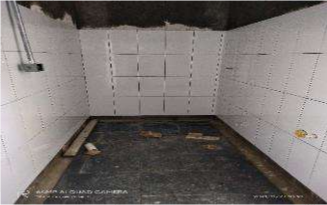
ENCHAPES PISOS Y MUROS BATERIA SANITARIA
