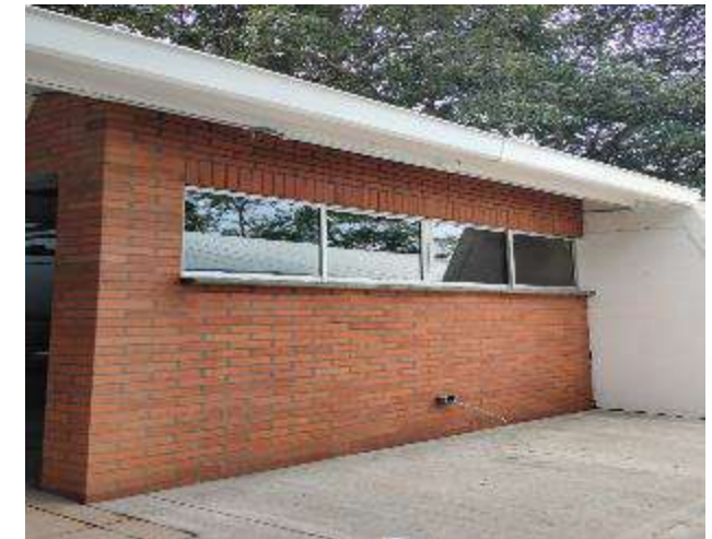
INSTALACION PUNTO ELECTRICO LUMINARIA EXTERNA
