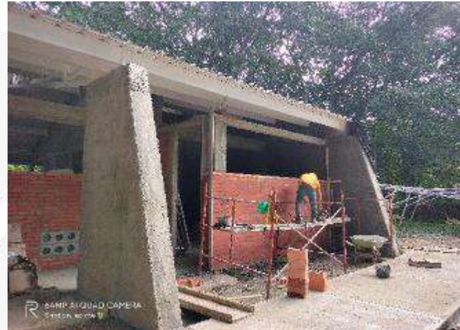
CONSTRUCCION DE MAMPOSTERIA FACHADA EN LADRILLO PRENSADO
