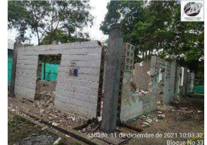
CONSTRCCION DE CIMENTACION SUPERFICIAL Y COLUMNAS EN CONCRETO
