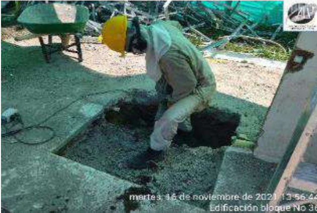
CORTE Y DEMOLICION MURO CICLOPEO EXISTENTE
