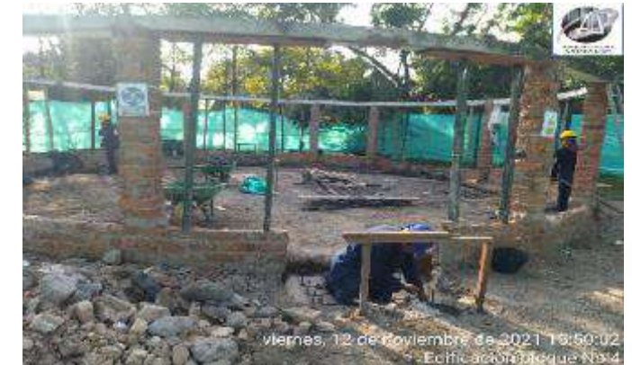
ARMADO ACERO DE REFUERZO PARA ZAPATA
