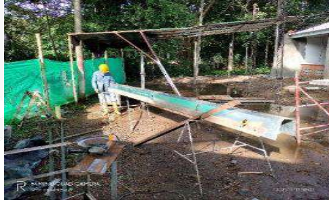
FABRICACION CANAL METALICA AGUAS LLUVIAS BLOQUE 12
