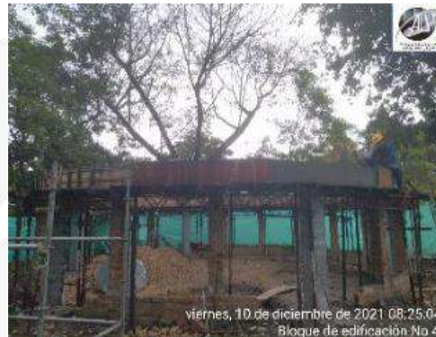
DESENCOFRADO VIGA AEREA
