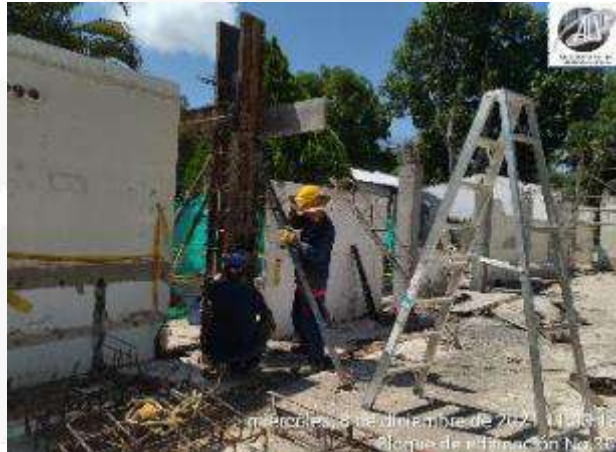
ENCOFRADO DE COLUMNAS
