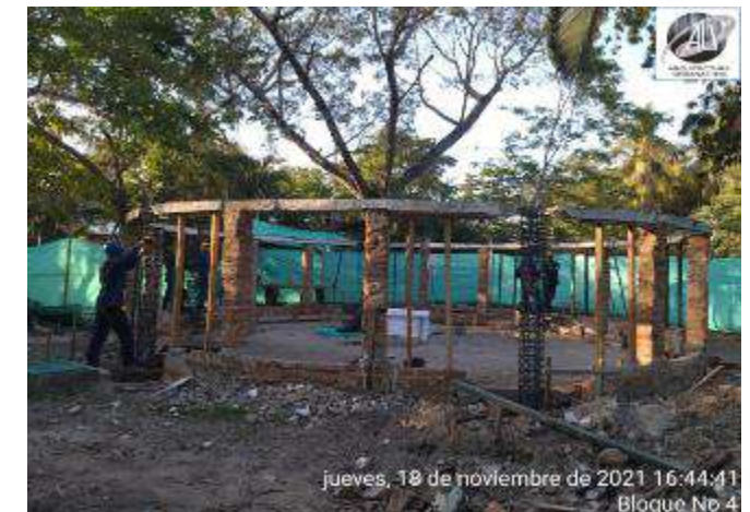
AMARRE DE ACERO DE REFURZO COLUMNAS
