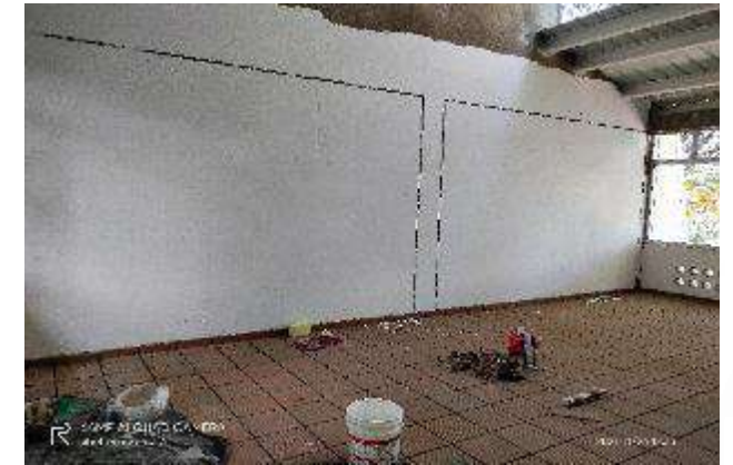
INSTALACION GUARDAESCOBAS AREA INTERNA
