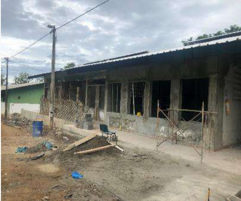
placa exterior de acceso
