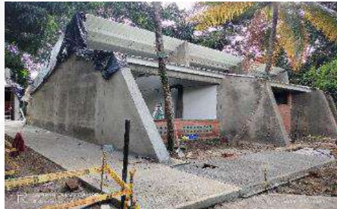
CONSTRUCCION DE ANDEN PERIMETRAL
