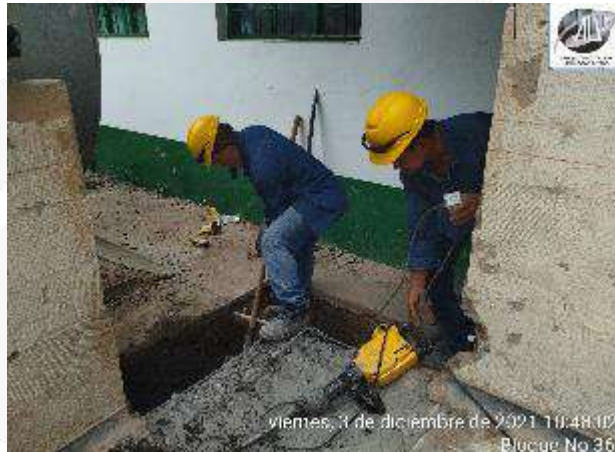
CONSTRUCCION CONCRETO CICLOPEO PARA MEJORAMIENTO CIMENTACION
