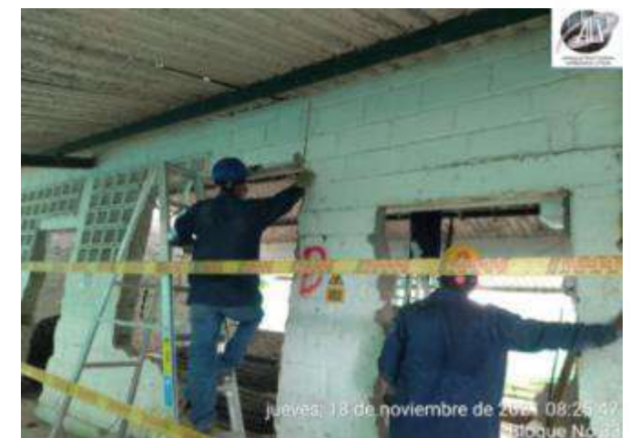
DEMOLICION DE DINTELES DE PUERTAS Y VENTANAS
