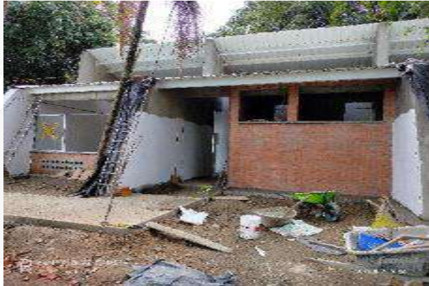
INSTALACION ESTRUCTURA METALICA PARA CANAL DE AGUAS LLUVIAS
