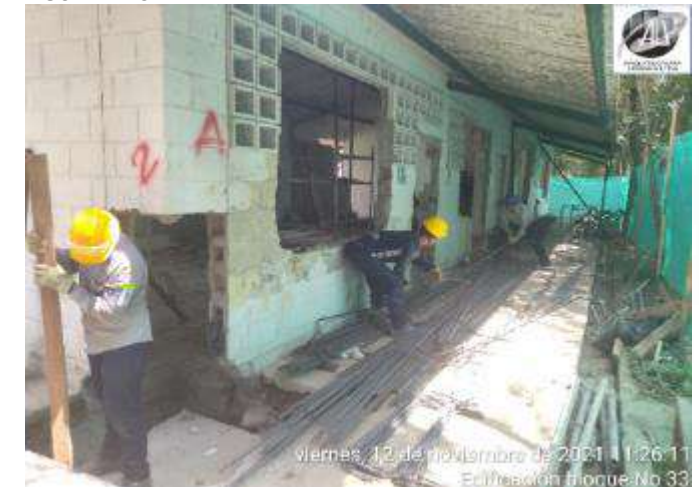
CONSTRUCCION CONCRETO CICLOPEO CIMENTACION SUPERFICIAL
