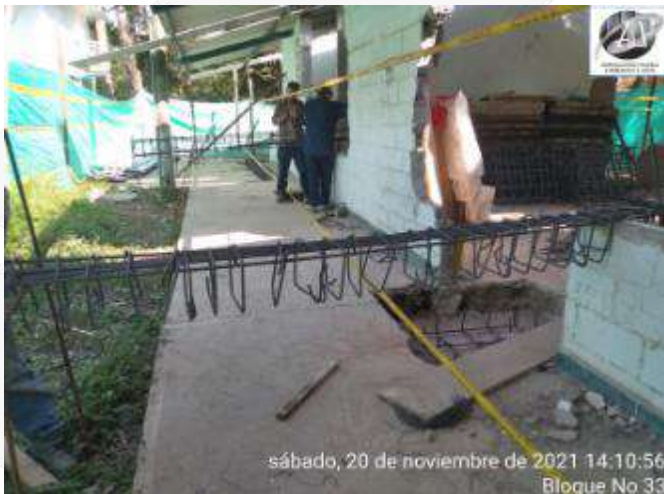
ARMADO ACERO DE REFUERZO VIGAS DE AMARRE
