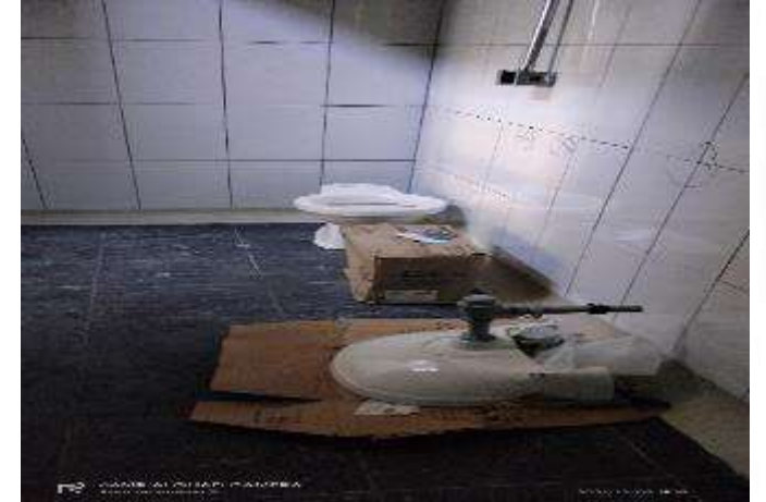
INSTALACION DE APARATOS SANITARIOS Y ACCESORIOS
