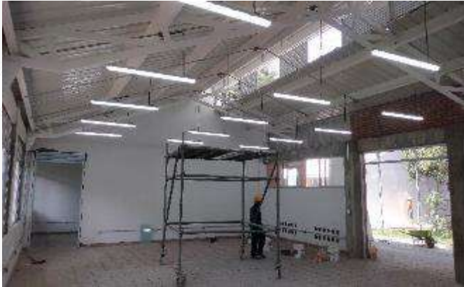
INSTALACION Y VERIFICACION DE FUNCIONAMIENTO DE LUMINARIAS
