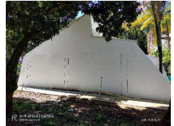
ESTUCO Y PINTURA FACHADAS LATERALES
