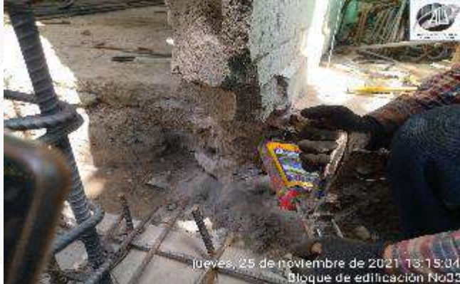
ANCLAJE ACERO DEFUERZO VIGA EXISTENTE
