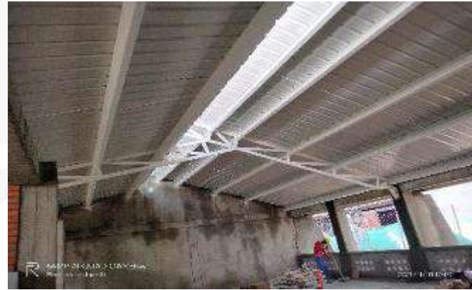
RESANE Y PINTURA ESTRUCTURA CUBIERTA METALICA BLOQUE 12
