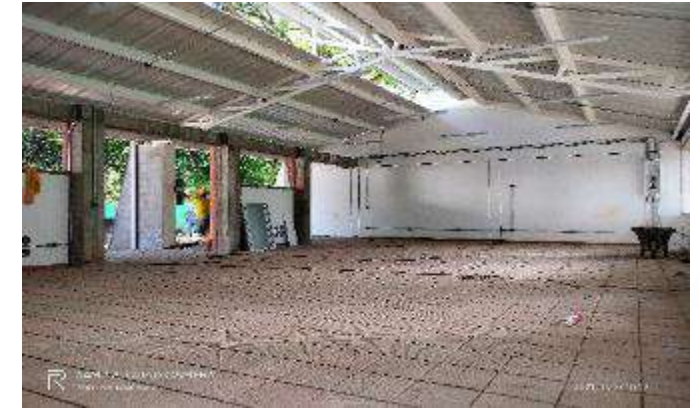
INSTALACION GUARDAESCOBAS AREAS INTERNAS
