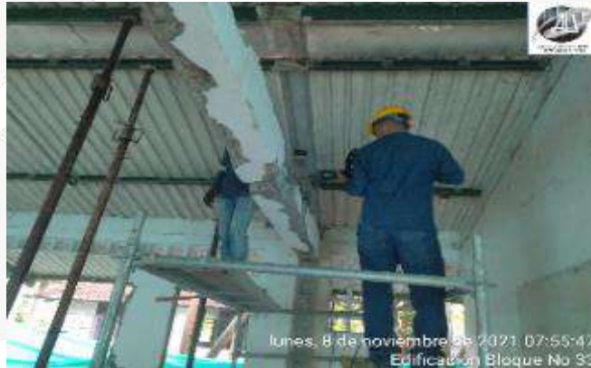
DEMOLICION MURO INTERNO EXISTENTE
