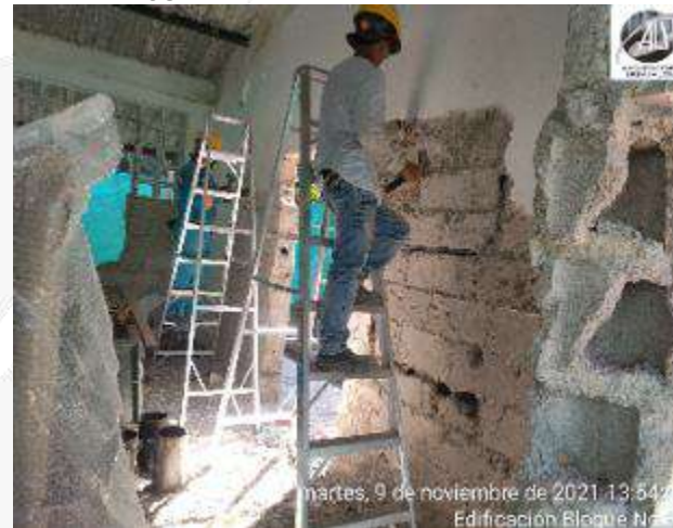
REGATA PARA RETIRO DE TUBERIA ELECTRICA EXISTENTE
