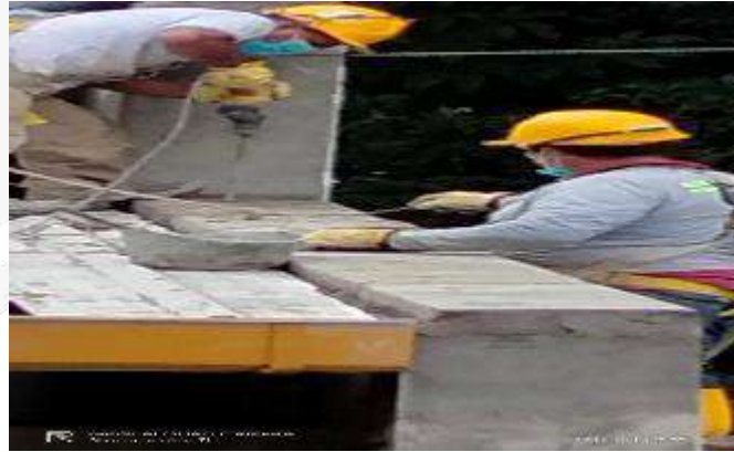
FABRICACION E INSTALACION FALNCHES METALICO CUBIERTA Y MUROS LATERALES BLOQUE 12
