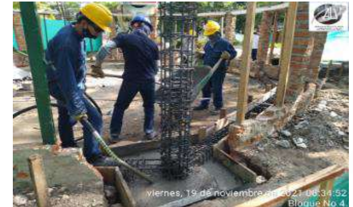
CONSTRUCCION DE ZAPATAS DE CIMENTACION SUPERFICIAL
