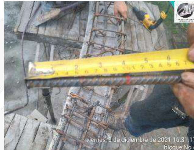
LIBERACION DE ACERO DE REFUERZO VIGA AEREA
