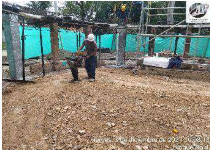
RELLENO Y CONFORMACION DE AREA INTERNA BLOQUE 4
