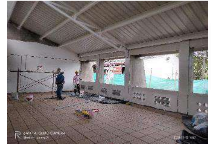
INSTALACION ENCHAPE PISOS, ESTUCO Y PINTURA SOBRE MUROS INTERNOS
