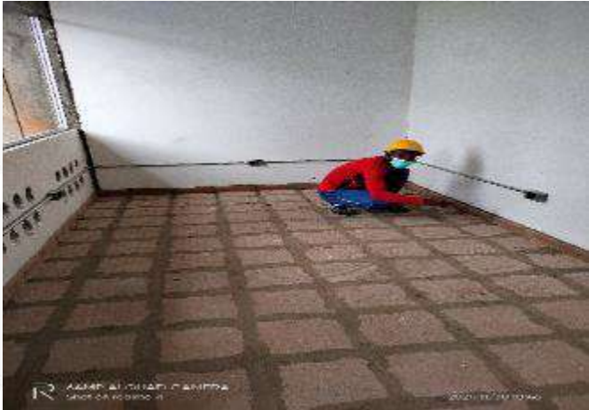
APLICACIÓN DE BOQUILLA ENCHAPE PISOS
