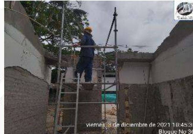
ESCARIFICADO Y DEMOLICION PAÑETE MUROS INTERNOS
