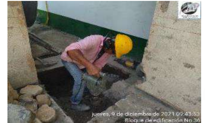
CORTE Y DEMOLICION PLACA CONTRAPISO EXISTENTE
