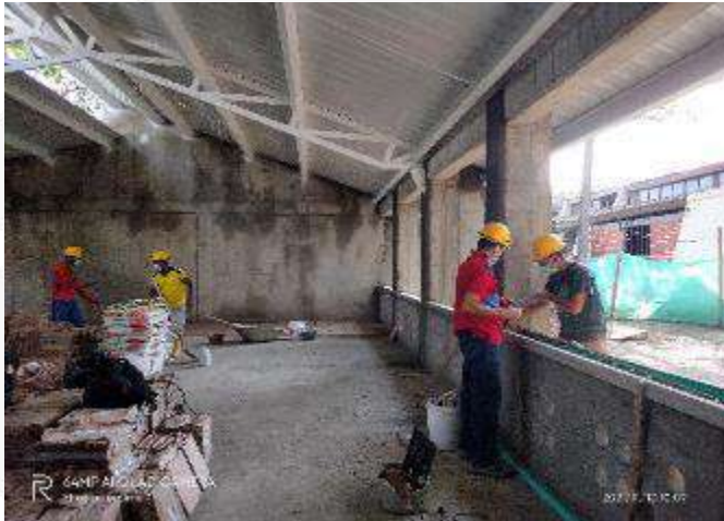
CONSTRUCCION ALFAJA EN CONCRETO SOBRE VENTANAS FACHADA PRINCIPAL
