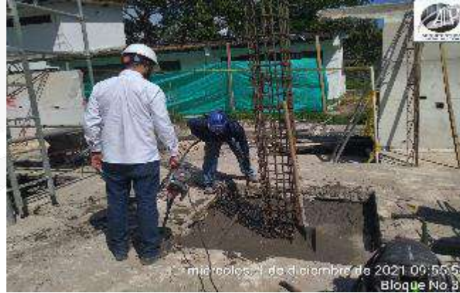
CONSTRUCCION DE ZAPATAS SUPERFICIALES Y ARMADO ACERO DE REFUERZO COLUMNAS
