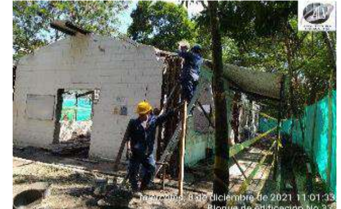
CONSTRUCCION DE COLUMNAS EN CONCRETO DE 3000 PSI.
