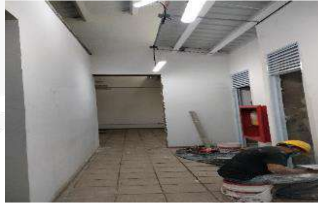
INSTALACION DE PUERTAS INTERNAS METALICAS Y GABINETE DE RED CONTRA INCENDIOS
