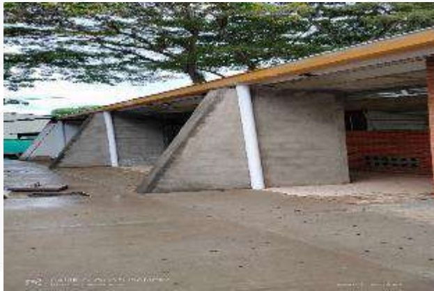
INSTALACION CANAL METALICA DE AGUAS LLUVIAS
