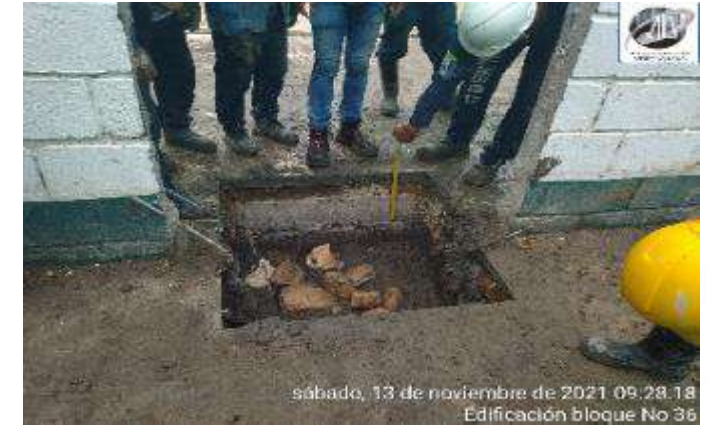
CONSTRUCCION DE CONCRETO CICLOPEO CIMENTACION
