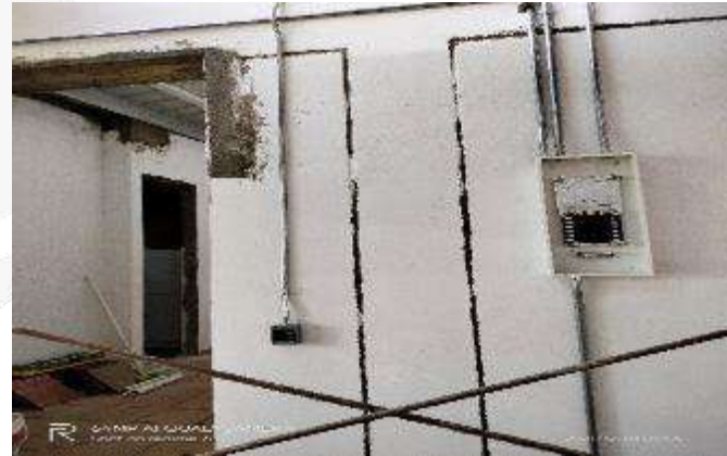
INSTALACION TABLEROS ELECTRICOS BLOQUE 13
