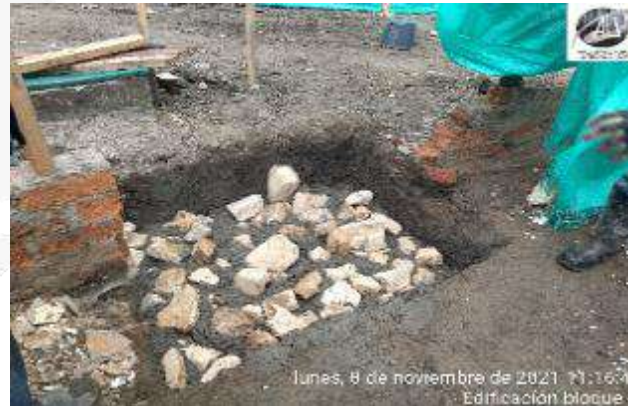
CONSTRUCCION DE CONCRETO CICLOPEO PARA CIMENTACION SUPERFICIAL
