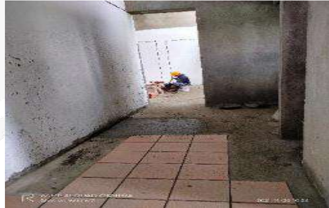
INSTALACION DE ENCHAPE PISO AREAS BLOQUE 13
