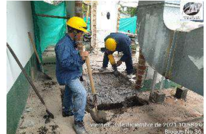
DEMOLICION CONCRETO CICLOPEO EXISTENTE
