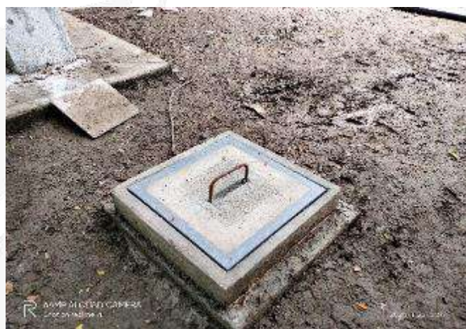
CONSTRUCCION DE CAJAS DE INSPECCION TERMINADAS CON TAPA
