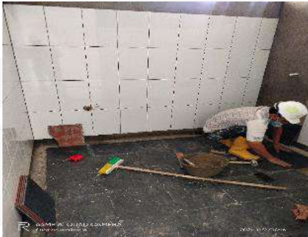
INSTALACION ENCHAFE PISOS Y MUROS BATERIA SANITARIA
