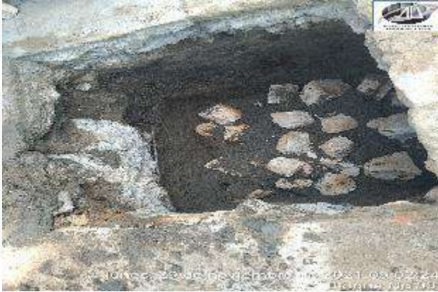
CONSTRUCCION CONCRETO CICLOPEO PARA MEJORAMIENTO CIMENTACION
