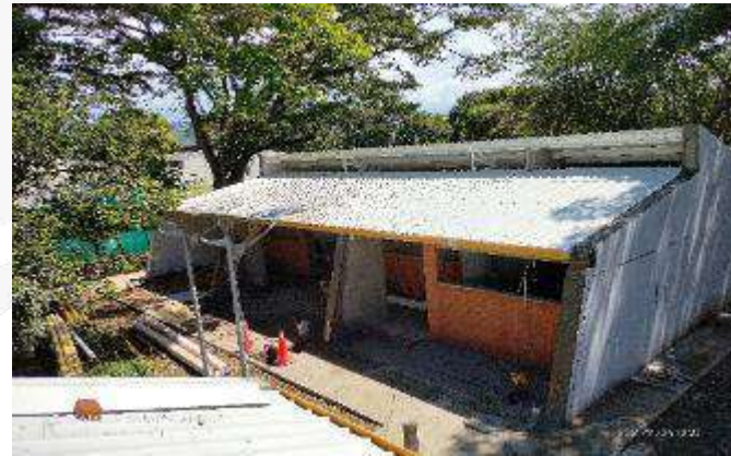
CONSTRUCCION ANDEN DE CIRCULACION EAS BLOQUE 13
