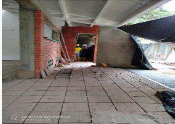
INSTALACION ENCHAPE ANDEN FAHADA Y CONSTRUCCION ANDEN CIRCULACION Y APROXIMACION BLOQUE 12
