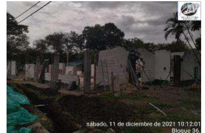
ACABADO Y FRAGUADO DE COLUMNAS EN CONCRETO
