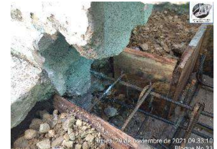
ANCLAJES Y ARMADO ACERO DE REFUERZO VIGA DE AMARRE
