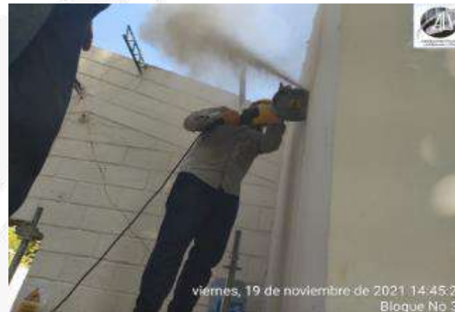
CORTE Y DEMOLICION MUROS EXISTENTES
