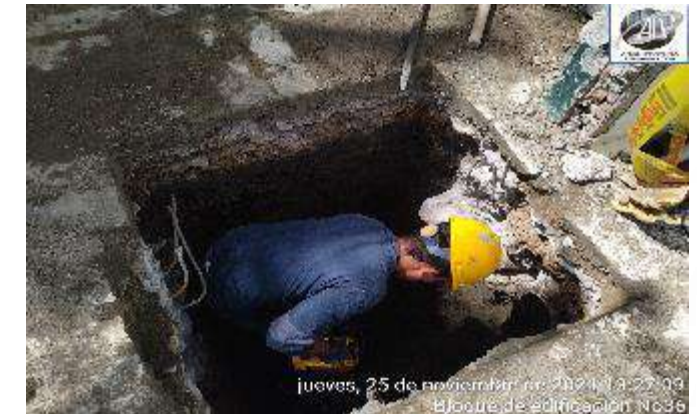
EXCAVACION MANUAL PARA CONSTRUCCION DE CICLOPEOS Y ZAPATAS SUPERFICIALES
