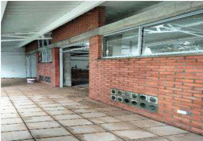
EMBOQUILLADO Y FRAGUADO DE ENCHAPE PISOS
