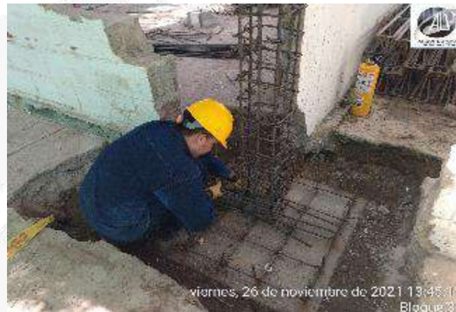
ARMADO ACERO DE REFUERZO ZAPATA Y COLUMNA
