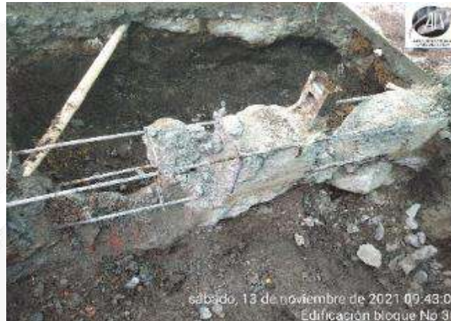
DEMOLICION DE VIGA EXISTENTE
