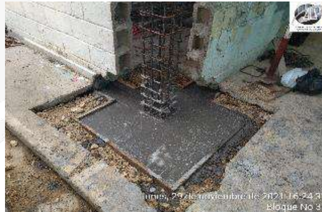
CONSTRUCCION DE ZAPATAS SUPERFICIALES BLOQUE 33
