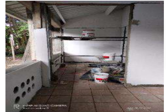
ESTUCO Y PINTURA SOBRE MUROS INTERNOS
