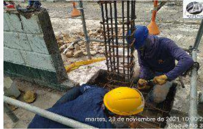
ARMADO ACERO DE REFUERZO ZAPATA Y COLUMNA
