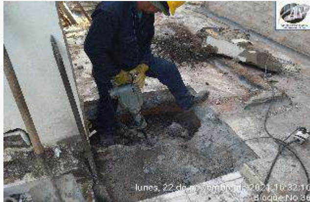
CORTE Y DEMOLICION MURO CIMENTACION CICLOPEO EXISTENTE
