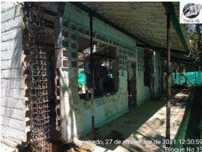
ARMADO ACERO DE REFUERZO COLUMNAS
