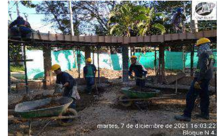
EXCAAVCION, NIVELACION Y RELLENO CON RECEBO PARA ADECUAION AREA PARA PLACA CONTRAPISO
