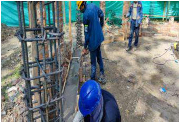
CONSTRUCION VIGA DE AMARRE
