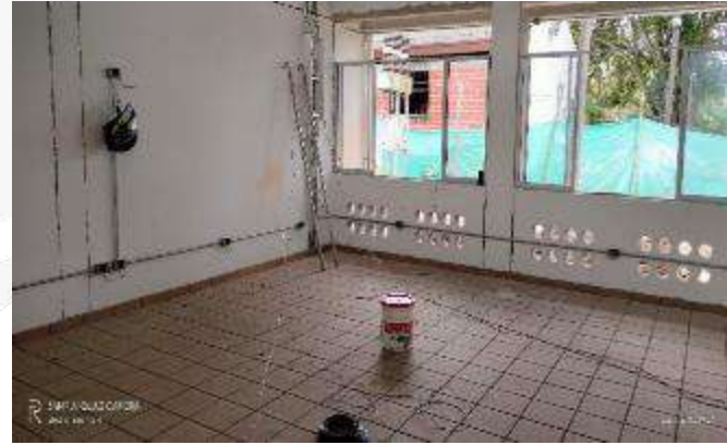
INSTALACION DE VENTANERIA EN ALUMINIO
