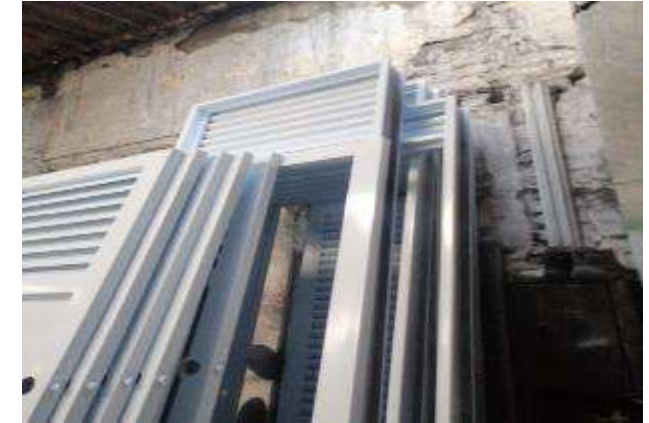
ALISTAMIENTO DE PUERTAS METALICAS PARA OBRA
