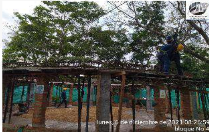
ARMADO ACERO DE REFUERZO VIGA AEREA
