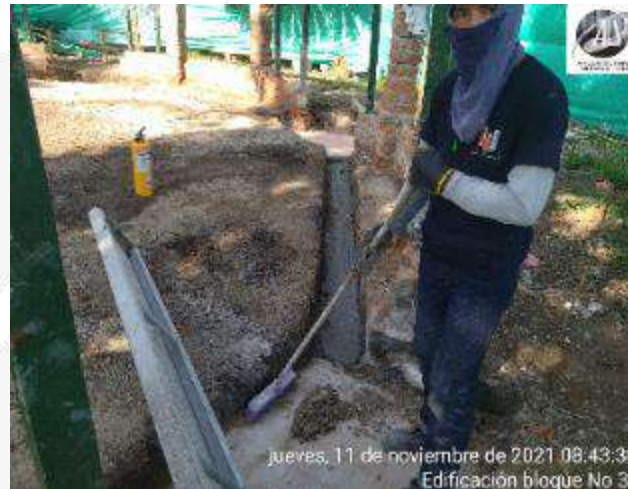
FUNDIDA CONCRETO DE LIMPIEZA VIGA DE AMARRE
