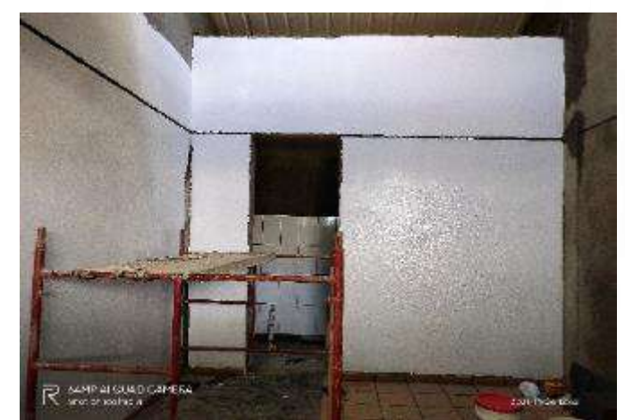
ESTUCO Y PINTURA SOBRE MUROS INTERNOS
