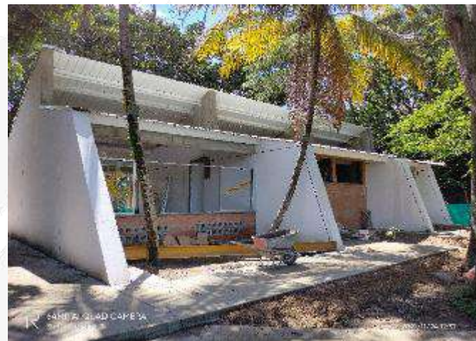
INSTALACION DE VENTANERIA EN ALUMINIO
