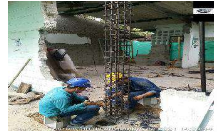
ARMADO ACERO DE REFUERZO PARA CONSTRUCCION ZAPATA DE CIMENTACION SUPERFICIAL Y COLUMNAS
