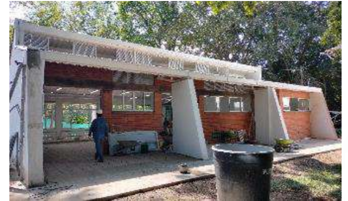
SUMINISTRO E INSTALACION VENTANERIA Y PERSINAS EN ALUMINIIO SOBRE FACHADAS
