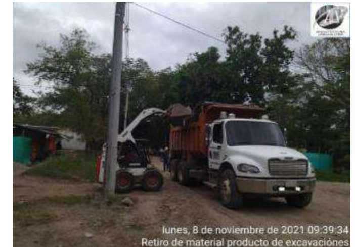
CARGUE Y RETIRO ESCOMBROS
