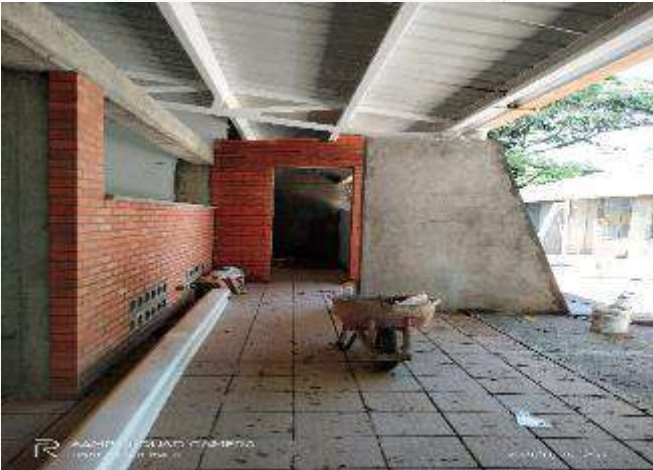
INSTALACION DE ENCHAPES PISO ANDEN DE ACCESO BLOQUE 12
