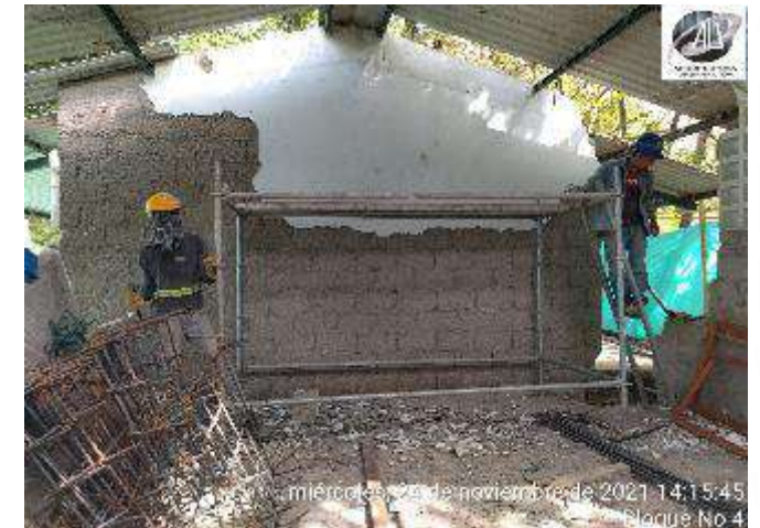
ESCARIFICADO Y DEMOLICION DE PAÑETE MUROS INTERNOS
