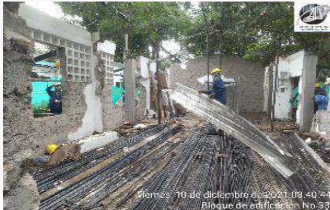
SE REALIZA DESMONTE DE CUBIERTA Y ESTRUCTURA METALICA EXISTENTE
