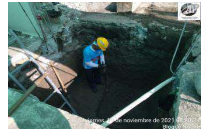
EXCAVACION MANUAL PARA CONSTRUCCION DE CICLOPEOS Y ZAPATAS SUPERFICIALES CENTRALES DEL BLOQUE
