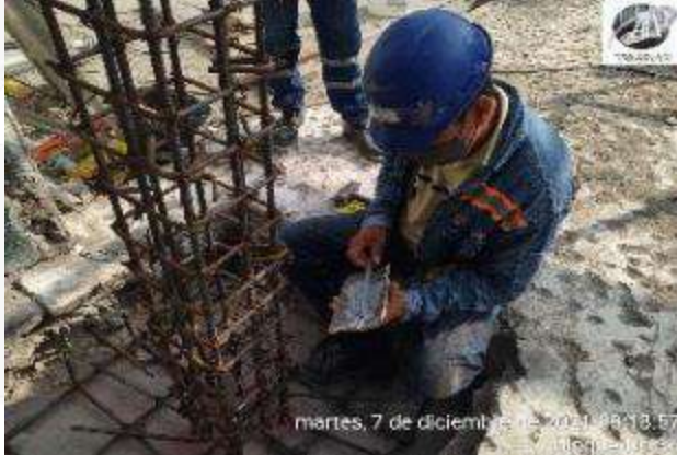
ARMADO ACERO DE REFUERZO ZAPATAS Y COLUMNAS
