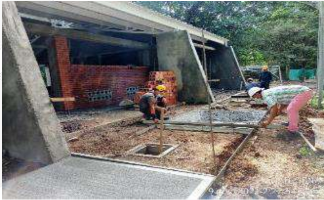
CONSTRUCCION DE ANDEN PERIMETRAL
