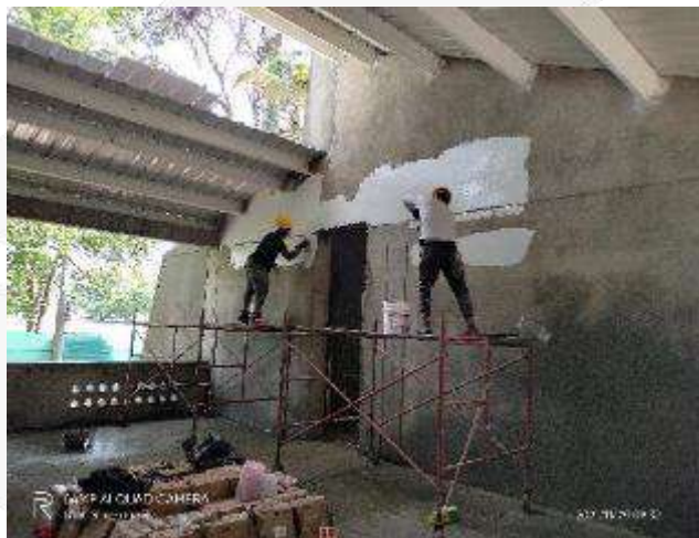
APLICACIÓN DE ESTUCO Y PINTURA SOBRE MUROS INTERNOS
