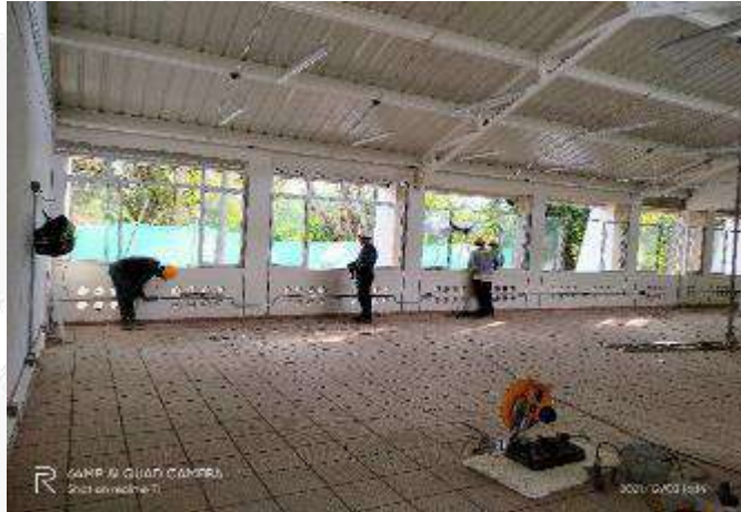
INSTALACION DE LUMINARIAS COLGANTES BLOQUE 12
