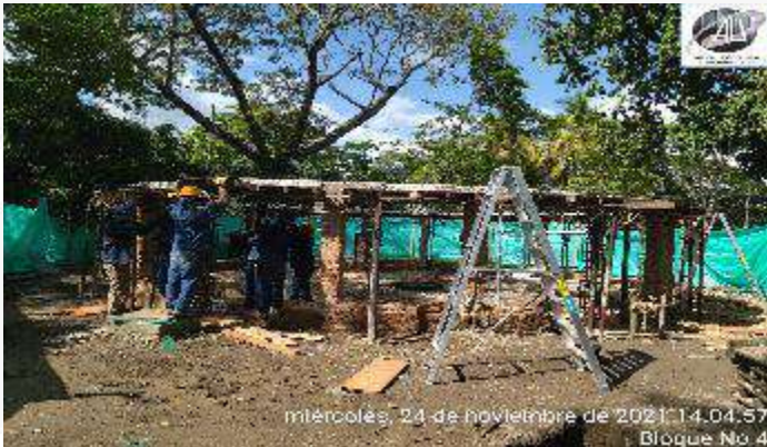
ARMADO DE ESTRUCTURA SOPORTE PARA CONSTRUCCION VIGA AEREA
