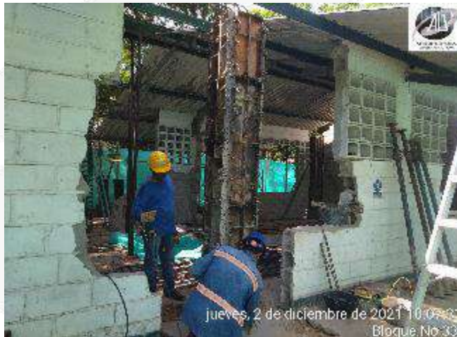
ENCOFRADO DE COLUMNAS BLOQUE 33
