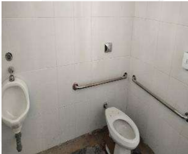
INSTALACION DE APARATO SANITARIO, ACCESORIOS Y PUESTA EN FUNCIONAMIENTO BATERIA SANITARIA PMR
