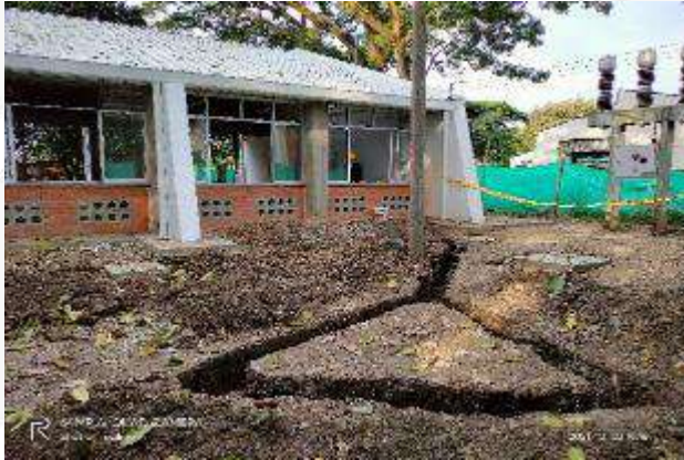
EXCAVACION MANUAL PARA INSTALACION DE RED DE APANTALLAMIENTO
