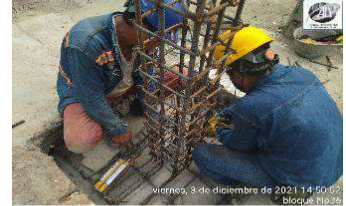
ARMADO ACERO DE REFUERZO ZAPATAS Y COLUMNAS
