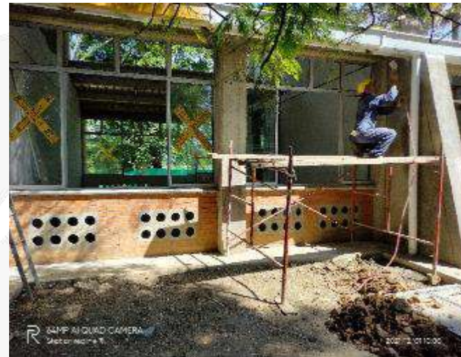
INSTALACION DE VENTANERIA EN ALUMINIO
