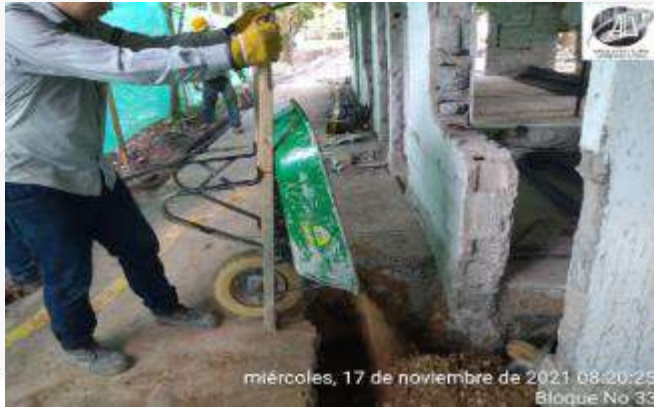
RELLENOS LATERALES CONCRETO CICLOPEO
