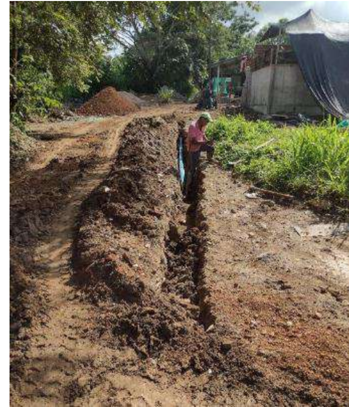
instalación tubería para hidrante
