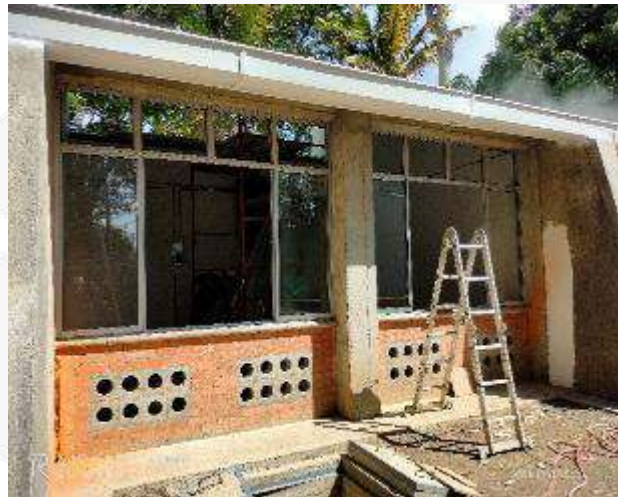
APLICACIÓN PINTURA SOBRE CANAL METALICA AGUAS LLUVIAS
