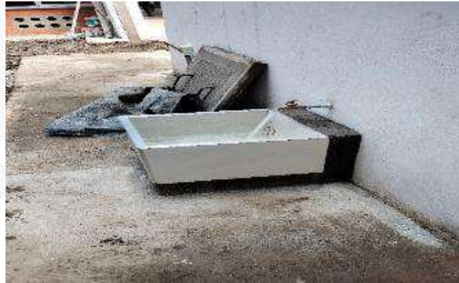
SUMINISTRO E INSTALACION DE POCETA EXTERNA
