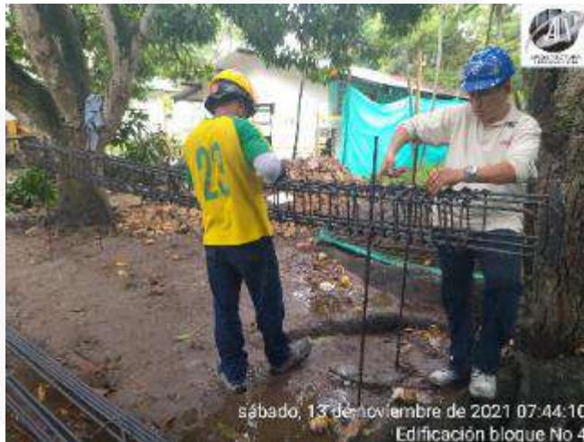
ARMADO DE PARRILLA DE REFUERZO VIGA DE AMARRE
