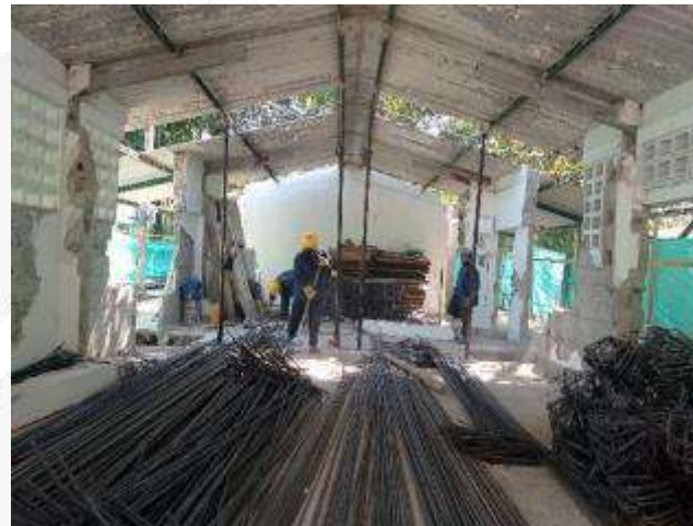
DEMOLICION DE MUROS INTERNOS Y ACOPIO DE ACERO DE REFUERZO
