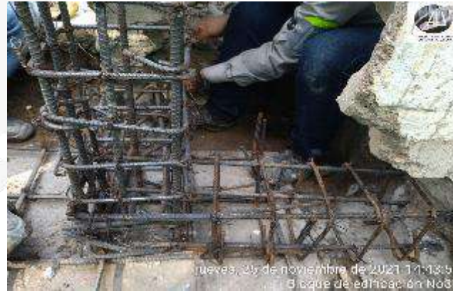
ARMADO ACERO DE REFUERZO ZAPATA Y VIGA DE AMARRE
