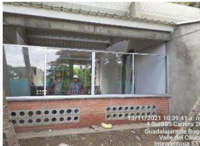
INSTALACION DE VENTANERIA EN ALUMINIO
