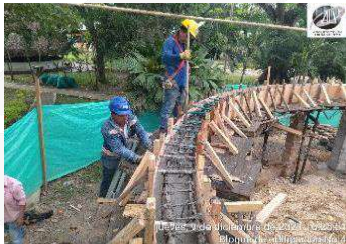
CONSTRUCCION VIGA AEREA
