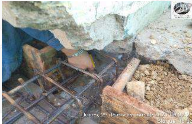
ANCLAJE ACERO DEFUERZO VIGA EXISTENTE
