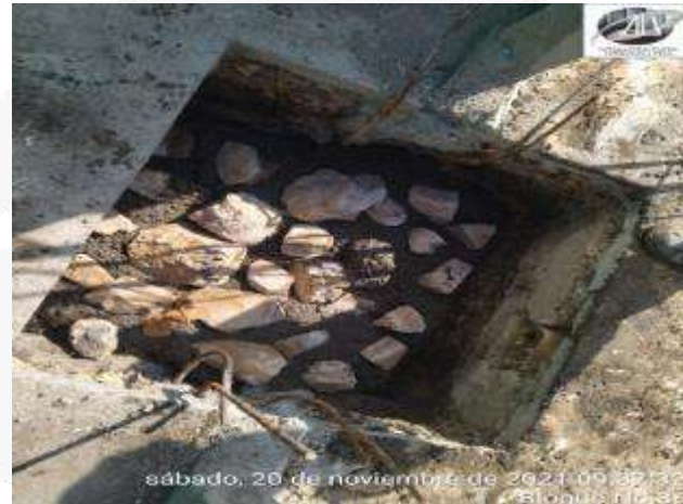
CONSTRUCCION DE CONCRETO CICLOPEO CIMENTACION
