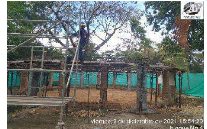
CONSTRUCCION DE COLUMNAS Y ARMADO DE ACERO DE REFUERZO VIGA AEREA
