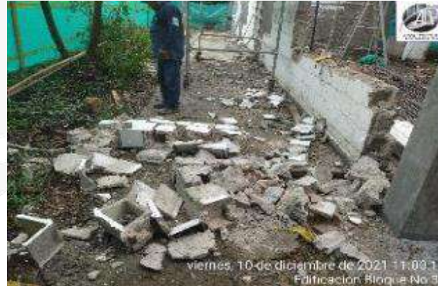
DEMOLICION DE MUROS PERIMETRALES EXISTENTES
