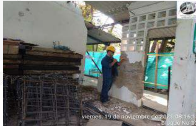
CORTE Y ESCARIFICADO PAÑETE EXISTENTE MUROS INTERNOS
