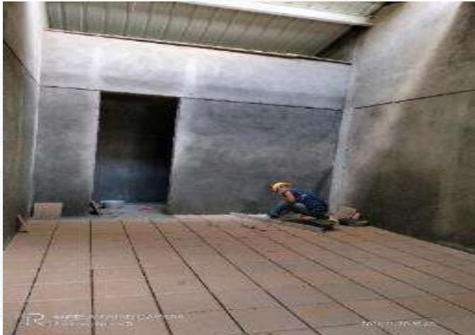
INSTALACION DE ENCHAPE PISO AREAS BLOQUE 12
