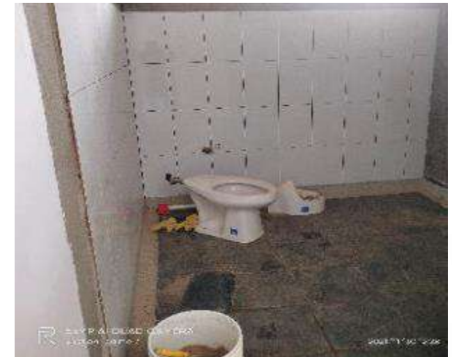
INSTALACION DE APARATOS SANITARIOS Y ACCESORIOS
