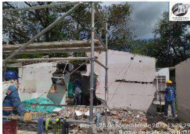
DEMOLICION MURO LATERAL EXISTENTE
