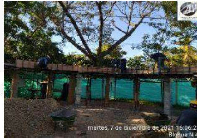
ENCOFRADO PARA CONSTRUCCION VIGA AEREA
