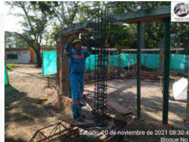
AMARRE DE ACERO DE REFURZO COLUMNAS
