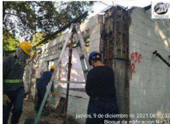
DESENCOFRADO D E COLUMNAS CONSTRUIDAS
