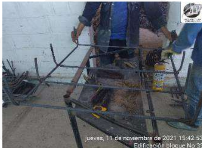
ARMADO ACERO DE REFUERZO ZAPATAS
