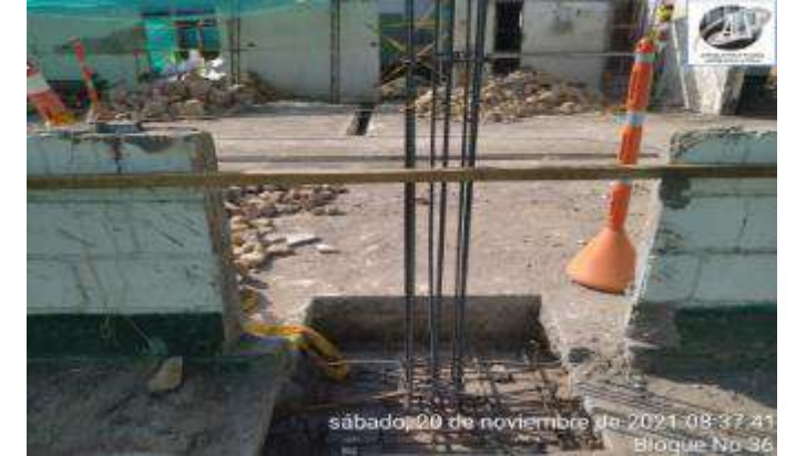
ARMADO DE ACERO DE REFUERZO ZAPATAS DE CIMENTACION SUPERFICIAL Y COLUMNAS
