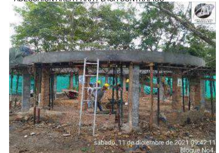
EXCAAVCION, NIVELACION Y RELLENO CON RECEBO PARA ADECUAION AREA PARA PLACA CONTRAPISO
