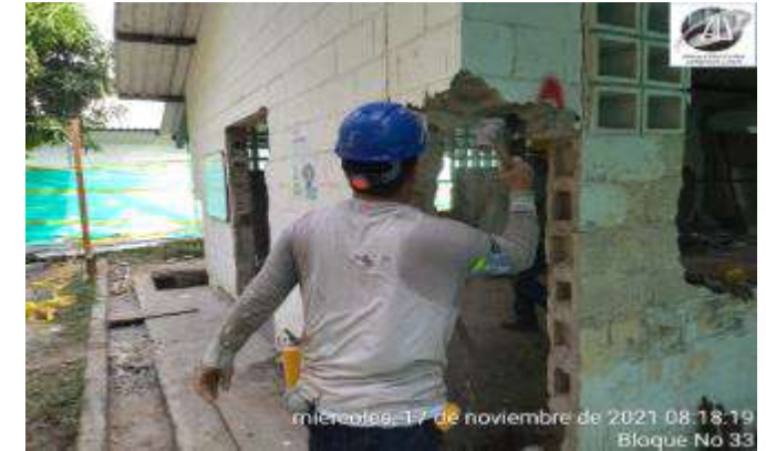
DEMOLICION MUROS PARA ARMADO DE ACEROS REFUERZO COLUMNAS
