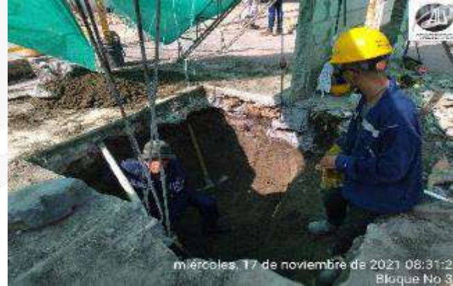
CORTE Y EXCAVACION MANUAL PARA CONCRETO CICLOPEO DE CIMENTACION
