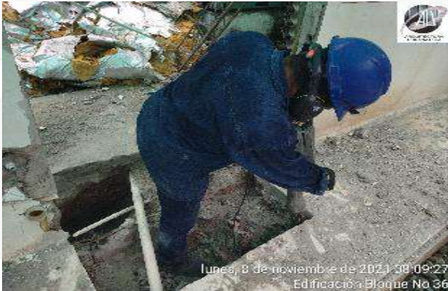
CORTE Y DEMOLICION MURO CICLOPEO EXISTENTE
