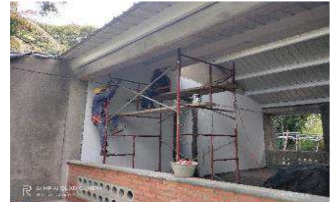
RESANE Y PINTURA ESTRUCTURA CUBIERTA METALICA BLOQUE 13
