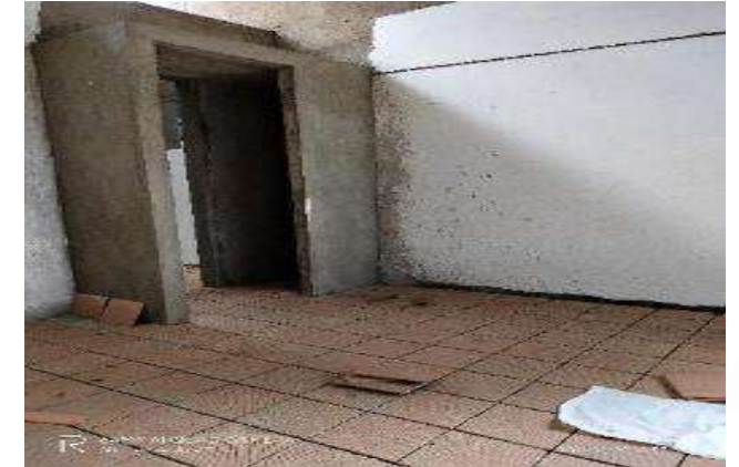
PAÑETE, ESTUCO Y PINTURA AREA INTERNA
