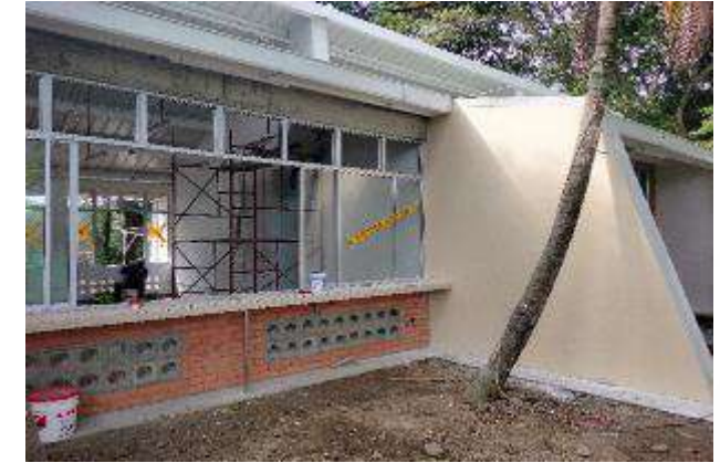
PINTURA Y ACABADO DE FACHADAS EXTERNAS
