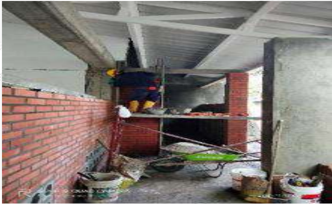
CONSTRUCCION MURO EN LADRILLO PRENSADO
