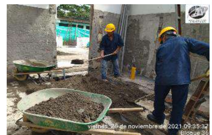
CARGUE Y RETIRO MATERIAL DE EXCAVACION CIMENTACION
