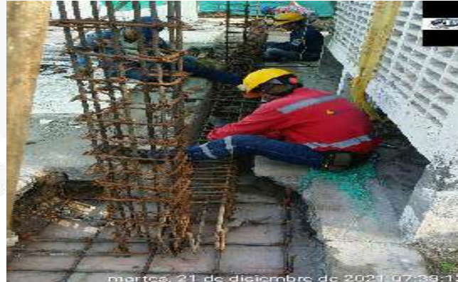
ARMADO ACERO DE REFUERZO ZAPATA Y VIGA DE AMARRE
