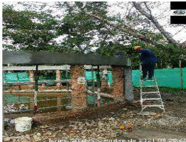
REPARACION DE ACABADO VIGA AEREA
