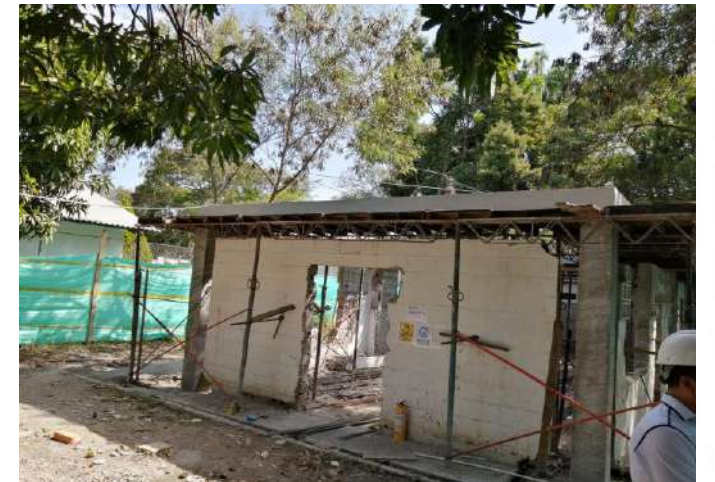
CONSTRUCCION DE VIGA AEREA EN CONCRETO DE 3000 PSI
