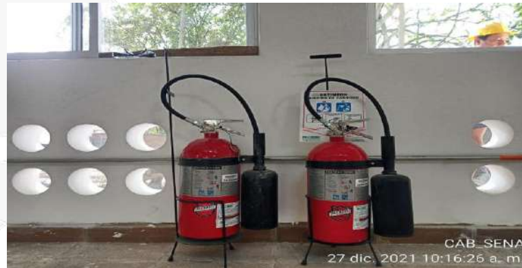
SUMINISTRO E INSTALACION EXTINTORIOS BLOQUE 13
