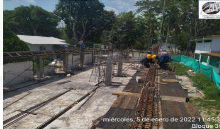
ARMADO ACERO DE REFUERZO VIGA AEREA
