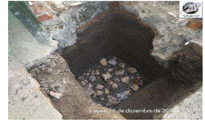
CONSTRUCCION DE CICLOPEO PARA MEJORAMIENTO DE CIMENTACION
