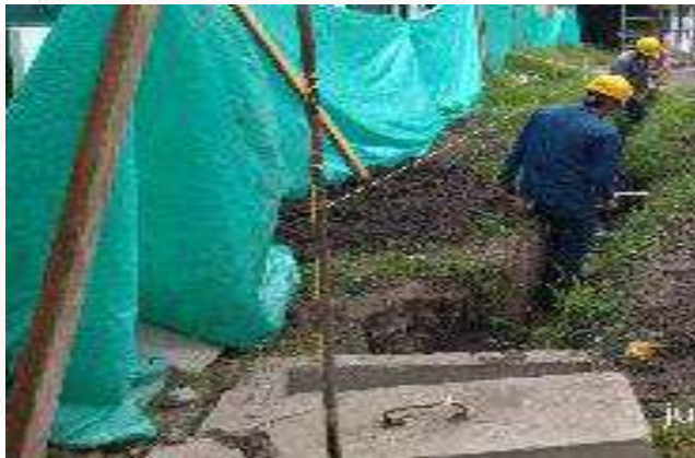
EXCAVACION MANUAL RED FLUVIAL
