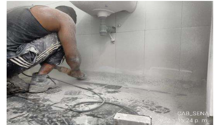
PULIDO Y ACABADO DE MEDIA CAÑA BATERIA SANITARIA
