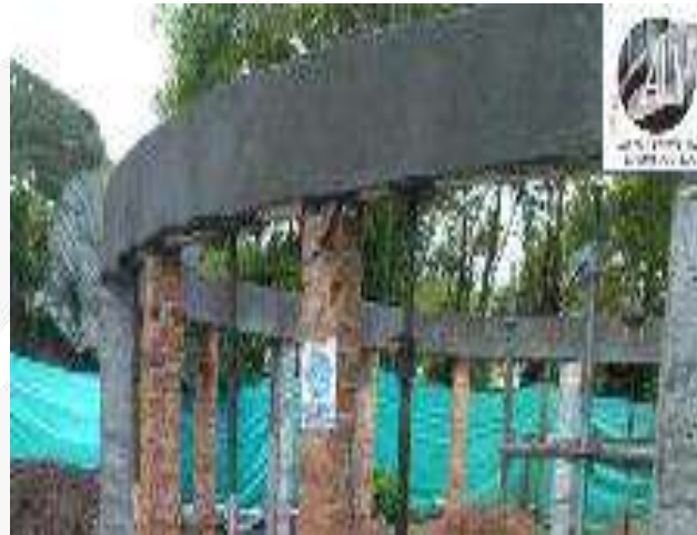
CONSTRUCCION VIGA AEREA
