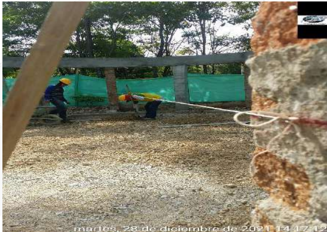
CHEQUEO DE NIVELES ZONA CONFORMADA
