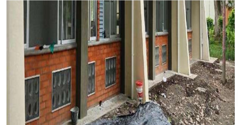
INSTALACION DE MARCO EN ALUMINIO Y ANGEOS SOBRE CALADOS DE VENTILACION
