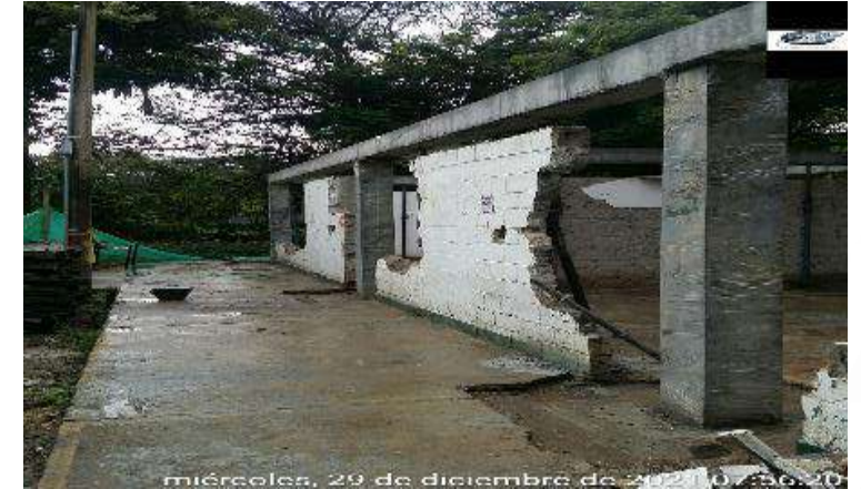
ESTRUCTURA DE CONCRETO CONSTRUIDA
