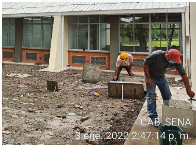
LIMPIEZA Y ASEO DE CAJAS DE INSPECCION HIDRAULICAS, SANITARIAS Y ELECTRICAS
