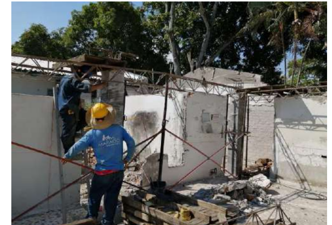
ARMADO DE ESTRUCTURA DE SOPORTE PARA CONSTRUCCION VIGA AEREA
