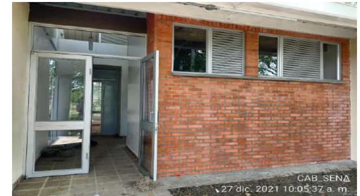
REMATES Y ACABADOS VANOS PUERTAS Y VENTANAS BLOQUE 13
