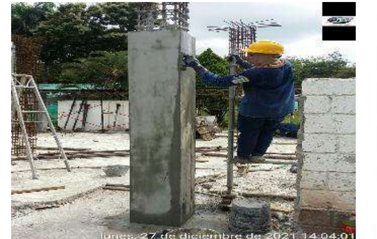
DESENCOFRADO DE COLUMNAS
