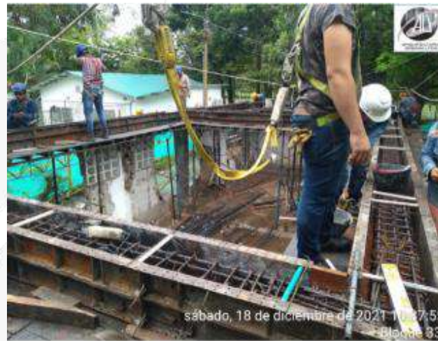
ENCOFRADO PARA CONSTRUCCION VIGA AEREA
