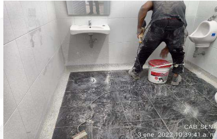
PULIDO Y ACABADO DE MEDIA CAÑA BATERIA SANITARIA DE PMR
