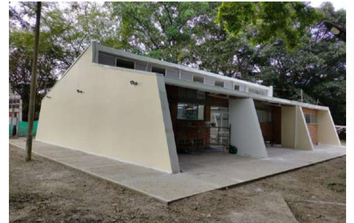
ACABADO DE FACHADA PRINCIPAL BLOQUE 12
