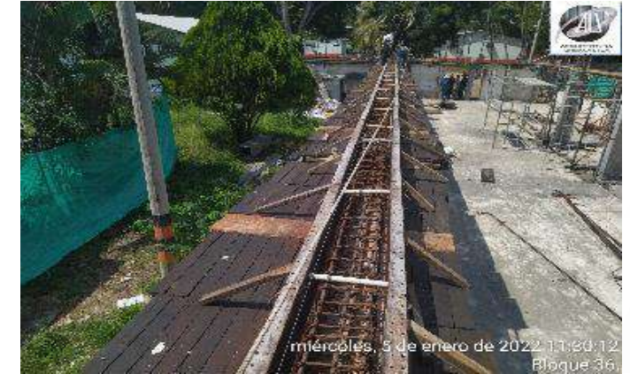
ENCOFRADO PARA CONSTRUCCION DE VIGA AEREA
