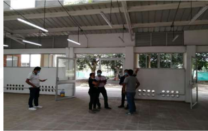
RECORRIDO DE OBRA CON FUNCIONARIOS SENA
