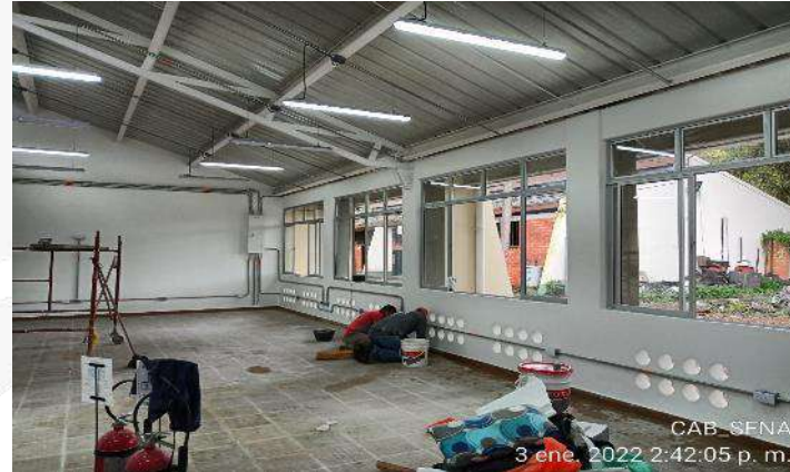
LAVADO Y LIMPIEZA DE GUARDAESCOBAS
