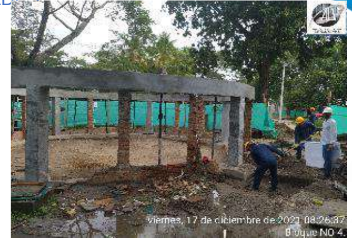
EXCAVACION MANUAL PARA CAJA DE INSPECCION
