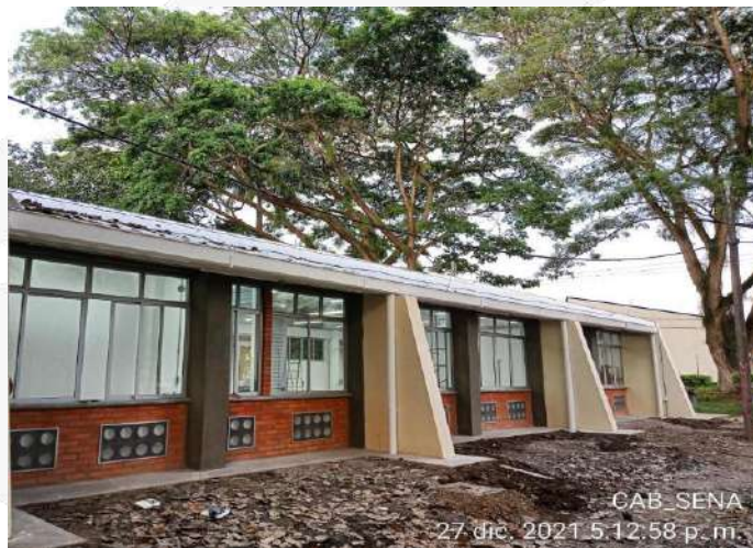
ADECUACION Y NIVELACION ZONAS VERDES
