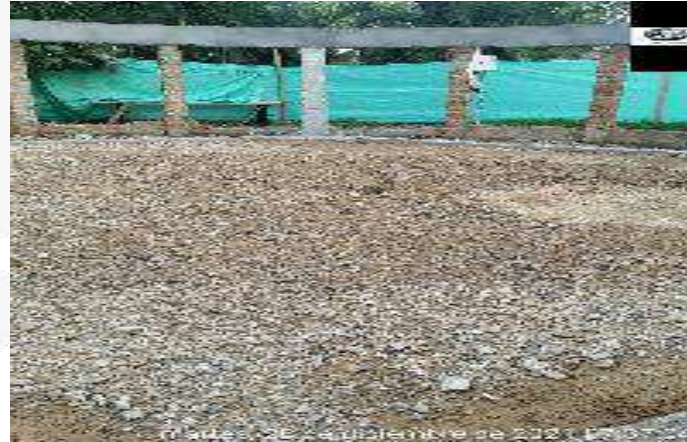
EXTENDIDO Y NIVELACION DE TERRENO CON RECEBO
