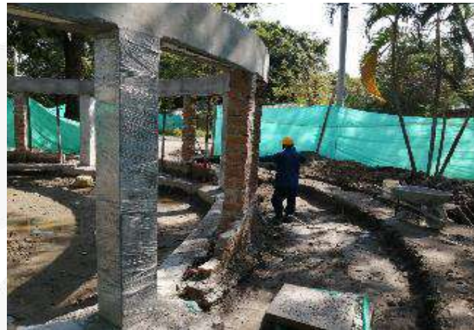
EXCAVACION MANUAL PARA CONSTRUCCION ANDEN PERIMETRAL
