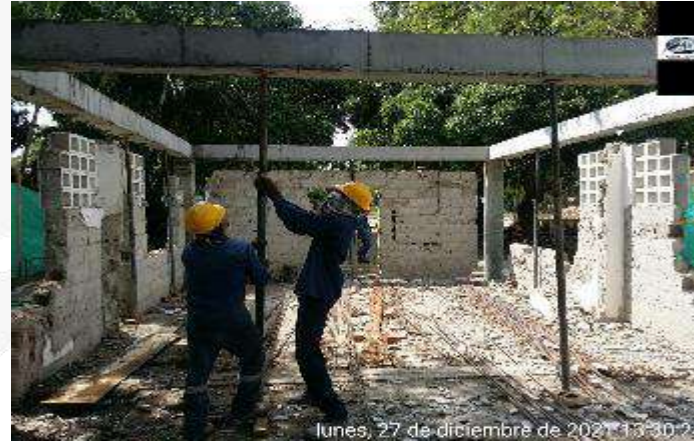
APUNTALAMIENTO VIGA AEREA
