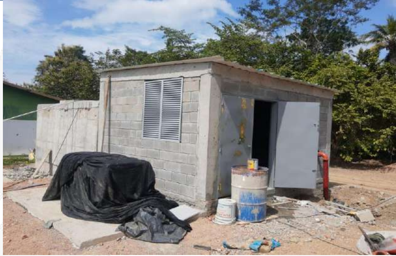
Cuarto de maquinas
