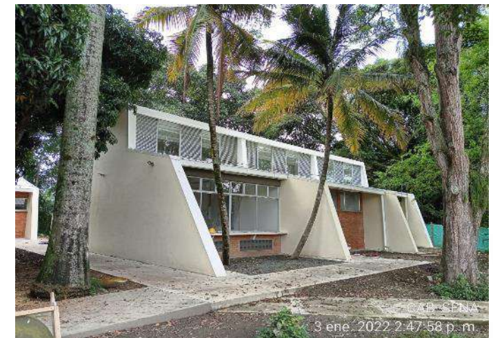
ACABADO DE FACHADA PRINCIPAL BLOQUE 13
