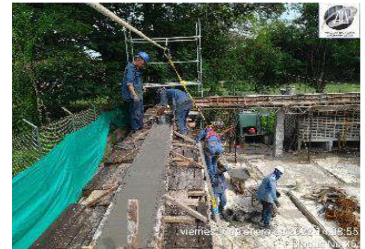
CONSTRUCCION VIGA AEREA
