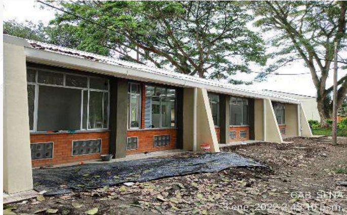
REMATES Y ACABADOS PINTURA MUROS EXTERNOS BLOQUE 12
