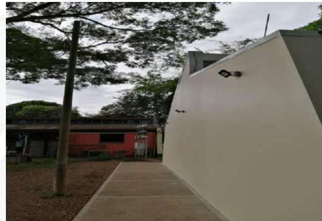
ACABADO DE FACHADAS laterales
