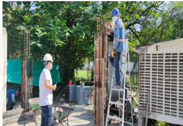
CHEQUEO DE PLOMADO Y PARAMENTO COLUMNAS
