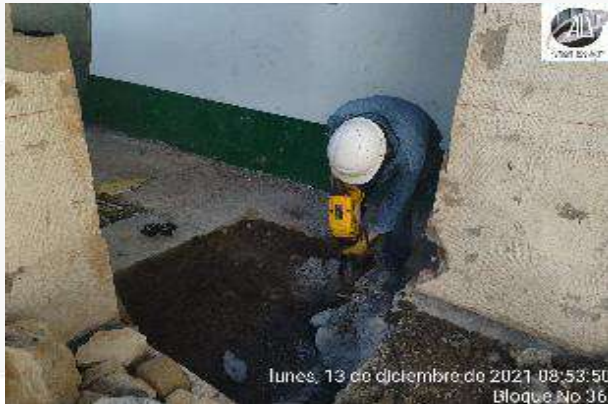
CORTE Y DEMOLICION CONCRETO EXISTENTE PARA CONSTRUCCION DE CIMENTACION
