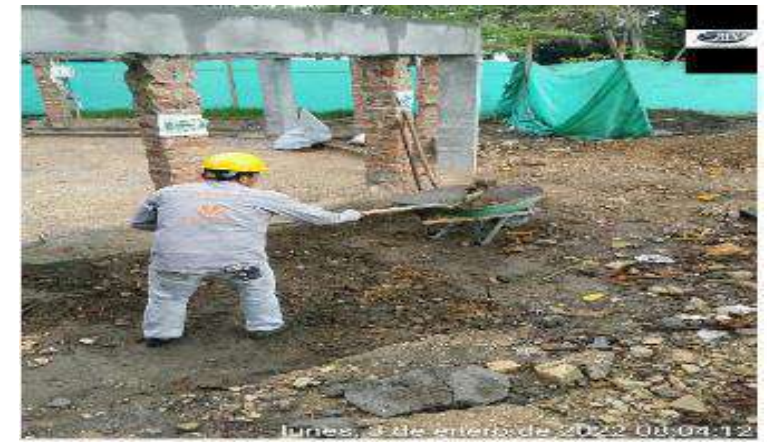
CORTE Y RETIRO MATERIAL DE EXCAVACION
