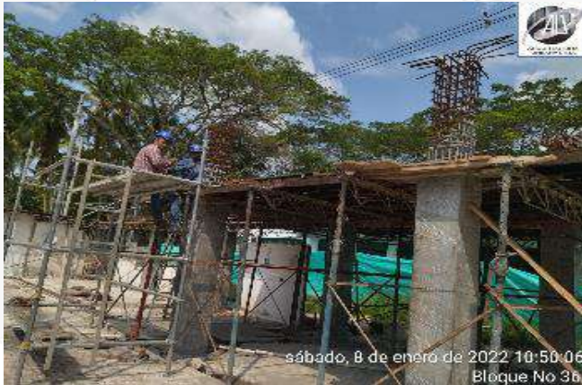
ARMADO ESTRUCTURA SOPORTE PARA CONSTRUCCION DE VIGA AEREA
