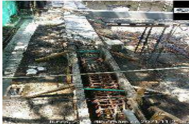
CONSTRUCCION VIGA AEREA
