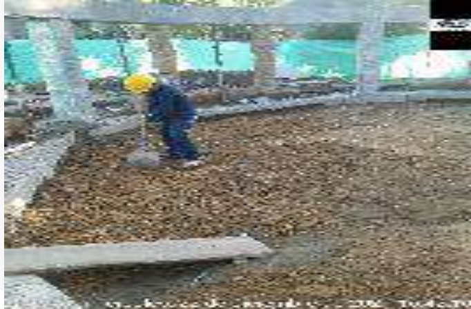
RELLENO Y CONFORMACION DE AREA CON RECEBO COMPACTADO
