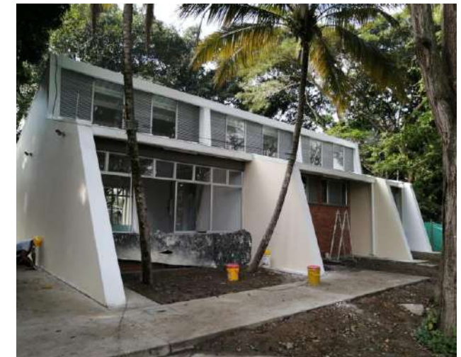
ACABADO DE FACHADA PRINCIPAL BLOQUE 13
