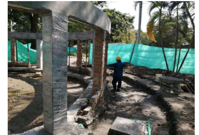
EXCAVACION MANUAL PARA CONSTRUCCION ANDEN PERIMETRAL
