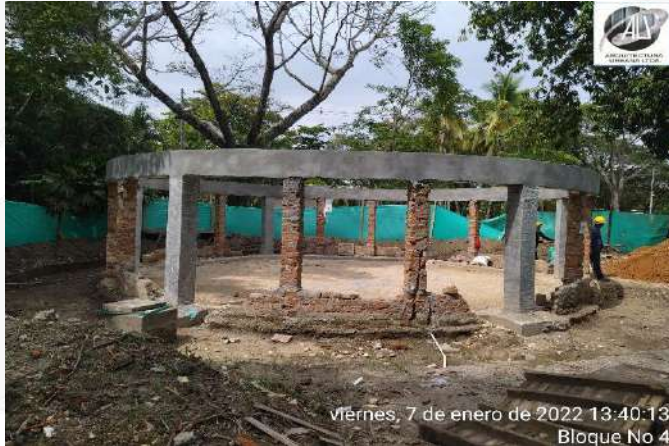
EXCAVACION MANUAL PARA CONSTRUCCION ANDEN PERIMETRAL
