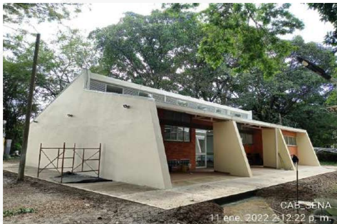
REMATAES Y ACABADOS MUROS EXTERNOS FACHADAS
