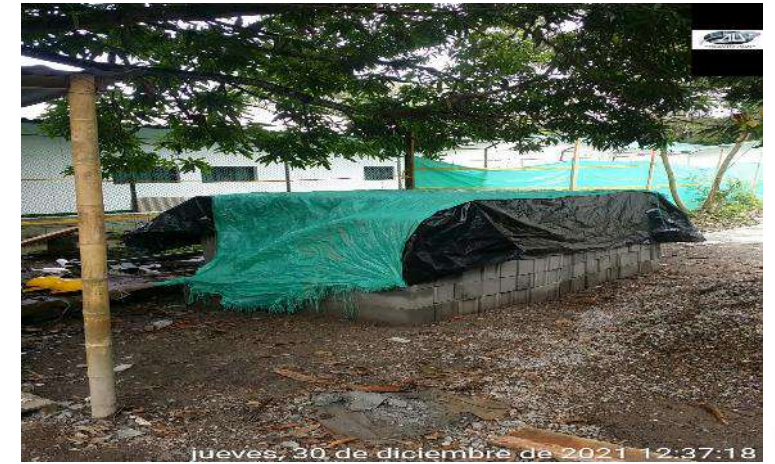
ACOPIO DE BLQQUE PARA MAMPOSTERIA CONFINADA
