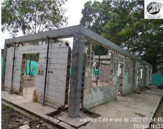
CONSTRUCCION ESTRUCTURA EN CONCRETO
