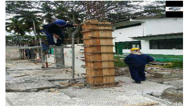
CONSTRUCCION DE COLUMNAS
