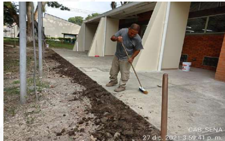
ADECUACION Y NIVELACION ZONAS VERDES
