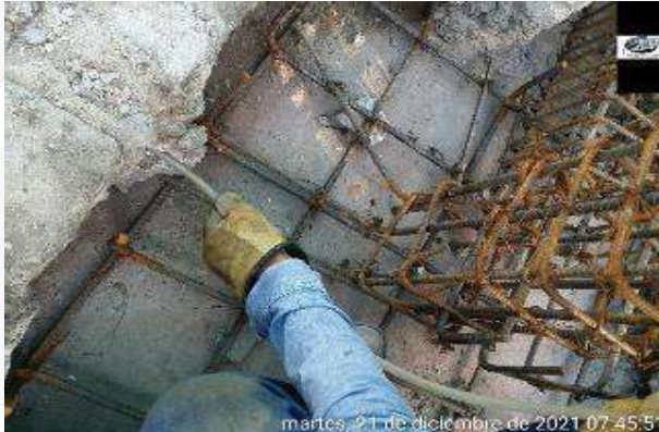
ARMADO ACERO DE REFUERZO ZAPATA Y COLUMNA
