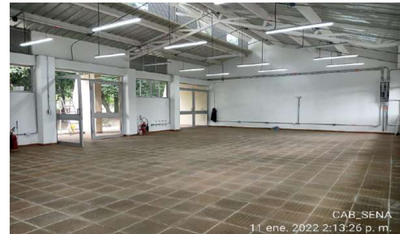
RESANE Y ACABADO DE BOQUILLA ENCHAPES PISOS
