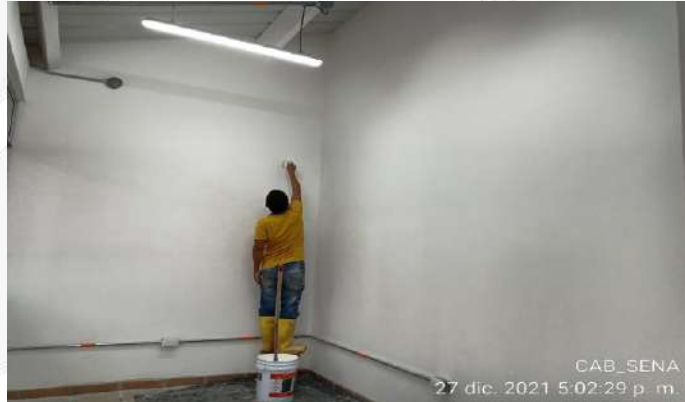
RESANE Y ACABDO PINTURA MUROS INTERNOS BLOQUE 13
