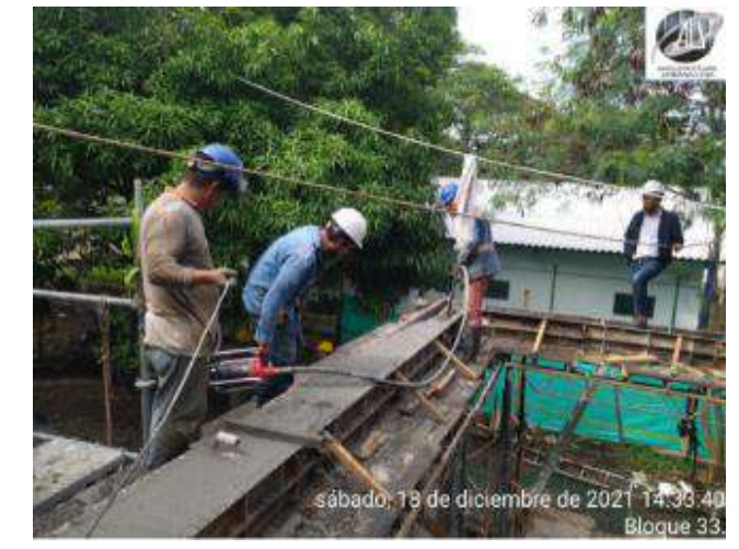
CONSTRCCION DE VIGA AEREA EN CONCRETO PREMEZCLADO DE 3000 PSI
