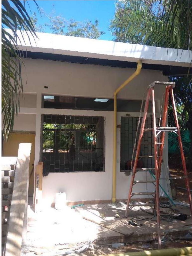
Bajantes aguas lluvias
