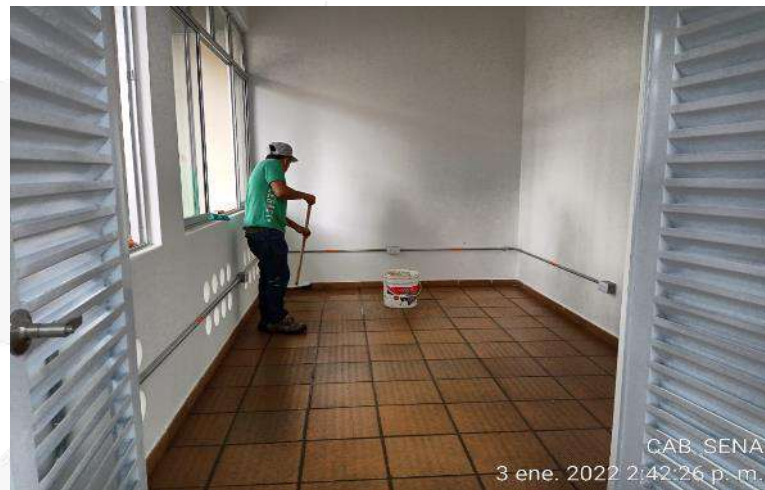
DESMANCHADO, LAVADO Y ACABADO DE PISO GENERAL BLOQUE 13
