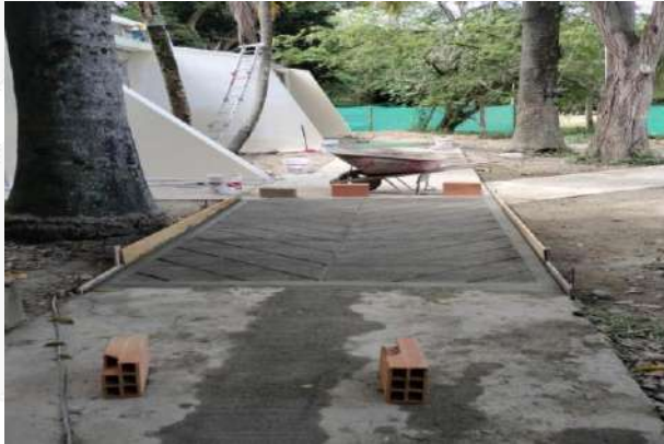
CONSTRUCCION RAMPAS DE ACCESIBILIDAD PMR
