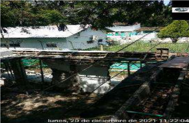
ARMADO ACERO DE REFUERZO Y ENCOFRADO PARA CONSTRUCCION VIGA AEREA
