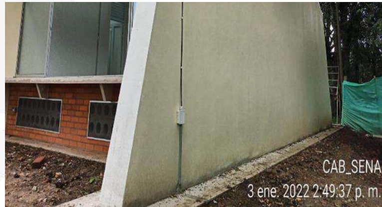
INSTALACION DE MARCO EN ALUMINIO Y ANGELO SOBRE CALADOS DE VENTILACION
