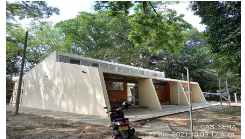
ACABADO DE FACHADA PRINCIPAL BLOQUE 12
