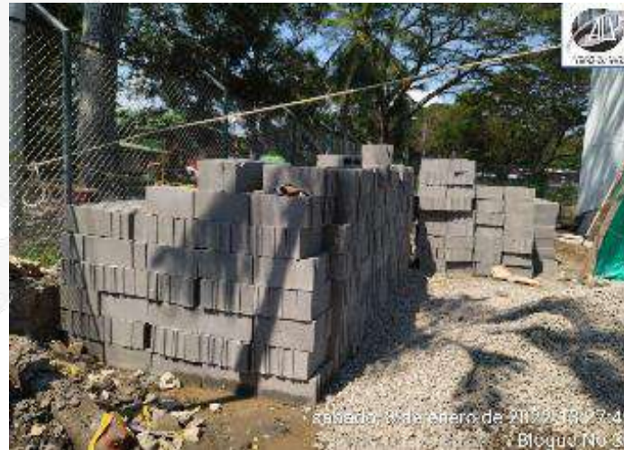
ACOPIO DE BLQUE PARA MAMPOSTERIA CONFINADA
