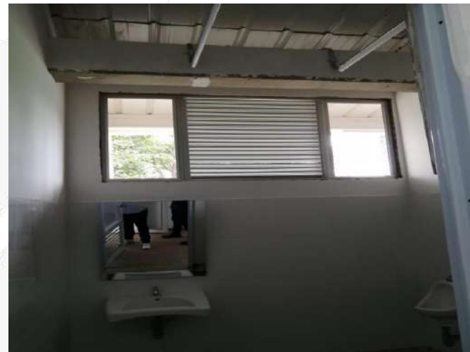
REMATE DE ACABADO VIGA AEREA ZONA DE BATERIAS SANITARIAS
