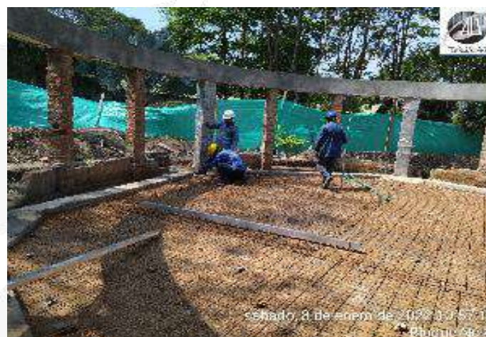
CHEQUEO DE NIVELES PARA CONSTRUCCION PLACA
