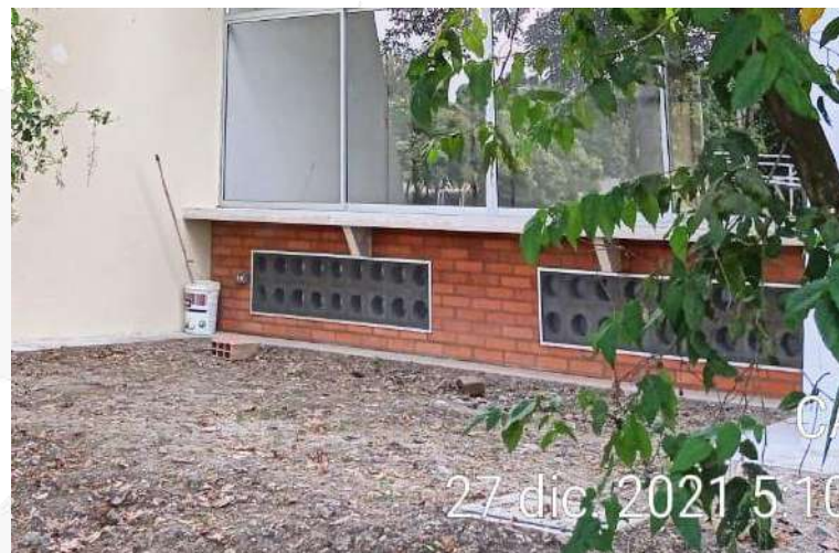
INSTALACION DE MARCO EN ALUMINIO Y ANGEOS SOBRE CALADOS DE VENTILACION
