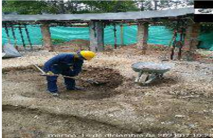
EXCAVACION MANUAL Y RETIRO DE MATERIAL EXISTENTE ZONA INTERNA BLOQUE
