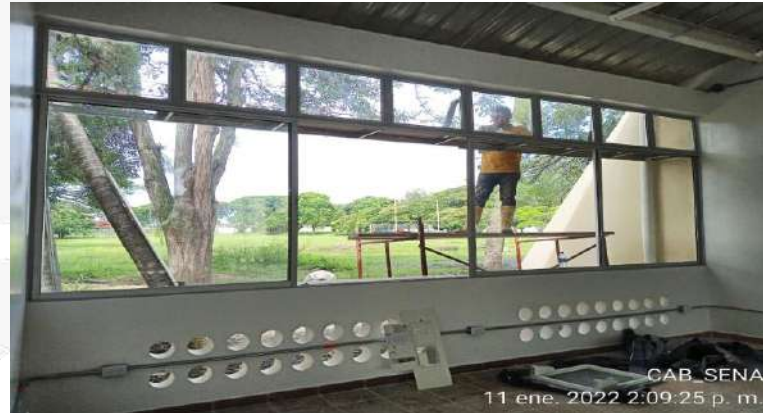
ACABADO Y REMATE DE INSTALACION BANDEJAS HORIZONTALES VENTANAS FACHADA
