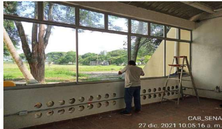
REMATAES Y ACABADOS VANOS VENTANAS
