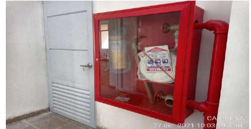
REMATAES Y ACABADOS GABINETE RED CONTRA INCENDIOS
