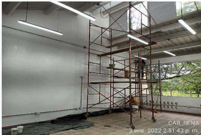
REMATAES Y ACABADOS MUROS INTERNOS
