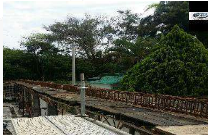
ARMADO ACERO DE REFUERZO VIGA AEREA
