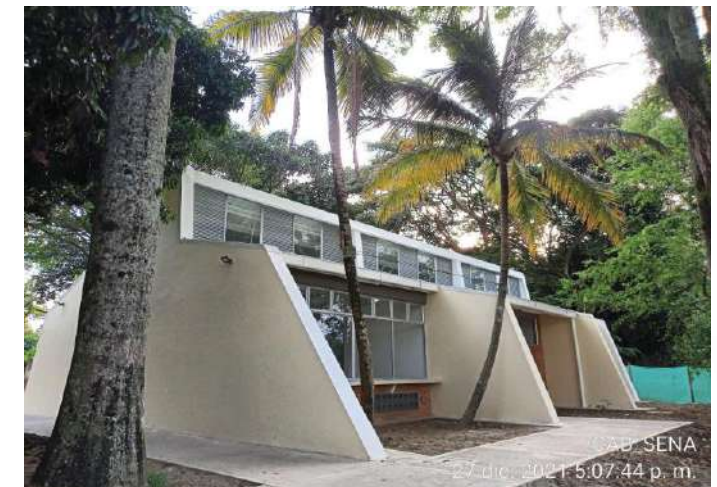
ACABADO DE FACHADA PRINCIPAL BLOQUE 13
