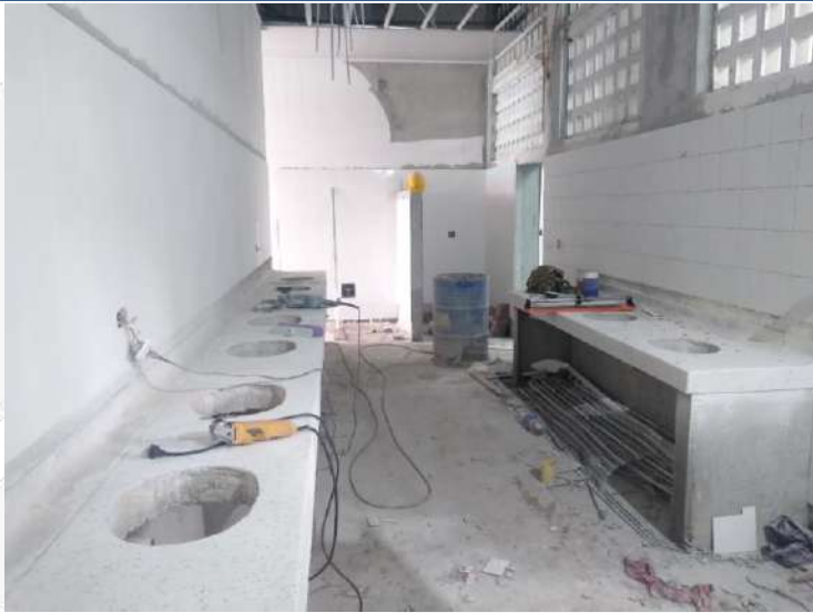
Enchape zona lavamanos
