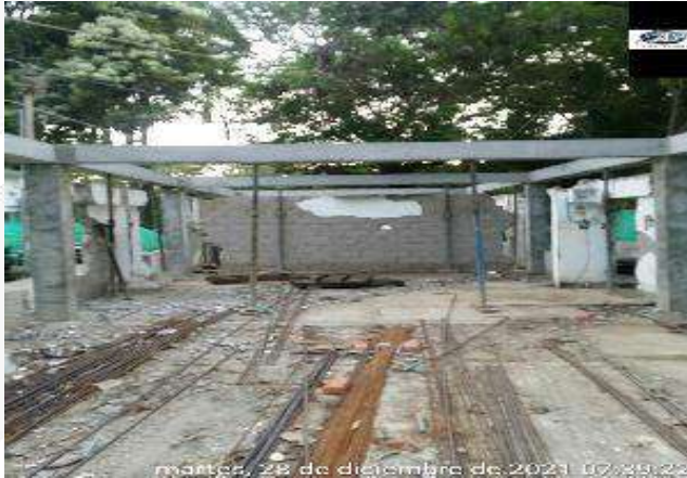
DESARME Y RETIRO ESTRUCTURA SOPORTE VIGA AEREA
