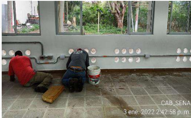
LAVADO Y LIMPIEZA DE GUARDAESCOBAS BLOQUE 13
