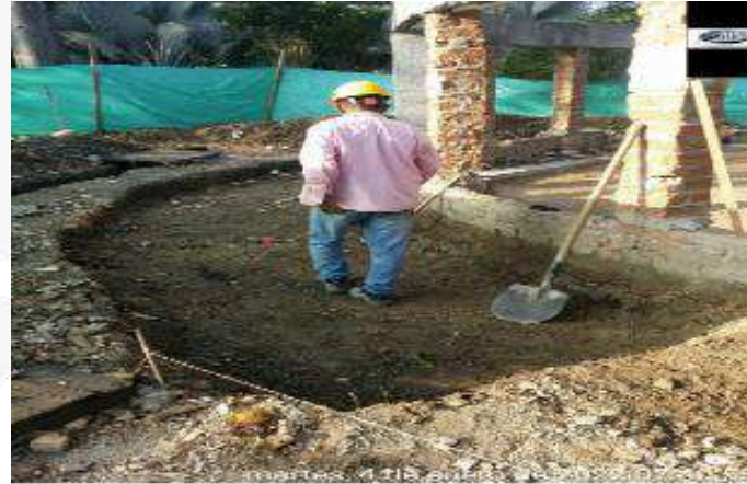
CORTE Y NIVELACION DE TERRENO PARA CONSTRUCCION ANDEN PERIMETRAL
