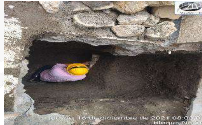
EXCAVACION MANUAL PARA CONSTRUCCION DE CICLOPEO
