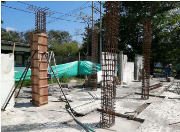
ENCOFRADO PARA CONSTRUCCION DE COLUMNAS
