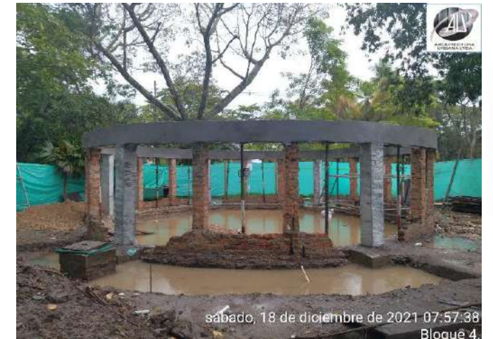
PRESENCIA DE LLUVIAS EN LA ZONA DE INTERVENCION
