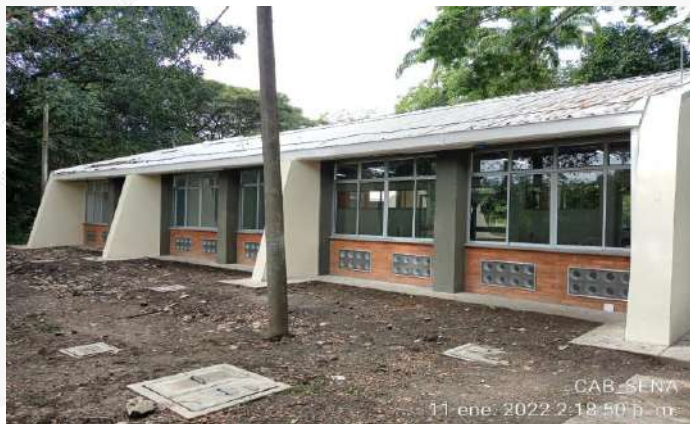
INSTALACION DE MARCO EN ALUMINIO Y ANGEOS SOBRE CALADOS DE VENTILACION
