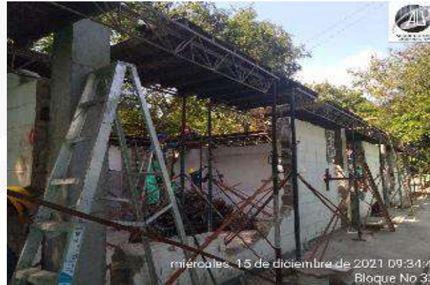
ARMADO ESTRUCTURA DE SOPORTE VIGA AEREA
