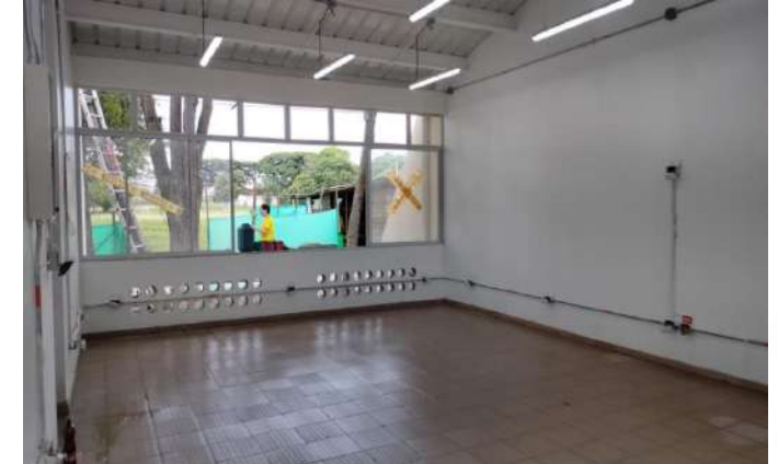
ACABADOS DE AULAS DE FORMACION
