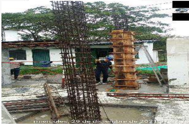
ARMADO ACERO DE REFUERZO COLUMNA
