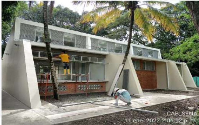
REMATAES Y ACABADOS MUROS EXTERNOS FACHADAS
