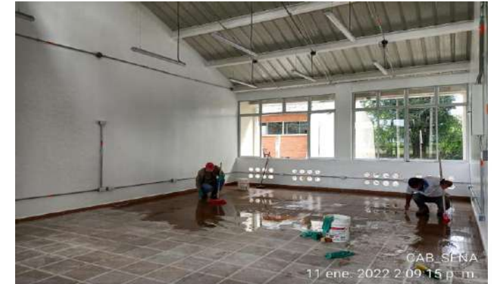
DESPEGUE Y LIMPIZA DE BOQUILLA ENCHAPES PISOS
