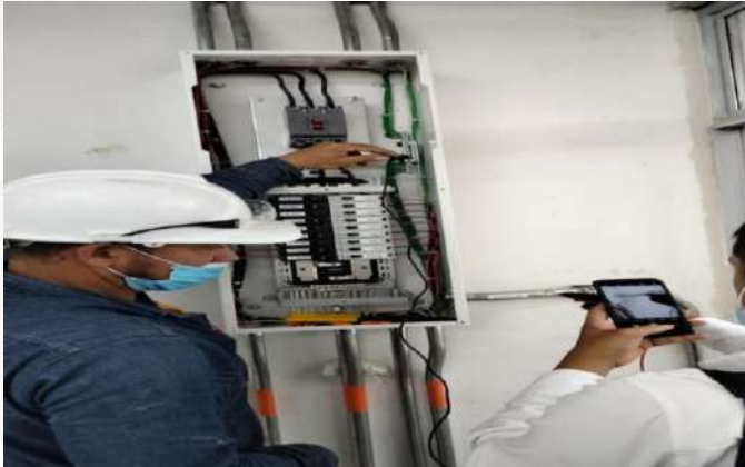
PRUEBAS A TABLEROS ELECTRICOS PARA CERTIFICADO RETIE Y RETILAP
