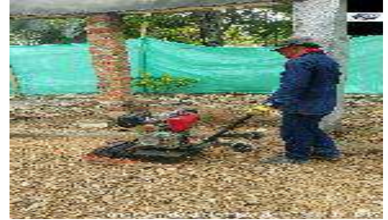
CONFORMACION Y COMPACTACION TERRENO
