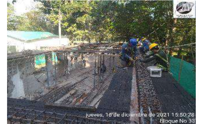
INSTALACION ACERO DE REFUERZO VIGA AEREA.
