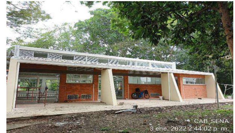
ACABADO DE FACHADA PRINCIPAL BLOQUE 12
