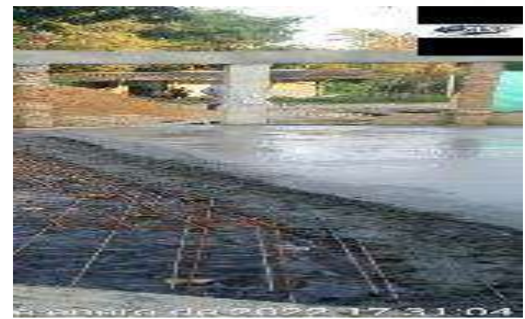
CONSTRUCCION PLACA CONTRAPISO
