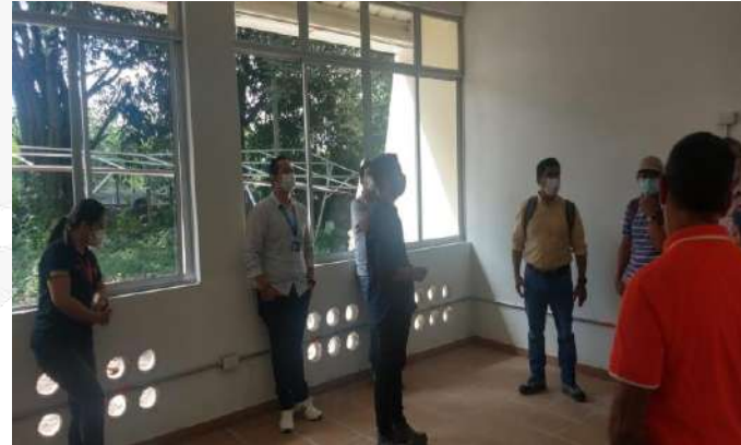
RECORRIDO DE OBRA CON FUNCIONARIOS SENA
