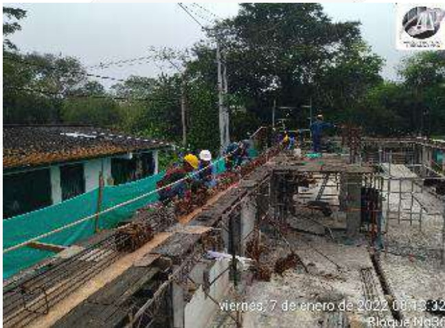
ARMADO ESTRUCTURA SOPORTE PARA CONSTRUCCION DE VIGA AEREA
