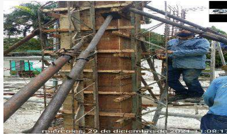
ENCOFRADO DE COLUMNAS
