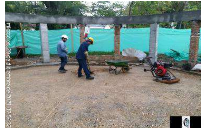
AREA CONFORMADA PARA TOMA DE DENSIDADES
