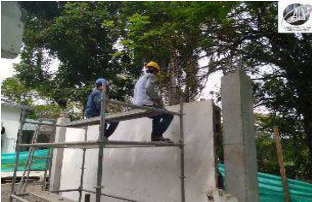
CORTE Y DEMOLICION DE MURO
