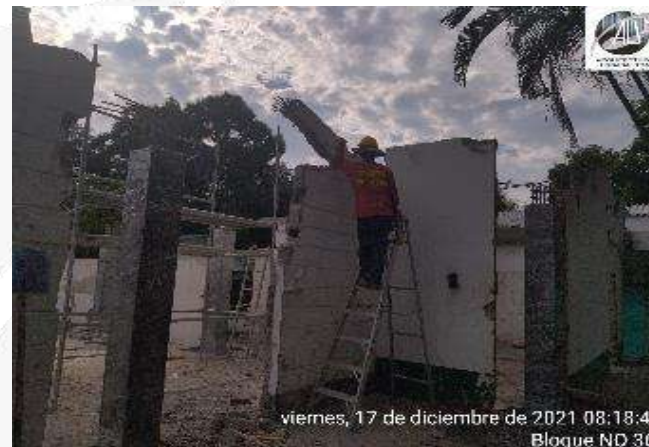
DEMOLICION DE VIGUETAS DE CONFINAMIENTO EXISTENTES
