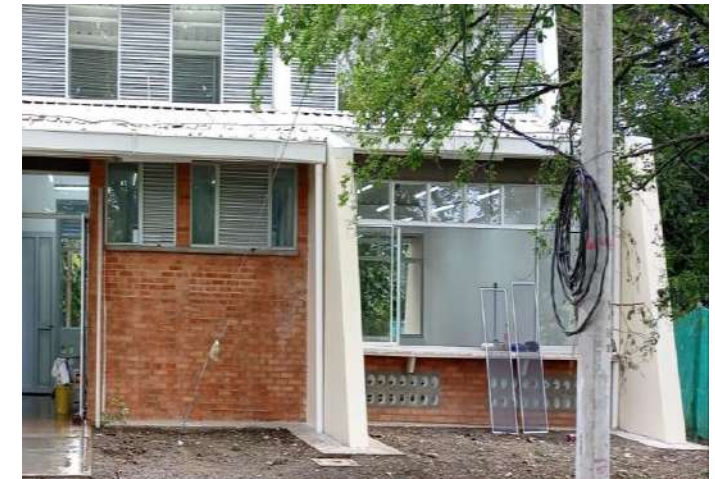
AJUSTE Y REINSTALACION DE VENTANAS BLOQUE 13
