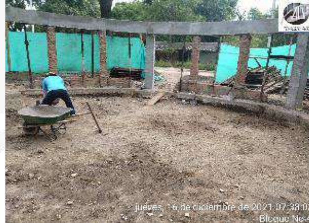
RELLENO Y CONFORMACION DE AREA CON RECEBO COMPACTADO
