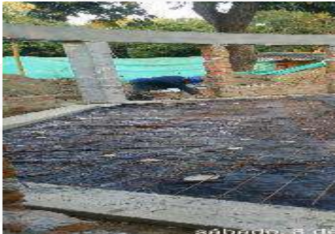
INSTALACION DE POLIETILENO PARA AISLAMIENTO DE HUMEDAD
