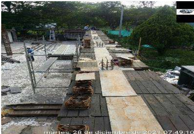
ARMADO ESTRUCTURA SOPORTE PARA CONSTRUCCION DE VIGA AEREA
