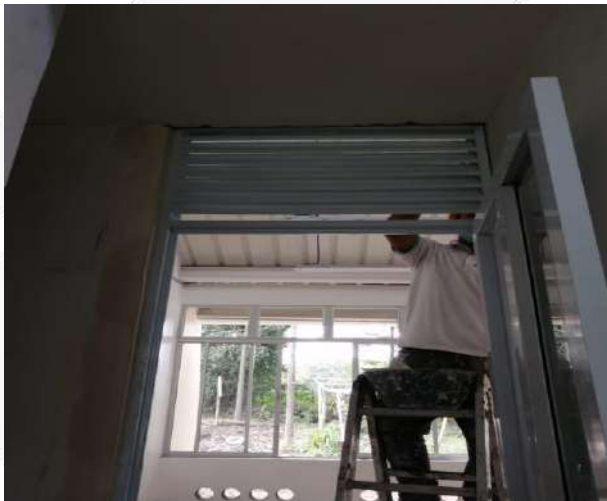
REMATE DE ESTUCO Y PINTURA SOBRE MURO DE ACCESO AULA INTERNA
