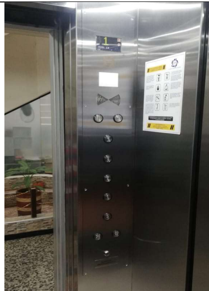
Botonera de cabina y hall con sistema braille e indicador
