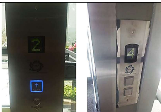
Botoneras con sistema braille e indicador en todos los pisos
