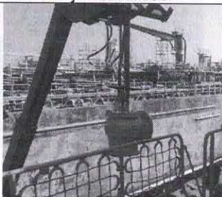
Instalación válvula principal de caja de mar
