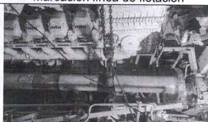
Instalación eje intermedio N° 1
