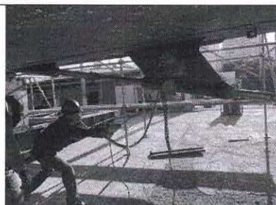
Desmonte línea de eje estribor
