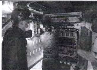
MANTENIMIENTO RED DISTRIBUCIÓN ELÉCTRICA
