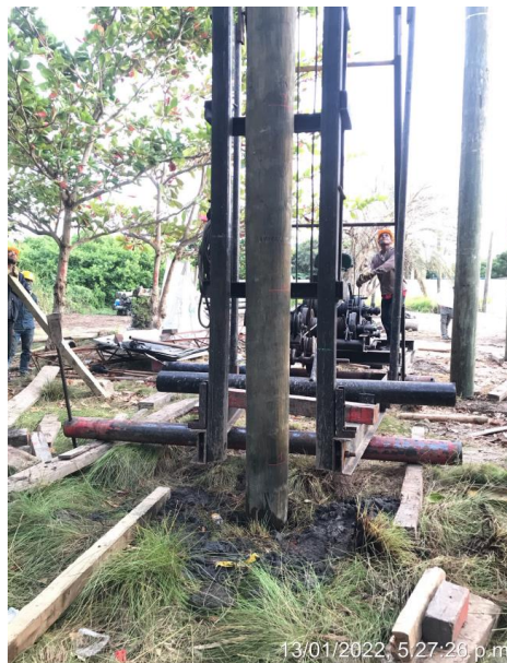
Primer hincado de pilote en frente de tierra (Estación III)
