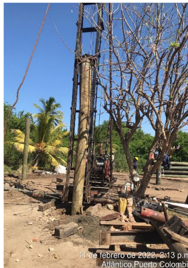
Hincado de pilotes en frente tierra (Estación III) Semana 4
