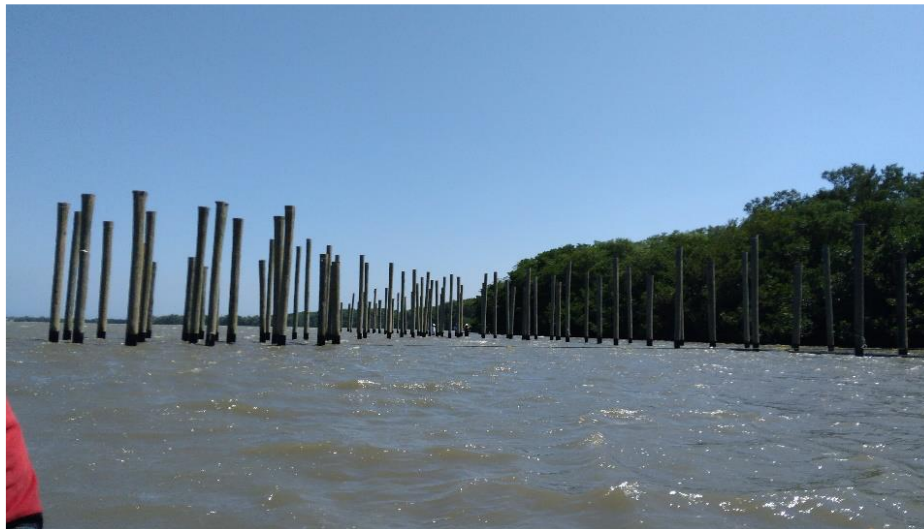
Hincado de pilotes en frente agua (Modulo 2 y 3) Semana 4.
