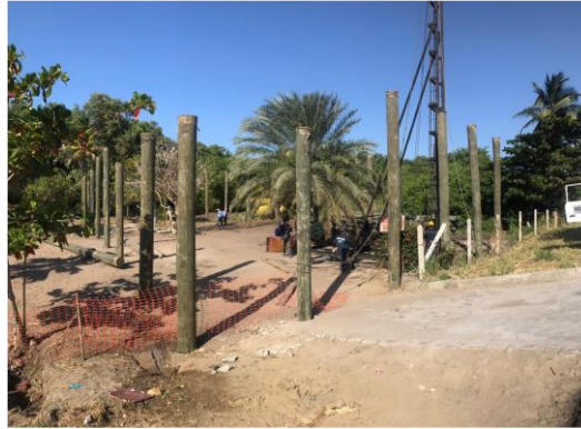
Pilotes hincados en el frente tierra (Estación III) semana 3
