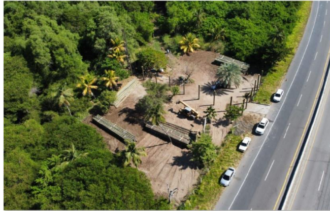
Vista aérea de pilotes hincados en el frente de tierra (Estación III)
