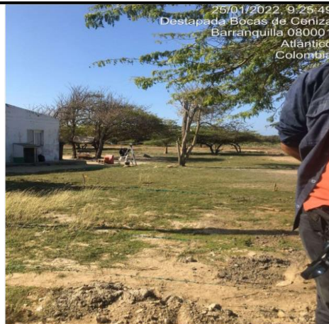
Trabajo de topografía en línea férrea.
