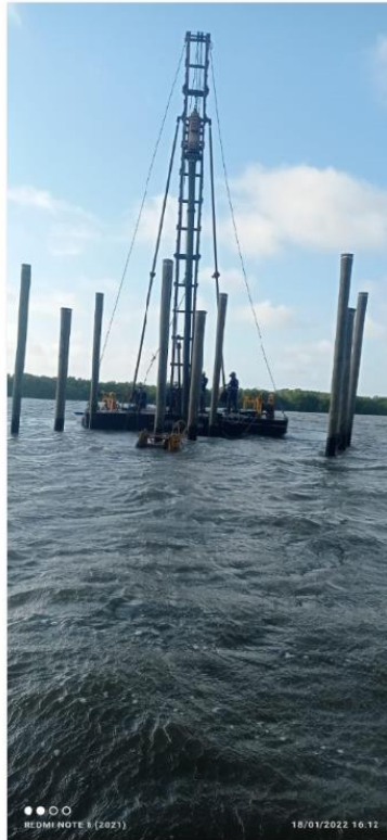
Pilotes hincados en el frente de agua (Modulo 1 y 2) semana 2.
