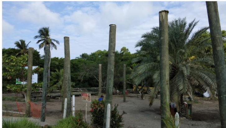
Pilotes hincados en el frente tierra (Estación III) semana 2
