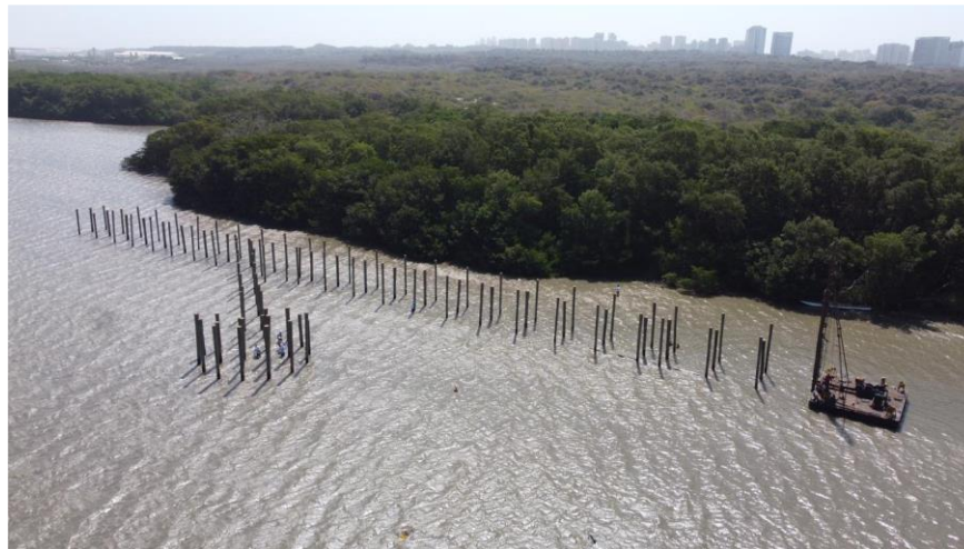
Vista aérea pilotes acumulados en el frente de agua (Estación III)
