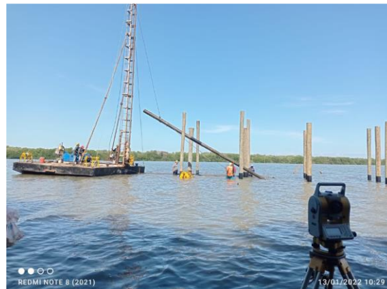
Hincado de pilotes en frente de agua (Modulo 1)
