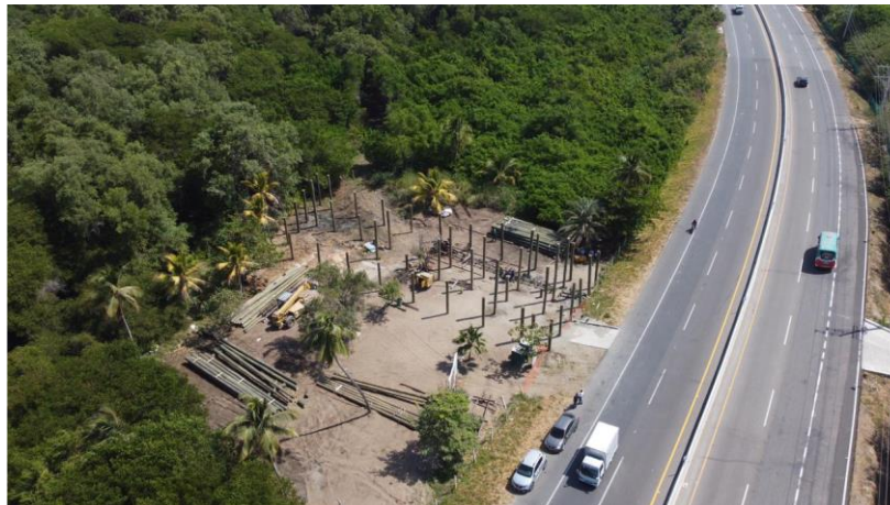
Vista aérea de pilotes en frente tierra (Estación III) Semana 4
