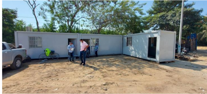
Segundo campamento de obra.
