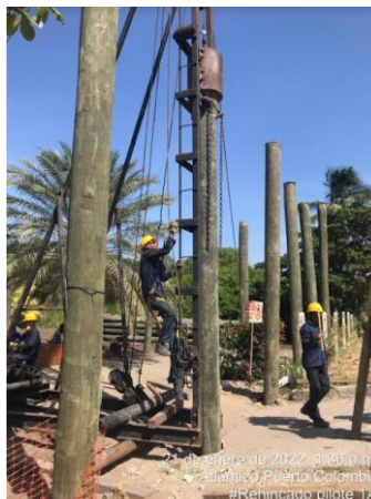
Pilotes rehincados en el frente tierra (Estación III) semana 2.
