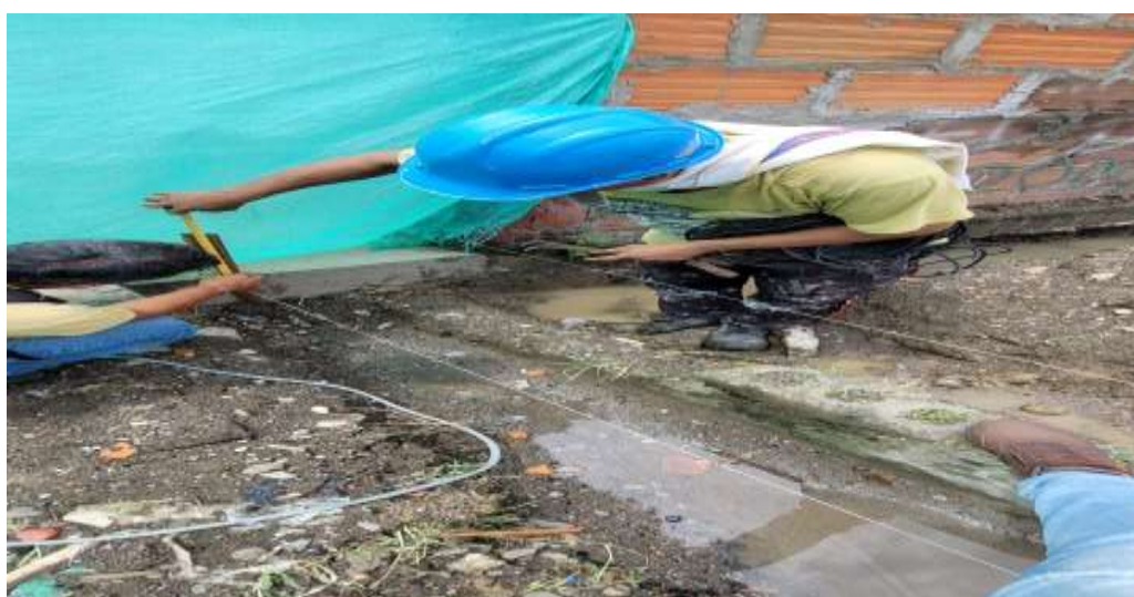
Imagen 2 Localización y Replanteo
