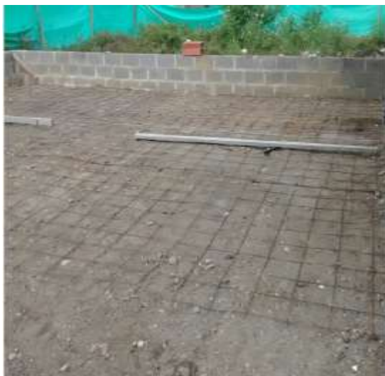
Imagen 5 y 6. Sobre cimient, lleno, Malla electrosoldada y vaciado de Placa
