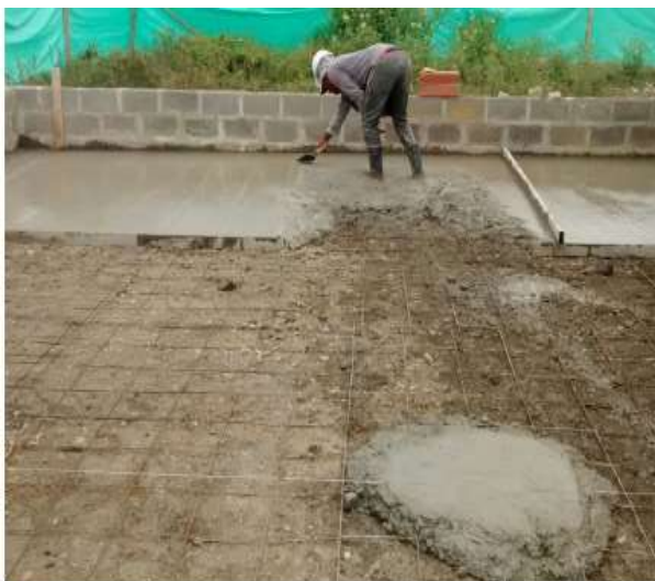
Imagen 5 y 6. Sobre cimient, lleno, Malla electrosoldada y vaciado de Placa
