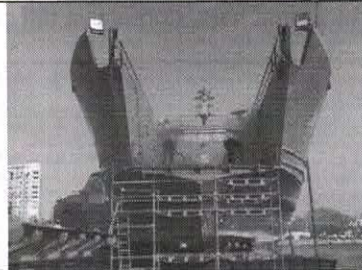
Mantenimiento cubierta principal
