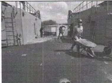
Mantenimiento cubierta principal
