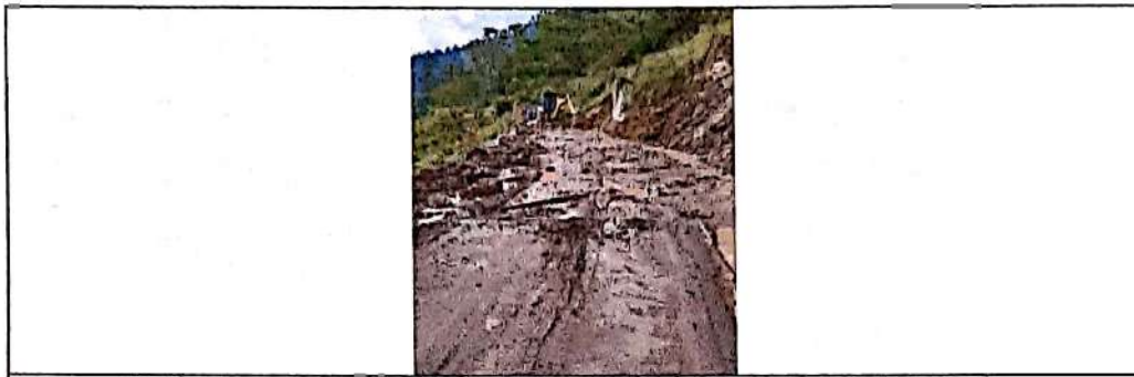
Imagen 15. Vereda andes sector escuela andes, vía afectada por deslizamiento.
