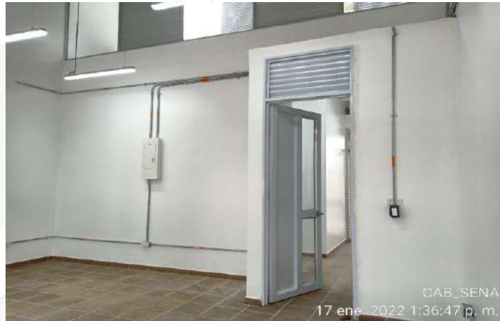
RESANE Y ACABADO DE PINTURA SOBRE MUROS INTERNOS
