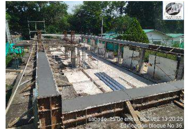
CONSTRUCCION VIGA AEREA
