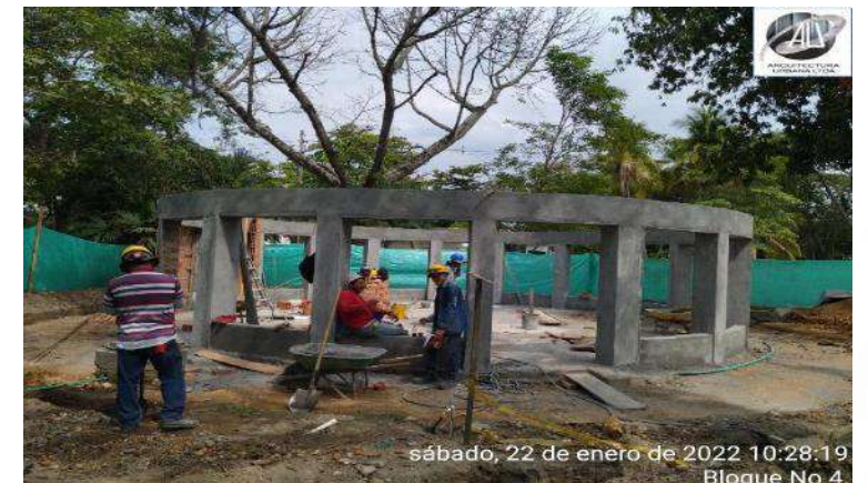
PAÑETE DE ESTRUCTURA Y MUROS EN LADRILLO PRENSADO
