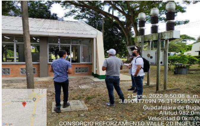
RECORRIDO DE OBRA PARA ENTREGA A LA SUBDIRECCION SENA
