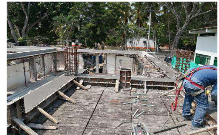
ARMADO ESTRUCTURA SOPORTE PARA CONSTRUCCION PLACA TANQUES
