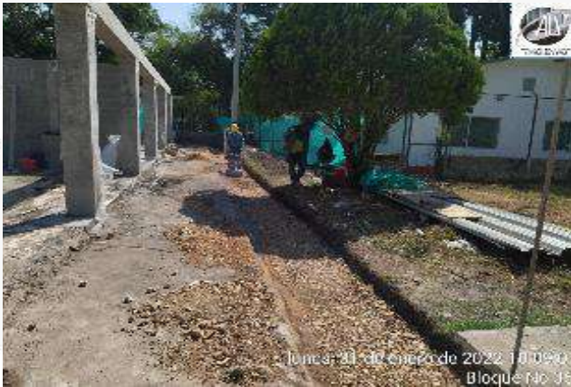
CONFORMACION Y COMPACTACION RECEBO PARA MEJORAR TERRENO CARCAMO
