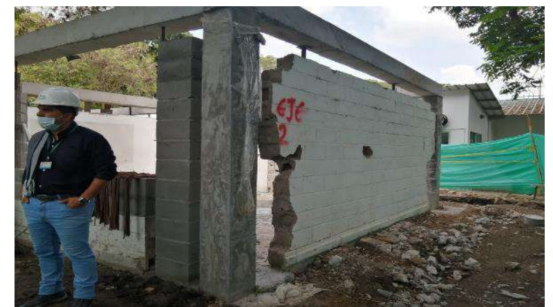
RECORRIDO OBRA CLIENTE SENA Y SUPERVISION TECNICA
