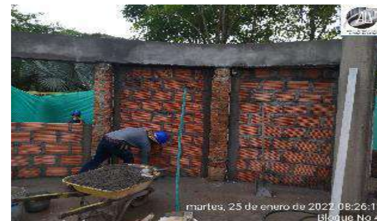
CONSTRUCCION MAMPOSTERIA CONFINADA
