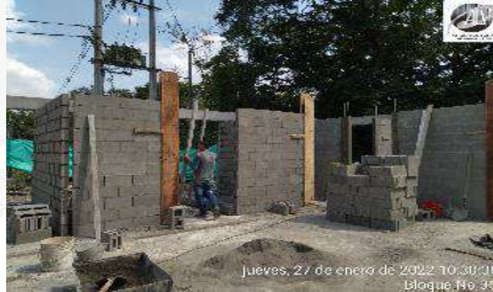
CONSTRUCCION DE MAMPOSTERIA CONFINADA
