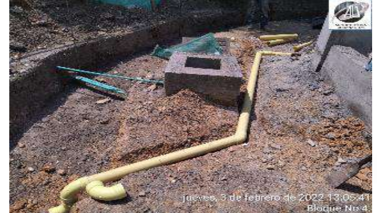
SUMINISTRO E INSTALACION TUBERIA DRENAJE CUBIERTA
