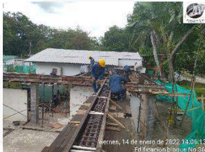
ARMADO ACERO DE REFUERZO VIGA AEREA
