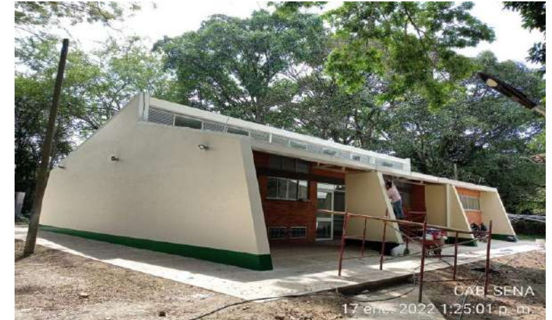
RESANE Y ACABADO DE PINTURA FACHADAS
