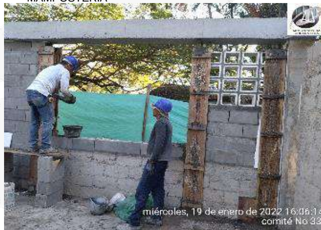
CONSTRUCCION MURO LATERAL CONFINADO
