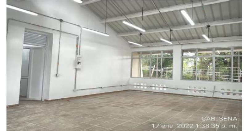
RESANES Y ACABADOS PINTURA ESTRUCTURA METALICA Y MUROS INTERNOS
