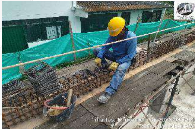
ARMADO ACERO DE REFUERZO CONSTRUCCION DE VIGA AEREA
