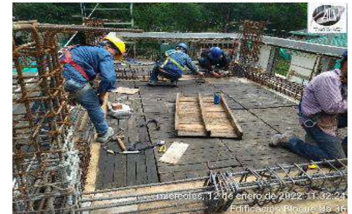
ARMADO ESTRUCTURA SOPORTE PARA CONSTRUCCION PLACA TANQUES
