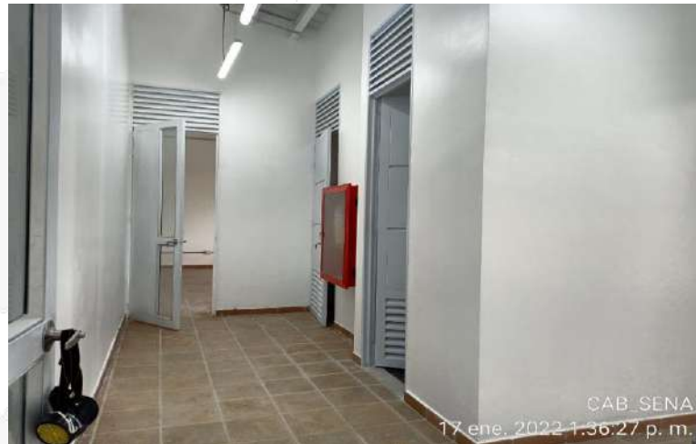
DESPEGUE Y LIMPIZA DE BOQUILLA ENCHAPES PISOS
