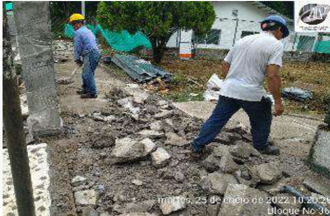
DEMOLICION ANDEN EXISTENTE
