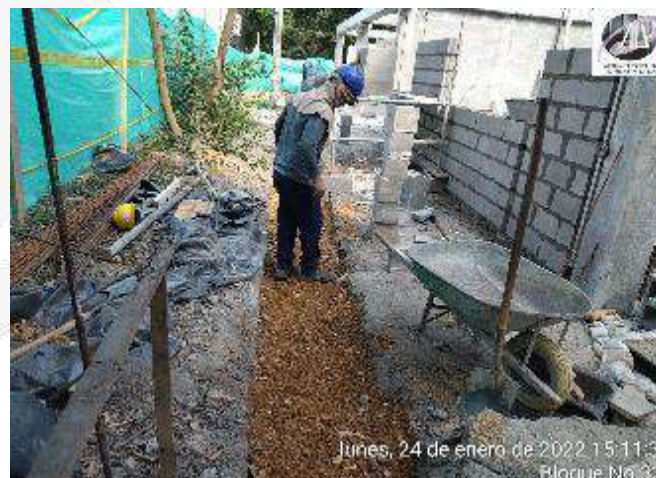
RELLENO Y CONFORMACION AREA PARA INSTALACION ACERO DE REFUERZO CARCAMO
