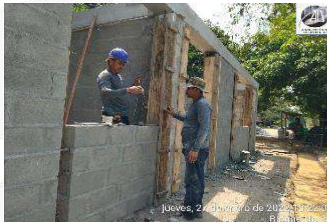
ENCOFRADO PARA CONSTRUCCION COLUMNETAS DE CONFINAMIENTO
