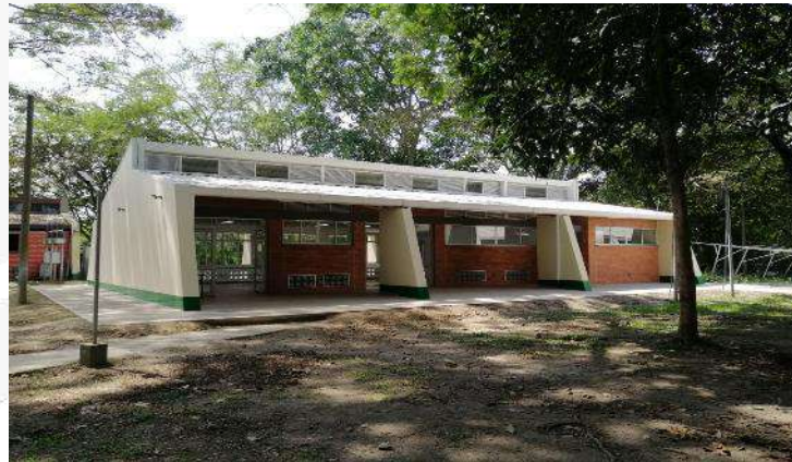
FINALIZACION DE CONTRUCCION BLOQUE 12
