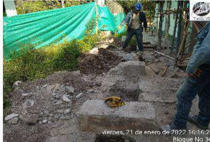
DEMOLICION DE CONCRETO ESTRUCTURAS EXTERNAS EXISTENTES
