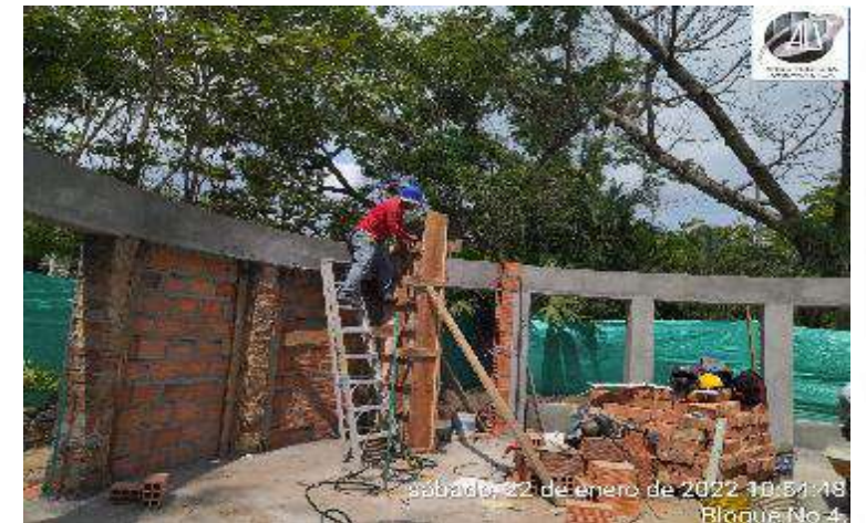
CONSTRUCCION MAMPOSTERIA CONFINADA
