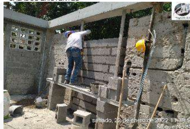
CONSTRUCCION MAMPOSTERIA CONFINADA
