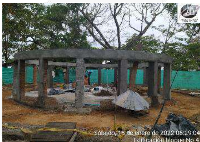
PAÑETE DE ESTRUCTURA Y MUROS INTERNOS Y EXTERNOS
