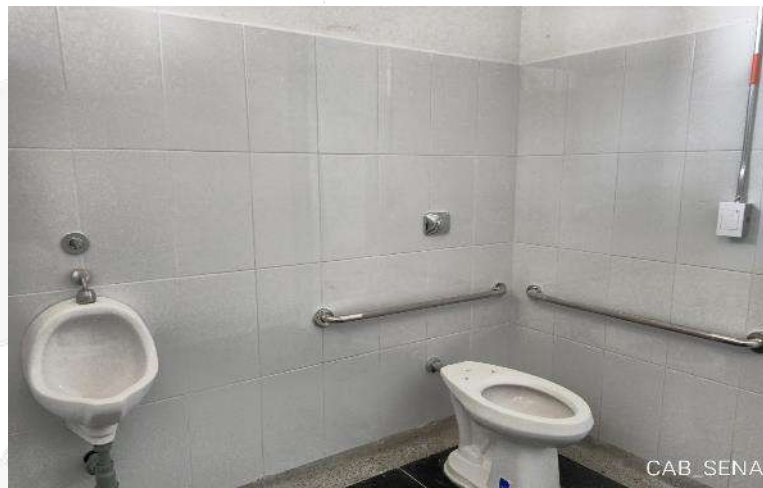
REVISION FUNCIONALIDAD DE UNIDAD SANITARIA PMR
