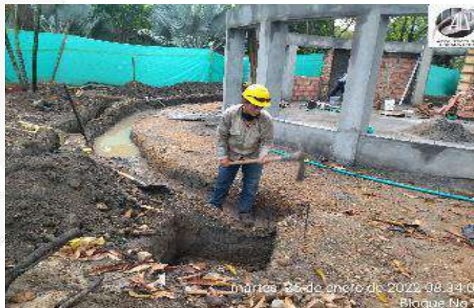
EXCAVACION ANUAL PARA CONSTRUCCION CARCAMO PERIMETRAL DE AGUAS LLUVIAS
