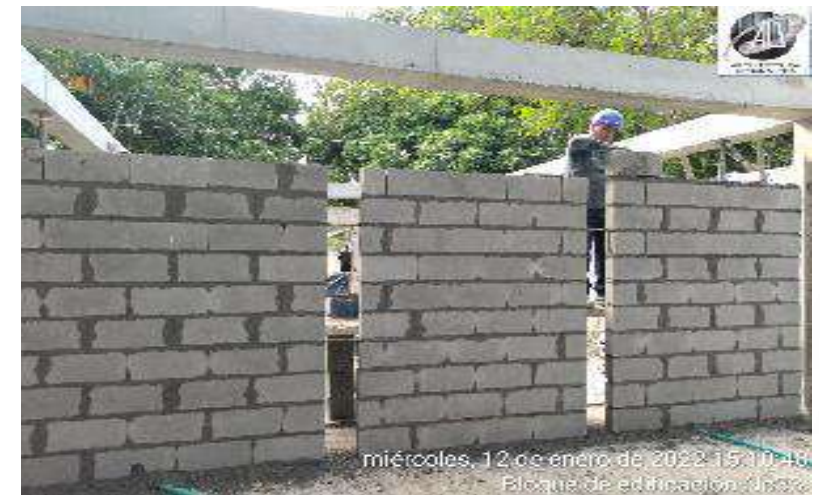
CONSTRUCCION DE MAMPOSTERIA
