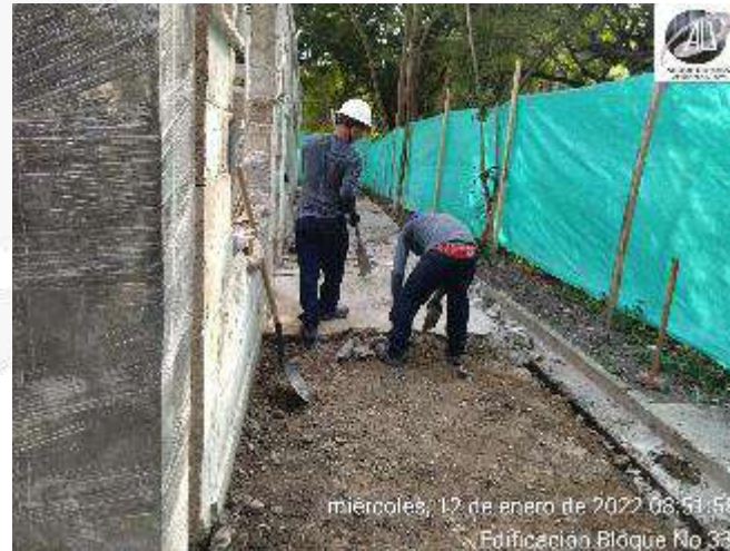
DEMOLICION ANDEN EXISTENTE
