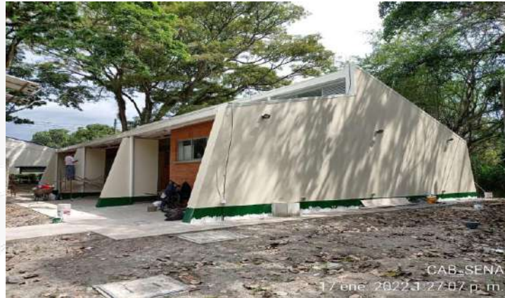
REMATE Y ACABADO DE PINTURA MUROS FACHADAS
