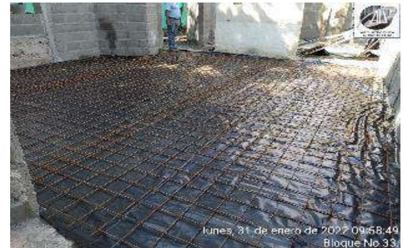
INSTALACION DE POLIPROPILENO Y MALLA ELECTROSOLDADA PARA CONSTRUCCION PLACA CONTRAPISO.
