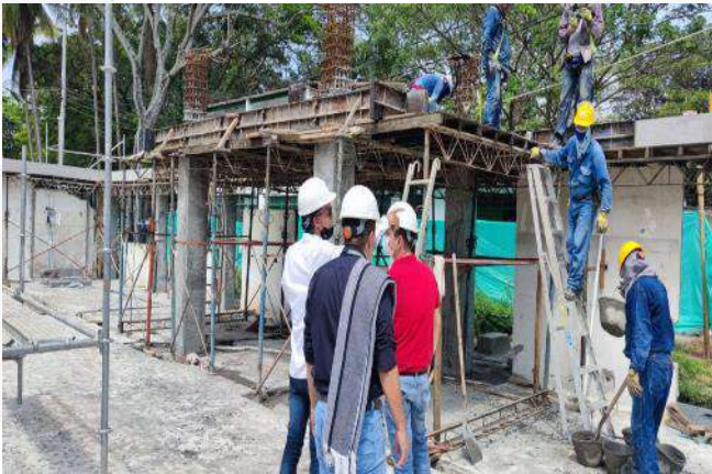
RECORRIDO DE OBRA CLIENTE SENA Y SUPERVISION
