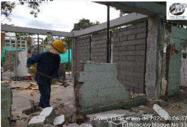
DEMOLICION DE MUROS EXISTENTES
