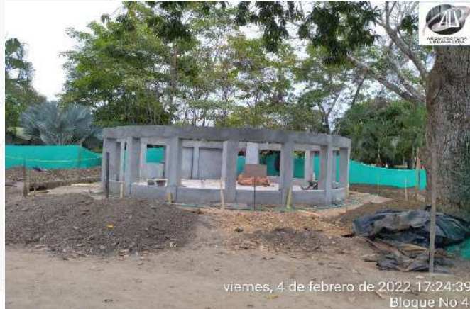
PAÑETE DE ESTRUCTURA Y MAMPOSTERIA
