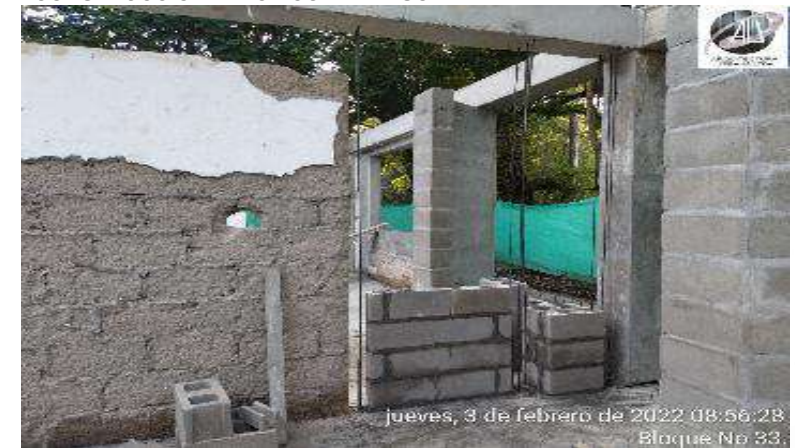
CONSTRUCCION MAMPOSTERIA CONFINADA
