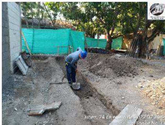
EXCAVACION MANUAL PARA CARCAMO PERIMETRAL
