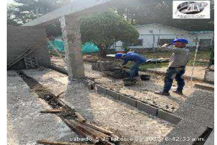
CONSTRUCCION MAMPOSTERIA CONFINADA PERIMETRAL
