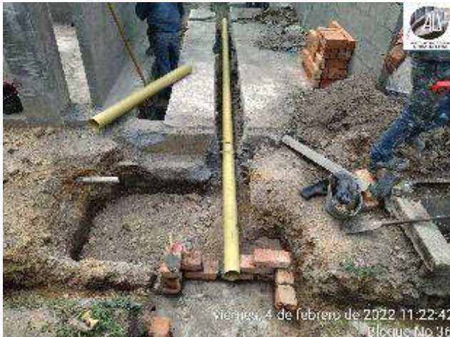
INSTALACION TUBERIA HIDROSANITARIA INTERNA
