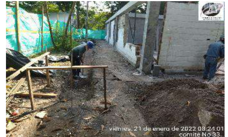
EXCAVACION MANUAL CARCAMO Y ANDEN PERIMETRAL
