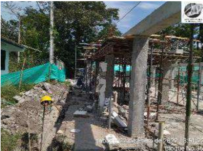
CONSTRUCCION DE VIGA AEREA EN CONCRETO
