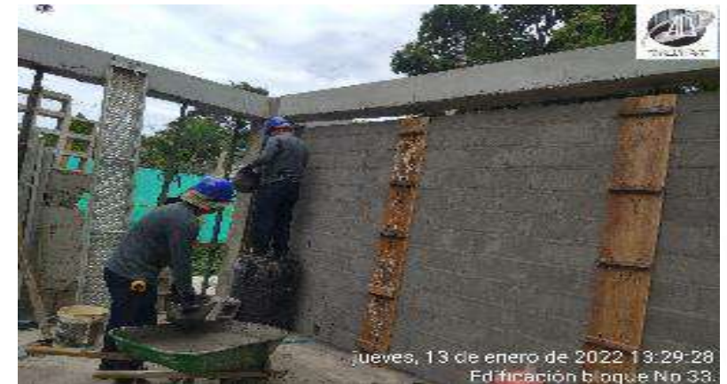
CONSTRUCCION DE CONFINAMIENTO MAMPOSTERIA
