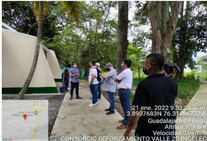
RECORRIDO DE OBRA PARA ENTREGA A LA SUBDIRECCION SENA
