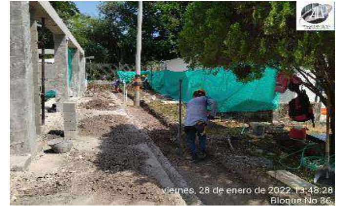
EXCAVACION MANUAL PARA CONSTRUCCION DE CARCAMO
