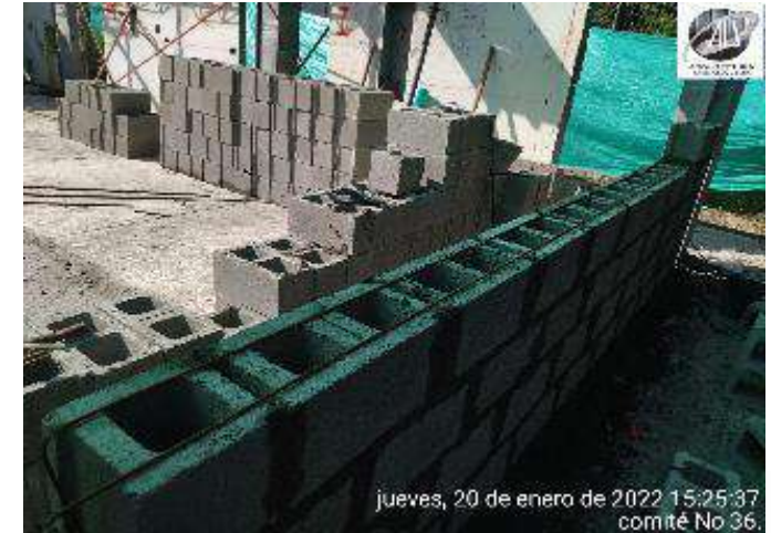
CONSTRUCCION MAMPOSTERIA GRAFILADA
