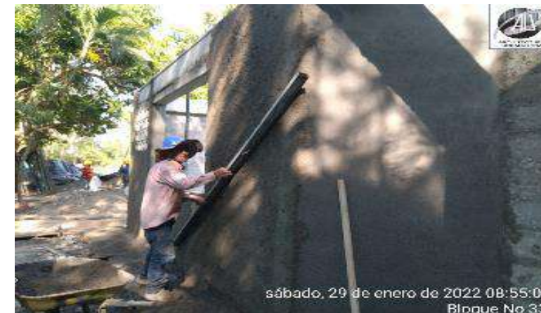
PAÑETE SOBRE MUROS FACHADA
