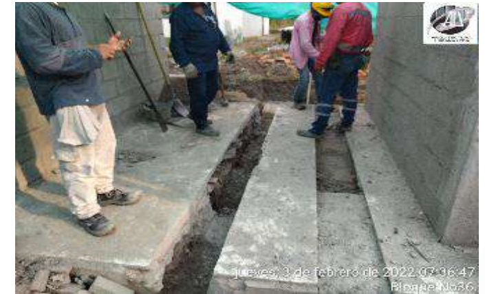
DEMOLICION Y EXCAVACION MANUAL PARA INSTALACION TUBERIA REDES HIDROSANITARIAS
