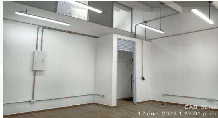
ACABADO Y REMATE DE INSTALACION DE TUBERIA Y TABLEROS ELECTRICOS
