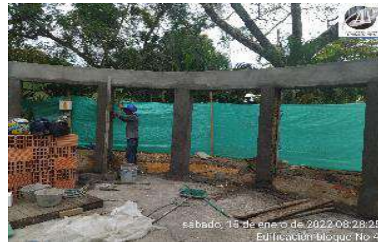
PAÑETE DE ESTRUCTURA Y MUROS INTERNOS Y EXTERNOS
