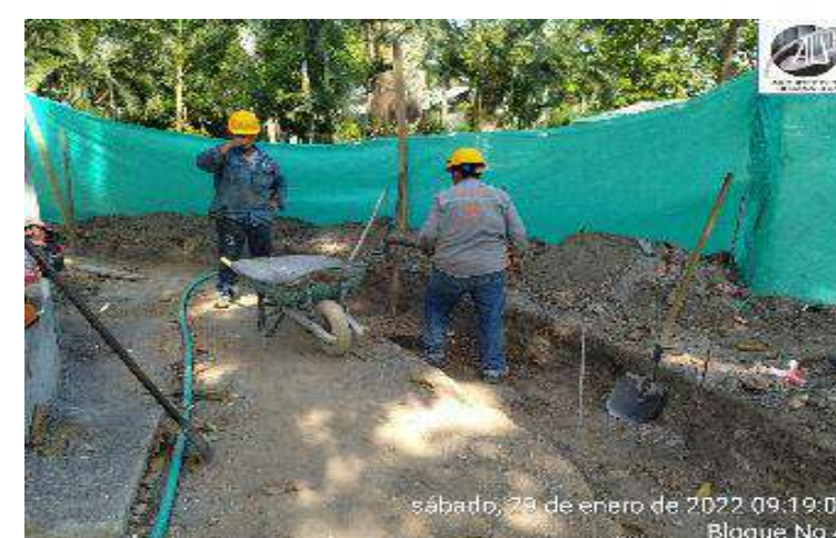
CARGUE Y RETIRO MANUAL DE MATERIAL DE EXCAVACION
