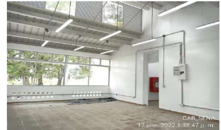
DESPEGUE Y LIMPIZA DE BOQUILLA ENCHAPES PISOS
