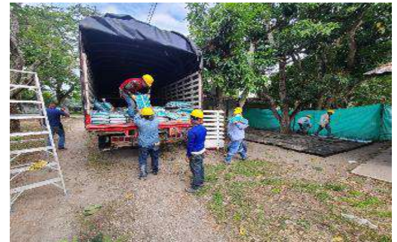
DESCARGUE Y ACOPIO DE ENCHAPE DE ACABADOS EN OBRA
