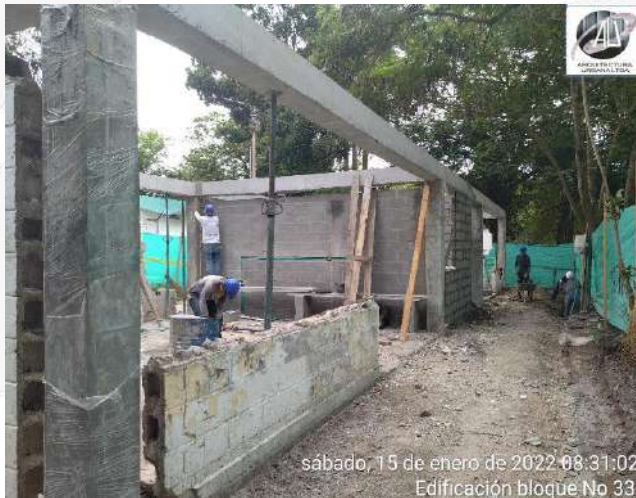
CONSTRUCCION MAMPOSTERIA EN BLOQUE DE CONCRETO
