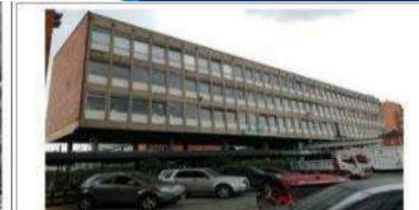
Fotografía 4. Parte de Fachada de la Torre Oriental
