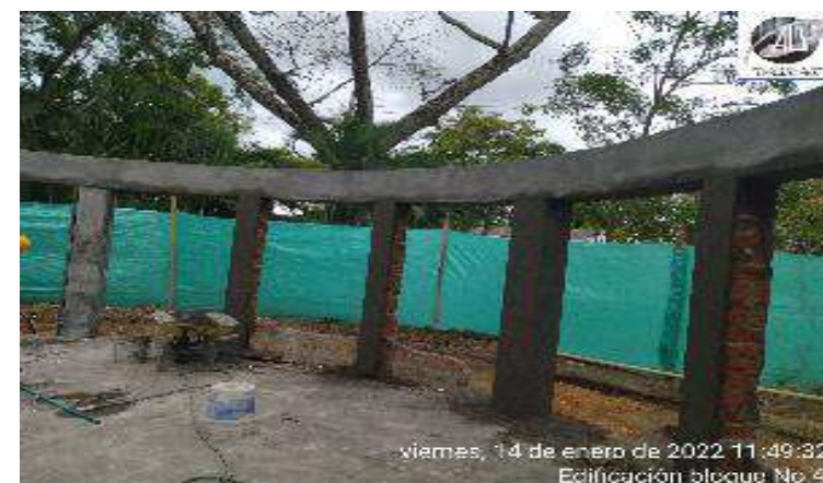
PAÑETE DE VIGA Y MUROS EN LADRILLO PRENSADO
