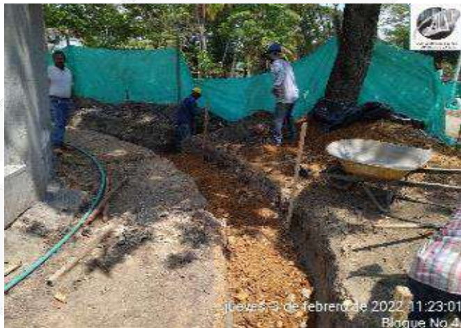
RELLENO PARA MEJORAMIENTO CAPACIDAD PORTANTE DE TERRENO ZONA DE CARCAMO
