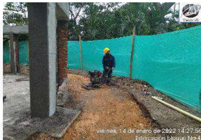
CONFORMACION Y COMPACTACION DE MATERIAL DE RECEBO PARA CONSTRUCCION ANDEN PERIMETRAL
