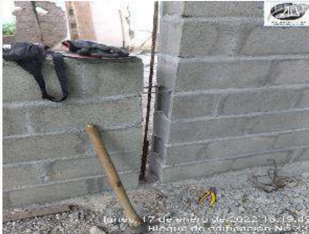
ANCLAJE ACERO PARA CONFINAMIENTO DE MAMPOSTERIA
