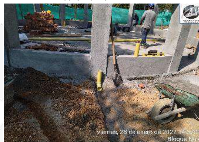
EXCAVACION ANUAL PARA CONSTRUCCION CARCAMO PERIMETRAL DE AGUAS LLUVIAS
