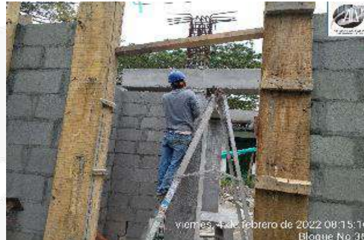
CONSTRUCCION DE COLUMNETAS DE CONFINAMIENTO MAMPOSTERIA
