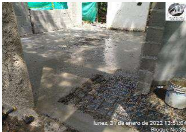
CONSTRUCCION PLACA CONTRAPISO
