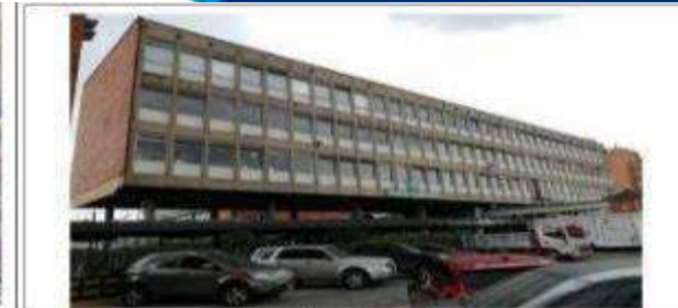
Fotografía 4. Parte de Fachada de la Torre Oriental
