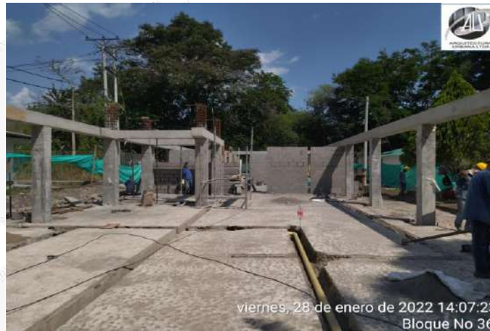
INSTALACION DE TUEBRIA SANITARIA INTERNA
