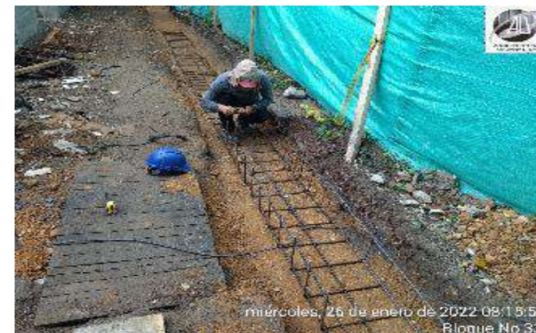
INSTALACION ACERO DE REFUERZO PARA CONSTRUCCION CARCAMO PERIMETRAL
