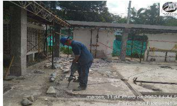
CORTE Y DEMOLICION PLACA EXISTENTE PARA INSTALACION TUBERIA
