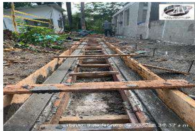
CONSTRUCCION CARCAMO PERIMETRAL CONTROL Y DRENAJE AGUAS LLUVIAS
