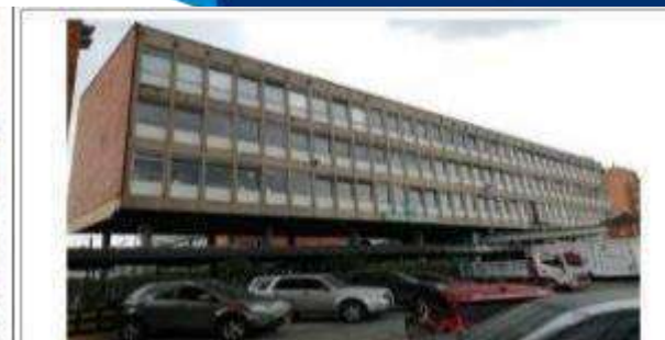
Fotografía 4. Parte de Fachada de la Torre Oriental
