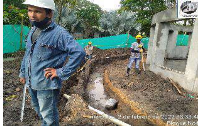
EXCAVACION MANUAL PARA CONSTRUCCION CARCAMO PERIMETRAL DE AGUAS LLUVIAS
