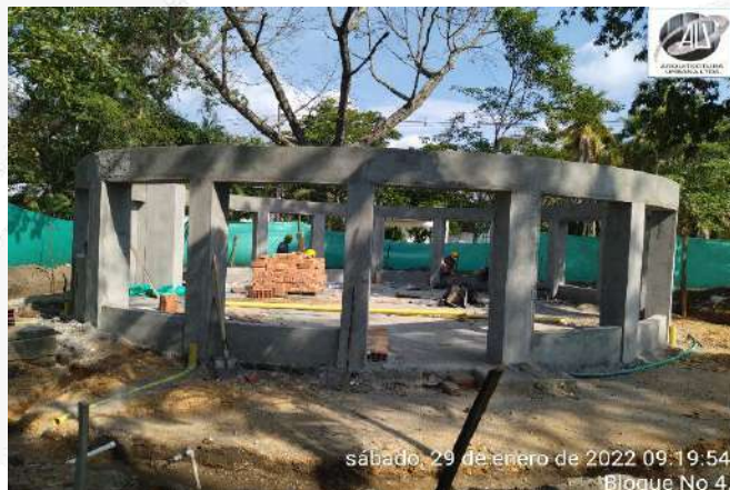
PAÑETE DE ESTRUCTURA Y MAMPOSTERIA
