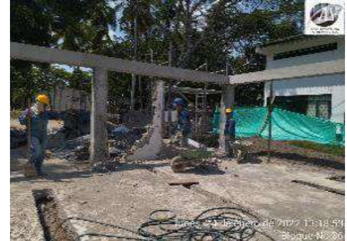
DEMOLICION MUROS EXISTENTES
