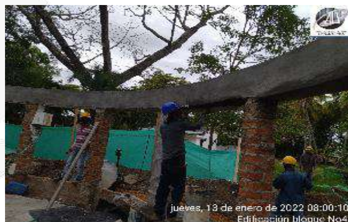
PAÑETE DE VIGA Y MUROS EN LADRILLO PRENSADO
