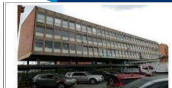
Fotografía 4. Parte de Fachada de la Torre Oriental
