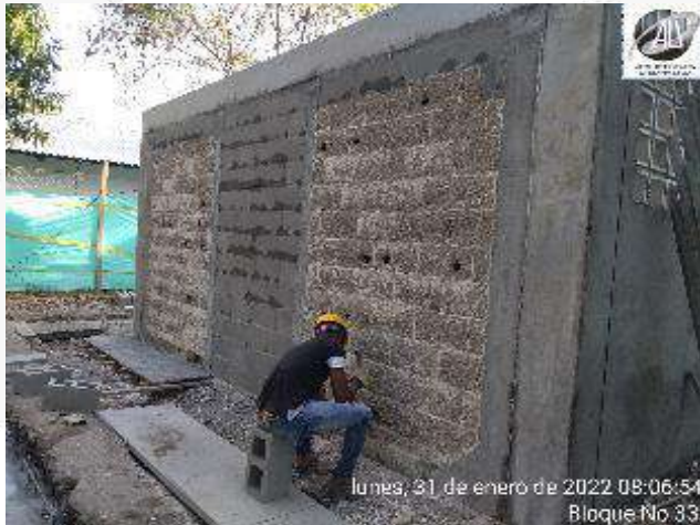
ESCARIFICADO DE PINTURA SOBRE MUROS EXISTENTES PARA PAÑETE NUEVO
