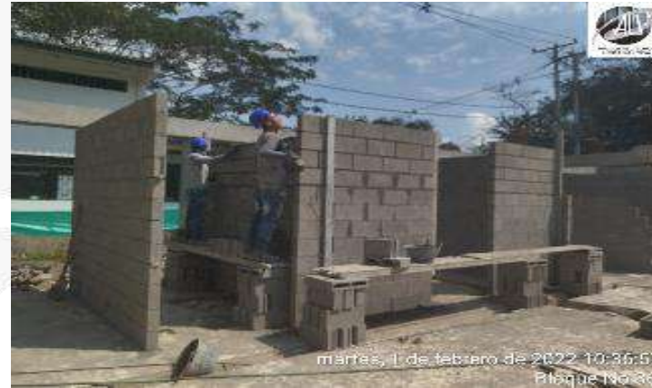
MODULACION Y CONSTRUCCION DE MAMPOSTERIA CONFINADA INTERNA
