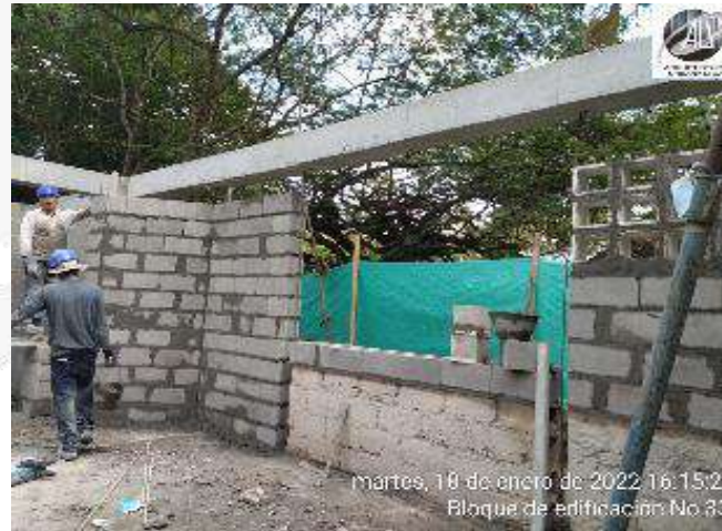
CONSTRUCCION MAMPOSTERIA Y RECUPERACION CALADOS EXISTENTES
