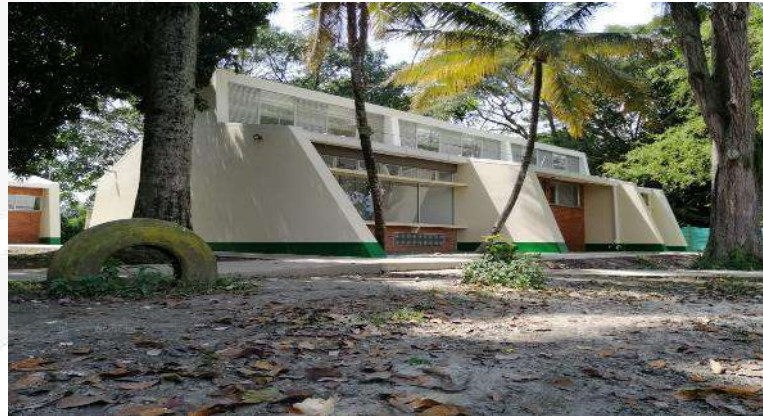
RECORRIDO INSTALACIONES BLOQUE 13
