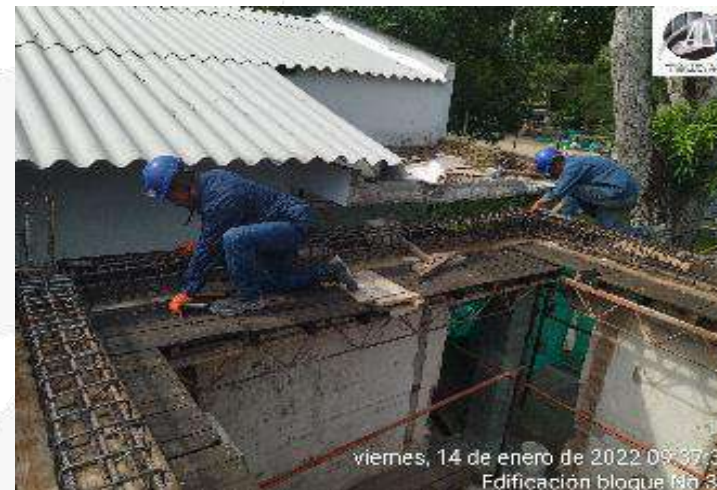
ARMADO ACERO DE REFUEZOZ PARA CONSTRUCCION VIGA AEREA
