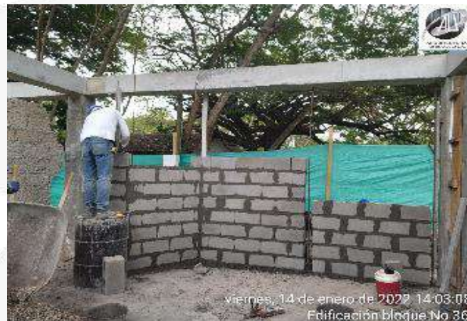
CONSTRUCCION DE MAMPOSTERIA
