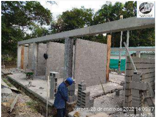
CONSTRUCCION DE MAMPOSTERIA DIVISORIA INTERNA
