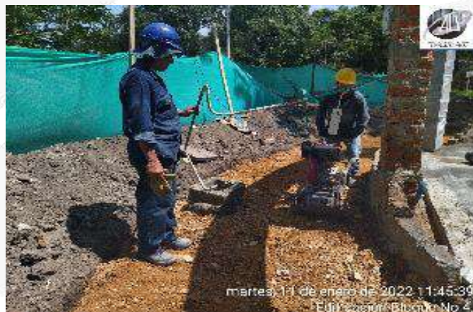
RELLENO Y CONFORMACION DE RECEBO
