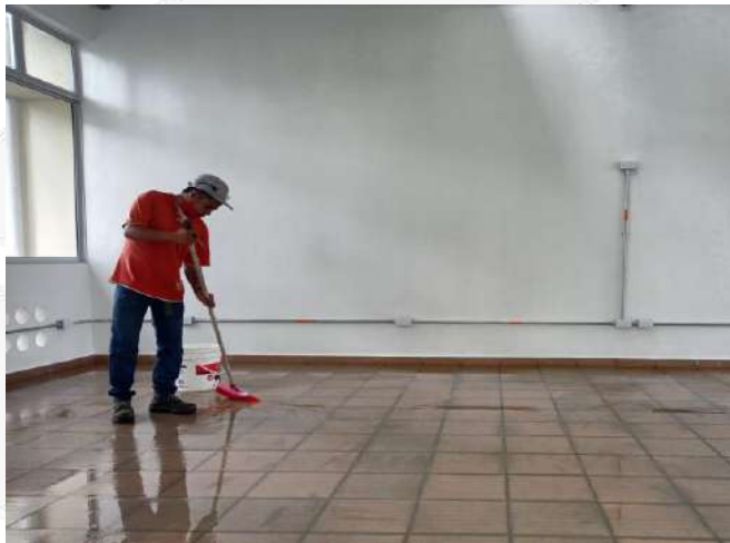
DESMANCHADO, LAVADO Y ACABADO DE PISO GENERAL BLOQUE 13
