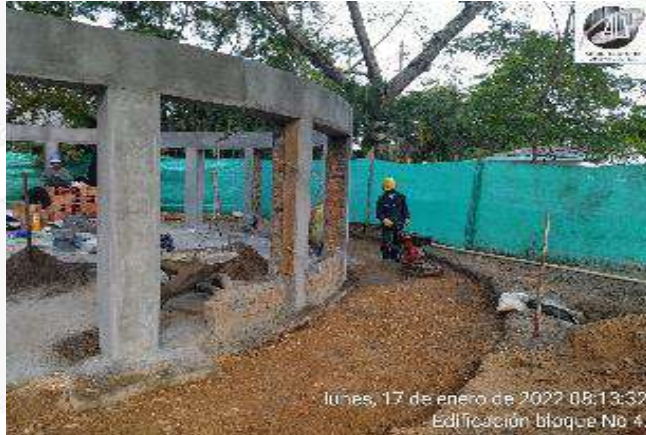
RELLENO Y CONFORMACION DE RECEBO
