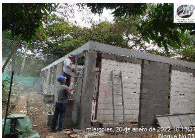
CONSTRUCCION MAMPOSTERIA CONFINADA
